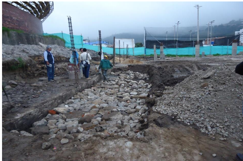
Imagen 11 Mejoramiento del Terreno
