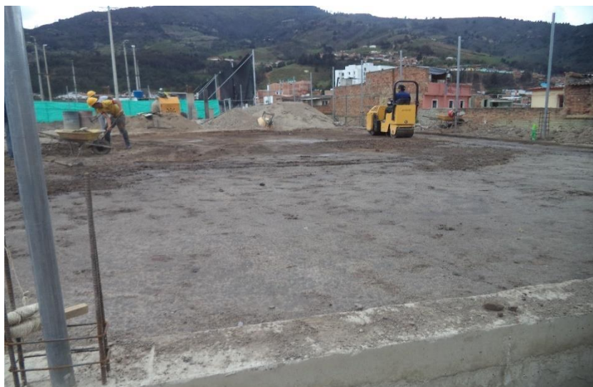
Imagen 12 Compactación del terreno
