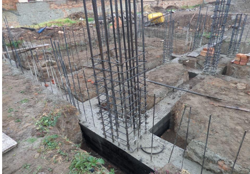
Imagen 7 Armado y fundida cimentación
