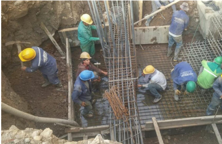
Imagen 10. Amarre de aceros: zapata y viga de cimentación. Fuente: Autor.
