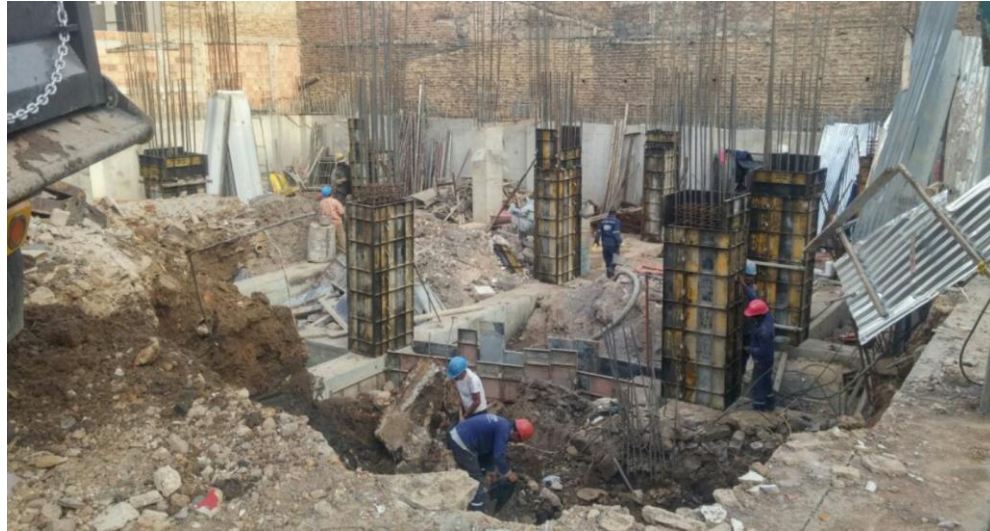
Imagen 17. Armado y encofrado de columnas. Fuente: Autor.
