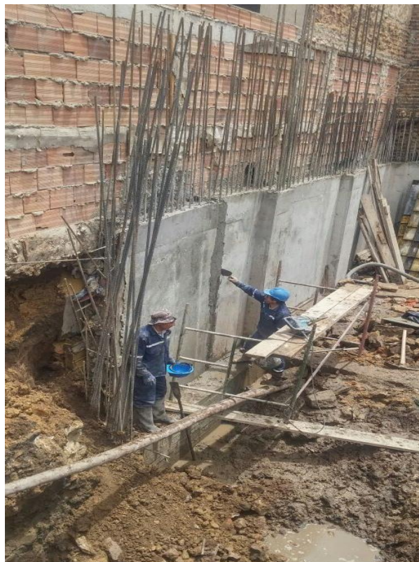
Imagen 12. Muro de contención perimetral con aceros de refuerzo número 5 y 4. Fuente: Autor.
