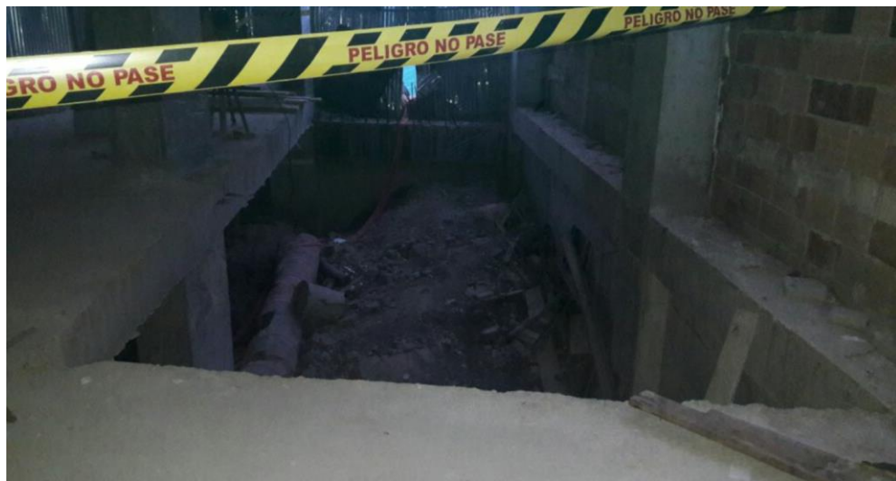
Imagen 15. Rampa de acceso a parqueaderos en construcción. Fuente: Autor.
