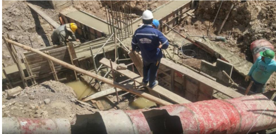
Imagen 8. Cimentación en concreto armado: encofrado y fundición de vigas. Fuente: autor.
