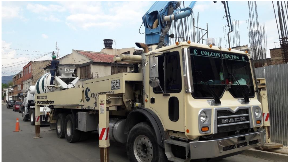
Imagen 14. Vaciado de concreto en columnas. Fuente: Autor.
