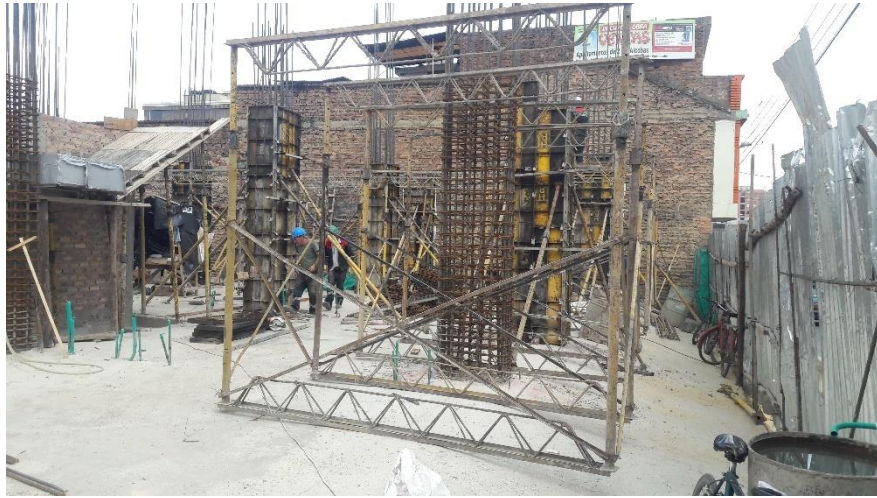
Imagen 18. Placa entre piso, techo del sótano. Fuente: Autor.
