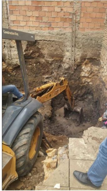
Imagen 6. Excavación mecánica. Fuente: Autor.
