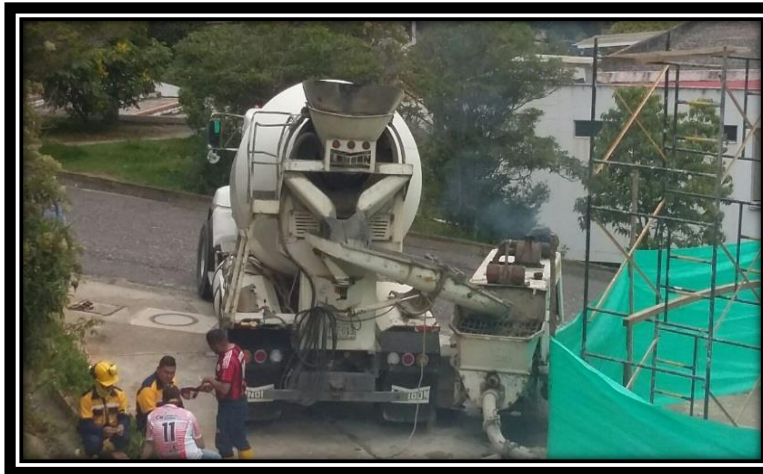
Bombeo de concreto
