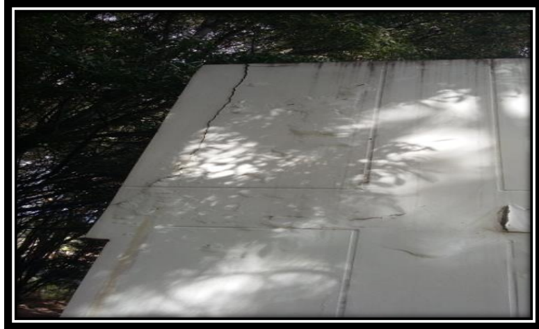
Fisura (aula de expresión corporal)
