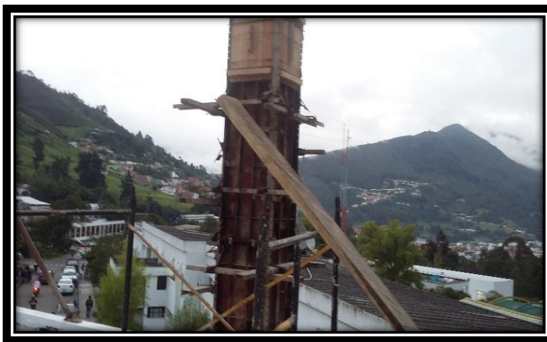
Encofrado de columnas
