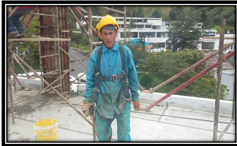
Uso de elementos de protección personal.
