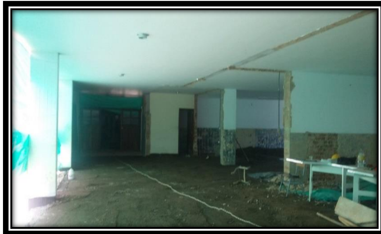
Compactación del suelo
