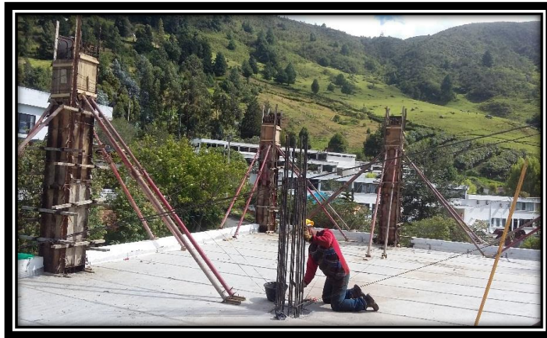
Limpieza del refuerzo de la columna
