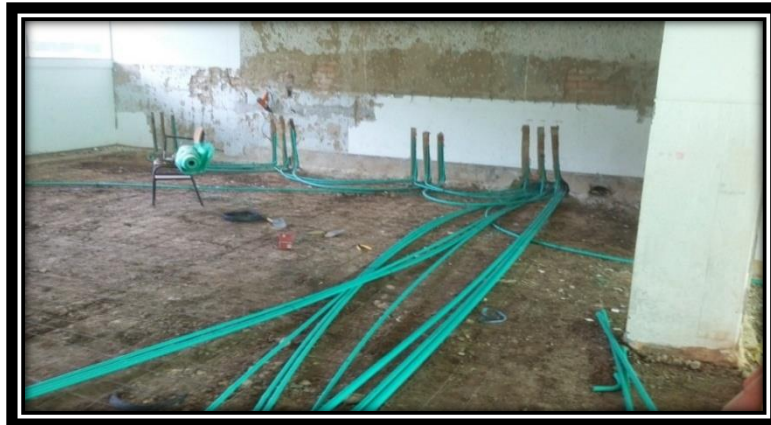
Tubería eléctrica.
