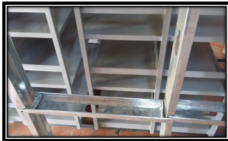
Estructura para el superboard.
