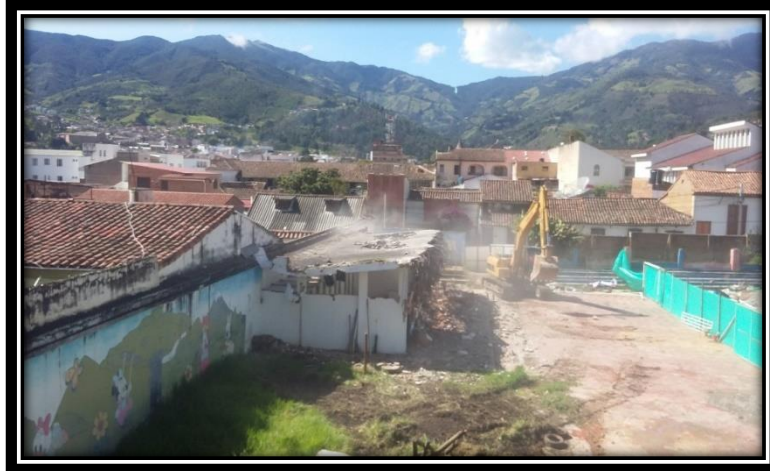
Inicio demolición de los baños.
