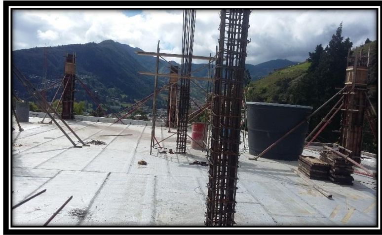
Distribución del acero de refuerzo
