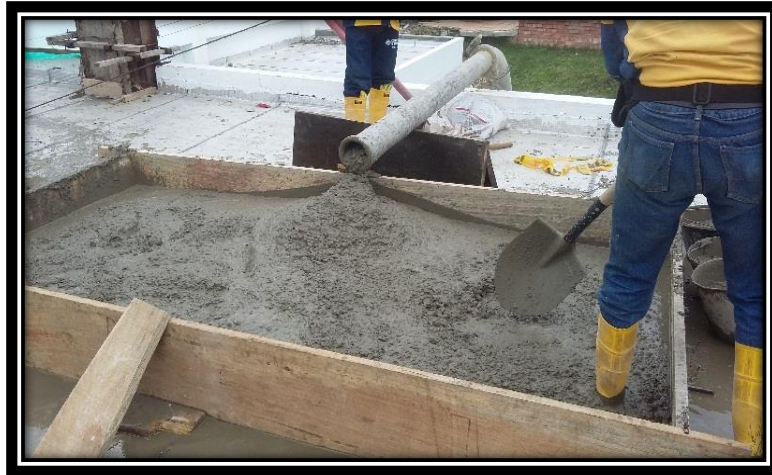
Recepción de concreto segundo nivel
