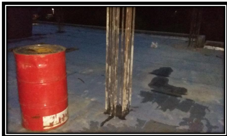
Adecuación para el empalme de la columna en la segunda planta.
