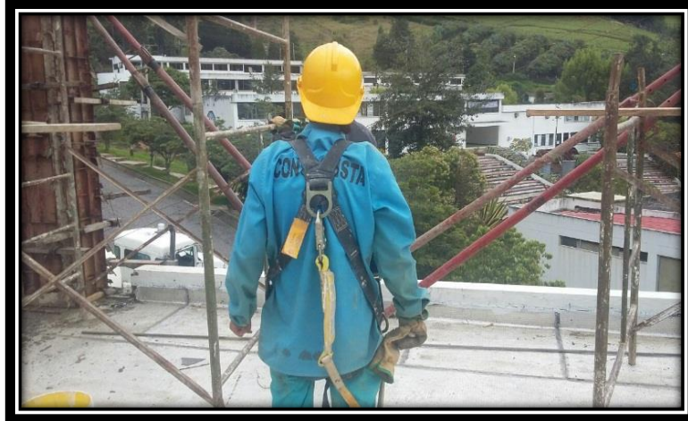
Uso de elementos de protección personal
