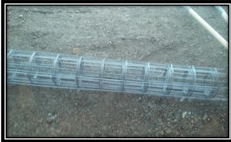
Malla electrosoldada.
