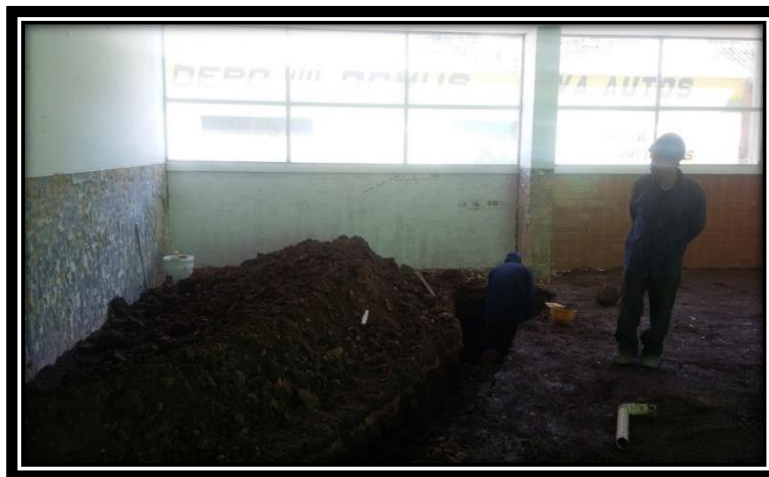
Excavación para tuberías sanitarias.
