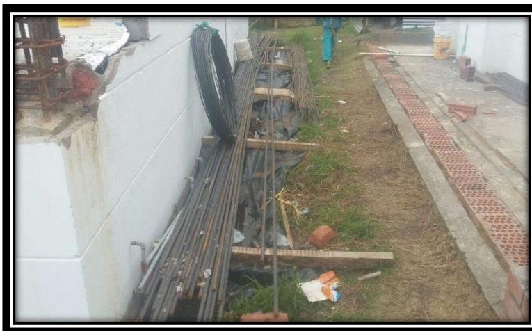
Acero de refuerzo
