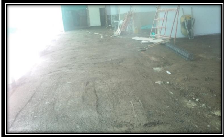
Relleno en recebo
