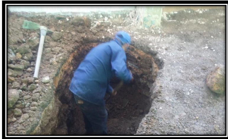
Excavación para caja de inspección
