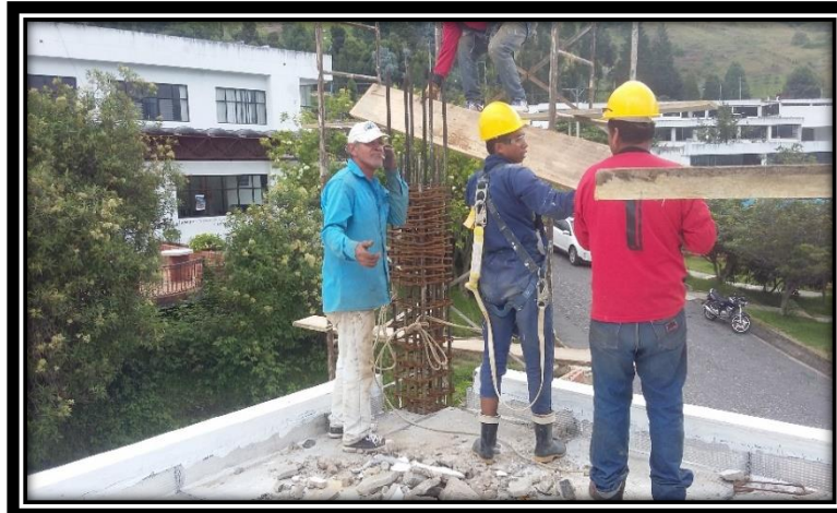
Armado de andamio
