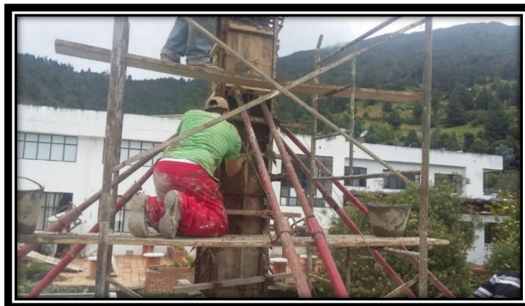
Fundida de columnas
