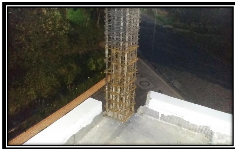
Adecuación para el empalme de la columna en la segunda planta.
