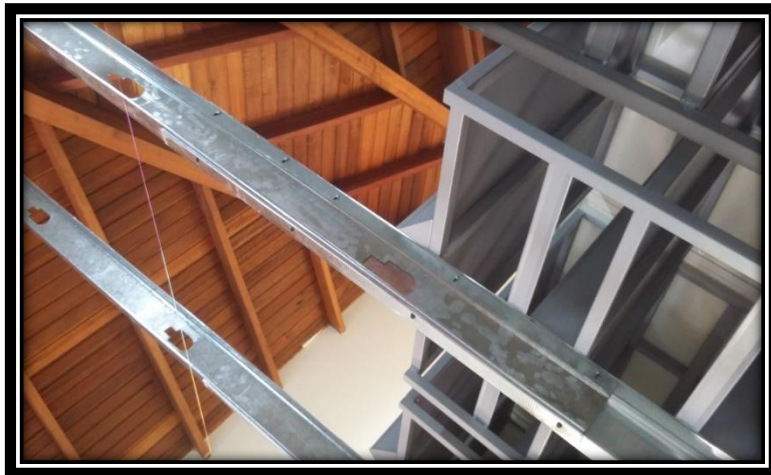
Estructura para el superboard.
