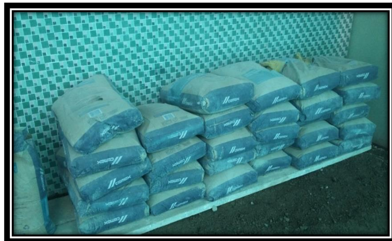
Almacenamiento del cemento
