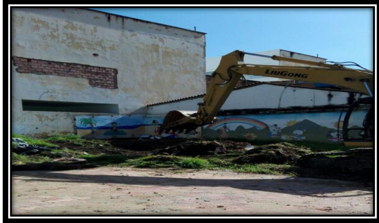
Demolición salón infantil.
