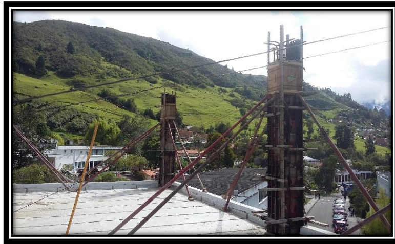
Encofrado de columna
