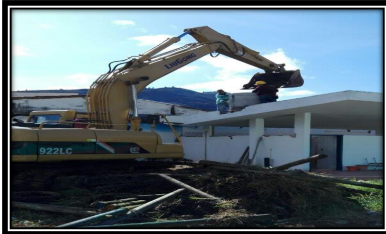
Retiro de tanque aéreo.
