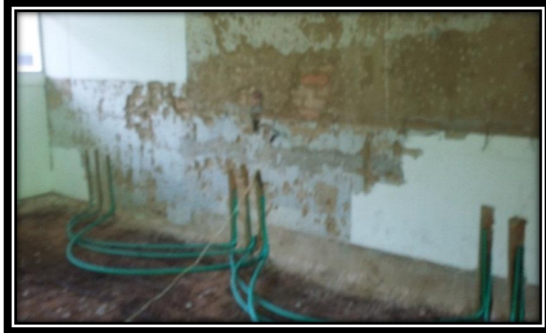
Instalación de tubería para red eléctrica salón B.
