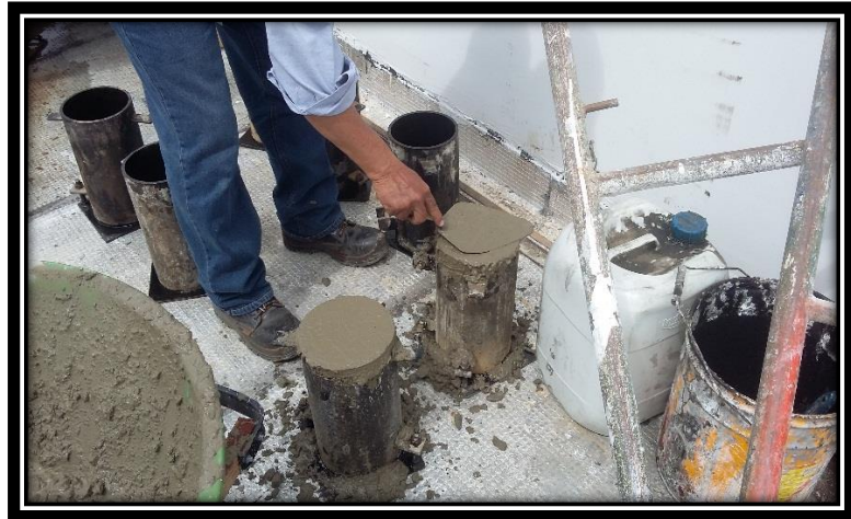
Vibrado en columnas
