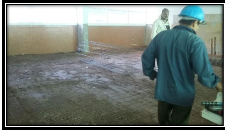
Enmallado de piso
