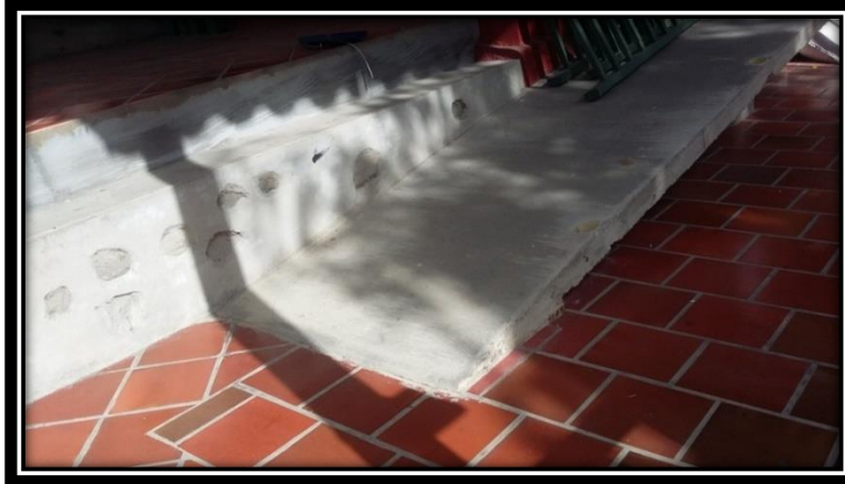
Dilatación en rampa de acceso a la oficina del estudiante
