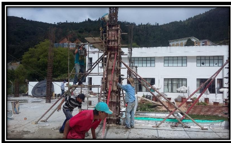
Fundida de columnas
