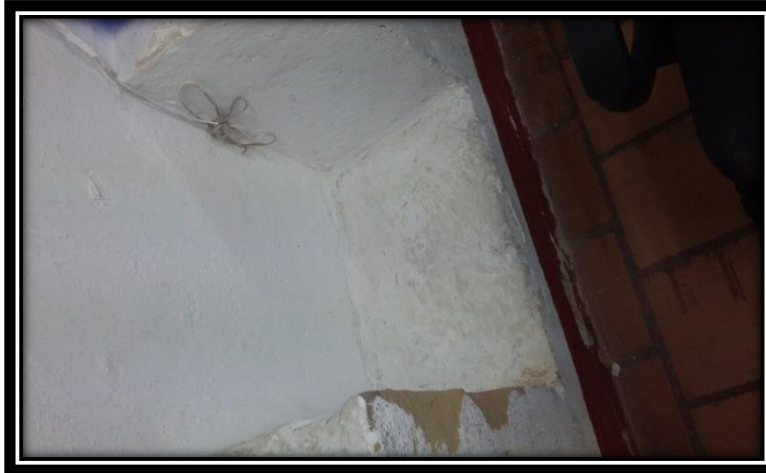
Dilatación en rampa de acceso a la oficina del estudiante
