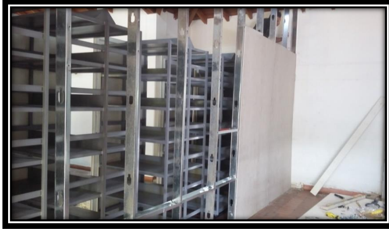
Instalación del superboard.
