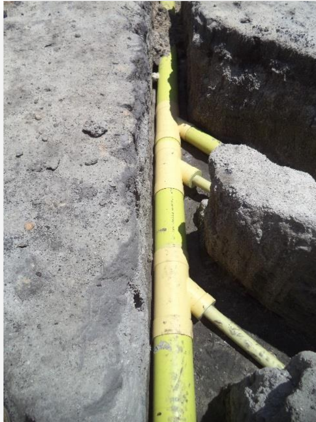
IMAGEN 57. Instalación de tuberías sanitarias.
