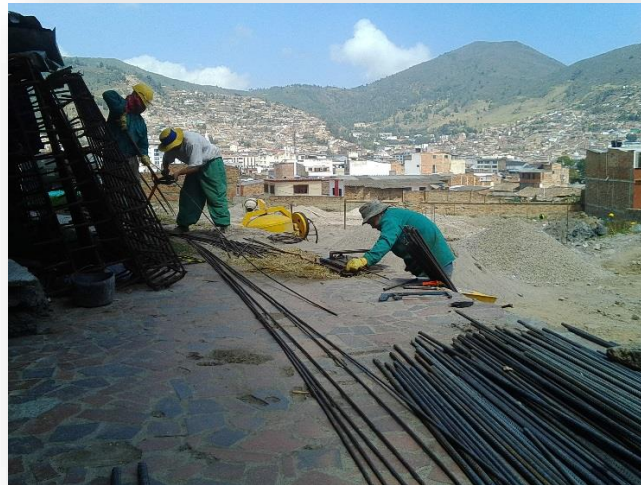
IMAGEN 45. Corte y figurado acero.
