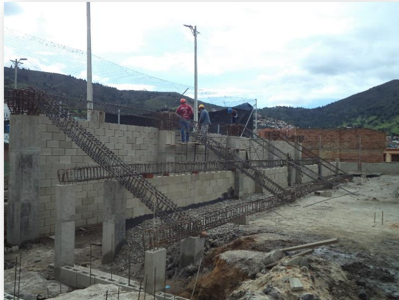
IMAGEN 38. Armado de vigas inclinadas.
