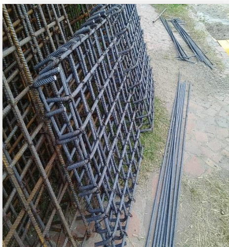
IMAGEN 29. REFUERZO ZAPATAS.
