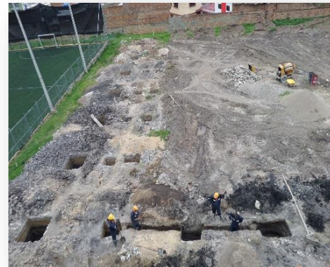
IMAGEN 18. Vista panorámica de excavaciones zapatas.
