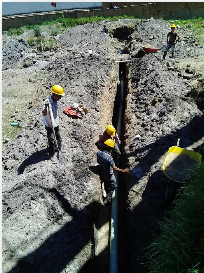
IMAGEN 21. Desvió de tuberías sanitarias.
