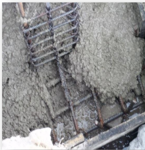
IMAGEN 30. FUNDIDA ZAPATAS.
