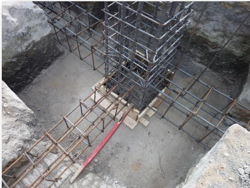
IMAGEN 31. Armado de pedestal en concreto
