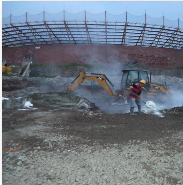
IMAGEN 50. Mejoramiento del terreno natural.
