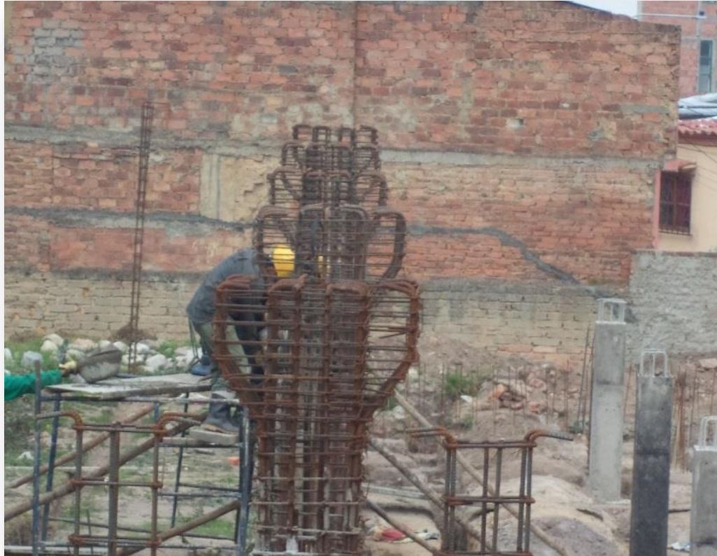
IMAGEN 35. Armado de ménsulas.
