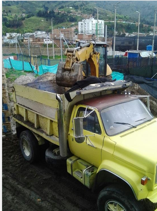
IMAGEN 25. Retiro de material de excavación.
