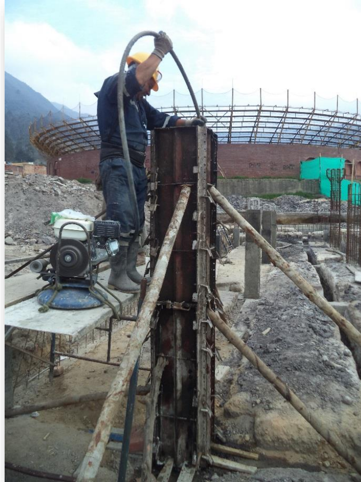
IMAGEN 34. Fundida de columna tipo 06.
