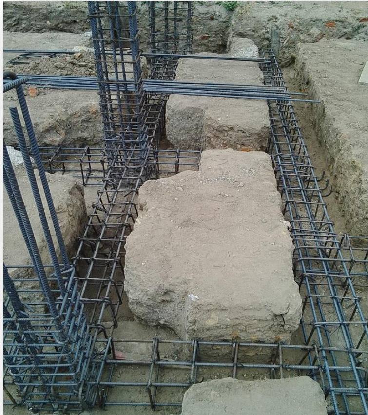
IMAGEN 32. Armado de viga de amarre en rampas.
