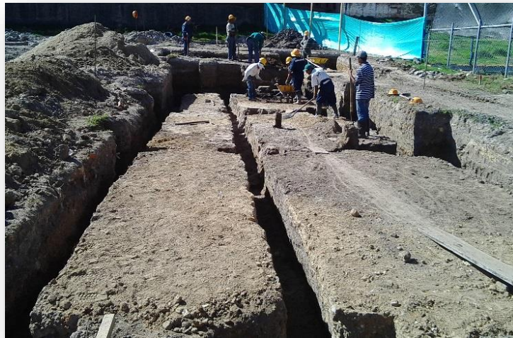
IMAGEN 23. Excavación vigas de amarre.
