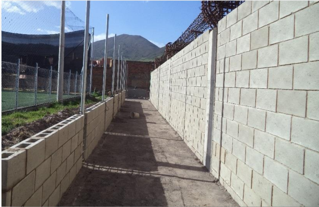
IMAGEN 44. Acabados de muros
