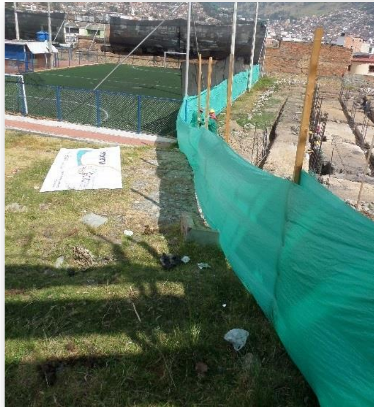
IMAGEN 9. Encerramiento lona verde.
