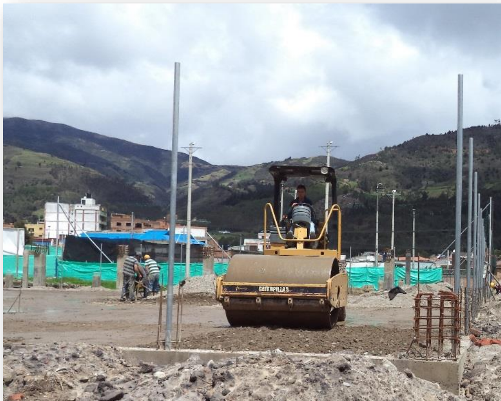
IMAGEN 49. Compactador de 10 Ton.
