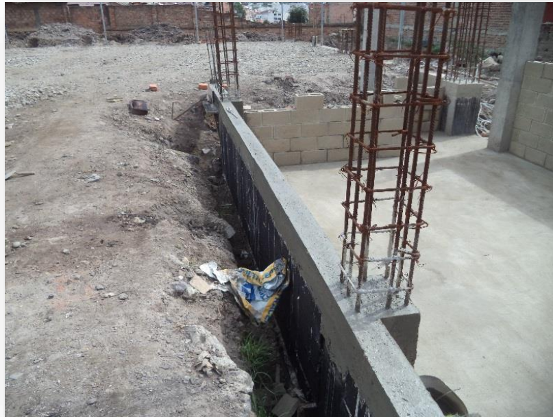
IMAGEN 41. Viga de amarre para muro.
