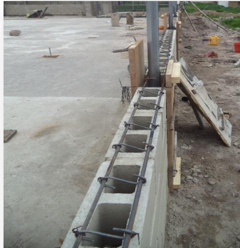
IMAGEN 42. Armado viga cinta.
