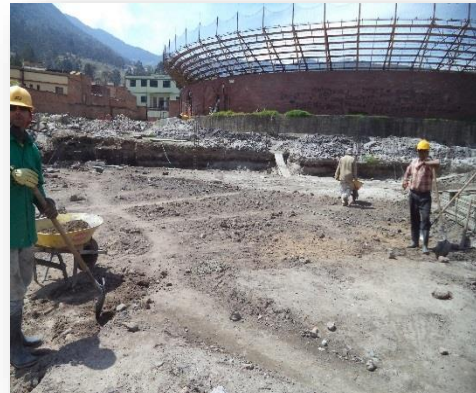
Corte y nivelación del terreno
