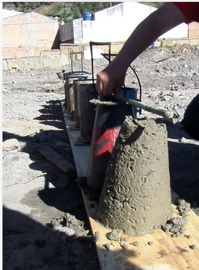
IMAGEN 64. Ensayo de asentamiento.
