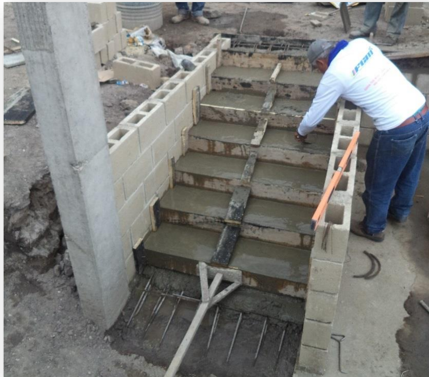
IMAGEN 40. Fundida de escaleras acceso a oficinas.
