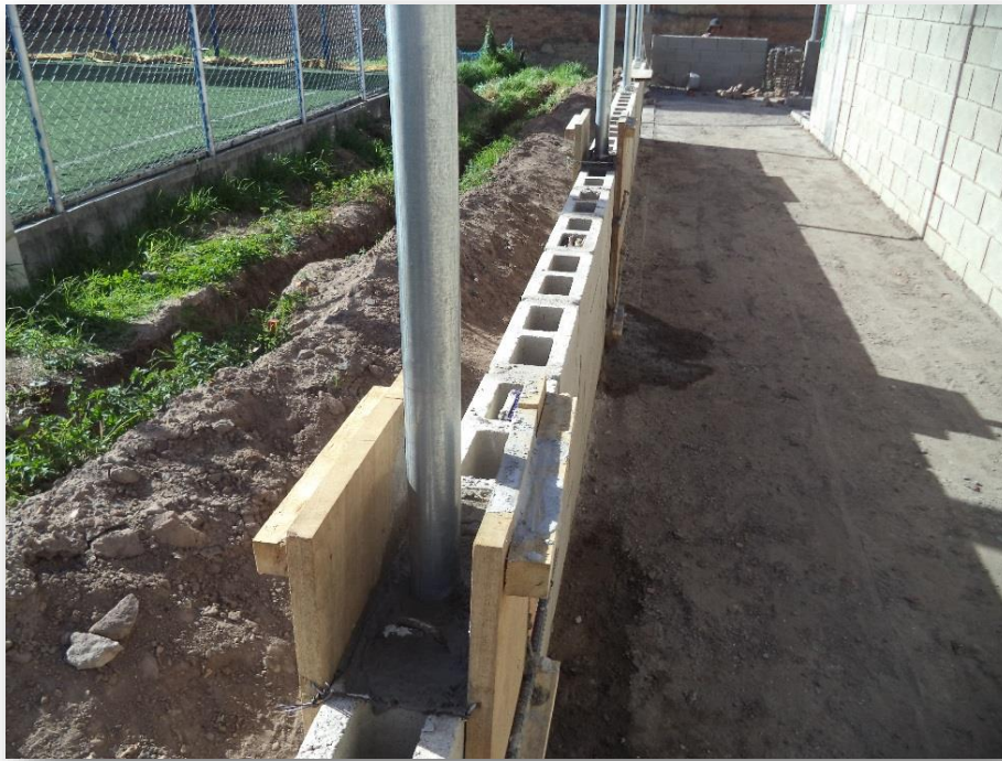
IMAGEN 37. Armado y fundida de columnetas.
