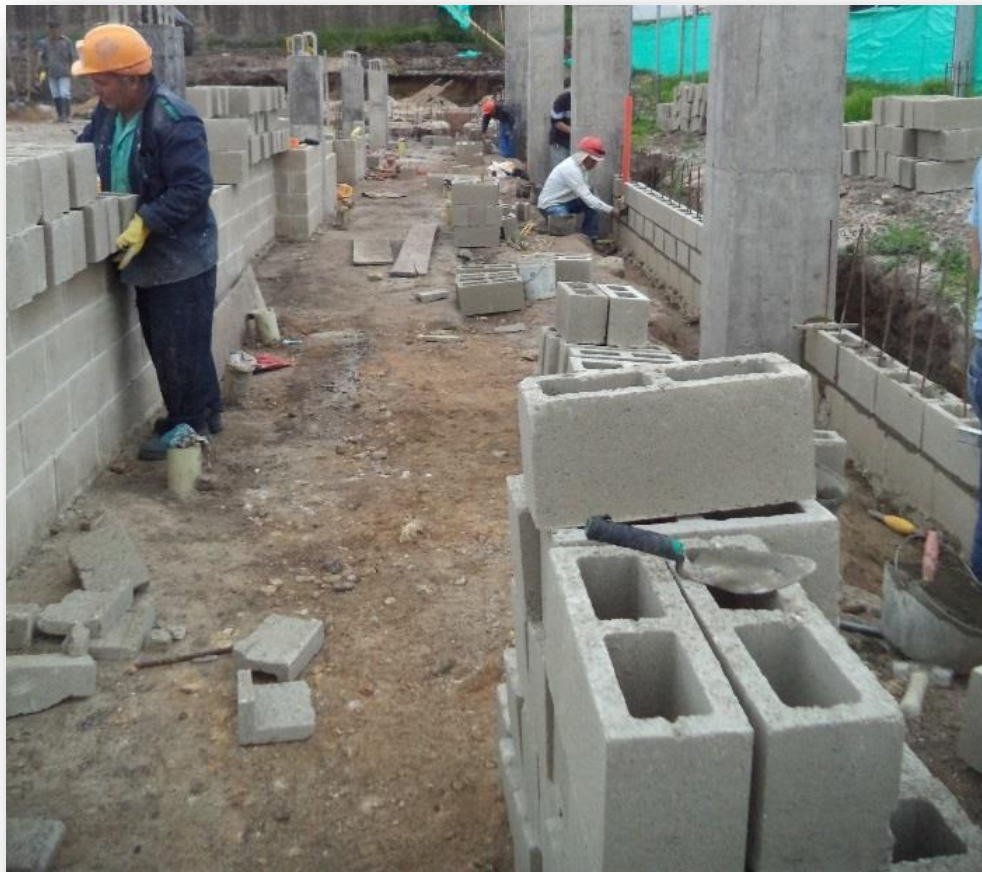
IMAGEN 43. Pega de bloques estructural.
