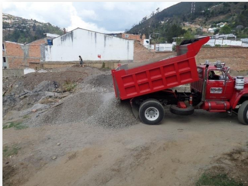
IMAGEN 58. Ingreso de material
