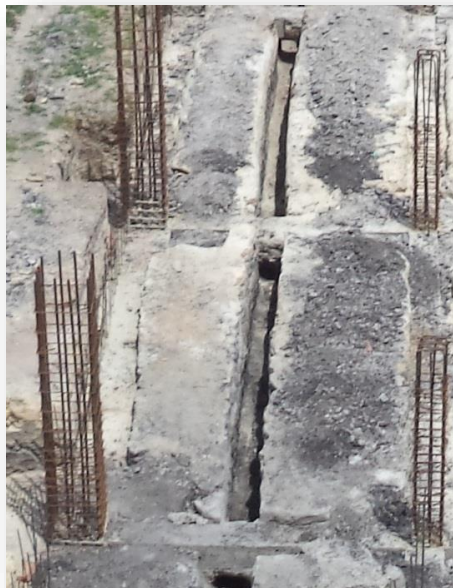
IMAGEN 24. Excavación ductos.
