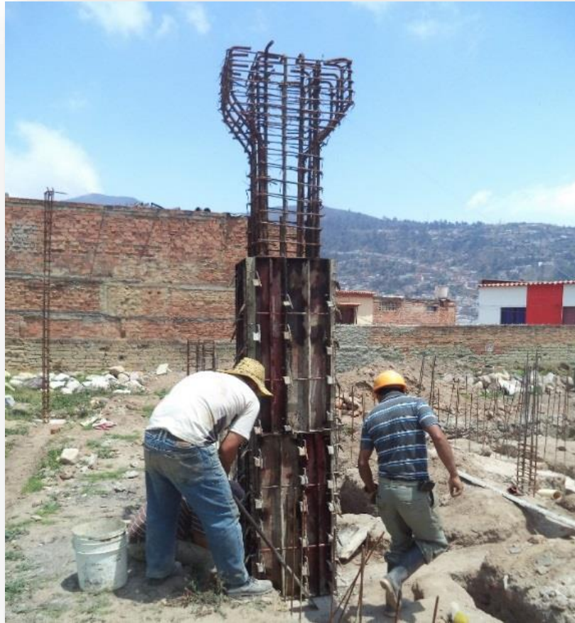
IMAGEN 36. Fundida de columnas de ménsulas
