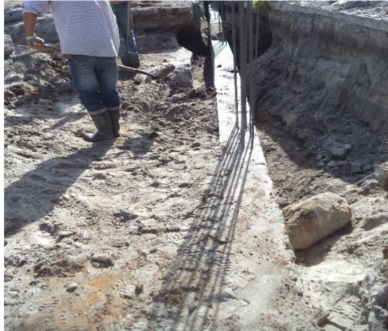
IMAGEN 33. Relleno con material de la misma excavación.
