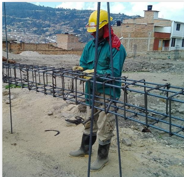
IMAGEN 46. Armado de acero para vigas.
