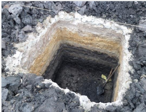
IMAGEN 17. Excavación zapatas tipo z-1.
