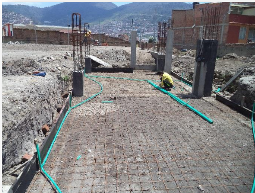
Imagen 54. Instalación de tuberías para eléctrico.
