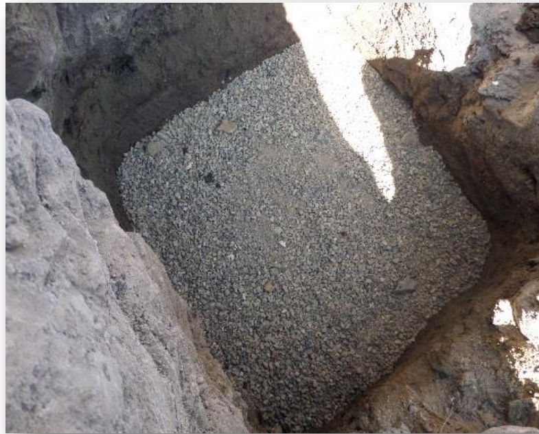
IMAGEN 27. Sub-base en excavaciones de zapatas.
