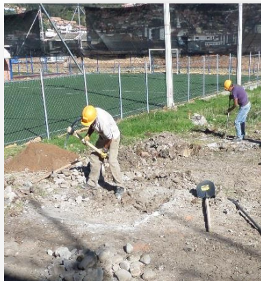
IMAGEN 15. Limpieza y descapote manual y mecánica.
