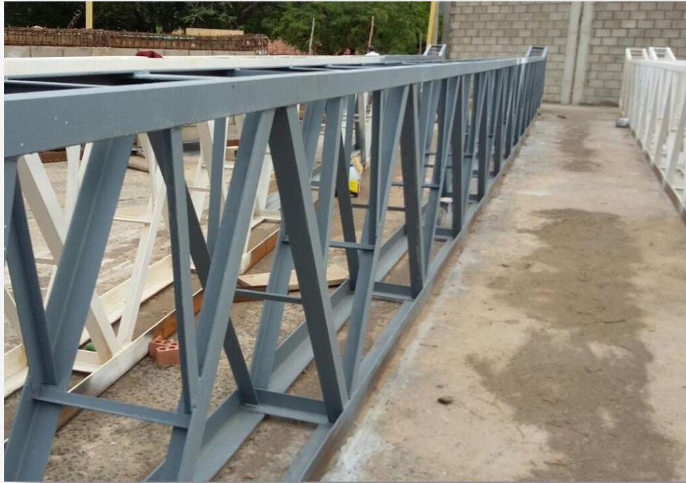
IMAGEN 48. Aplicación de anticorrosivo.
