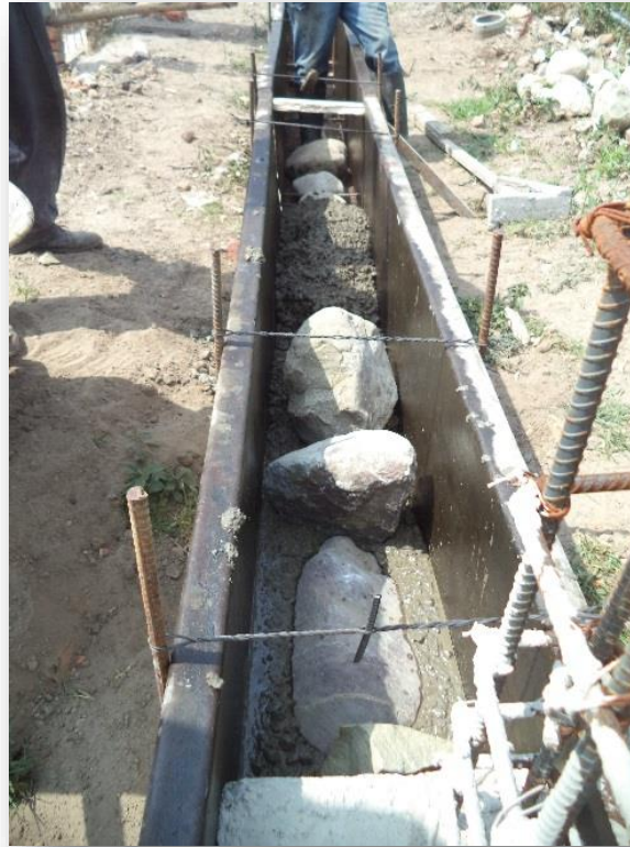
IMAGEN 2. Concreto ciclópeo encierro.
