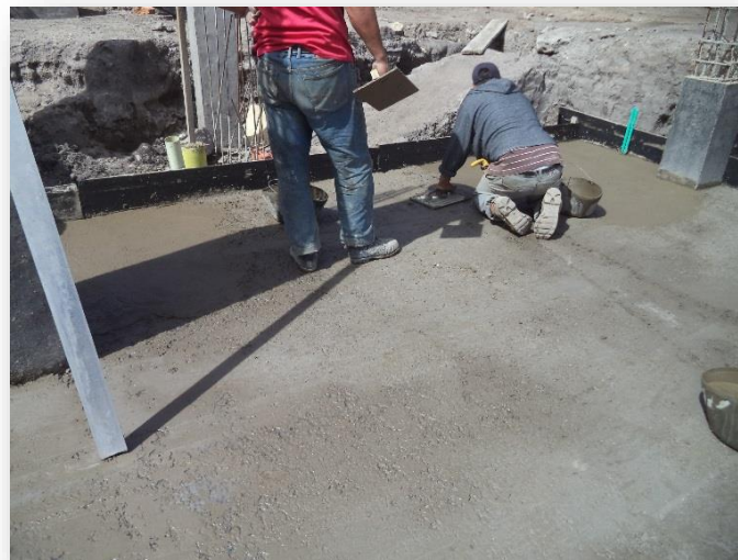
IMAGEN 53. Acabados en pisos de oficinas.
