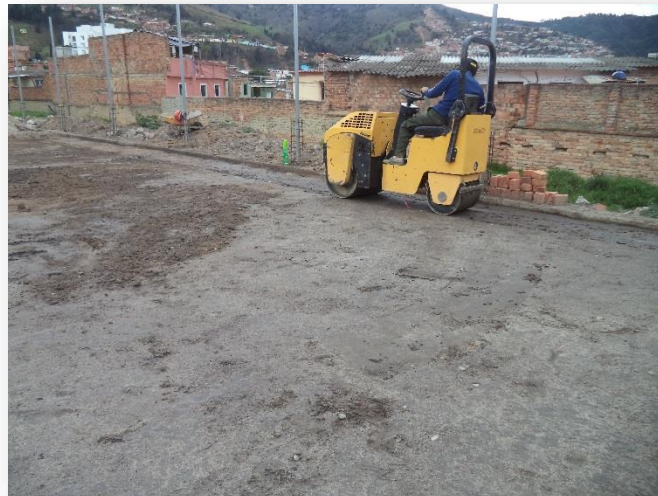
IMAGEN 51. Compactación con binitin 1 Ton.
