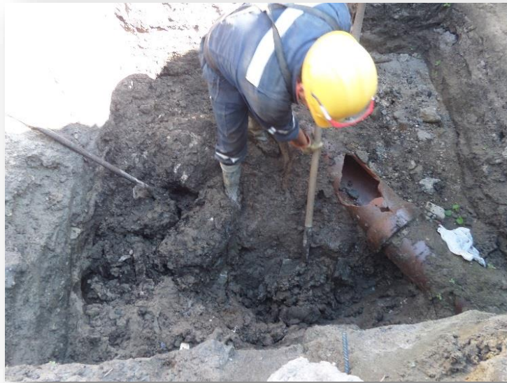
IMAGEN 19. Tubería de gres de 8" encontrada en excavación.
