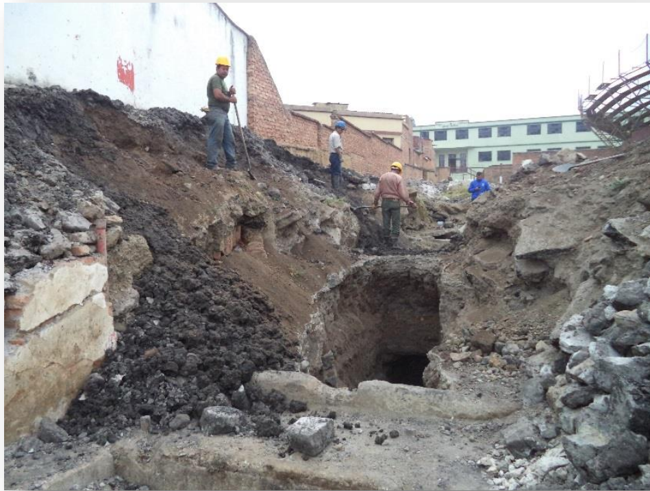
IMAGEN 22. Excavación para desvío de tubería sanitaria
