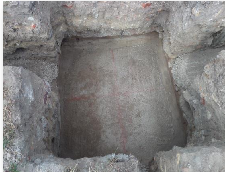
IMAGEN 28. Concreto ciclópeo en zapatas.
