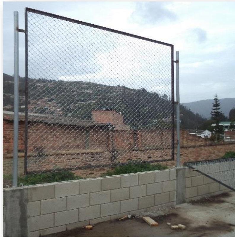
IMAGEN 55. Instalación malla eslabonada en encerramiento.
