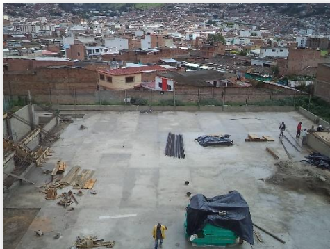
IMAGEN 52. Losas de cancha.
