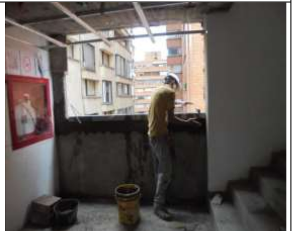
Fotografía 62. Estuco sobre muros
