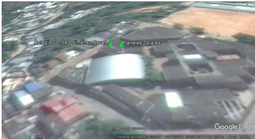
Figura. 16. Vista en Google Maps de la cubierta de la institución para ampliación del proyecto
