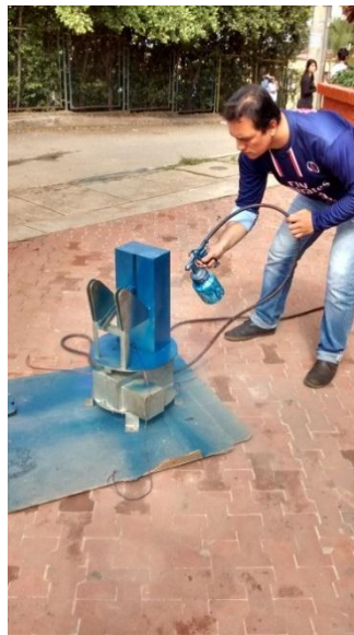
Figura. 22. Aplicación de anticorrosivo para disminuir efectos corrosivos atmosféricos.
