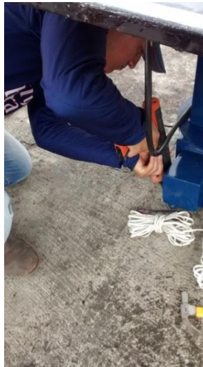
Figura. 25. Anclaje de estructura con tiros de impacto
