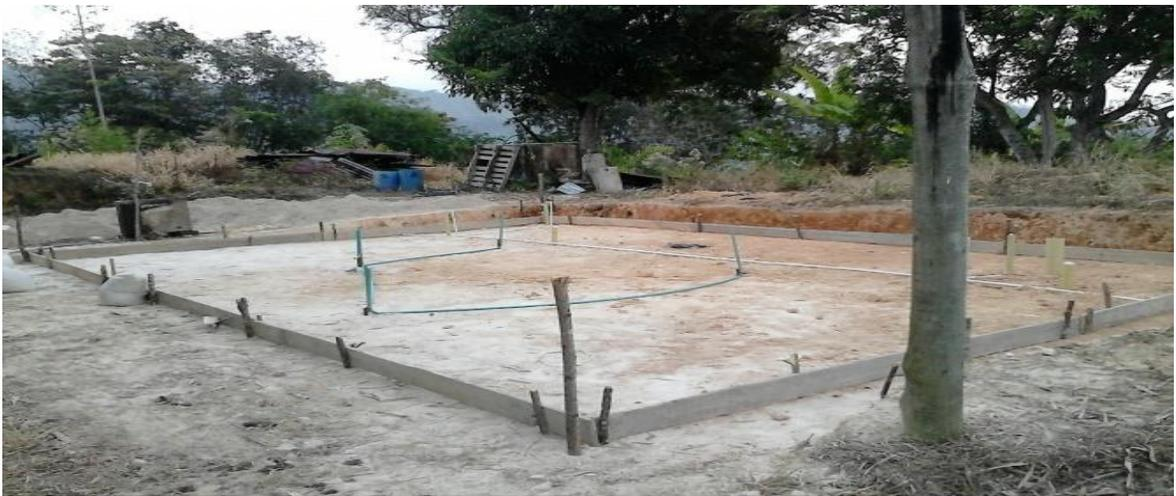
figura 16 instalación de tuberías hidrosanitarias y eléctrica beneficiario Carmen Estévez Cacua: fuente autor
