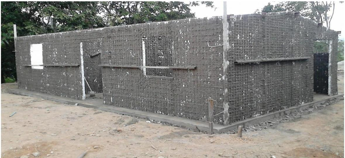
figura 21 instalación de alineadores de muro y lechada de mortero beneficiario Javier Tolosa Vereda Mirabel: fuente autor
