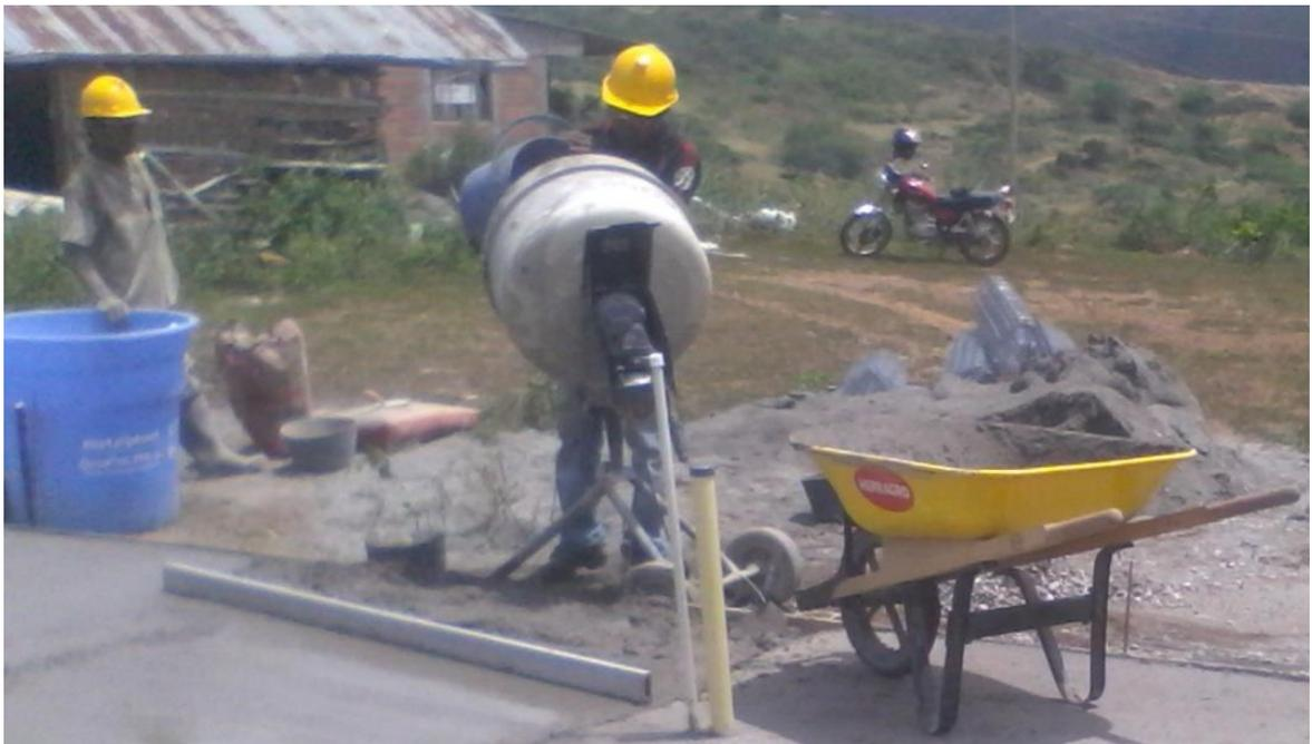
figura 11 preparación de concreto en obra. Fuente autor
