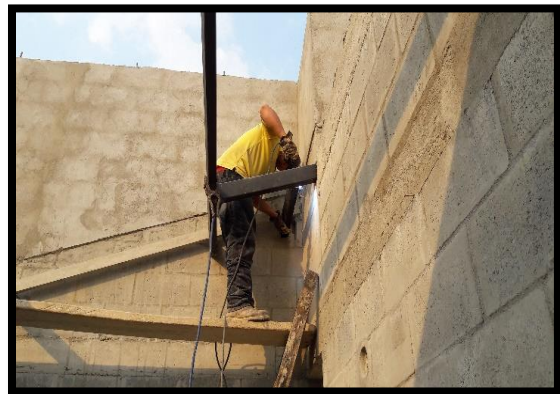
96 Instalación de cerchas para estructura metálica. Fuente: Autor (2016)
