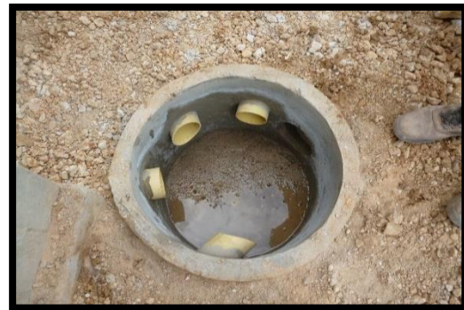
20 Caja de inspección terminada con empalme de tubería Fuente. Autor (2016)
