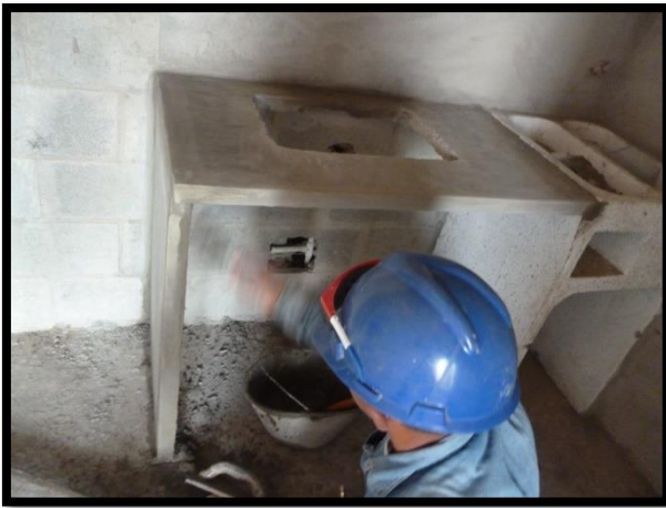
92 Instalación de meso en imitación de granito y adecuaciones sanitarias e hidráulicas. Fuente: Autor (2016)
