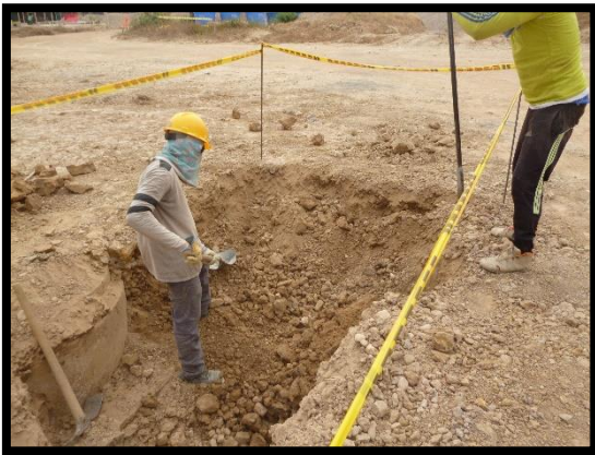
3 excavación manual para pozo de alcantarillado bloque s 6 y 10 Fuente. Autor (2016)
