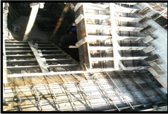
69 acero de refuerzo escaleras Fuente. Autor (2016)
