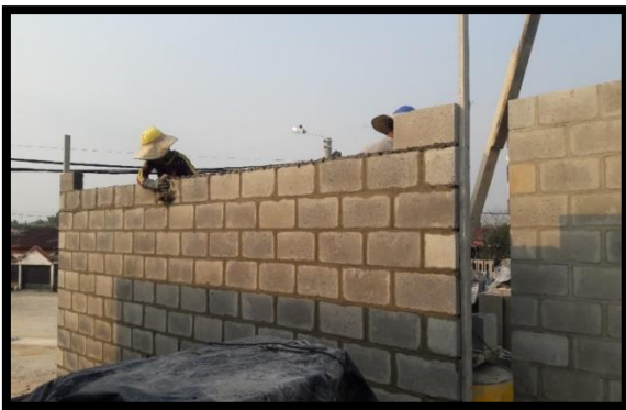
31 instalación de bloque estructural Fuente. Autor (2016)
