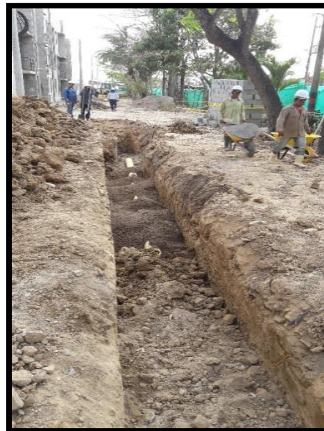
15 Relleno de material común Fuente. Autor (2016)
