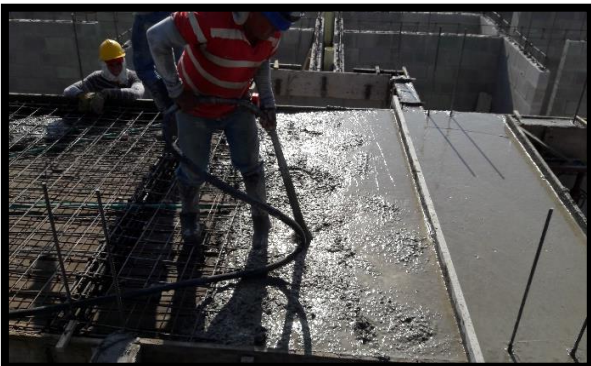
58 vibrado de placa tanque Fuente. Autor (2016)
