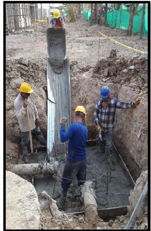
23 fundida de base de pozo de alcantarillado Fuente. Autor (2016)
