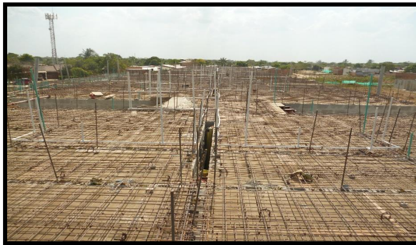
67 instalación de malla electro soldada Fuente. Autor (2016)
