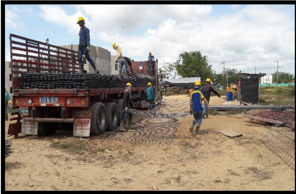
66 suministro de malla electro soldada Fuente. Autor (2016)
