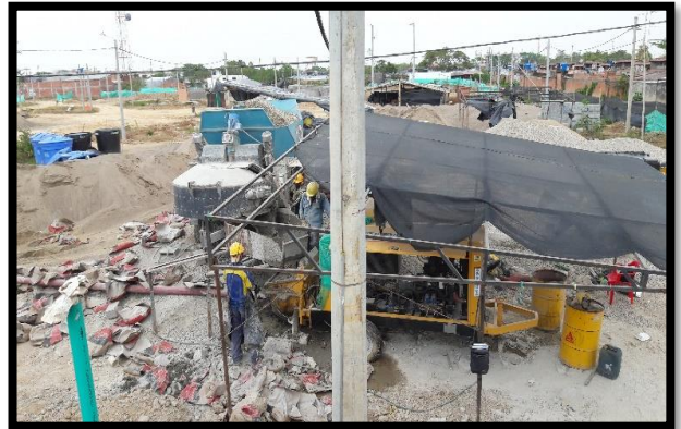
40 concretara y bomba de concreto Fuente. Autor (2016)
