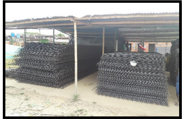
65 almacenamiento de malla electro soldada Fuente. Autor (2016)
