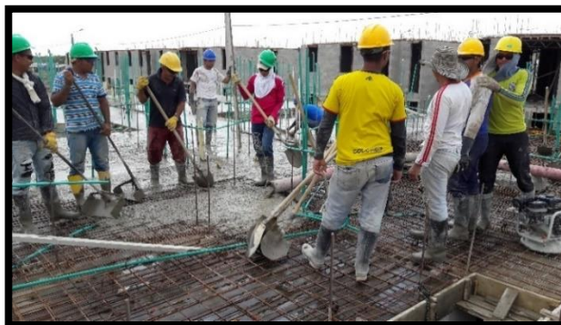
34fundida de placa entrepiso nivel 2 Fuente. Autor (2016)
