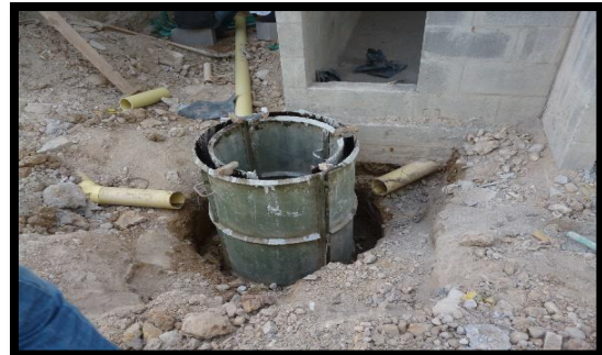
18 Formaleta metálica para caja de inspección de aguas lluvia Fuente. Autor (2016)
