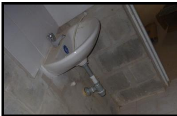
91 Lavamanos instalado. Fuente: Autor (2016)
