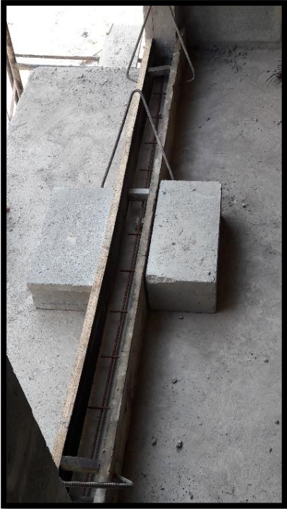
63 encofrado de poyo Fuente. Autor (2016)
