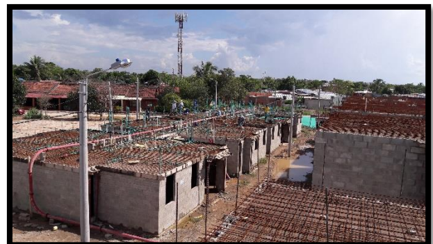
37 placa entrepiso nivel 2 lista para fundir Fuente. Autor (2016)
