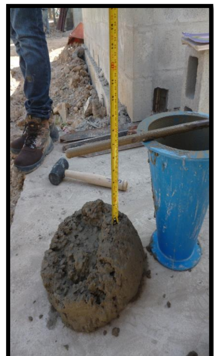
100 Asentamiento de 17cm para fundida de pozos sanitarios.
