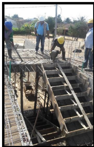
51 Fundida de escalera entre niveles 1 y 2 Fuente. Autor (2016)
