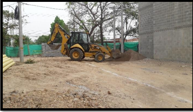
8 almacenamiento de arena para cimentación de tubería Fuente. Autor (2016)
