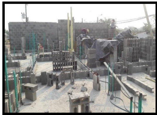
32 inicio de instalación de bloque estructural Fuente. Autor (2016)
