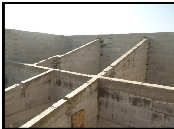
55 Terminado de viga culata de 12x17 Fuente. Autor (2016)
