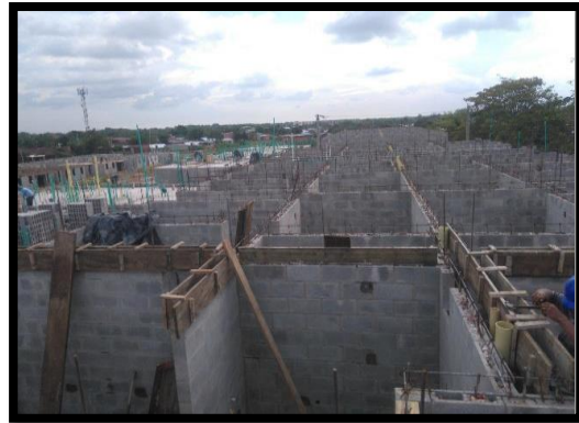
46 Fundida de viga aérea de 2x20 bloque 10 Fuente. Autor (2016)
