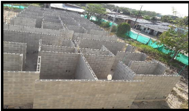
43 Dovelas bloque 13 nivel 1 Fuente. Autor (2016)
