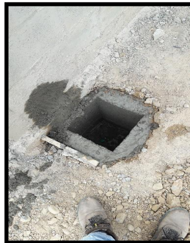
29 Fundida de caja de apantallamiento Fuente. Autor (2016)
