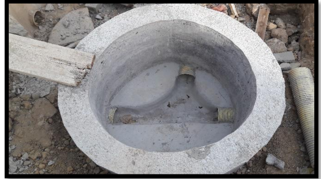
26 cañuela de pozo de alcantarillado Fuente. Autor (2016)
