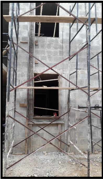
62 encofrado de borde ventana bloque 6 Fuente. Autor (2016)
