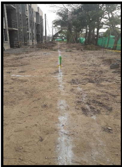
1 demarcación de pozos y red de alcantarillo
