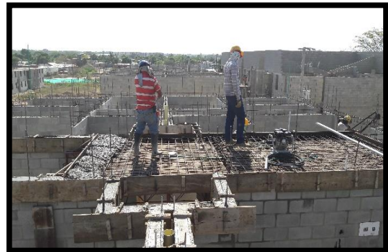
59 Fundida de placa tanque Fuente. Autor (2016)
