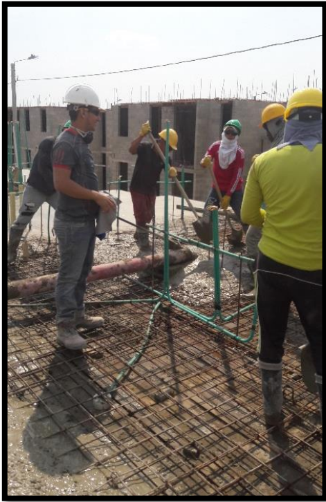
39 supervisión de fundida de placa entrepiso nivel 2 Fuente. Autor (2016)
