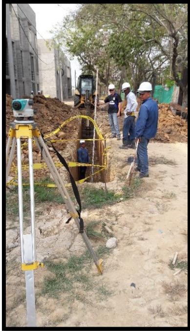
7 verificación de excavación con equipo de precisión Fuente. Autor (2016)
