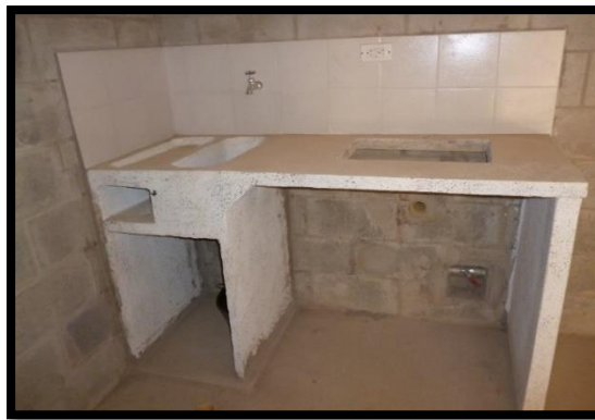
89 Enchape de muro para área de salpicadero el lavadero y lavaplatos. Fuente: Autor (2016)
