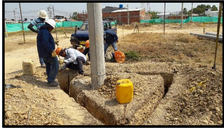
28 instalación de varillas de cobre en triangulo Fuente. Autor (2016)
