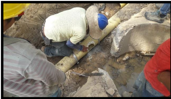
13 Aplicación de silicona sika Fuente. Autor (2016)
