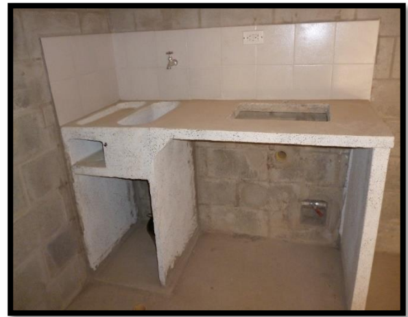
93 Mesón en imitación de grano instalado. Fuente: Autor (2016)
