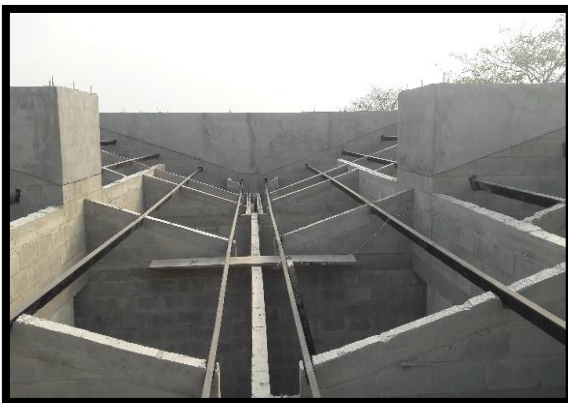
95 Cerchas de estructura metálica para cubierta de torres 1 y 2 del bloque 5. Fuente: Autor (2016)
