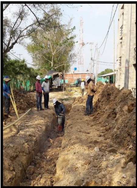
16 Compactación del material común en zanjas Fuente. Autor (2016)
