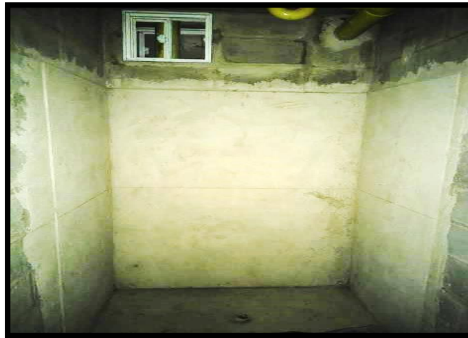
86 Impermeabilizado de muros de baños en mortero con sika 1.
