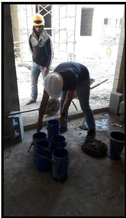
98 Toma de cilindros de muestra para vigas. Fuente: Autor (2016)
