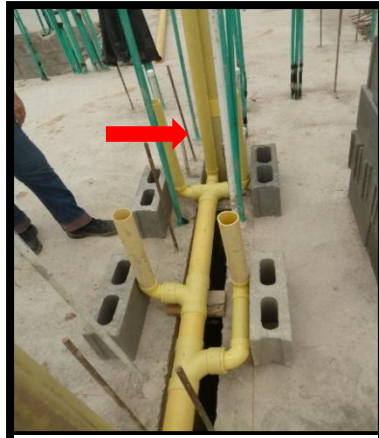
80 Tubería sanitaria de 2" para puntos de ventilación en 2do nivel. Fuente: Autor (2016)
