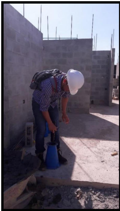
102 Realización de ensayo en concreto grouting para fijación de mampostería en el bloque 13.
