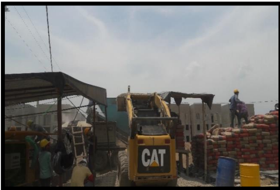
41 añadiendo agregados a la concretara Fuente. Autor (2016)
