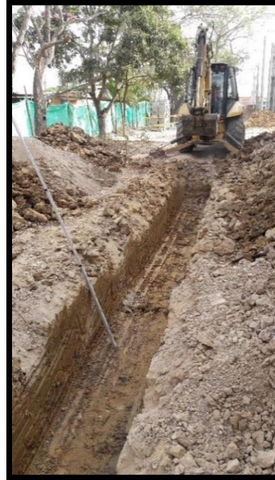
6 excavación mecánica para tubería sanitaria Fuente. Autor (2016)
