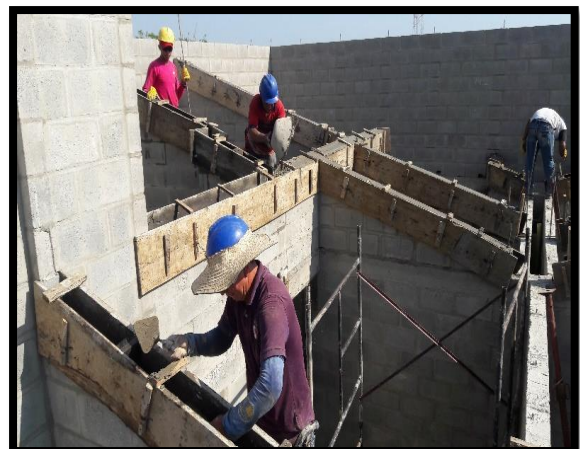
53 Fundición de viga culata de 12x17 Fuente. Autor (2016)
