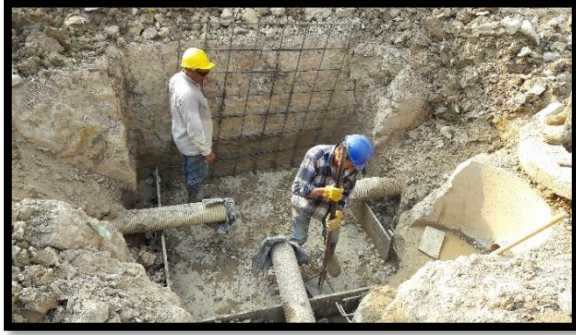
25 adecuación del terreno para base de pozo Fuente. Autor (2016)
