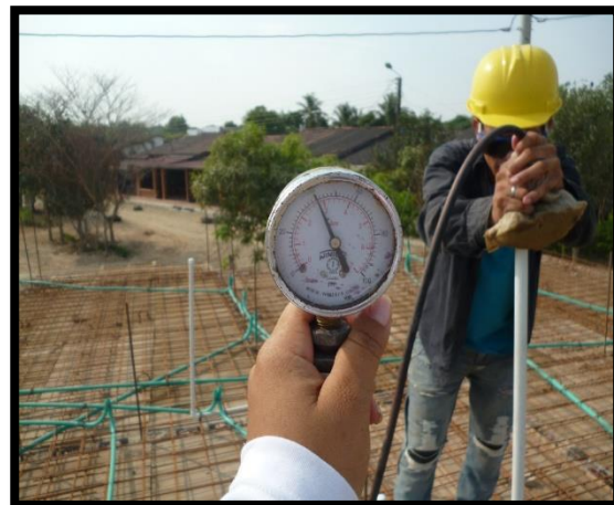
75 ensayo de presión en red domiciliaria Fuente. Autor (2016)
