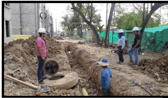
14 relleno con material común para zanjas de tubería de alcantarillado Fuente. Autor (2016)
