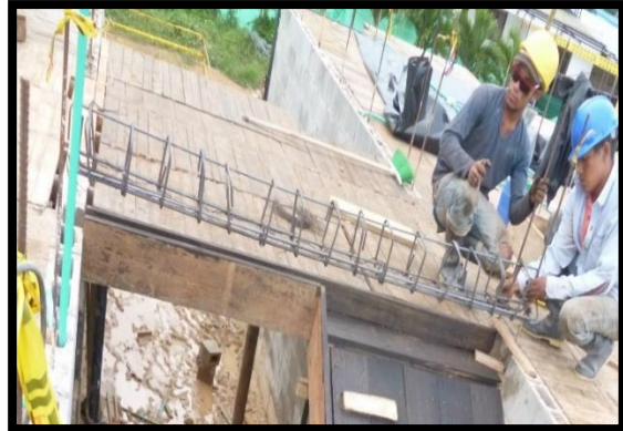
68 acero de refuerzo de viga de escaleras Fuente. Autor (2016)
