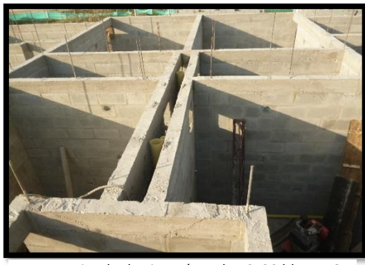
44 terminado de viga aérea de 12x20 bloque 6 Fuente. Autor (2016)
