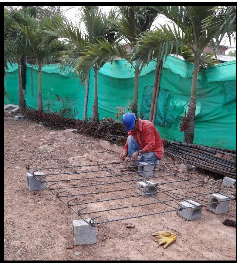
70 acero de refuerzo para base de pozos de alcantarillado Fuente. Autor (2016)
