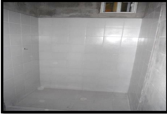
88 Enchape de muros y piso de baños en cerámica blanca.
