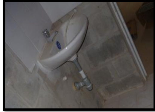
87 Enchape de muro en salpicadero de lavamanos.
