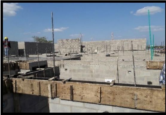
47 Encofrado de viga aérea de 12x20 bloque 9 Fuente. Autor (2016)
