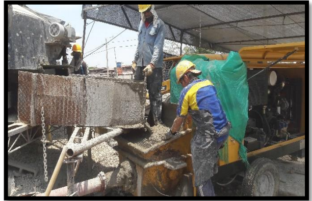
38 Expulsión de concreto con bomba de concreto Fuente. Autor (2016)
