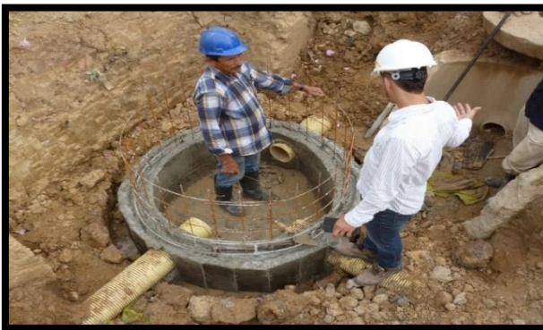
24 fundida del primer anillo del pozo de alcantarillado Fuente. Autor (2016)
