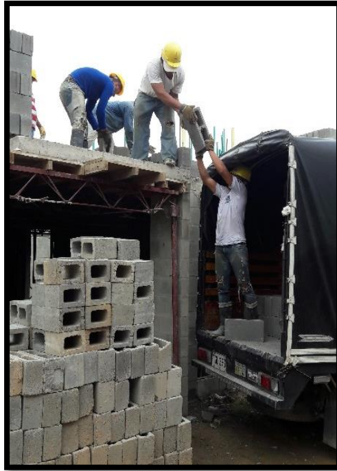
33 acarreo de bloque estructural Fuente. Autor (2016)
