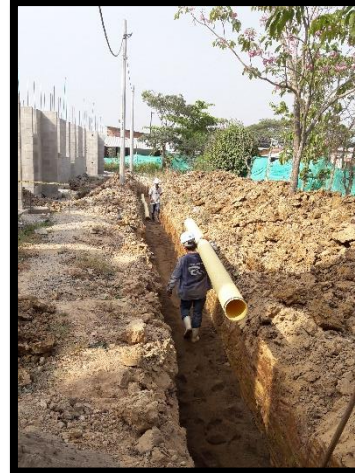
9 instalación de arena en zanjas Fuente. Autor (2016)
