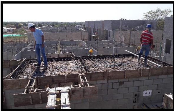
56 Inspección de placa tanque Fuente. Autor (2016)
