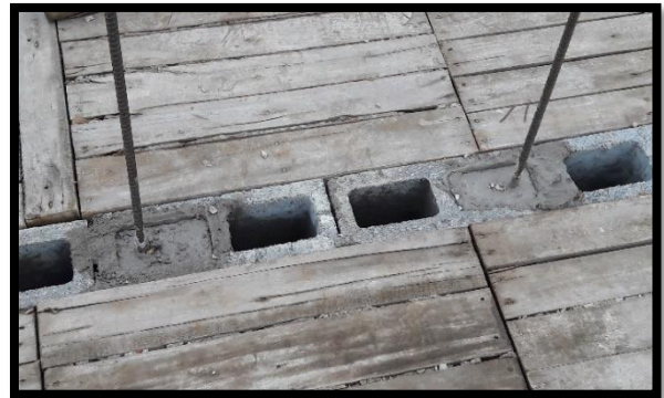
42 Colocación de concreto grouting Fuente. Autor (2016)
