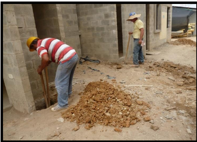
30 Excavación para caja de apantallamiento Fuente. Autor (2016)
