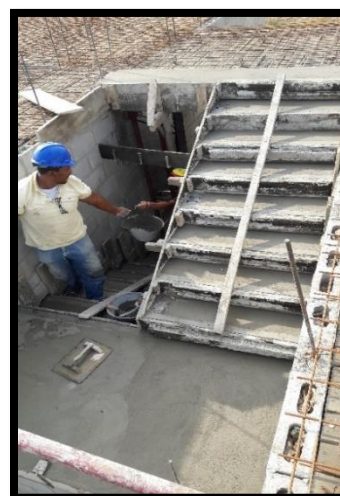
52 Terminación de fundida de escalera Fuente. Autor (2016)
