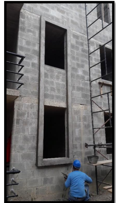
60 terminado de borde ventana bloque 6 Fuente. Autor (2016)
