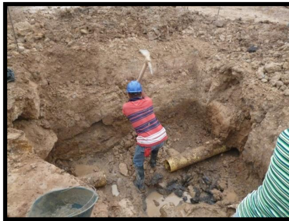
5 excavación manual para pozo de alcantarillado bloque 5 y 9 Fuente. Autor (2016)
