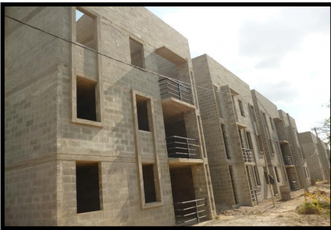
84 Barandas en balcón en el bloque 5, en los niveles 1,2 y3. Fuente: Autor (2016)
