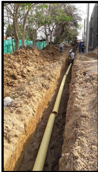
10 instalación de tubería novafort 8" Fuente. Autor (2016)
