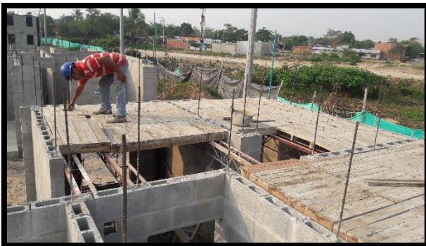
36 encofrado placa entrepiso nivel 2 Fuente. Autor (2016)
