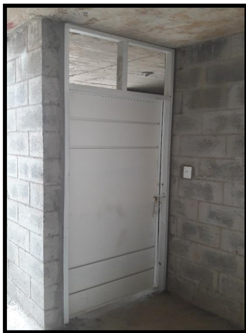
85 Puerta de entrada principal instalada en el apto 1, del nivel 1, en la torre 2, del bloque 5. Fuente: Autor (2016)
