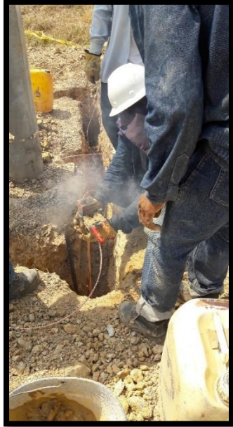
27 tiro de soldadura de polo a tierra Fuente. Autor (2016)
