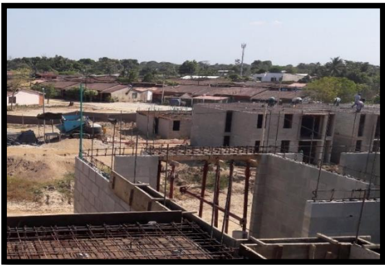
45 hierro de viga aérea de 12x20 bloque 6 Fuente. Autor (2016)
