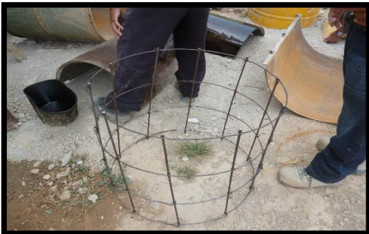
17 Hierro de 3/8" para caja de inspección de aguas lluvia Fuente. Autor (2016)
