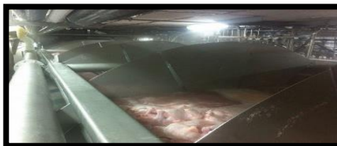
Figura 10. Etapa chiller 2 de la planta de beneficio.
