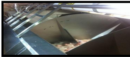
Figura 9. Etapa pre-chiller y chiller 1 de la planta de beneficio.
