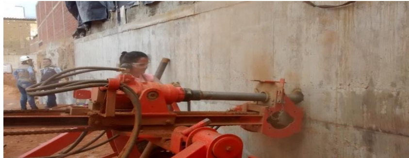
Figura 20. Perforación para anclaje.
