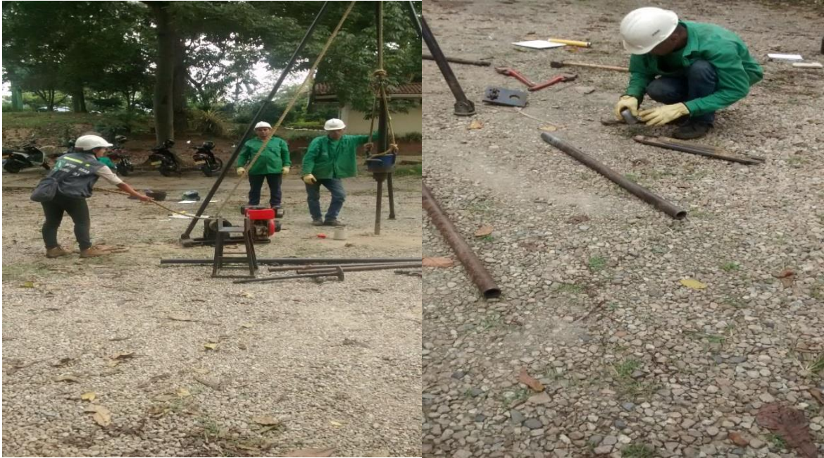
Figura 28. Perforaciones y Tomas de Muestra, Ensayo de SPT.
