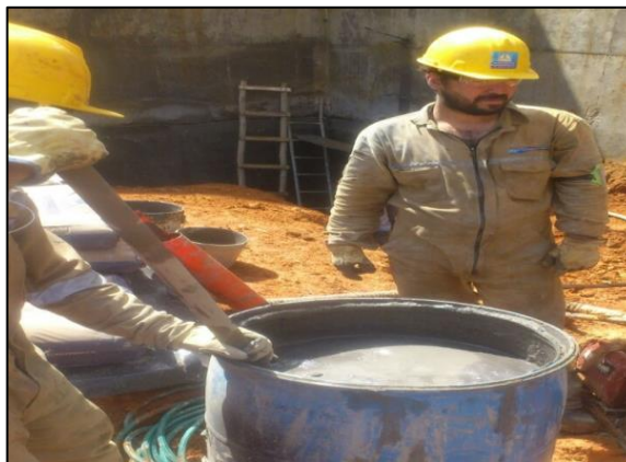
Figura 22. Preparación de la lechada.
