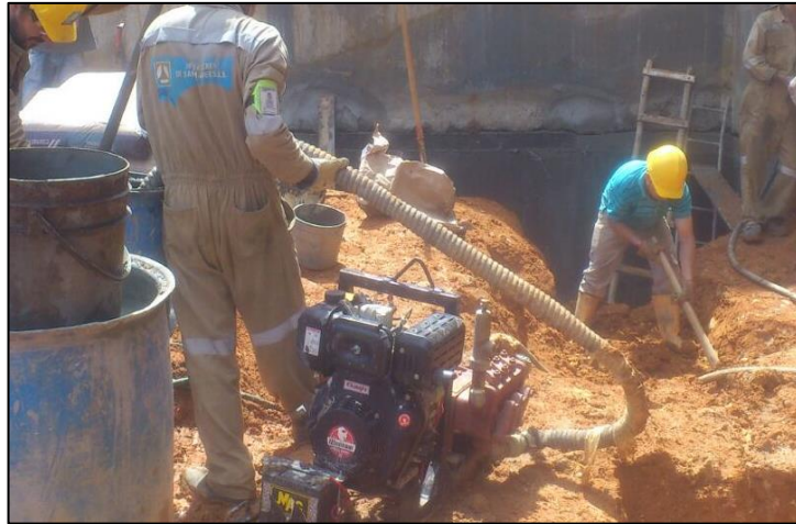
Figura 23. Inyección de la lechada
