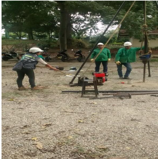
Figura 6. Realización de Ensayos de SPT
