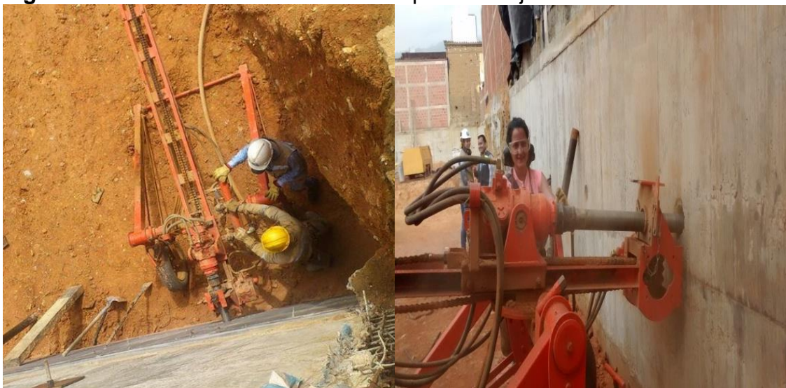
Figura 26. Realización de Perforaciones para Anclajes.
