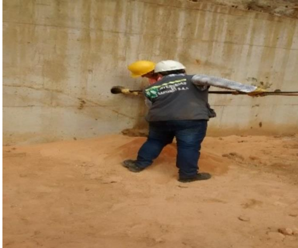
Figura 21. Instalación de la barra
