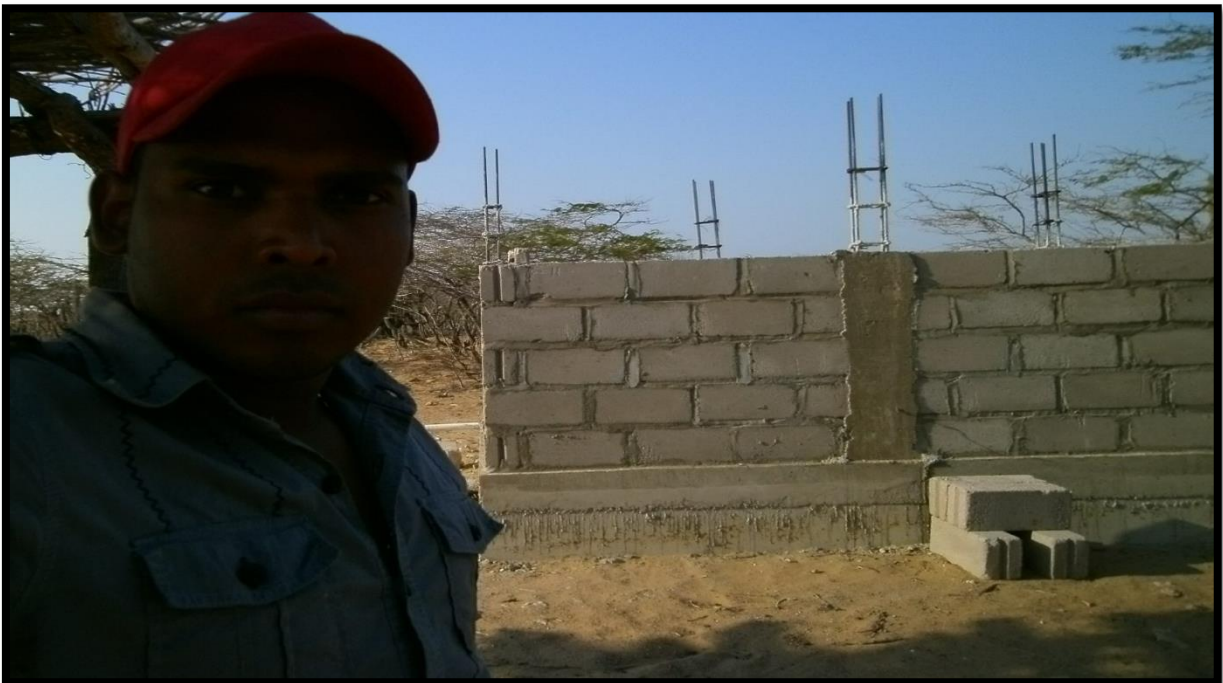
Imagen 21. Alberca de almacenamiento de agua en su fase media
