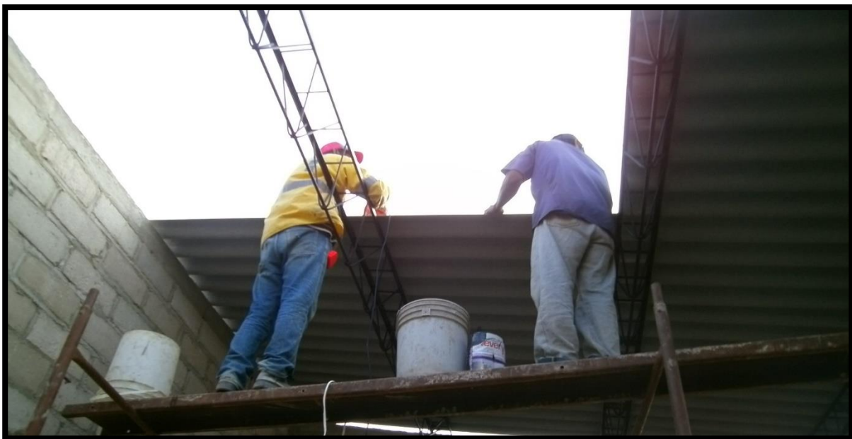
Imagen 23. Instalación de cubierta en tejas de asbesto cemento
