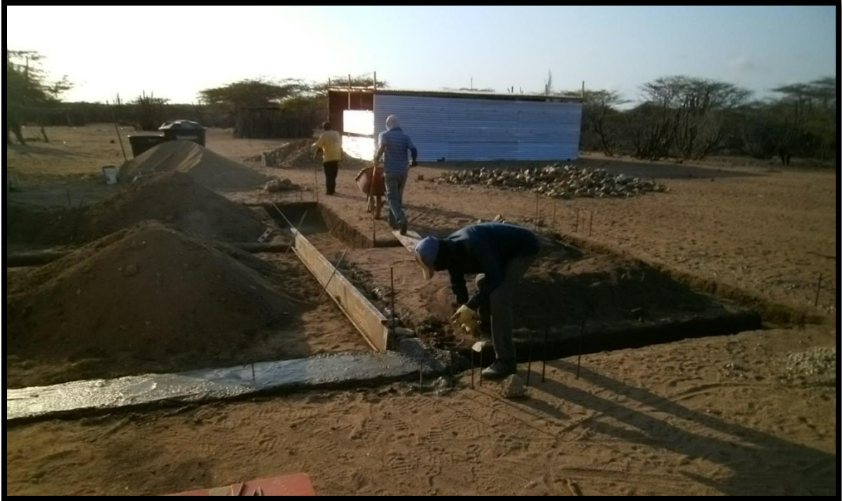
Imagen 7. Colocación de concreto para viga de cimentación
