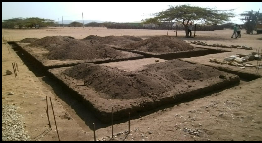
Imagen 4. Excavación de aula
