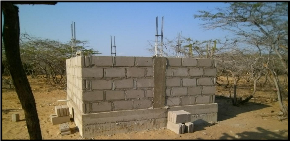
Imagen 20. Mampostería de la alberca de almacenamiento de agua
