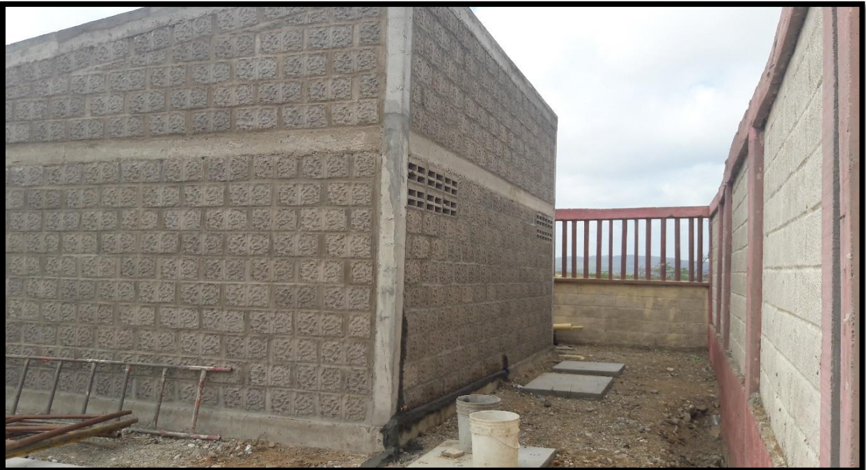
Imagen 19. Alzado de muros en bloque abuzardado
