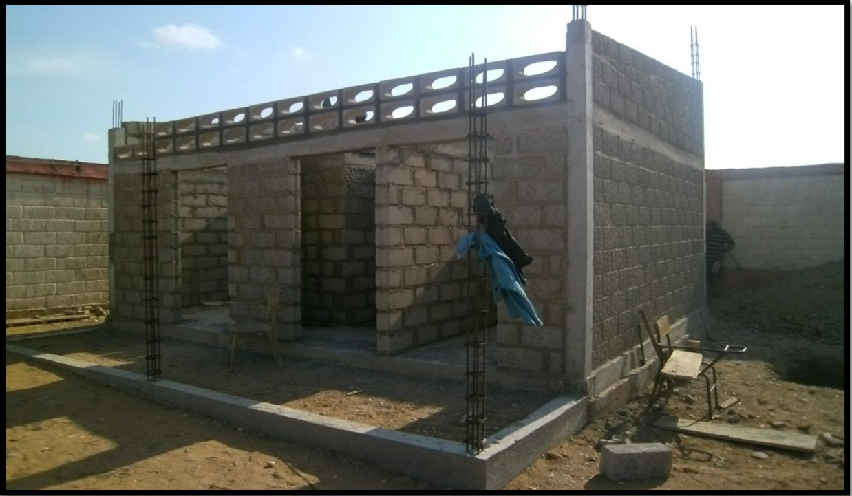
Imagen 18. Alzado de muros en bloque abuzardado
