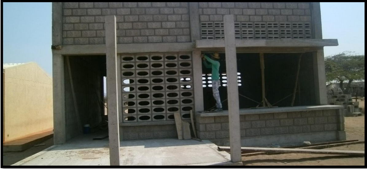
Imagen 28. Instalación de bovedilla ojo de buey y visualización de bovedilla en persiana
