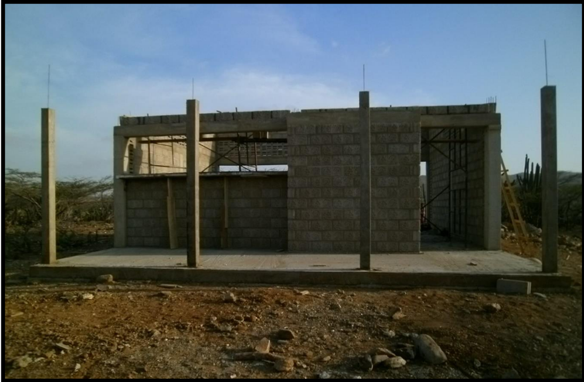
Imagen 17. Alzado de muros en bloque abuzardado
