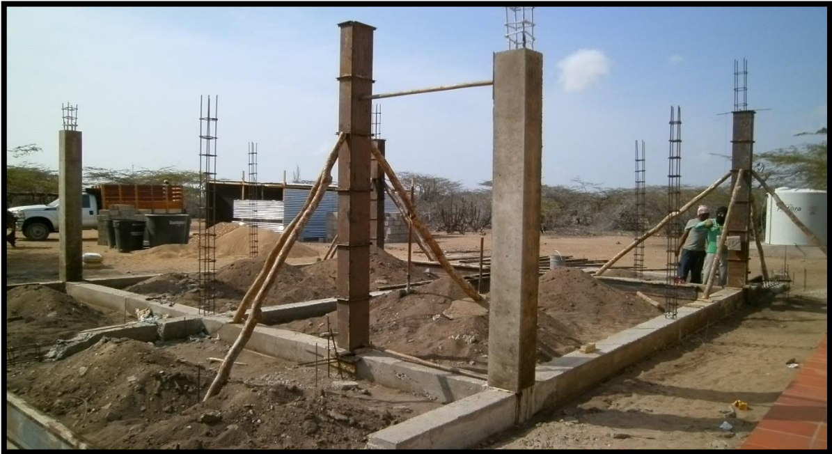
Imagen 11. Encofrado y desencofrado de columnas
