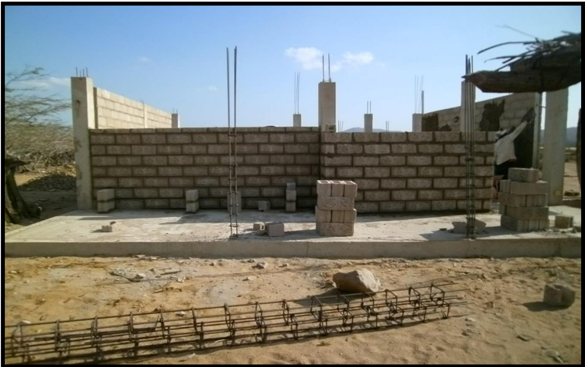
Imagen 16. Alzado de muros en bloque abuzardado
