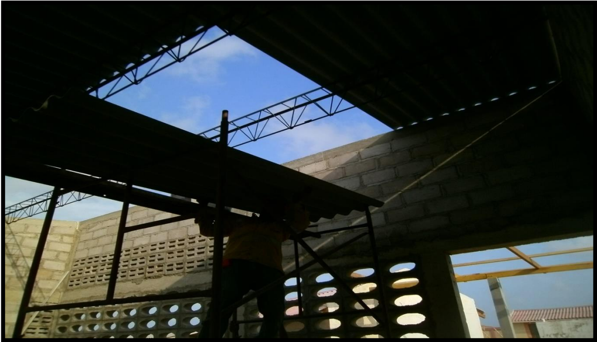
Imagen 22. Instalación de cubierta en tejas de asbesto cementsos
