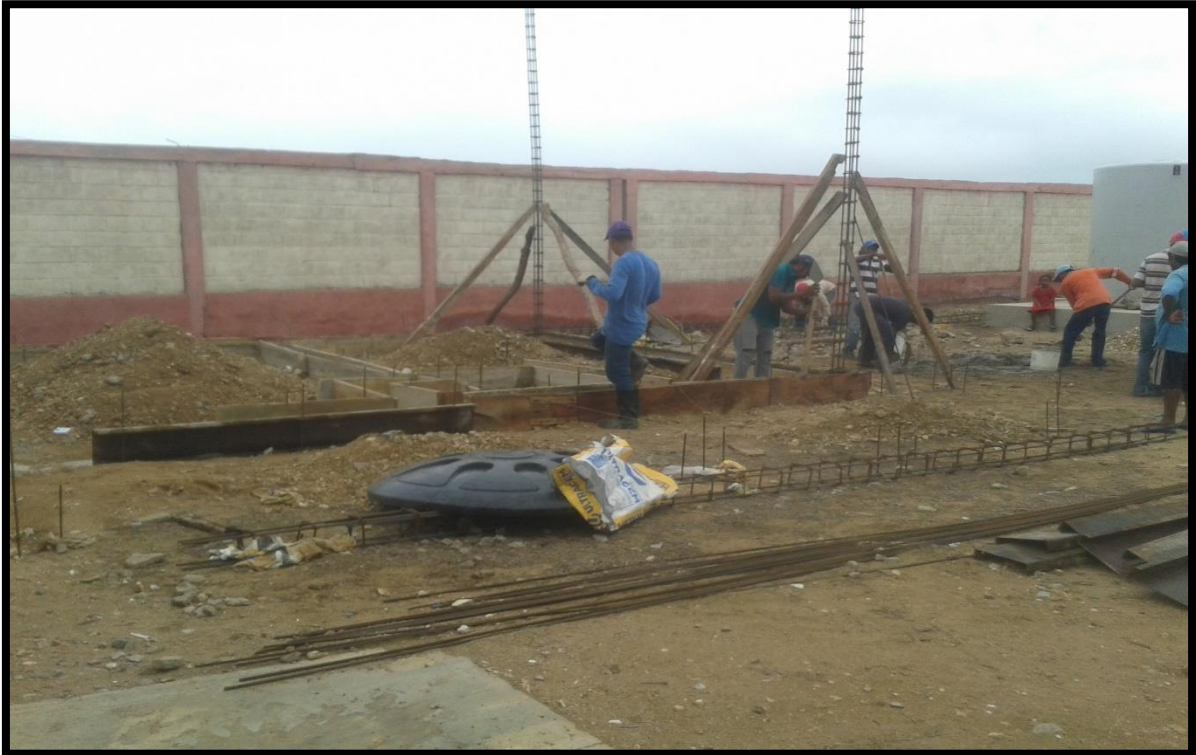
Imagen 8. Cimentación de unidad sanitaria
