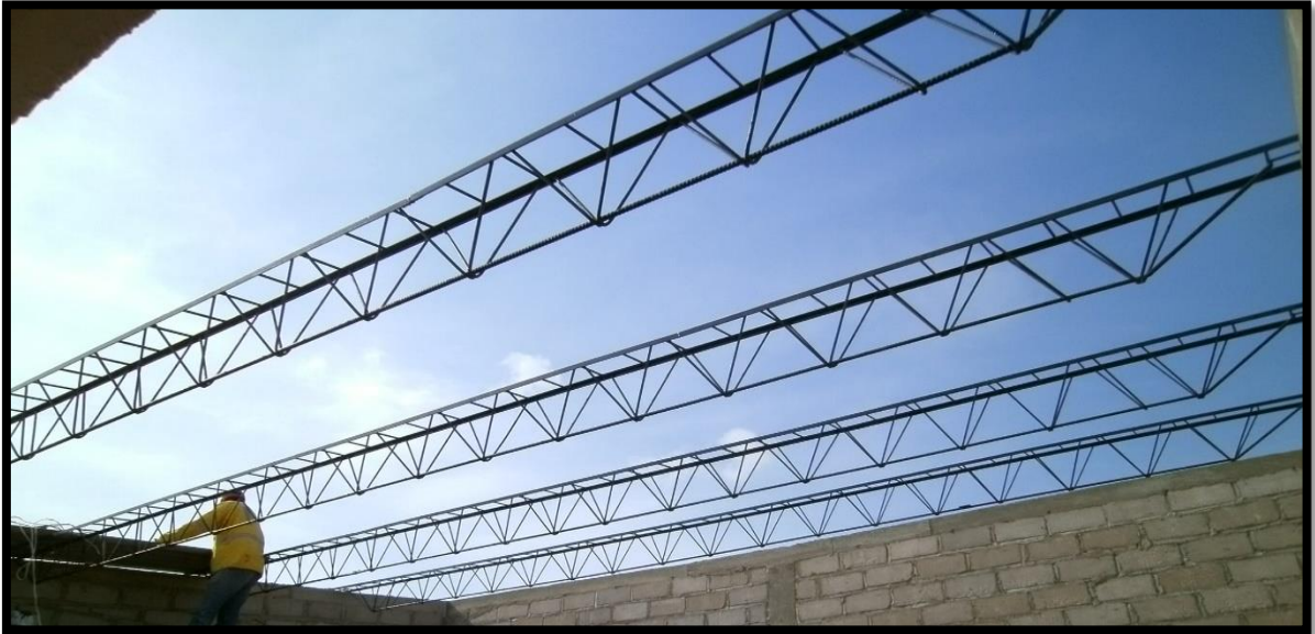
Imagen 12. Montura de cercas Metálica
