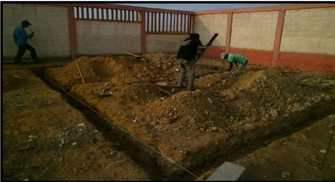
Imagen 5. Excavación unidad sanitaria
