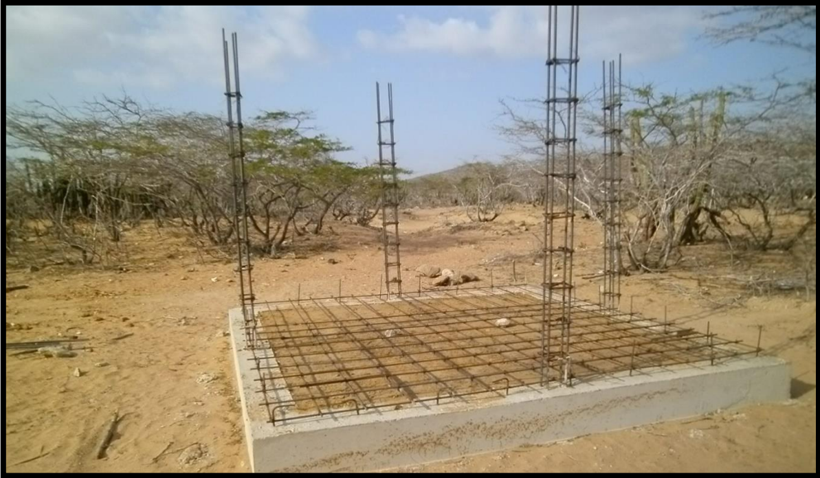
Imagen 13. Estructura metálica de alberca de almacenamiento de agua
