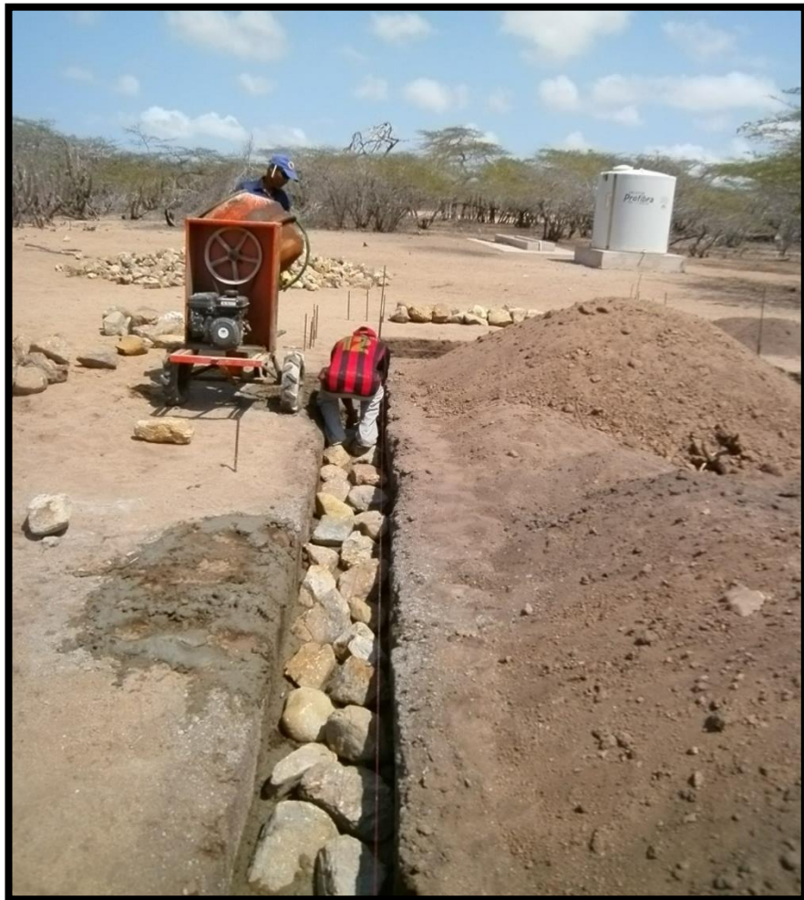
Imagen 6.colocación de ciclópeo
