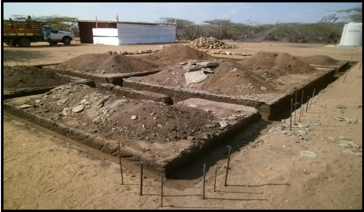
Imagen 3. Excavación de aula parte frontal
