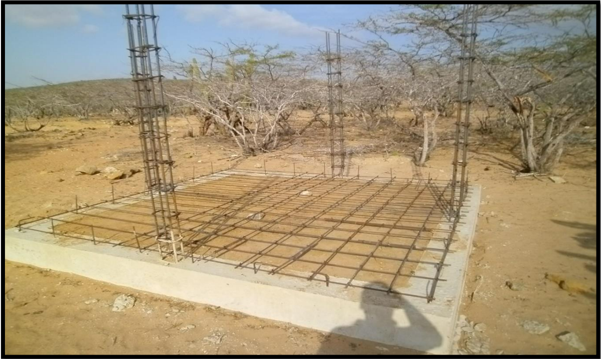
Imagen 9. Cimentación de alberca de almacenamiento de agua
