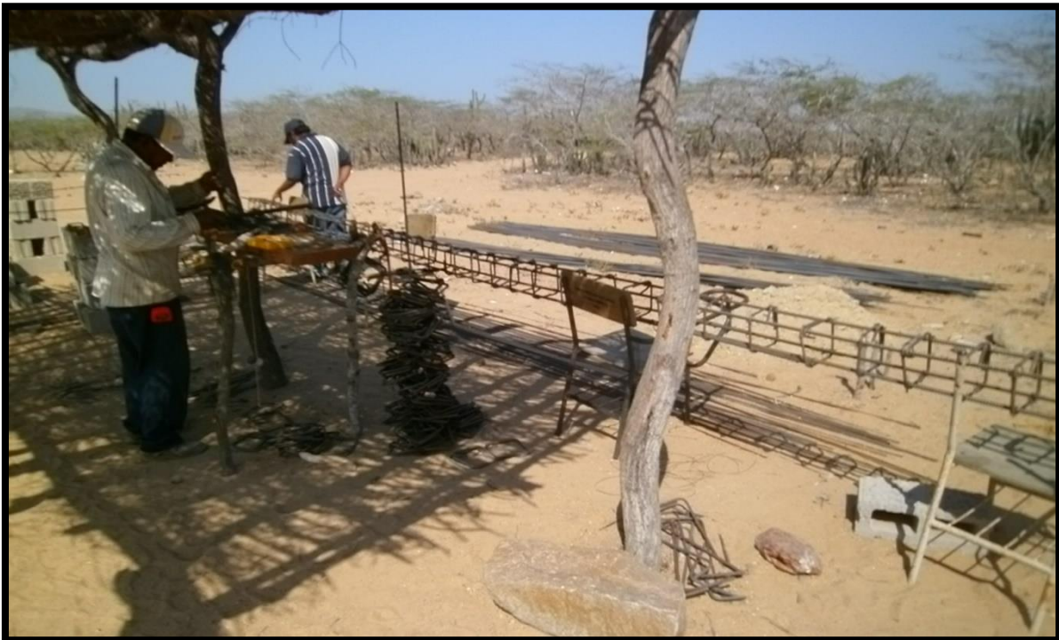
Imagen 30. Elaboración de estructuras metálicas
