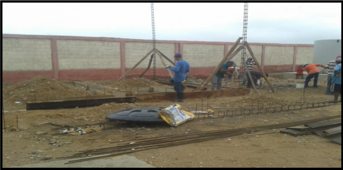
Imagen 14. Estructura metálica unidad sanitaria
