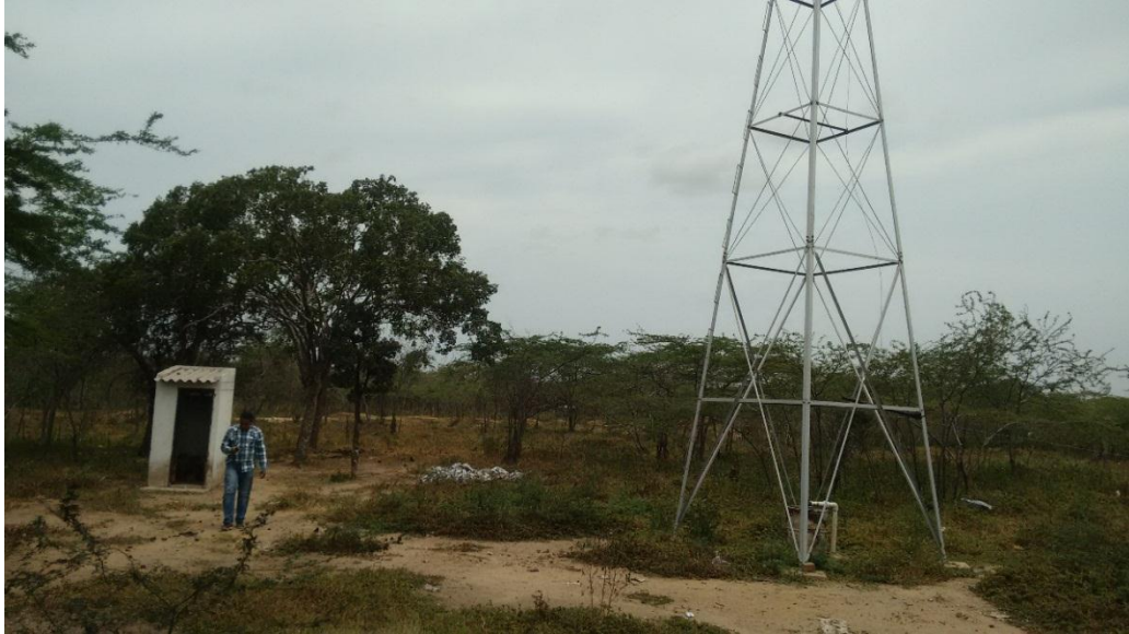
Foto 8. Inspección de las instalaciones del pozo.
