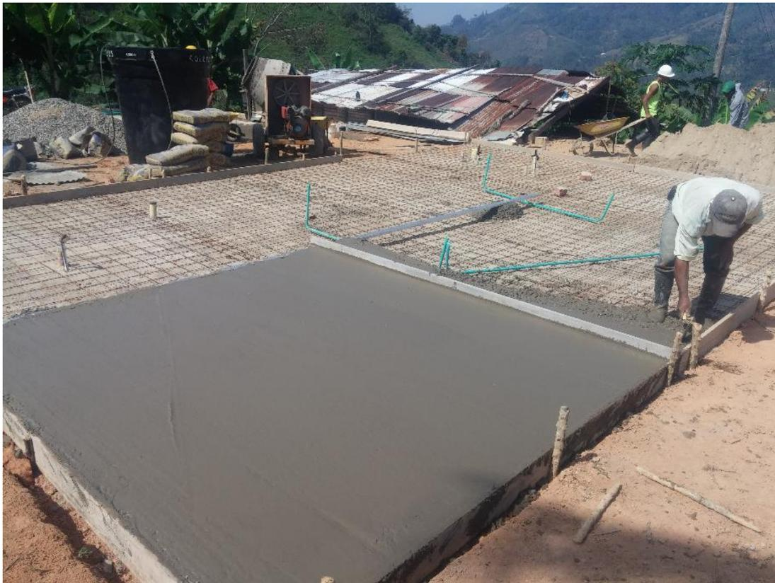
En esta imagen se aprecia las tuberías hidrosanitarias, eléctricas instaladas y la respectiva instalación de la malla electrosoldada.
