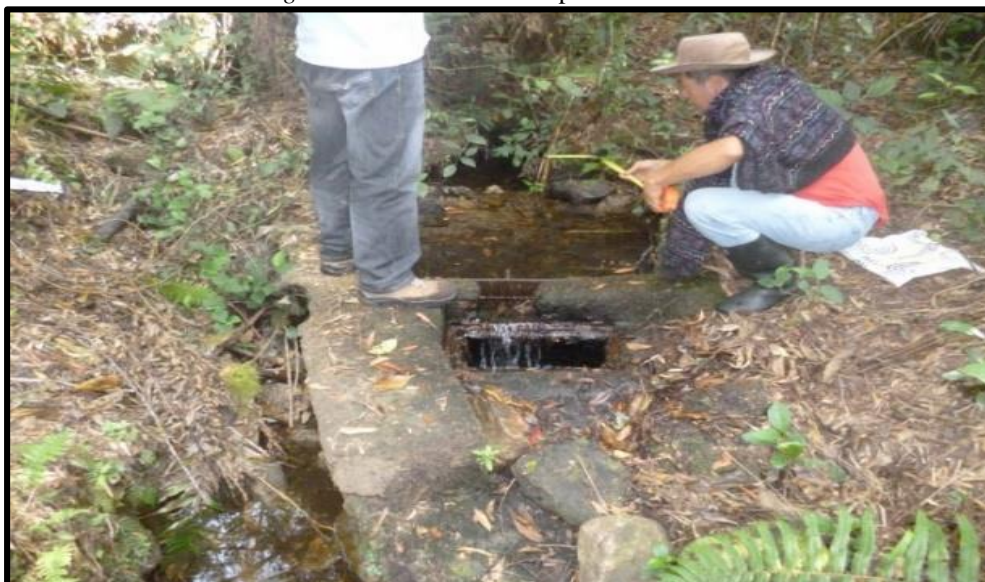
Figura 14. Estructura de Captación Existente
