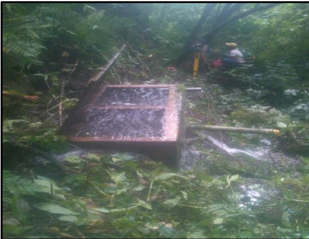
Figura 9. Desarenador Existente
