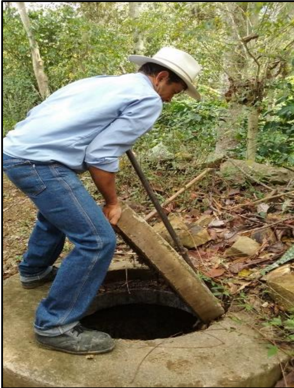
Figura 19. Inspección de Pozos Laguna de Ortices
