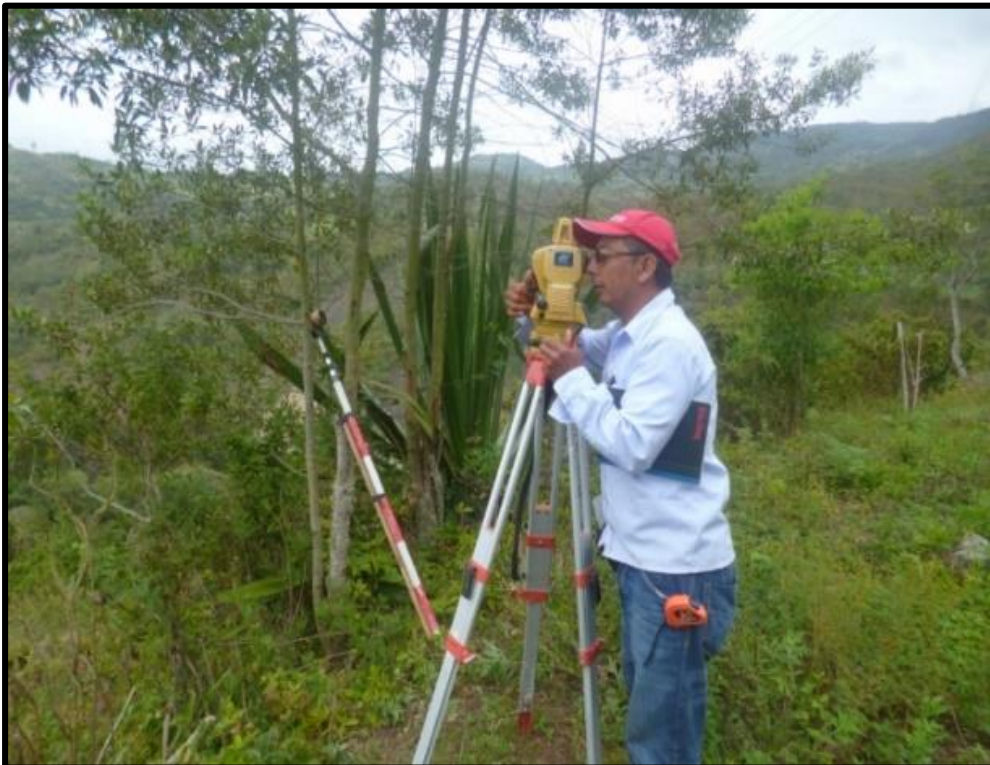
Figura 24. Levantamiento Topográfico Acueducto San Andrés
