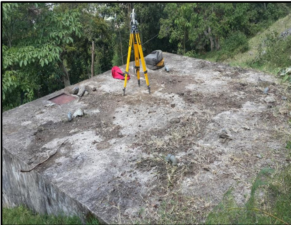
Figura 11. Tanque de Almacenamiento 1 existente
