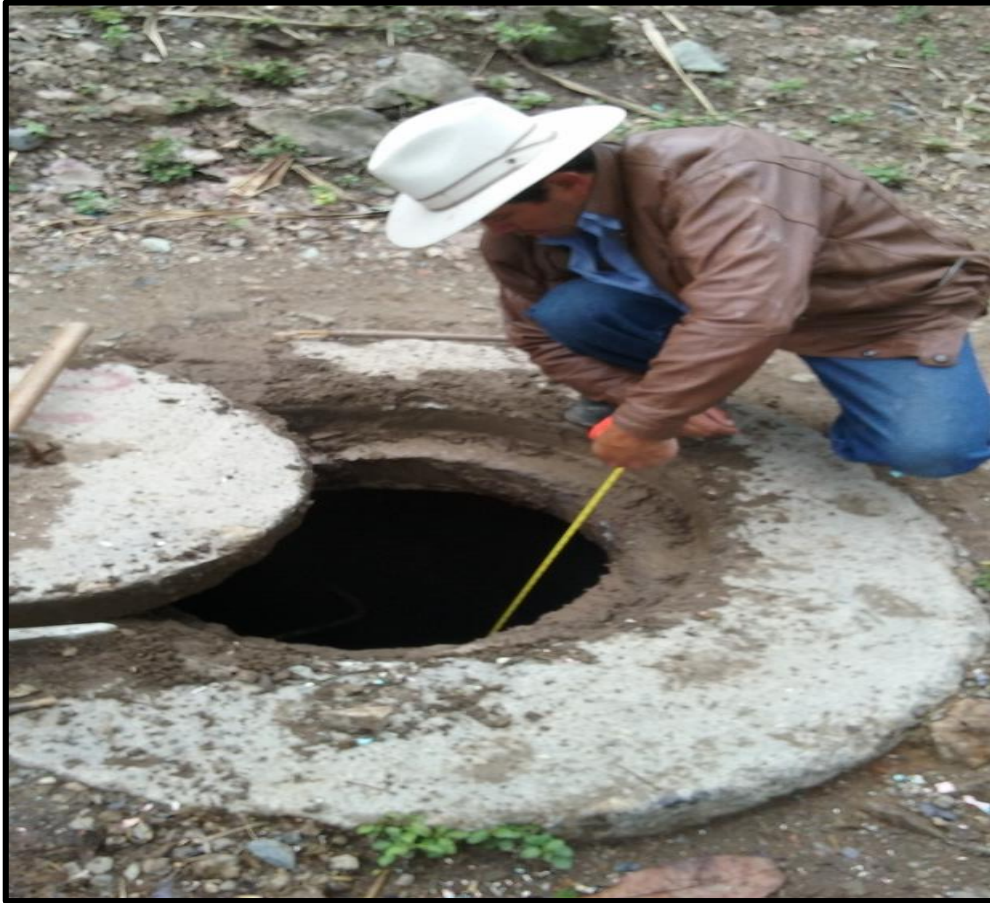
Figura 22. Inspección de Pozos Pangote
