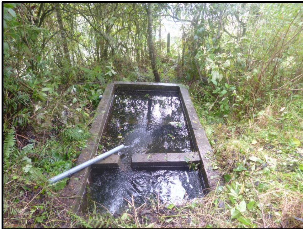
Figura 52. Desarenador 1 Existente Pangote
