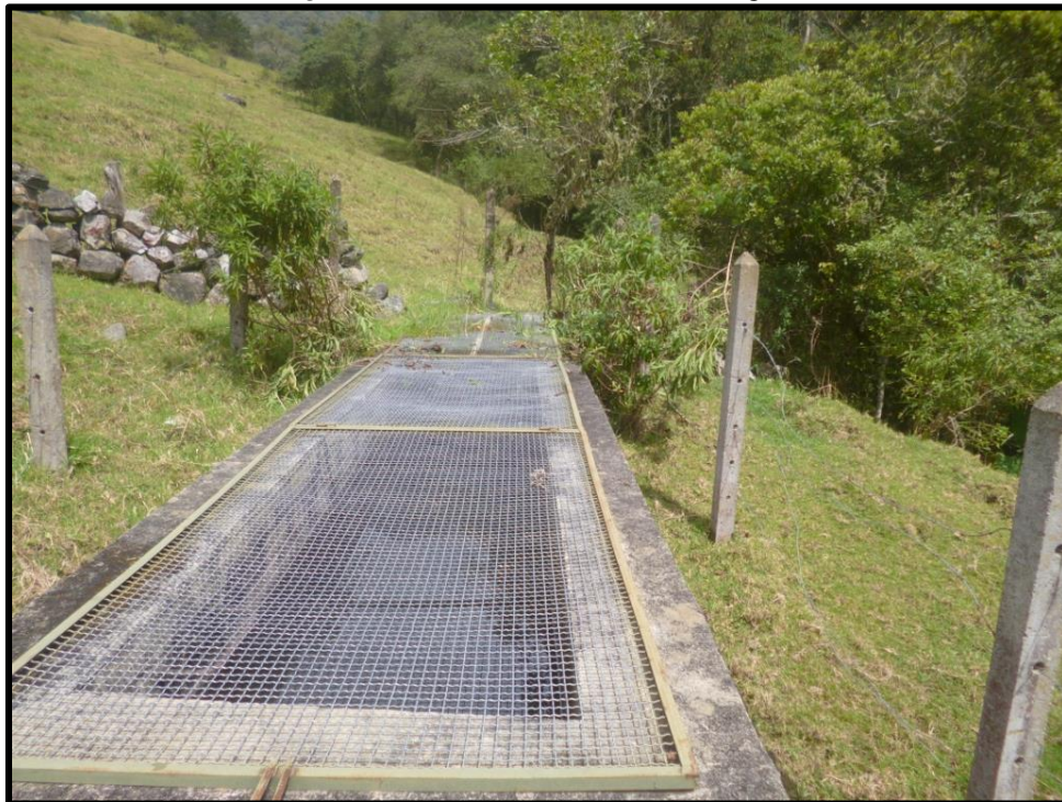
Figura 53. Desarenador 2 Existente Pangote
