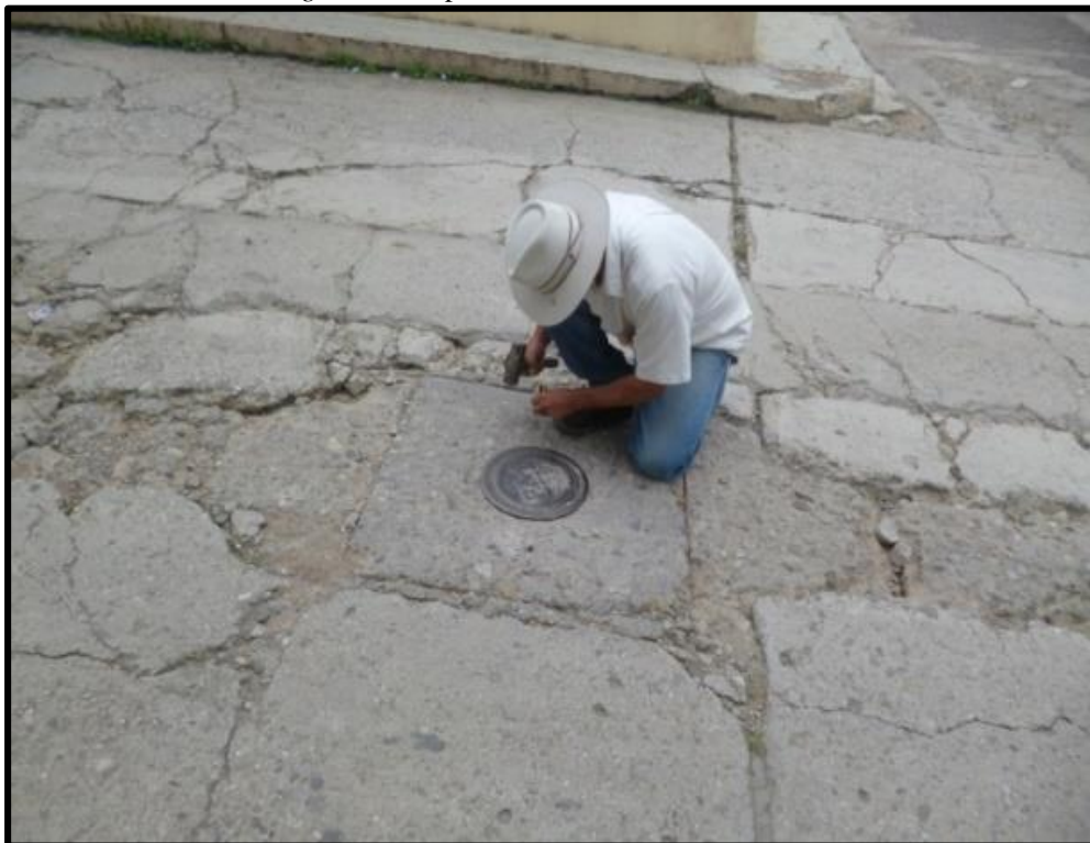
Figura 38. Inspección de Válvulas San Andrés
