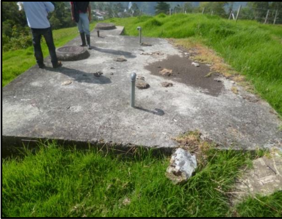
Figura 17. Tanque de Almacenamiento Existente
