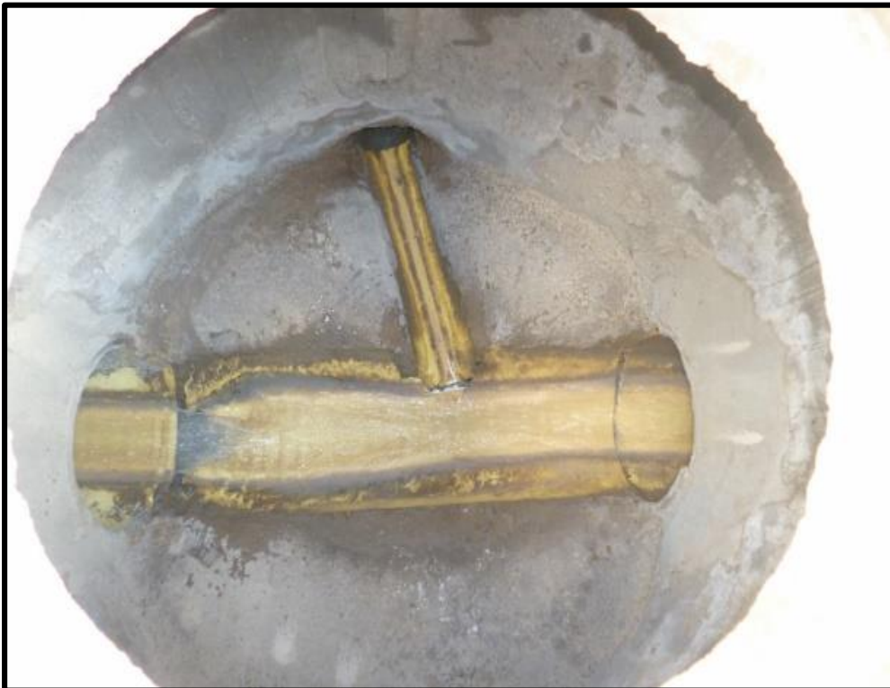
Figura 33. Interior de Pozos San Andrés
