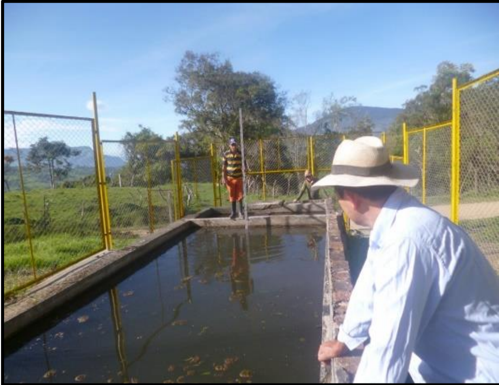
Figura 25. Desarenador Acueducto San Andrés
