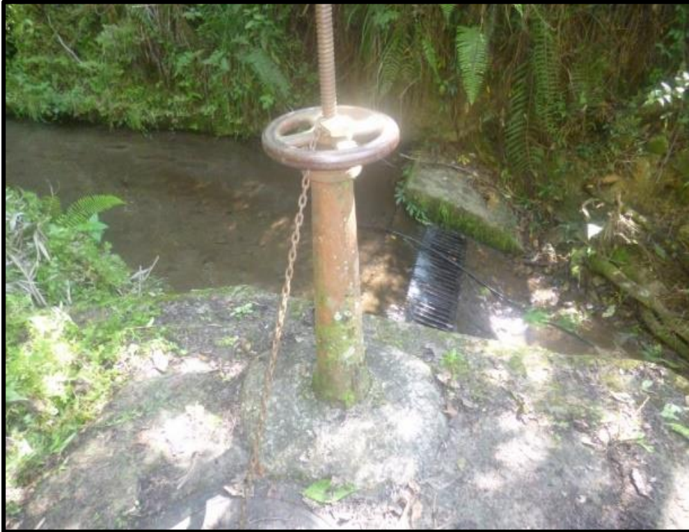
Figura 23. Estructura de Captación Acueducto San Andrés
