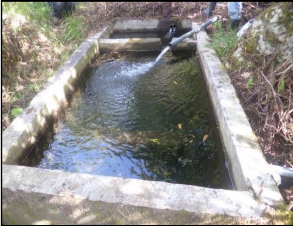
Figura 15. Desarenador 1 Existente
