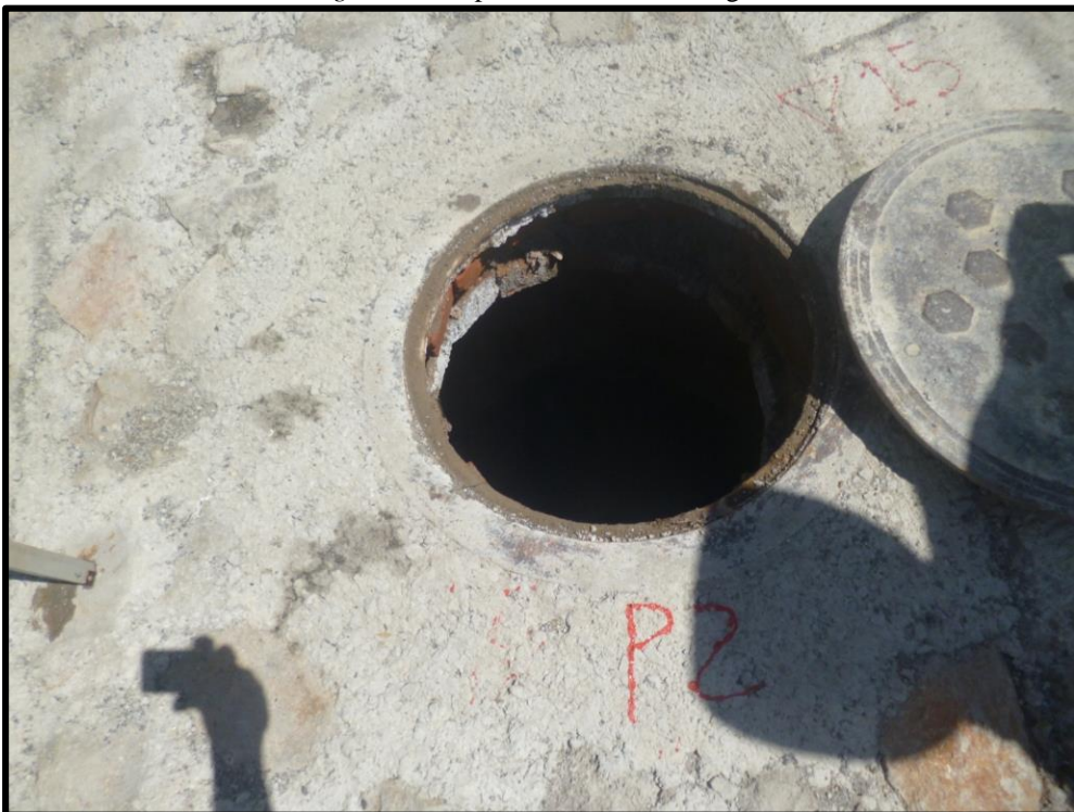
Figura 21. Inspección de Pozos Pangote
