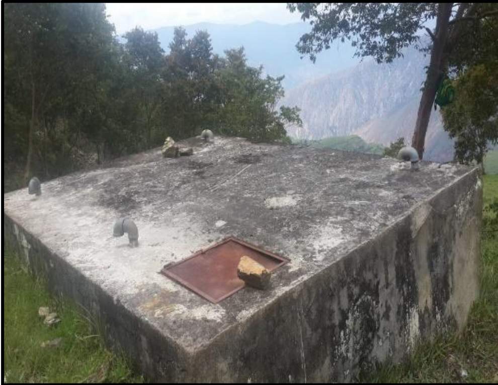
Figura 12. Tanque de Almacenamiento 2 existente
