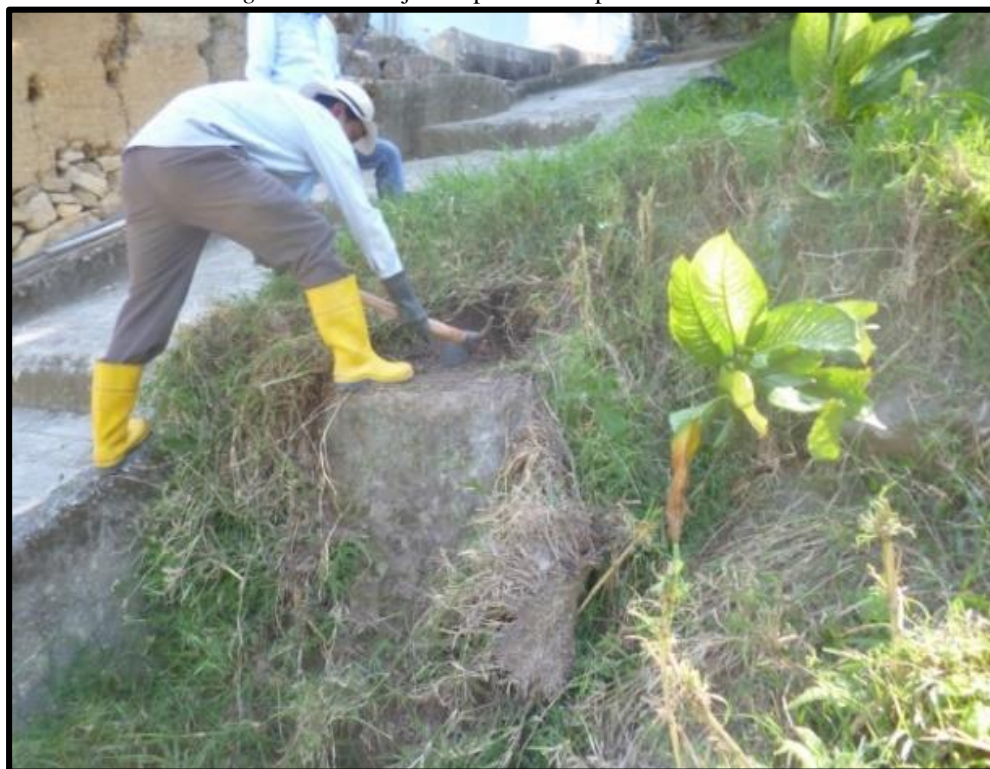
Figura 31. Trabajos Inspección de pozos San Andrés
