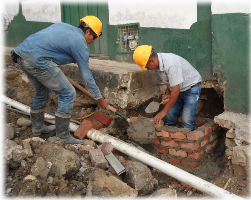
Imagen 37: Construcción Cajas de Inspección
