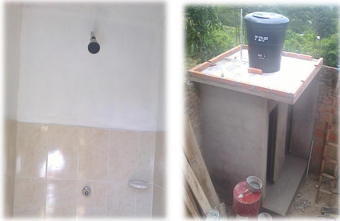
Imagen 18: Instalación de puntos Hidráulicos y Tanque Elevado
