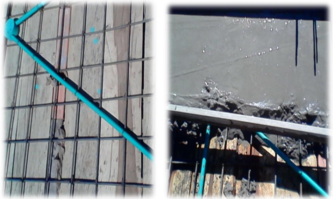
Imagen 12: Formaleta y Fundición de Placa con Instalaciones Eléctricas
