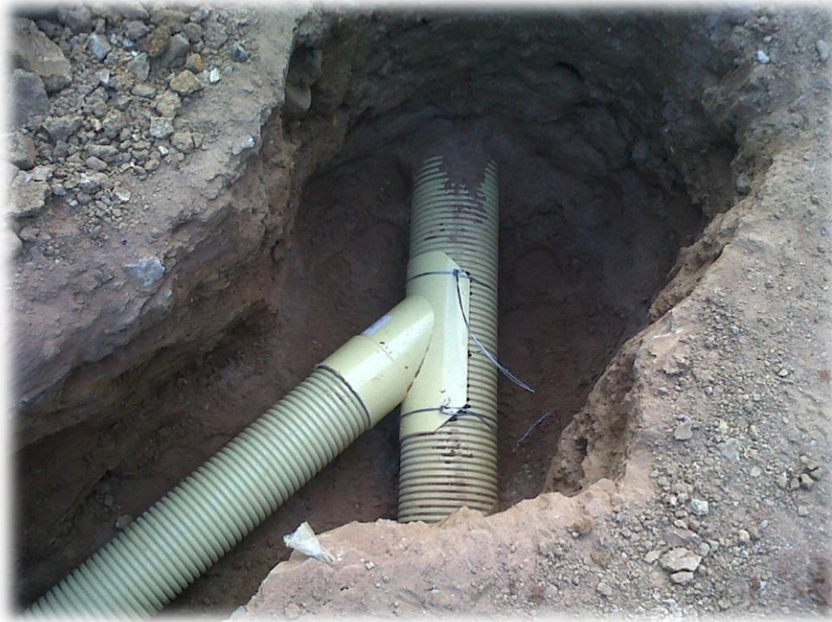
Imagen 38: Instalación de tubería y silla Yee
