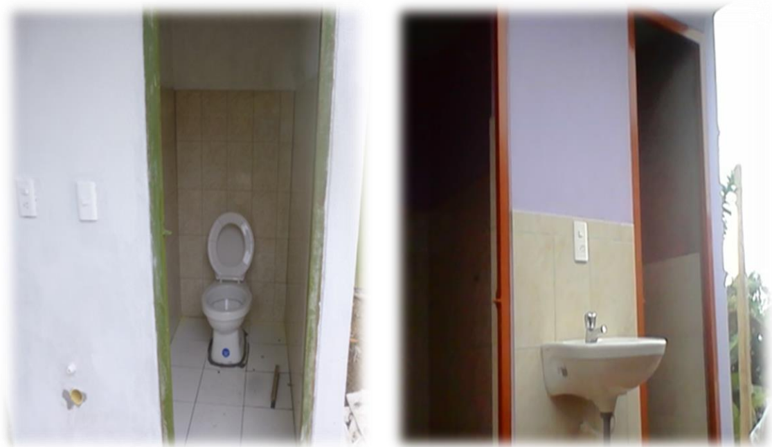
Imagen 19: Instalación de Sanitario y Lavamanos
