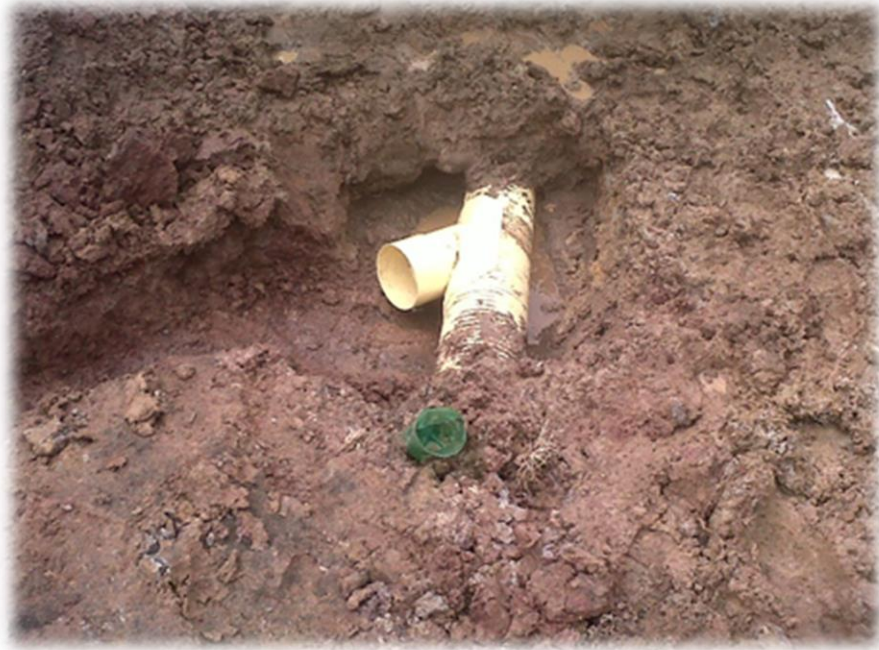
Imagen 23: Instalación Silla Yee a la Tubería principal del Alcantarillado
