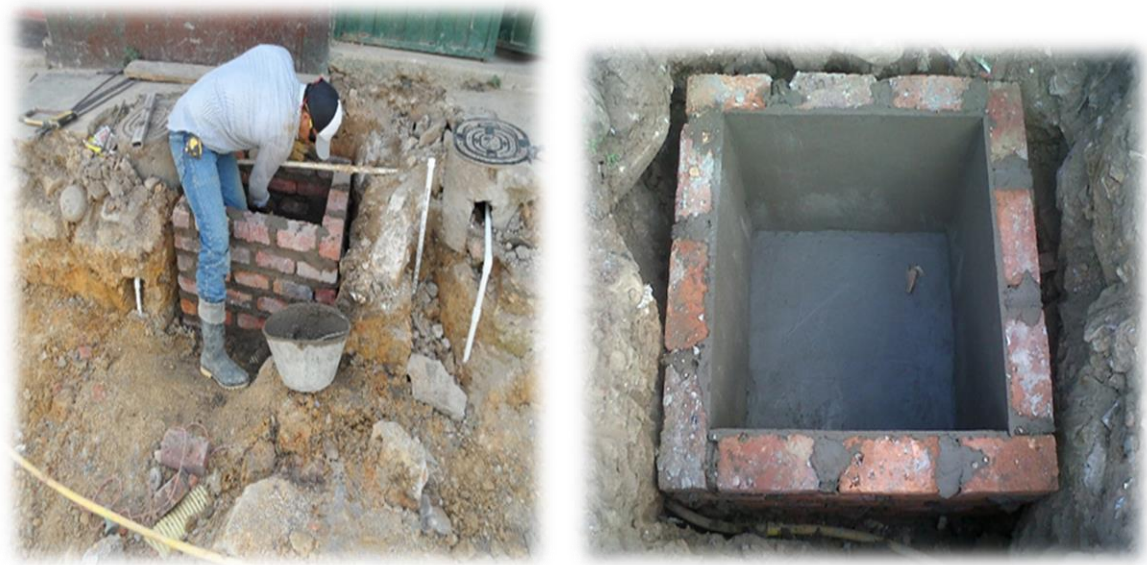
Imagen 25: Construcción cajas de Inspección
