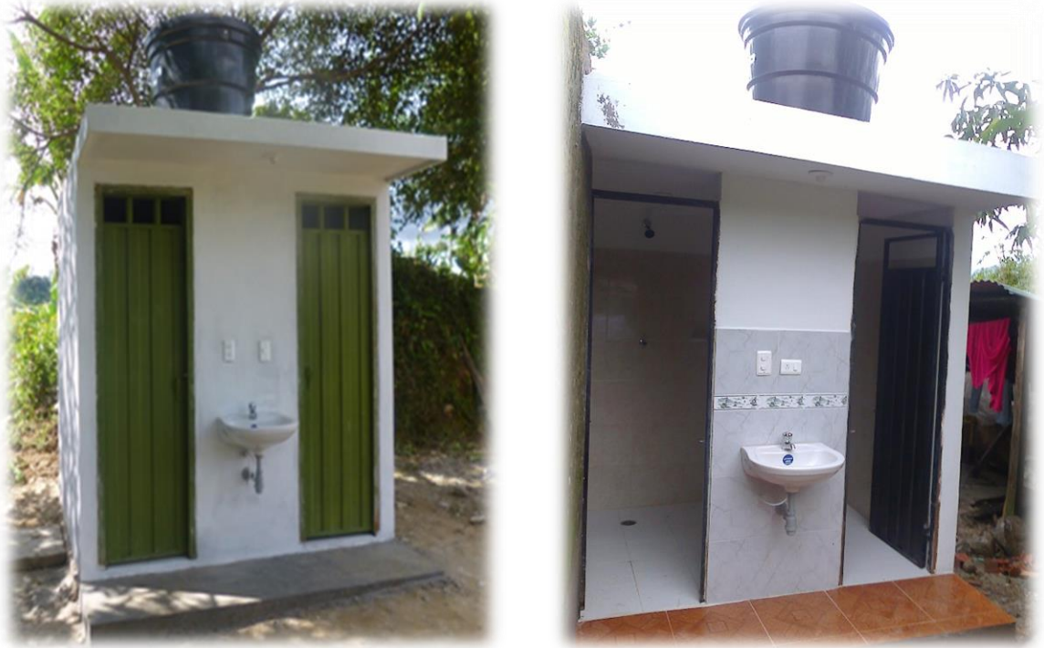
Imagen 21: Fachada Terminada Unidad Sanitaria
