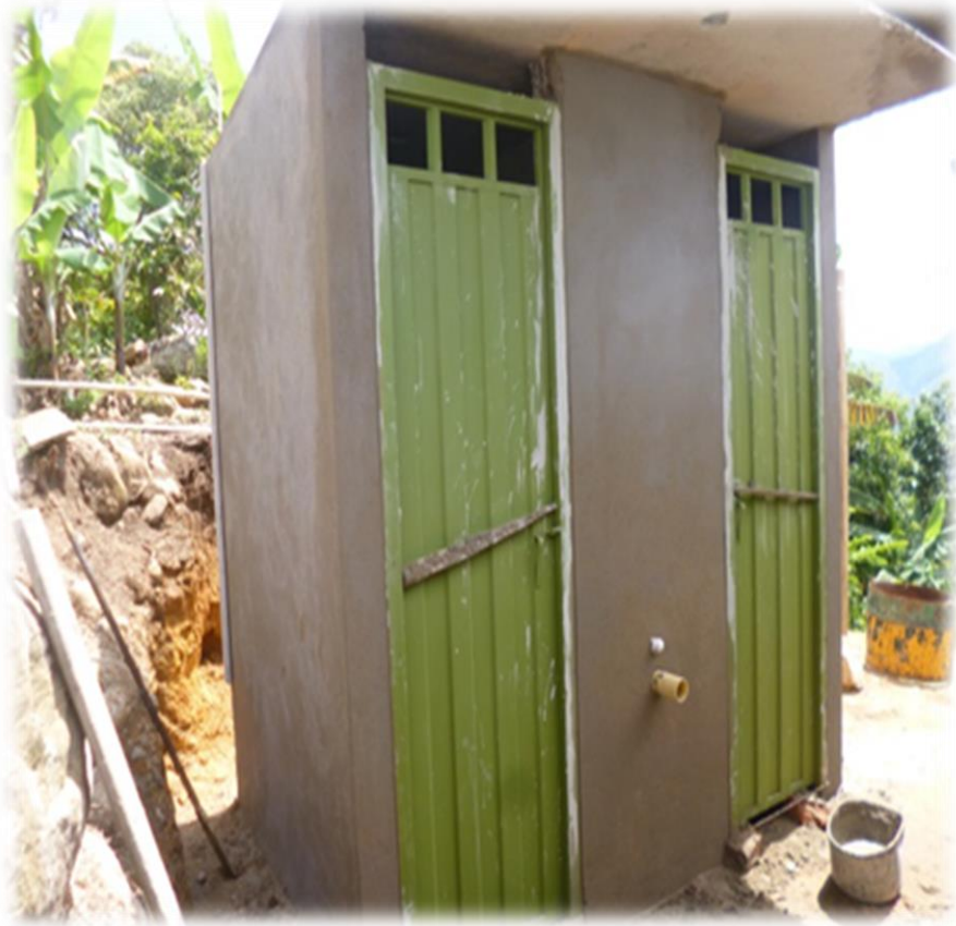
Imagen 14: Instalación Puertas Metálicas, friso parte externa
