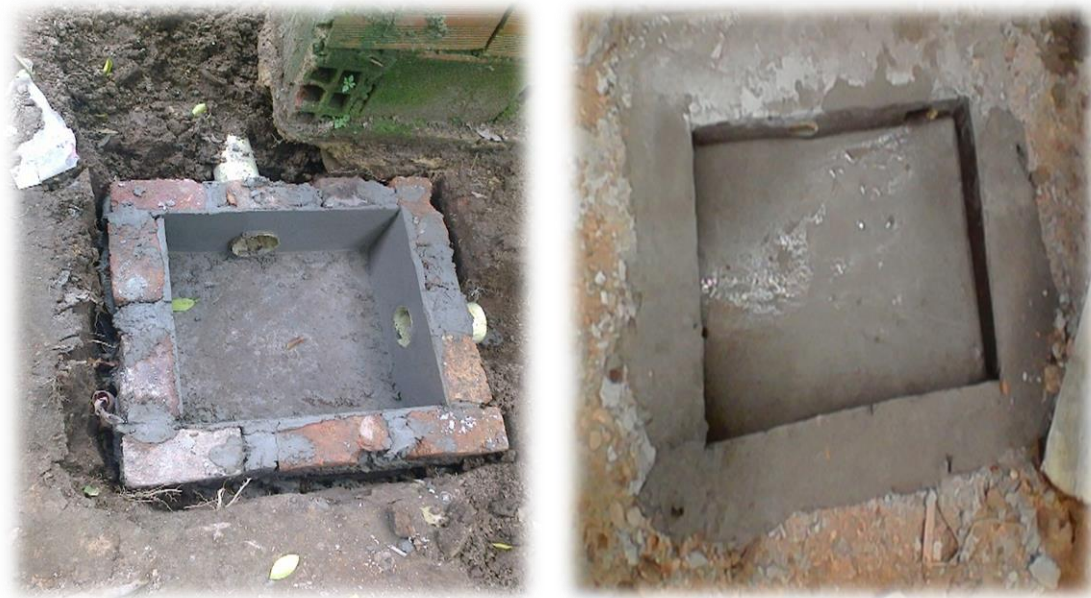
Imagen 11: Construcción cajas de Inspección
