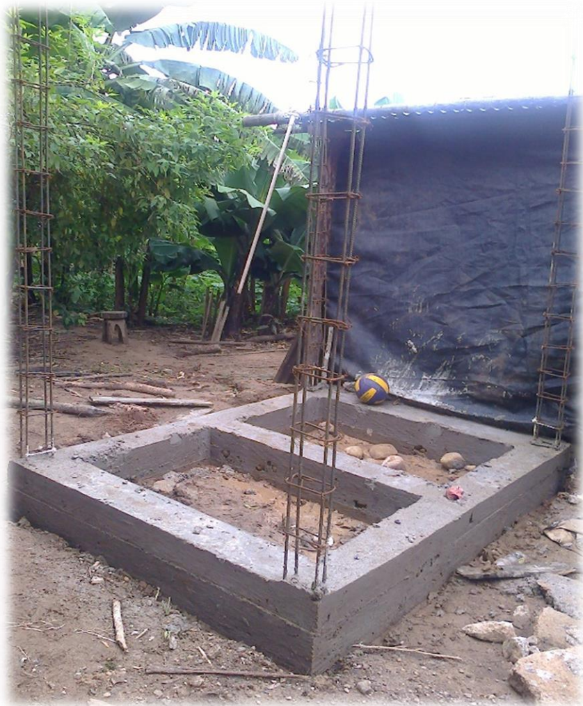
Imagen 8: Fundición de vigas de Cimentación
