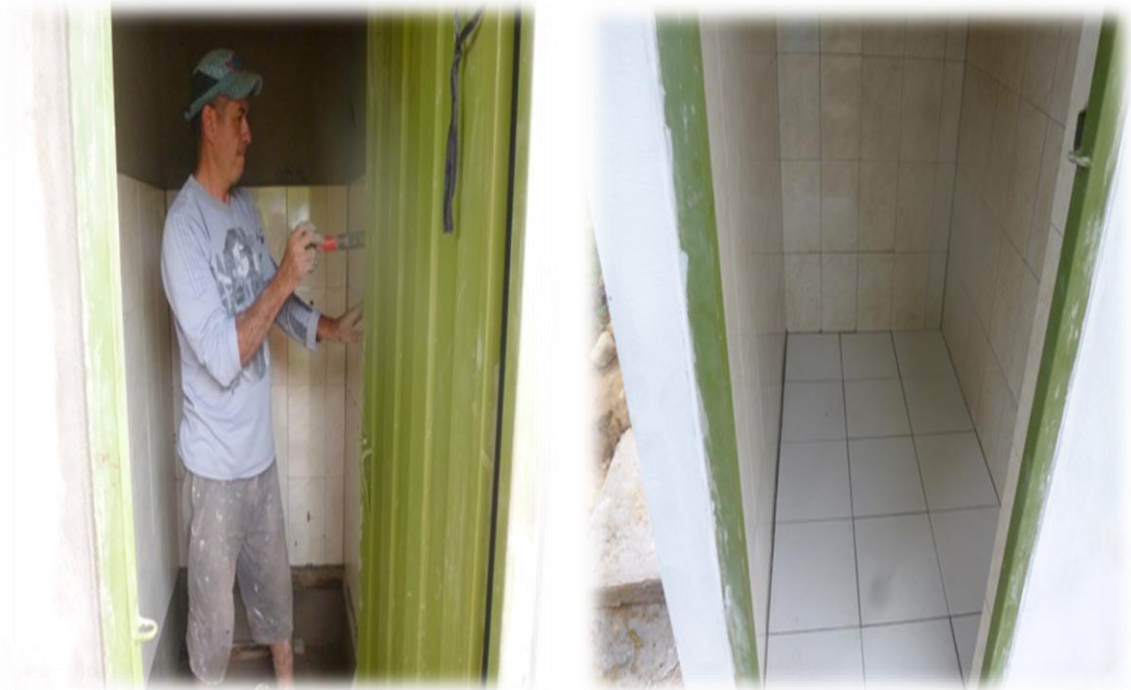
Imagen 16: Enchape de Muros y Pisos
