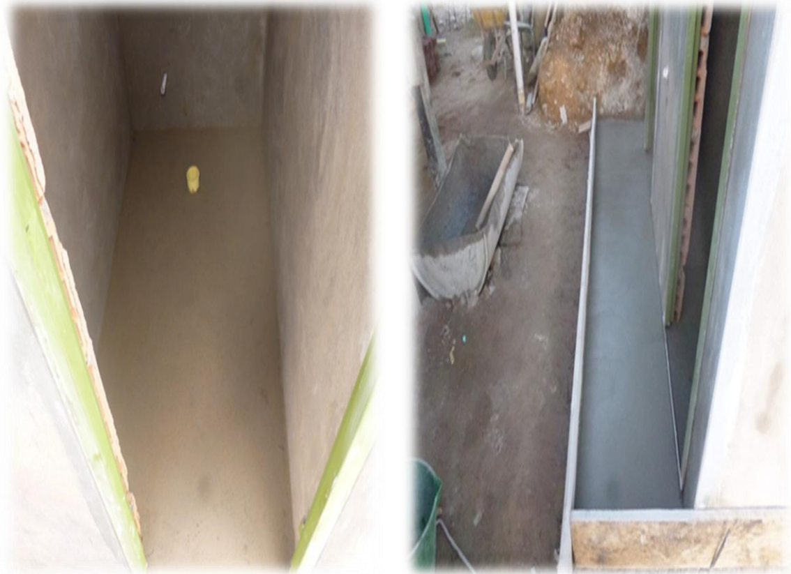
Imagen 15: Piso en concreto e=0.10 mts
