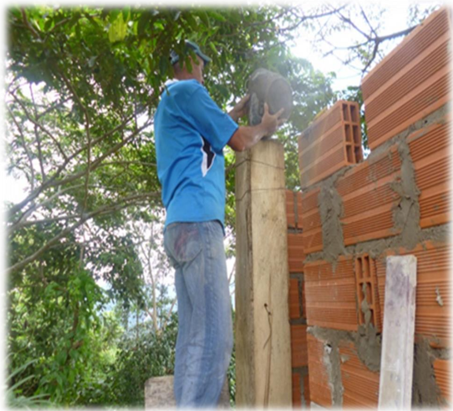
Imagen 10: Fundición de Columnas
