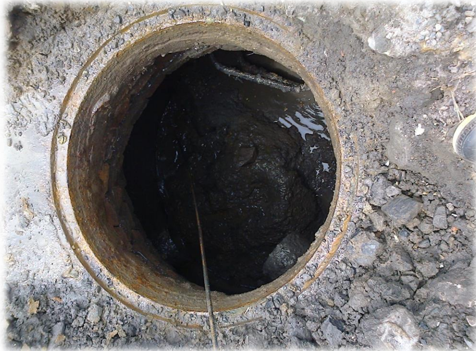
Imagen 39: Mantenimiento y Limpieza de pozos de Inspección
