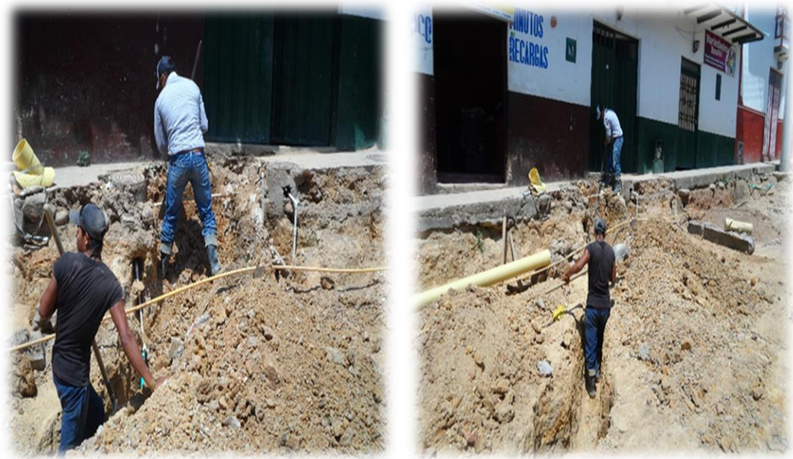
Imagen 22: Excavación de zanja para Acometida Sanitaria
