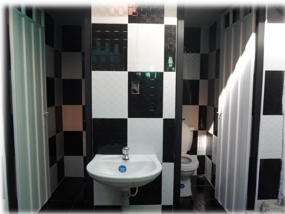
Imagen 36: Unidades Sanitarias Terminada
