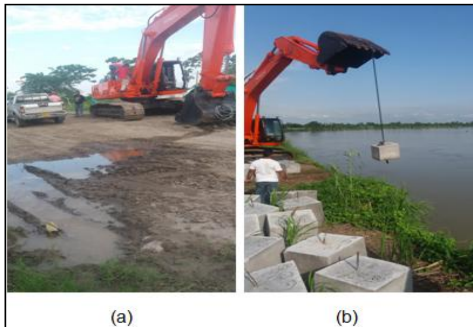
Imagen15: Instalación de hexápodos.
