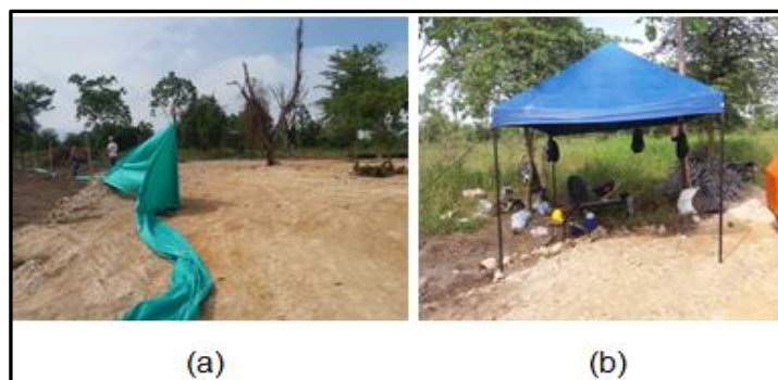
Imagen 7: Cerramiento y adecuación del campamento.
