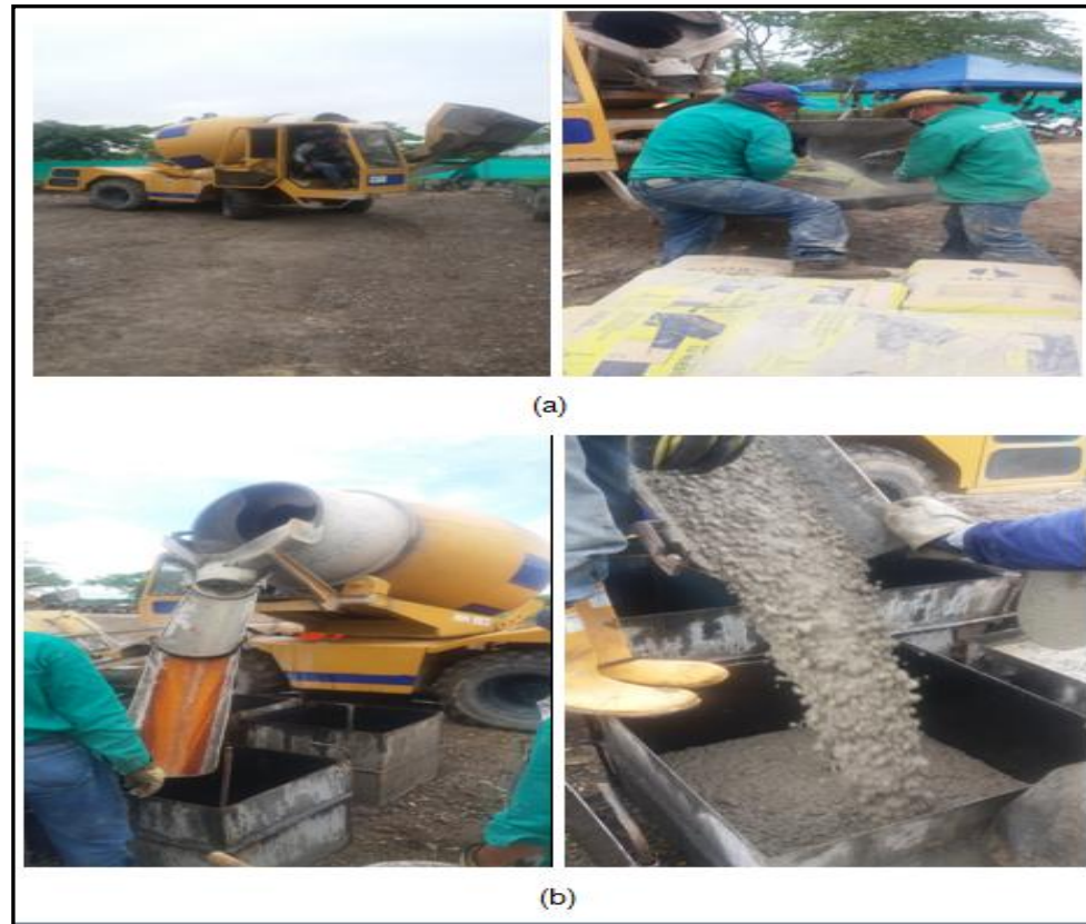
Imagen11: Fundido con auto mezclador.
