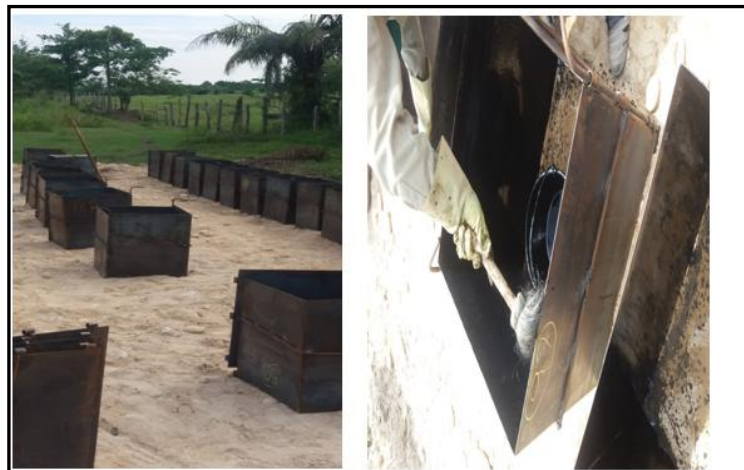
Imagen 9: Armado de formaletas y aceitado.
