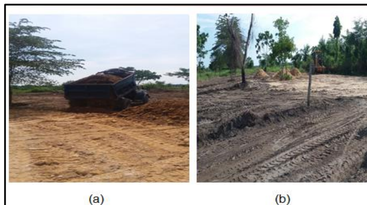
Imagen 5: Replanteo con motoniveladora.
