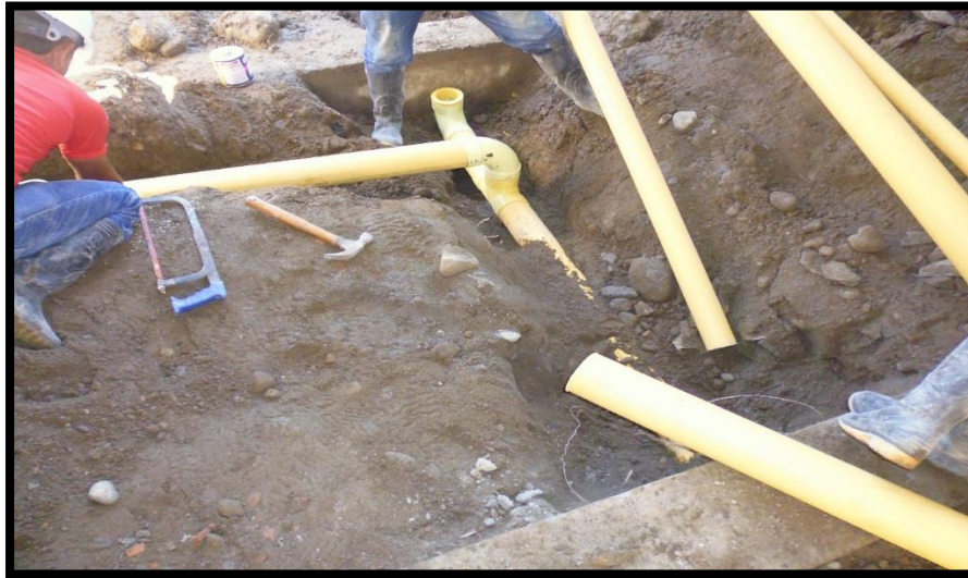
Figura 39. Instalación de tubería 4"
