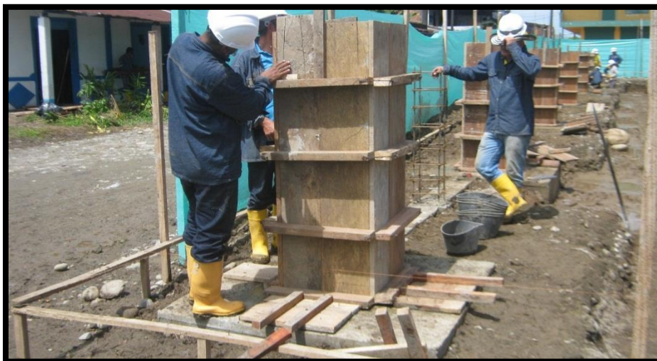
Figura 16. Armazón de formaleta para pedestales principales de medidas 50X50
