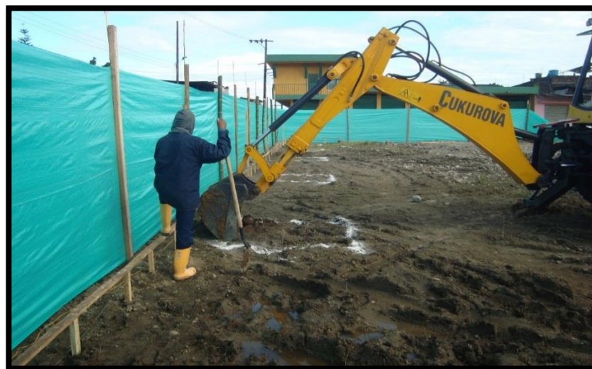
Figura 7. Excavación de las zapatas con ayuda de herramienta mayor
