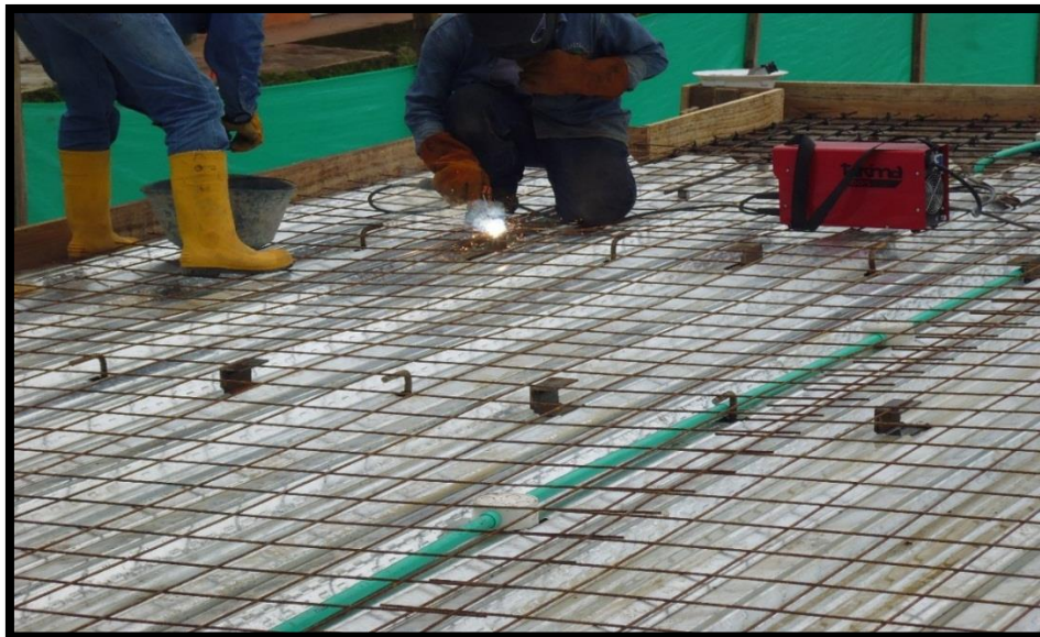
Figura 55. Soldadura de malla electro-soldada
