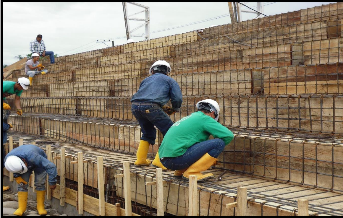
Figura 48. Acero de refuerzo de gradería
