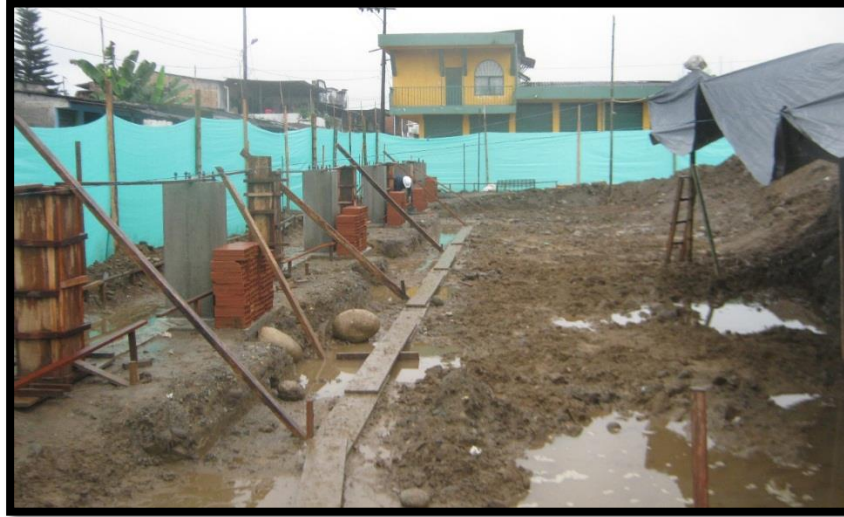
Figura 19. Pedestales fundidos
