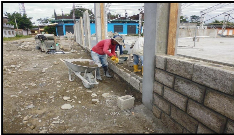
Figura 33. Pega de ladrillo abujardado
