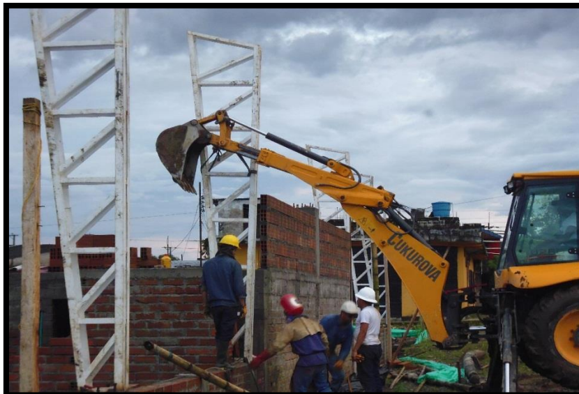
Figura 22. Colocación de pedestales
