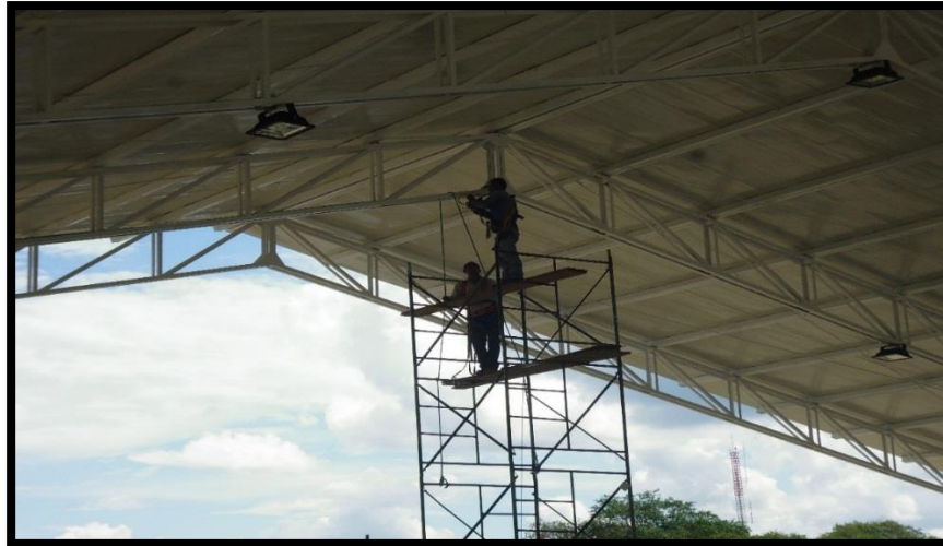
Figura 61. Instalación de lámparas led de 100 y 200 w
