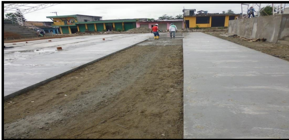
Figura 57. Fundida de la loza para la cancha
