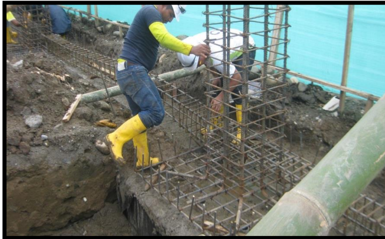
Figura 13. Colocación de acero
