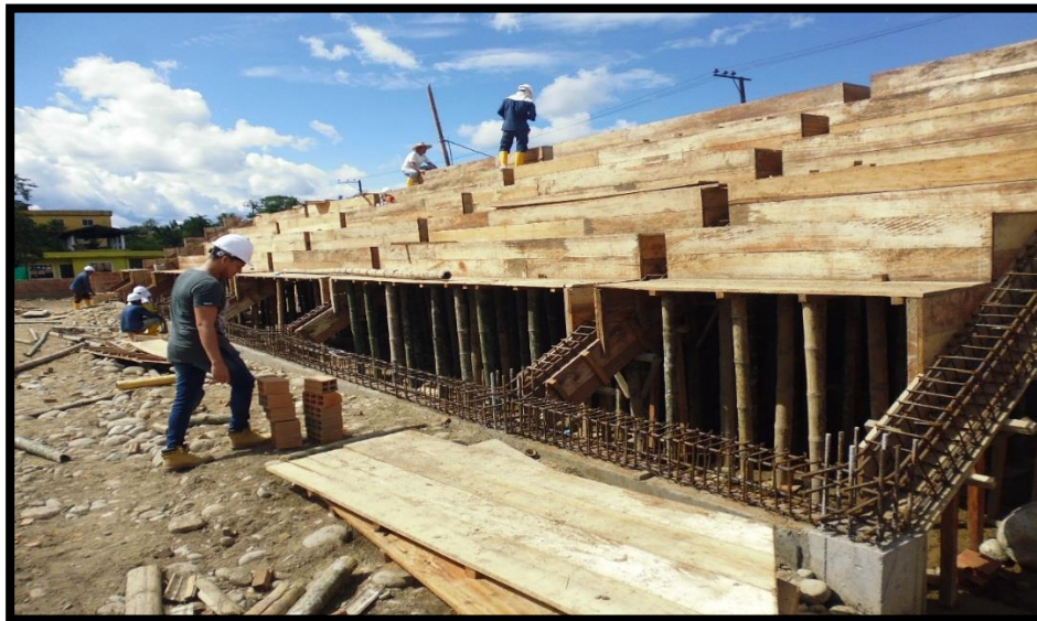
Figura 46. Colocación de formaleta de gradería
