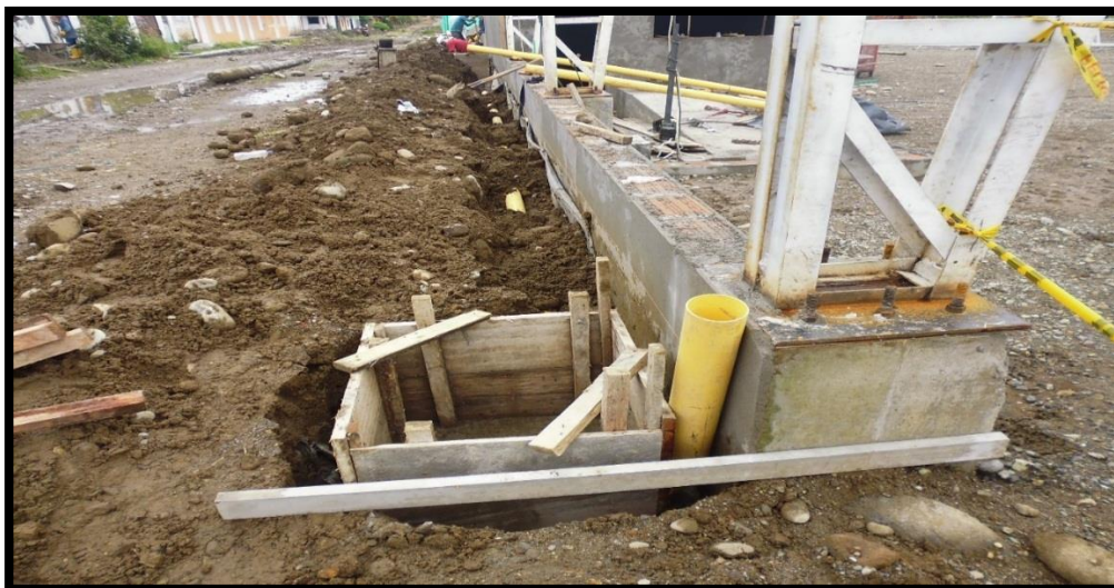
Figura 43. Zanja con tubería de 6”
