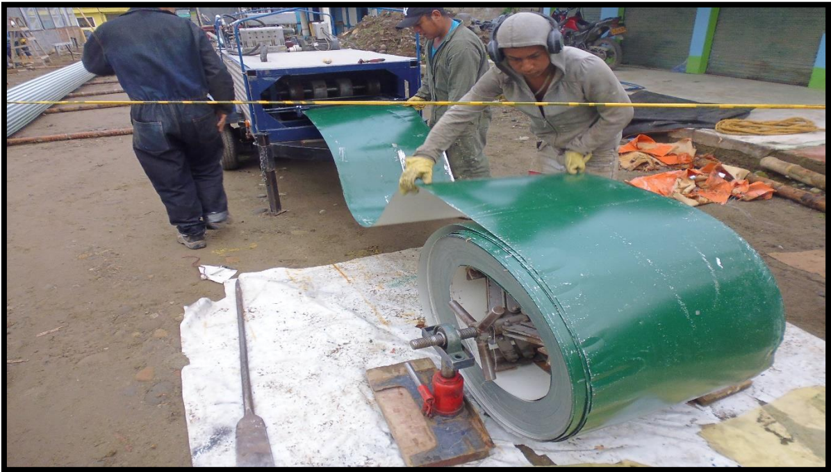
Figura 26. Laminas siendo moldeadas en maquina
