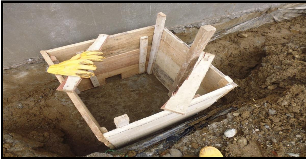
Figura 42. Fabricación de cajillas para aguas lluvias
