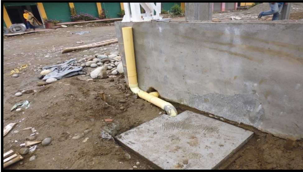
Figura 44. Bajante de aguas lluvias de canal
