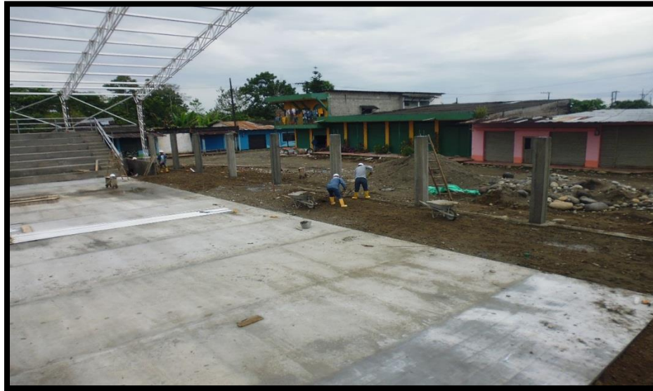
Figura 58. Cancha fundida por secciones
