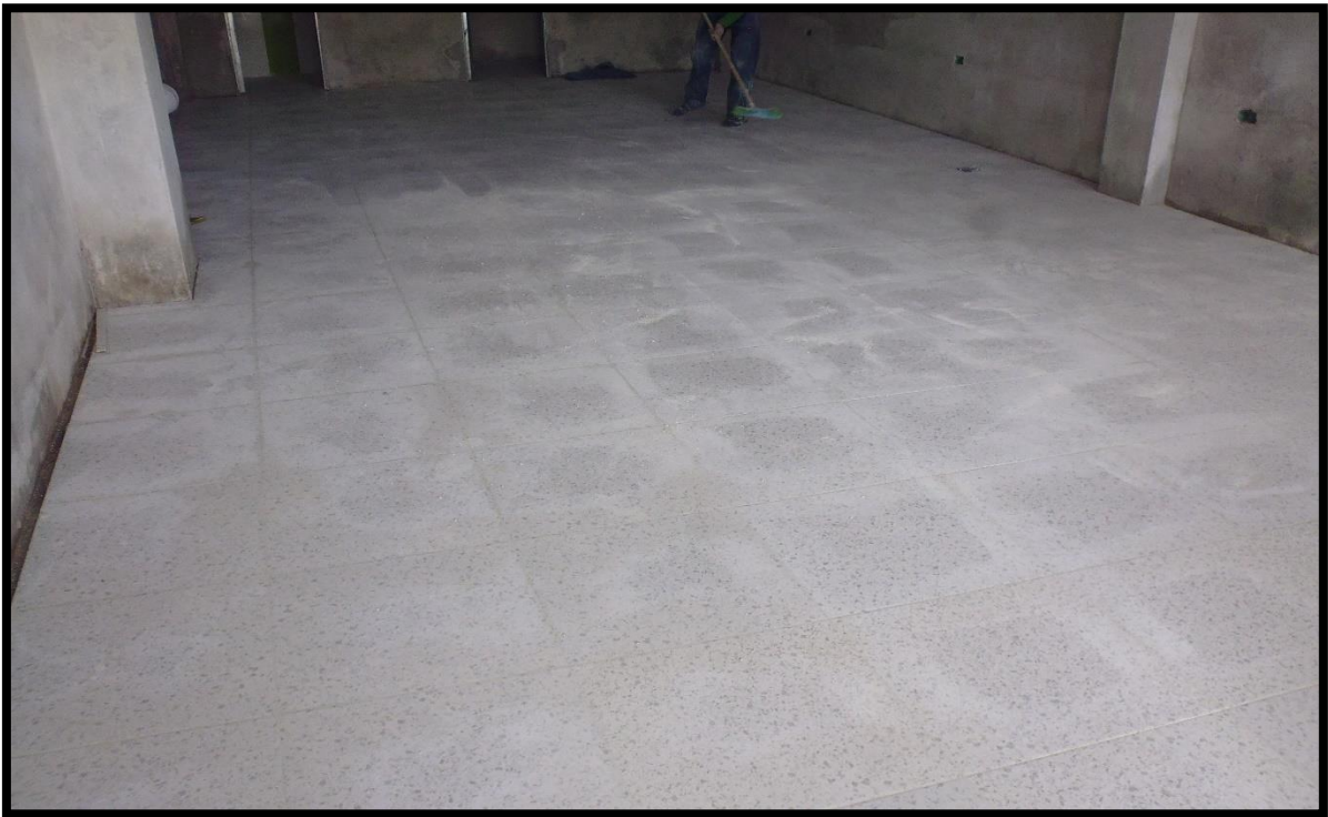
Figura 63. Enchape de pisos de oficinas
