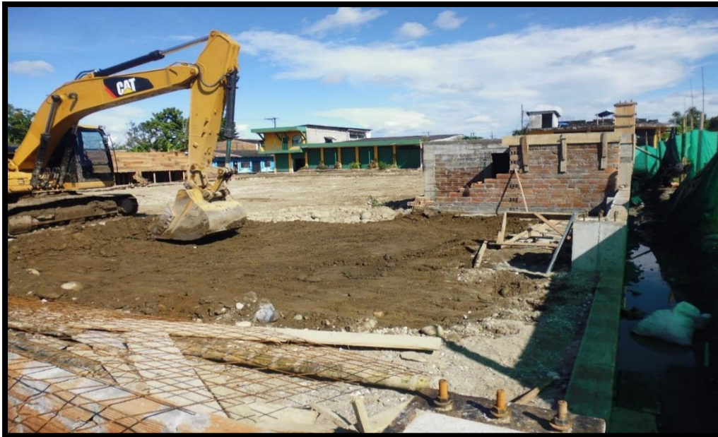
Figura 10. Capas de material de relleno
