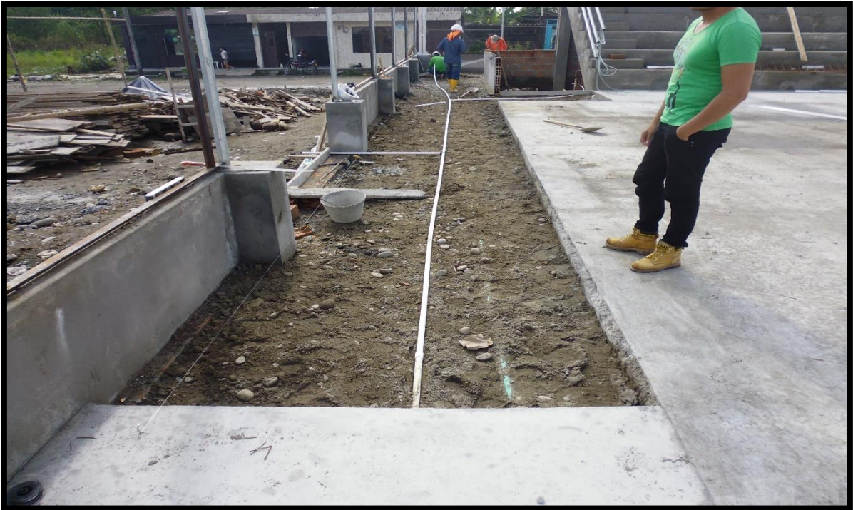
Figura 37. Verificación de la instalación de tubería de ½”
