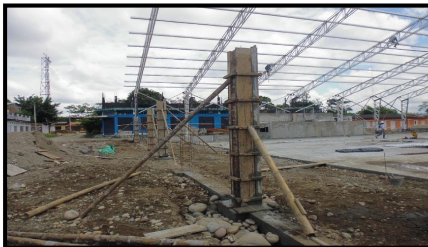
Figura 24. Correas metálicas de cubierta
