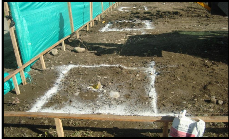
Figura 6. Marcación con cal para excavación de las zapatas
