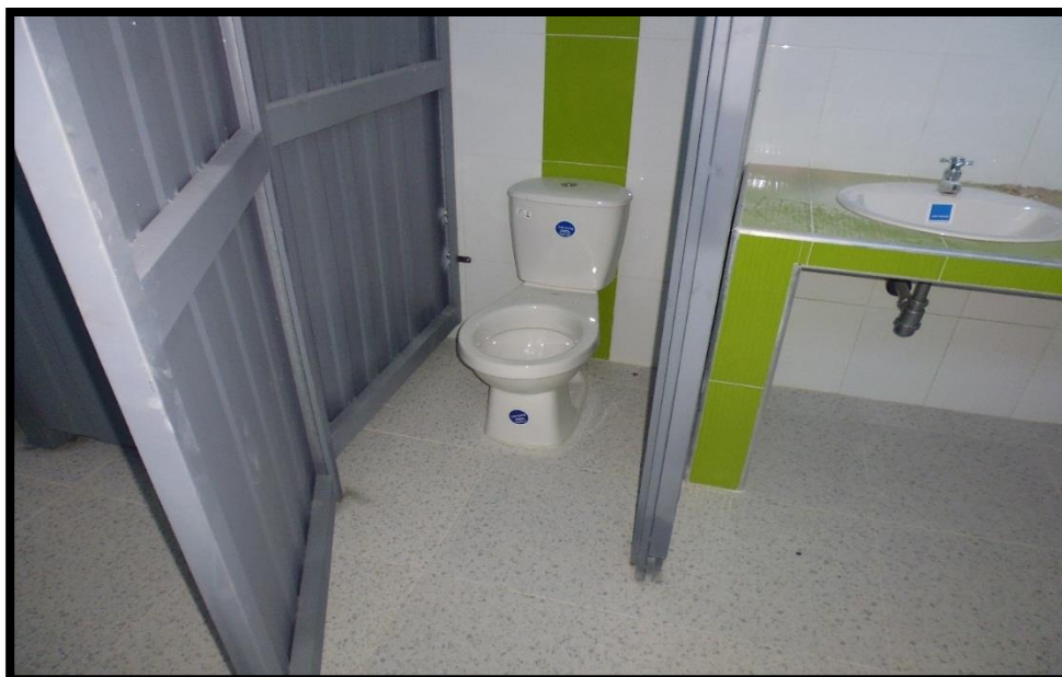
Figura 65. Baños de camerinos
