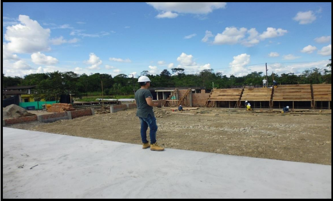
Figura 47. Supervisión de la formaleta de gradería
