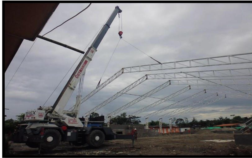
Figura 23. Grúa P&H en la colocación de cerchas.
