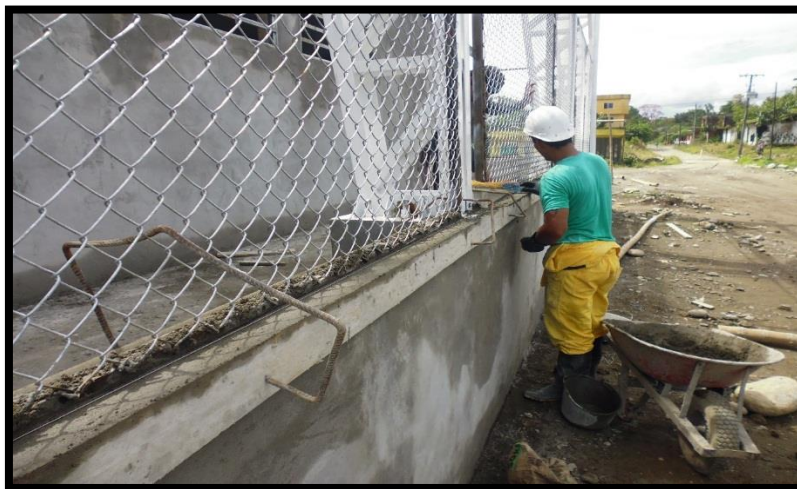
Figura 67. Filos de muro de cerramiento
