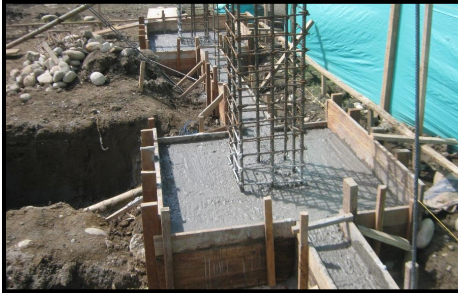
Figura 15. Cimentación fundida
