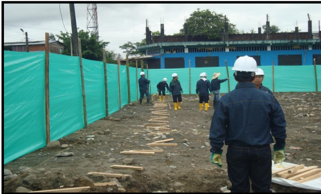
Figura 4. Tomas de nivel para armazón de puentes
