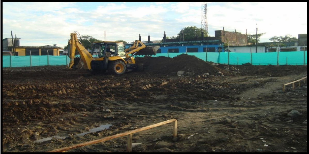
Figura 3. Material de excavación
