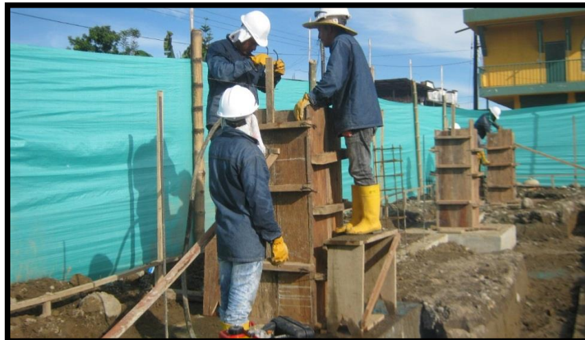
Figura 18. Verificación de niveles de los pedestales
