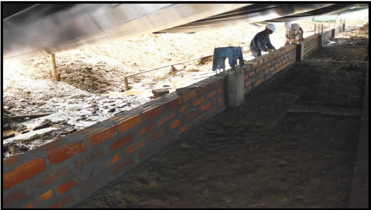
Figura 31. Ladrillo en tizón en la parte baja se la gradería
