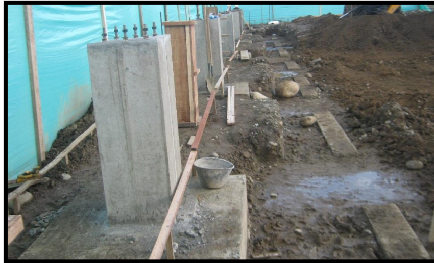
Figura 17. Colocación de formaleta para pedestales de 30X30
