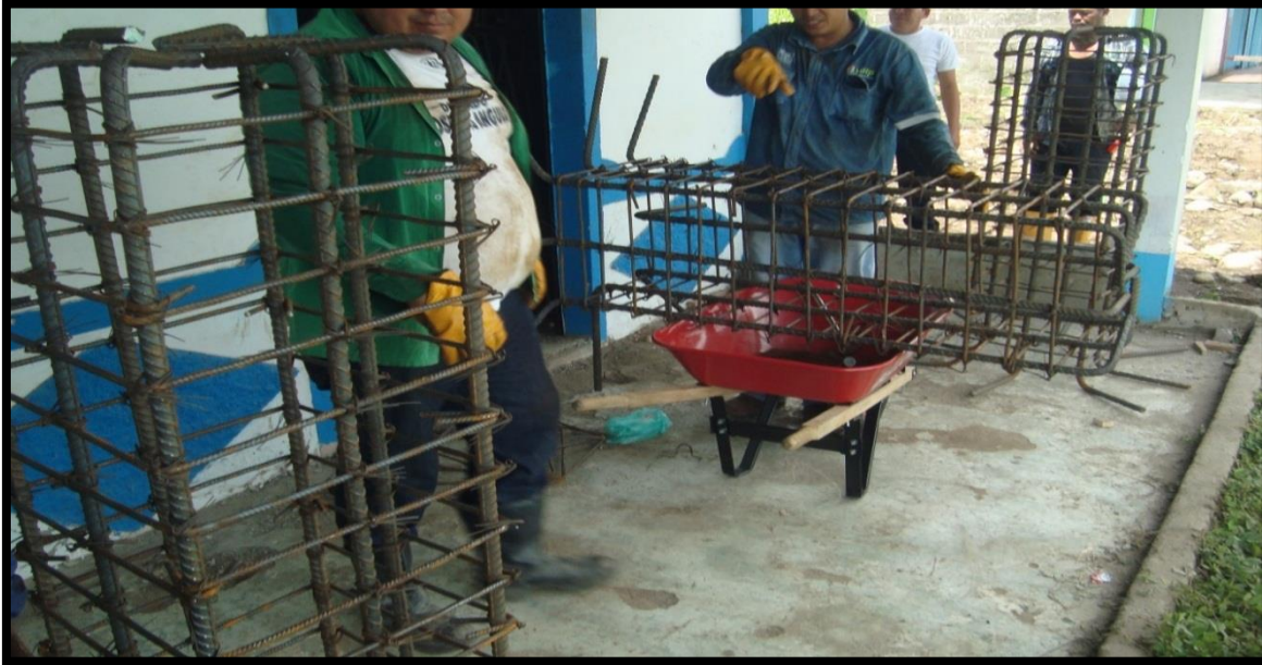
Figura 11. Acero amarrado para los pedestales de la cubierta.
