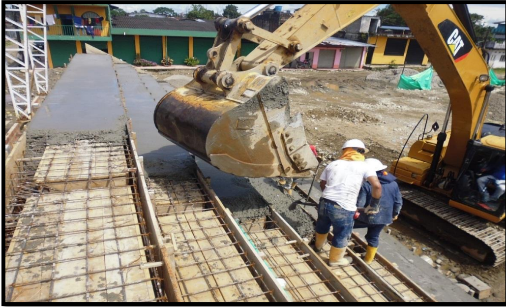
Figura 49. Concreto 3000 psi reforzado para gradería
