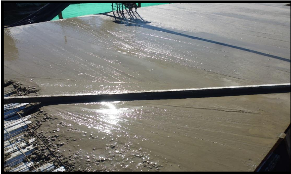
Figura 56. Colocación de concreto en tarima
