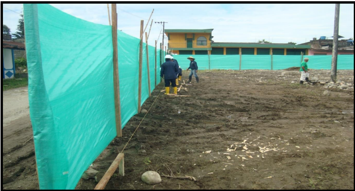
Figura 2 Cerramiento en poli sombra del perímetro del terreno
