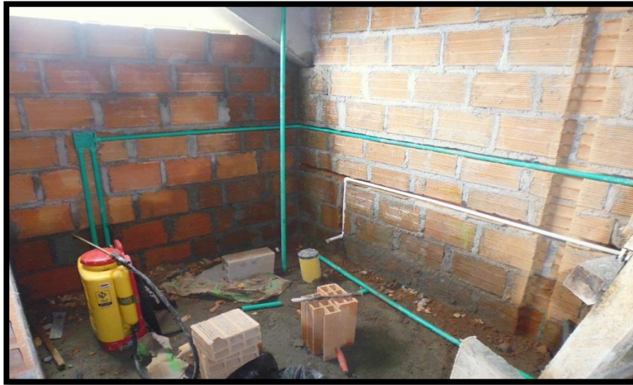
Figura 60. Regata para tubería de la red eléctrica.
