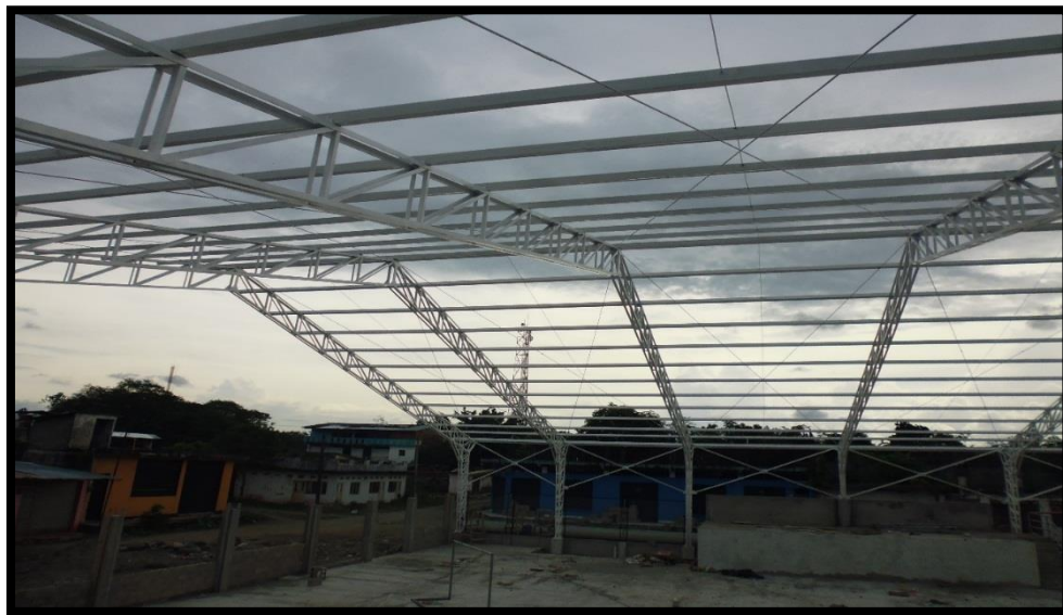
Figura 25. Tensores y rigidizadores
