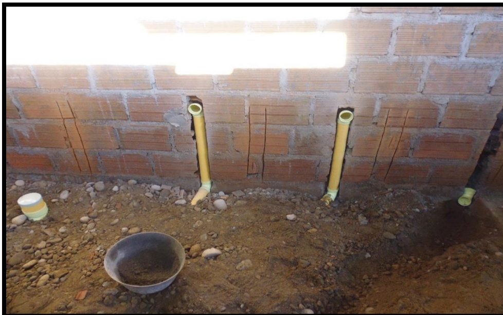
Figura 40. Regata para la ubicación de tubería de 3"
