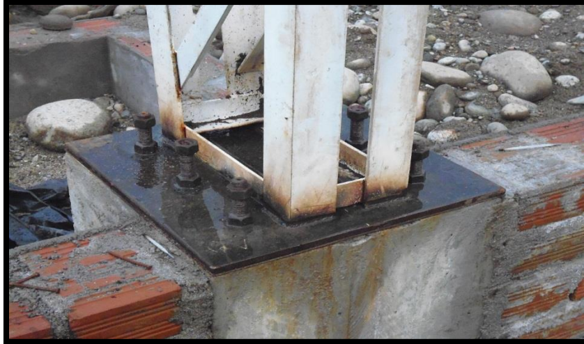
Figura 21. Soldadura de pedestal
