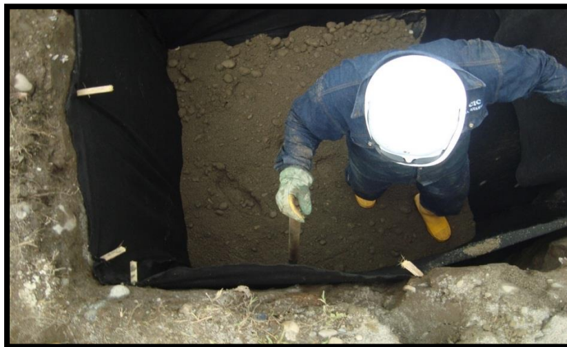
Figura 9. Mejoramiento de zapatas en recebo y geotextil
