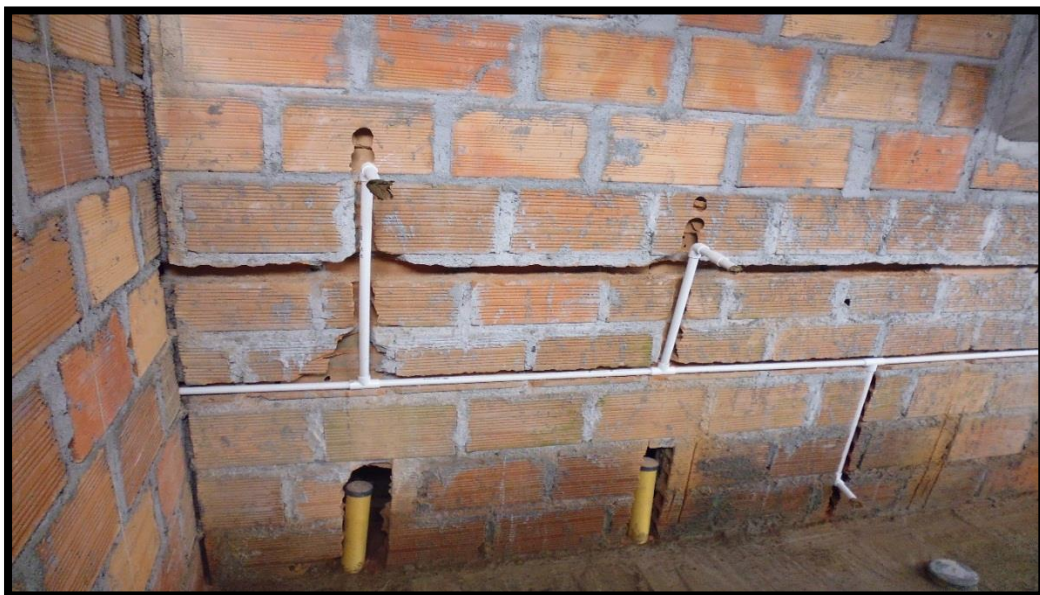
Figura 36. Puntos hidráulicos Tubería de 1/2"
