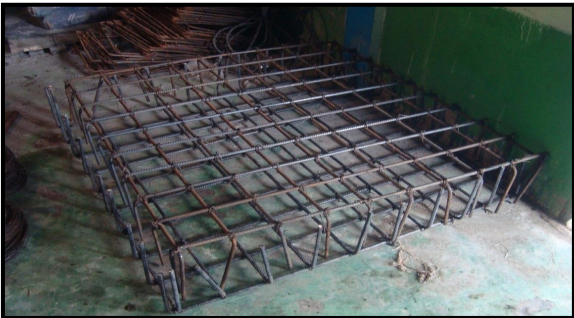
Figura 12. Malla en acero para zapatas
