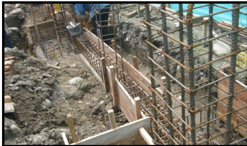
Figura 14. Formaleta de cimentación
