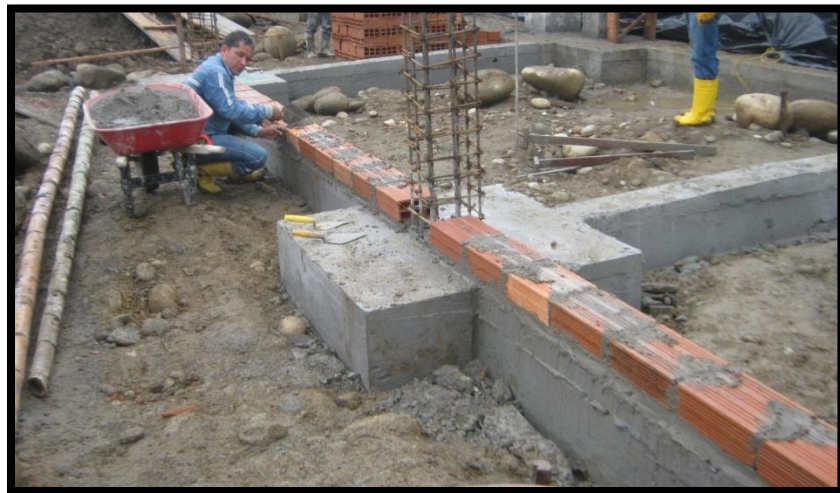
Figura 28. Pega de ladrillo en forma tizón
