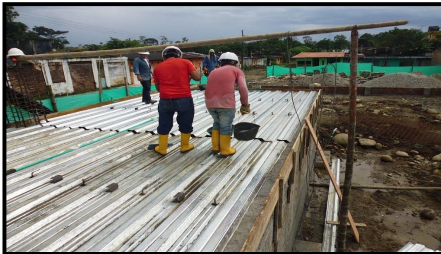
Figura 53. Ubicación de lámina metaldeck
