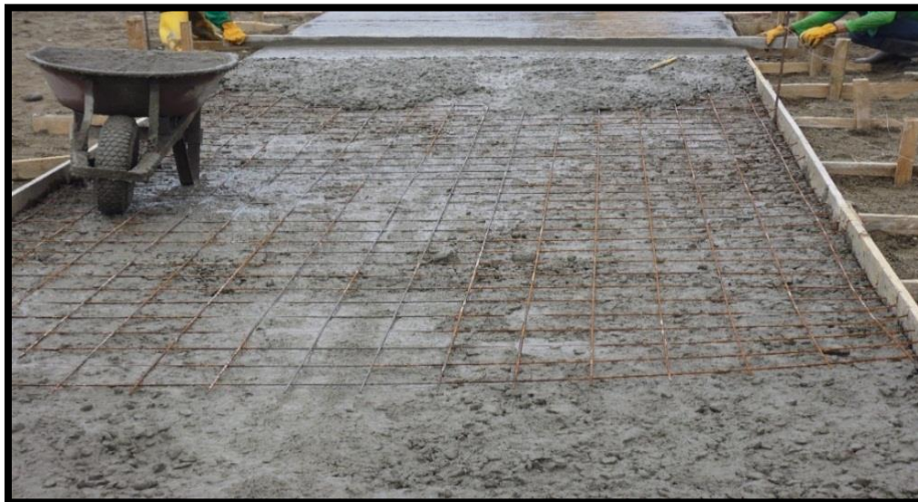
Figura 59. Malla electro-soldada en losas de cancha
