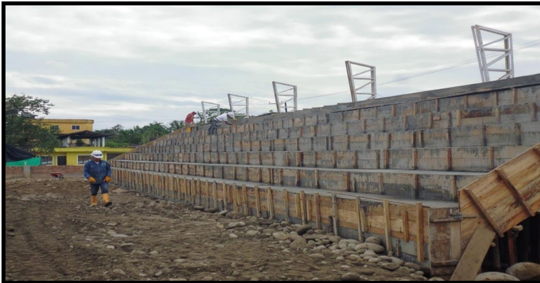
Figura 50. Gradería ya fundida con concreto
