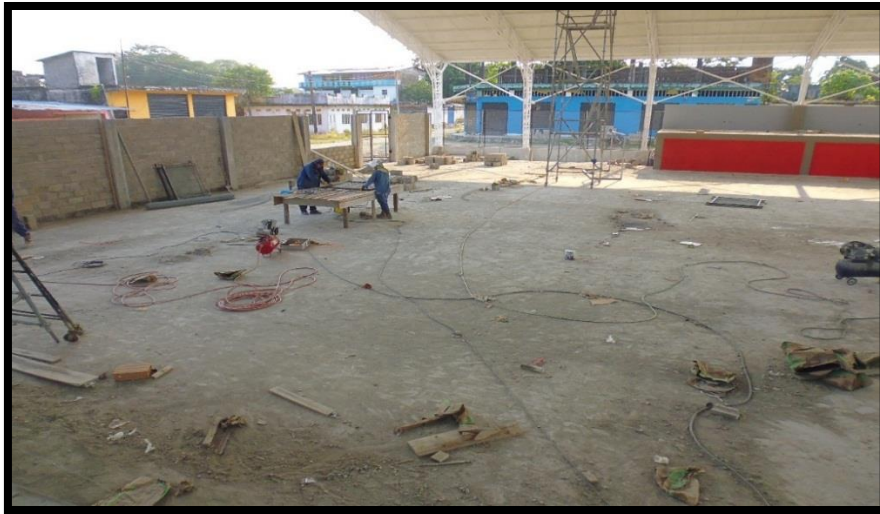
Figura 66. Fabricación de portones en tubo galvanizado
