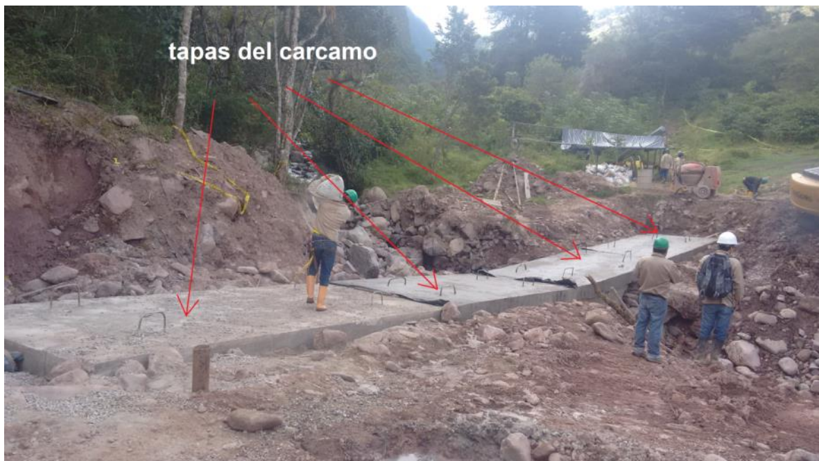
Figura 56. Fundido de todas las tapas del cárcamo.
