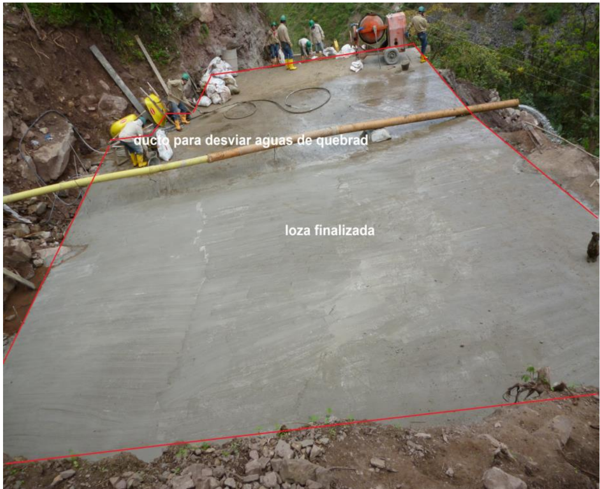
Figura 48. Fundido de loza finalizado.
