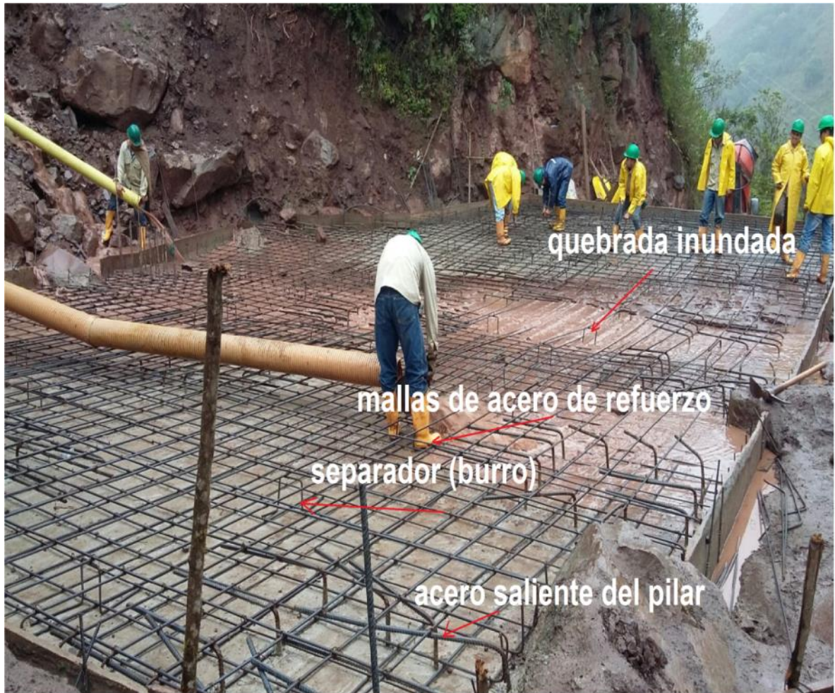
Figura 46. Armado de mallas con acero de refuerzo con presencia de lluvias e inundación de la quebrada.
