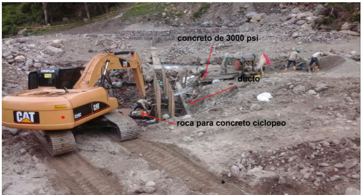
Figura 64. Fundido de tramo N°3 de la pantalla.
