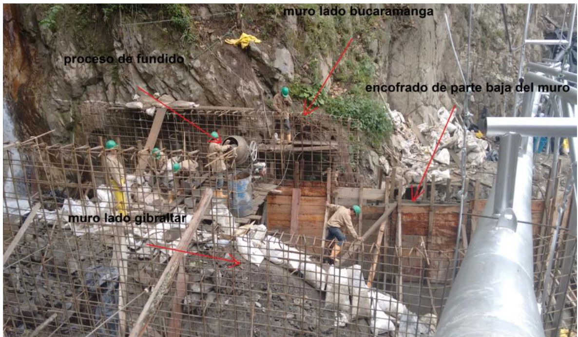
Figura 83. Proceso de fundido de muro lado Bucaramanga.
