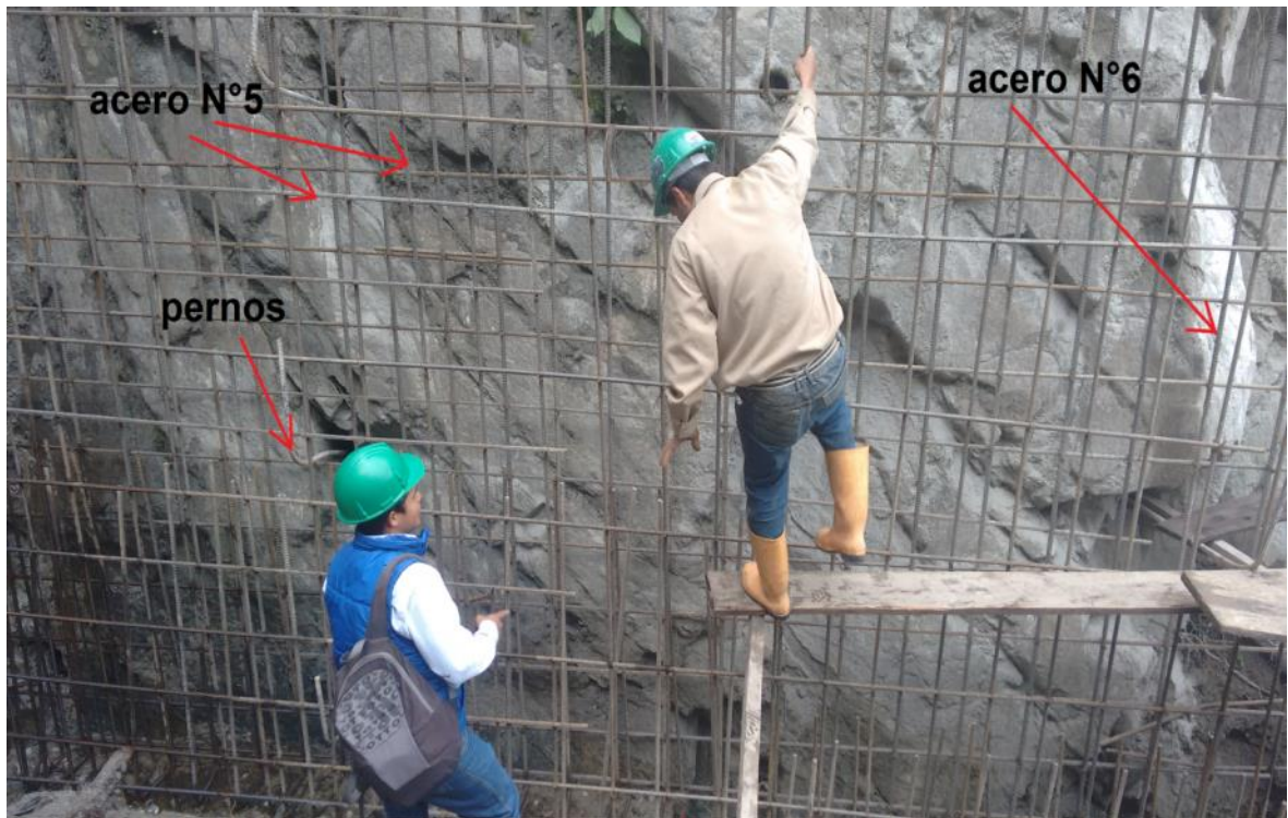
Figura 82. Armado de acero y amarrado de pernos al muro.
