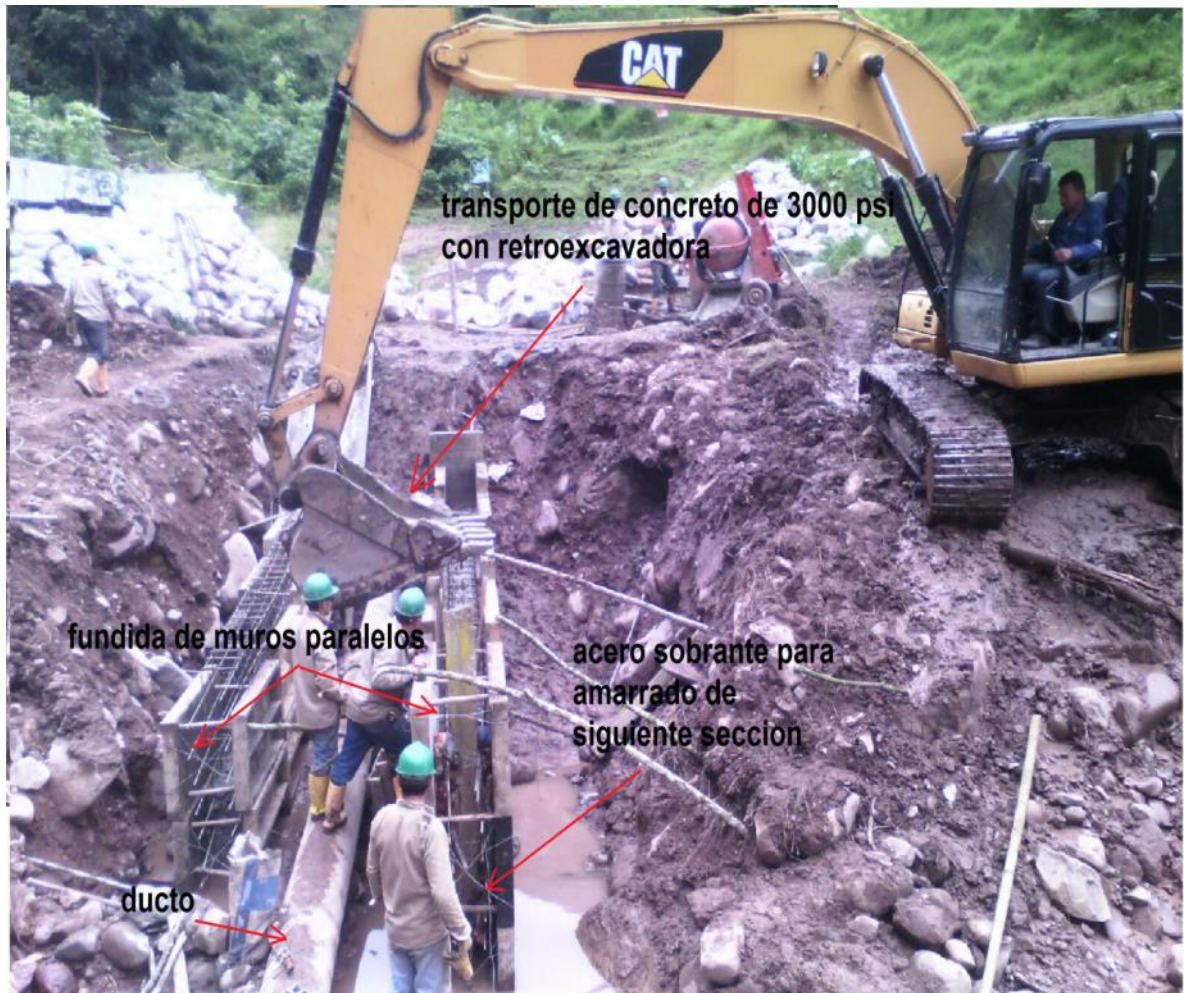
Figura 52. Fundida de muros de cárcamo de forma paralela.
