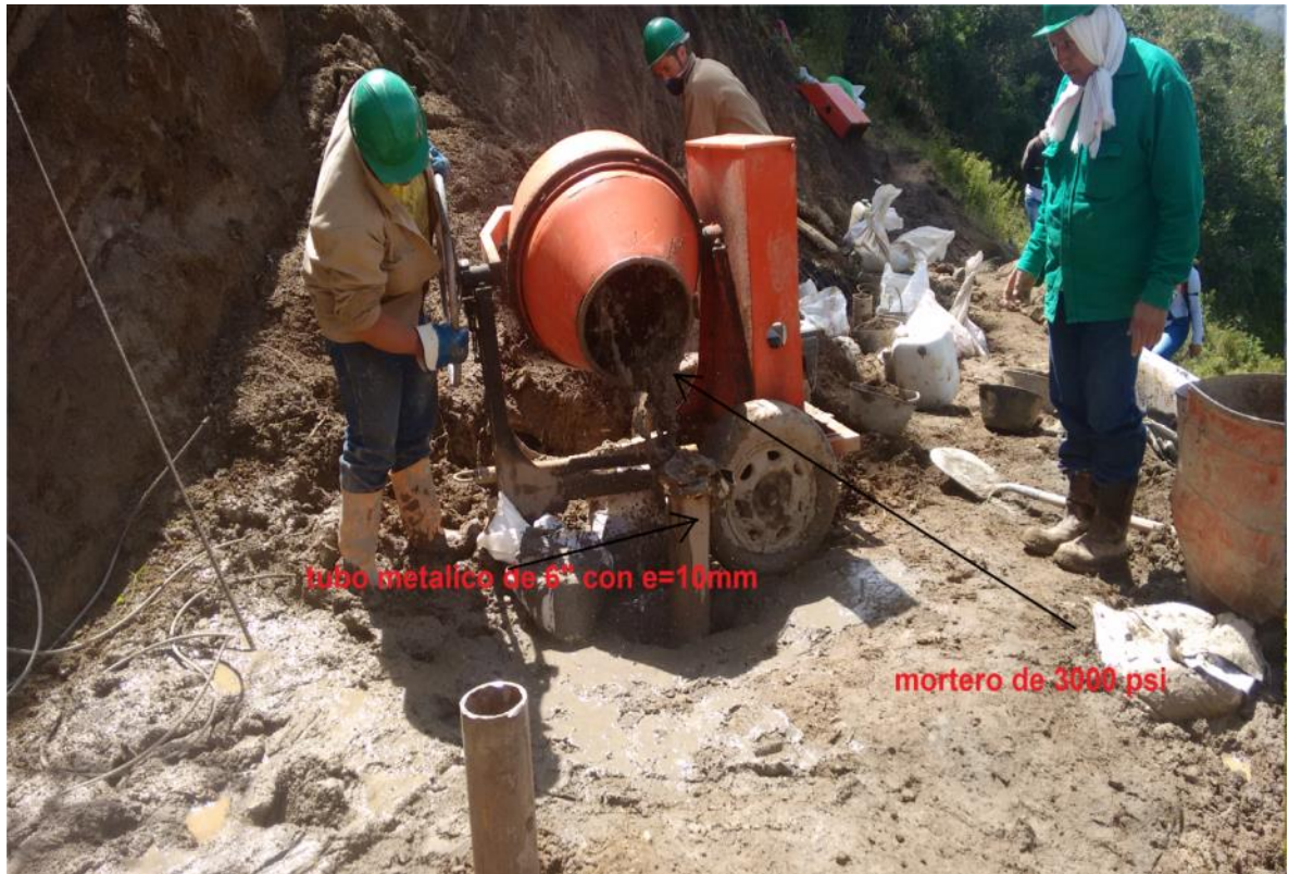
Figura 72. Fundido de micropilote metálico.
