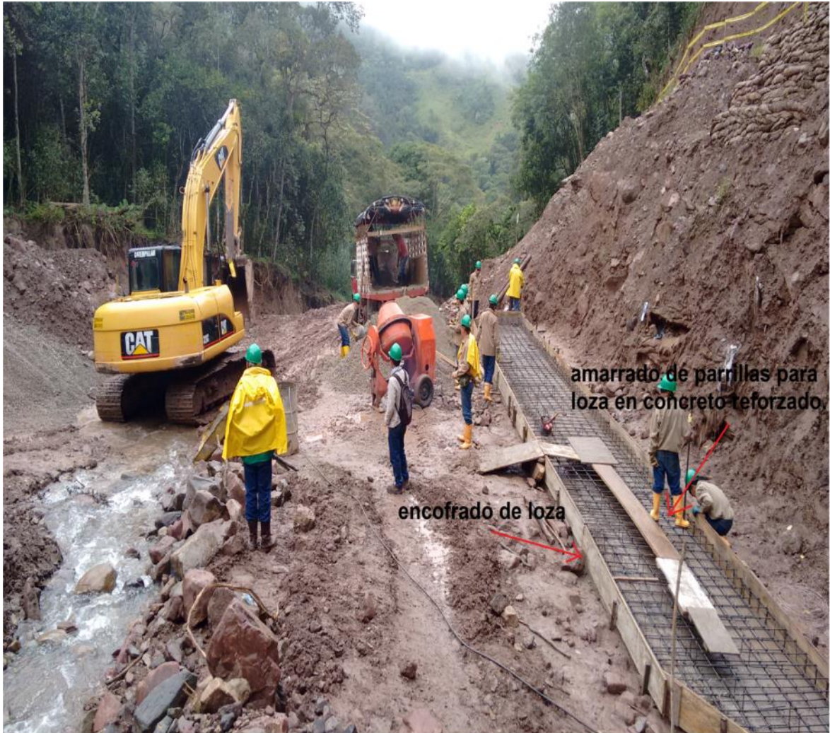
Figura 21. Parrillas armadas y encofrado de la loza.
