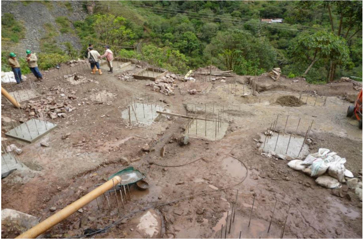
Figura 43. Pilares fundidos.
