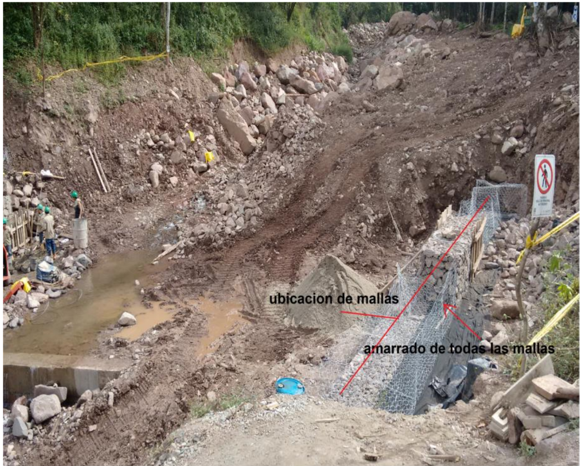
Figura 23. Ubicado de mallas y amarrado de estas.
