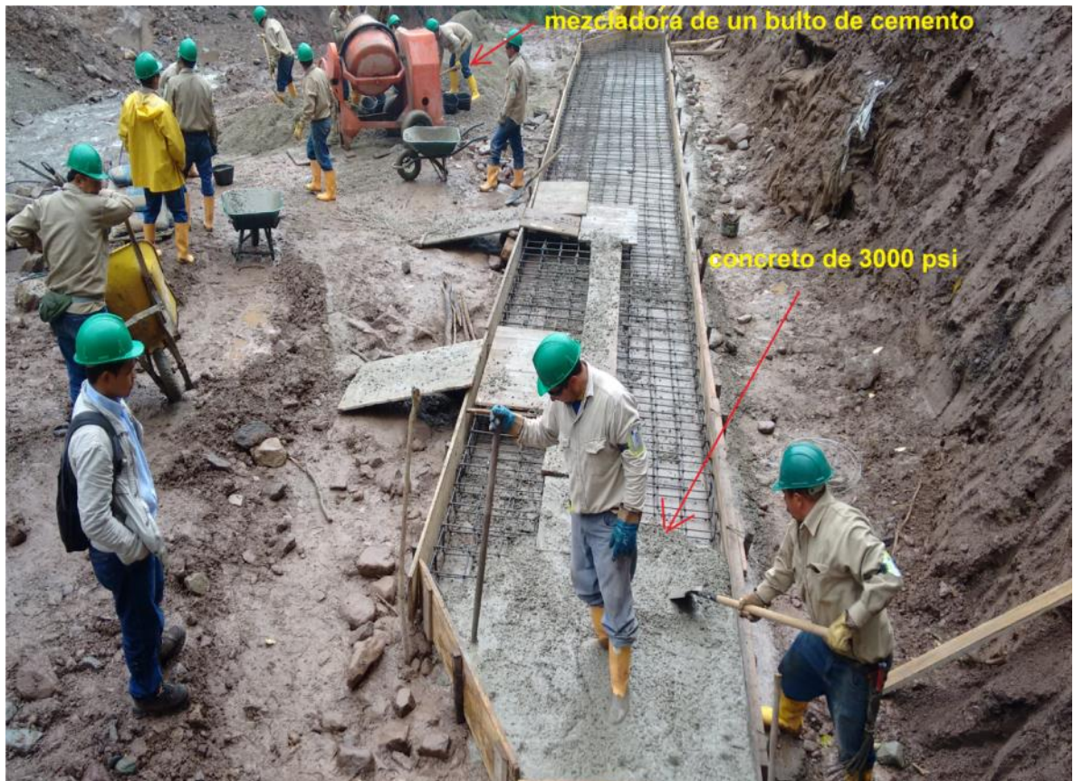
Figura 22. Fundido de loza reforzada.
