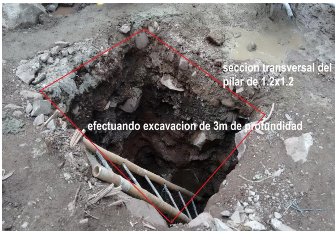
Figura 41. Excavación manual para pilares.
