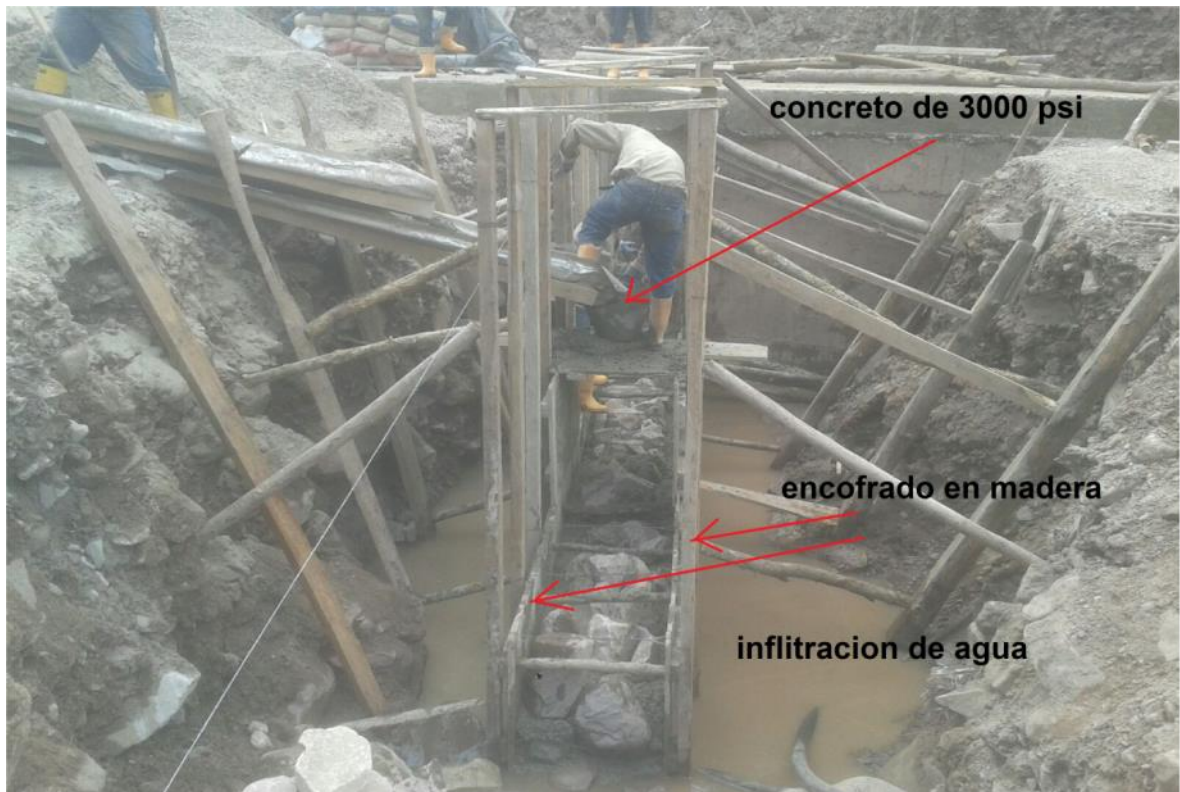
Figura 28. Fundido de tramo 1 de pantalla en concreto ciclópeo.
