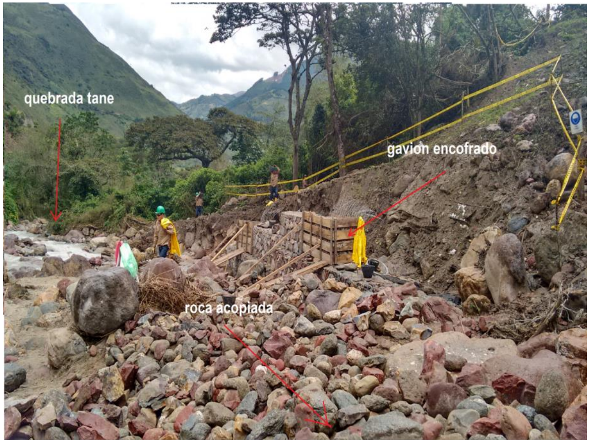
Figura 59. Gavión encofrado.
