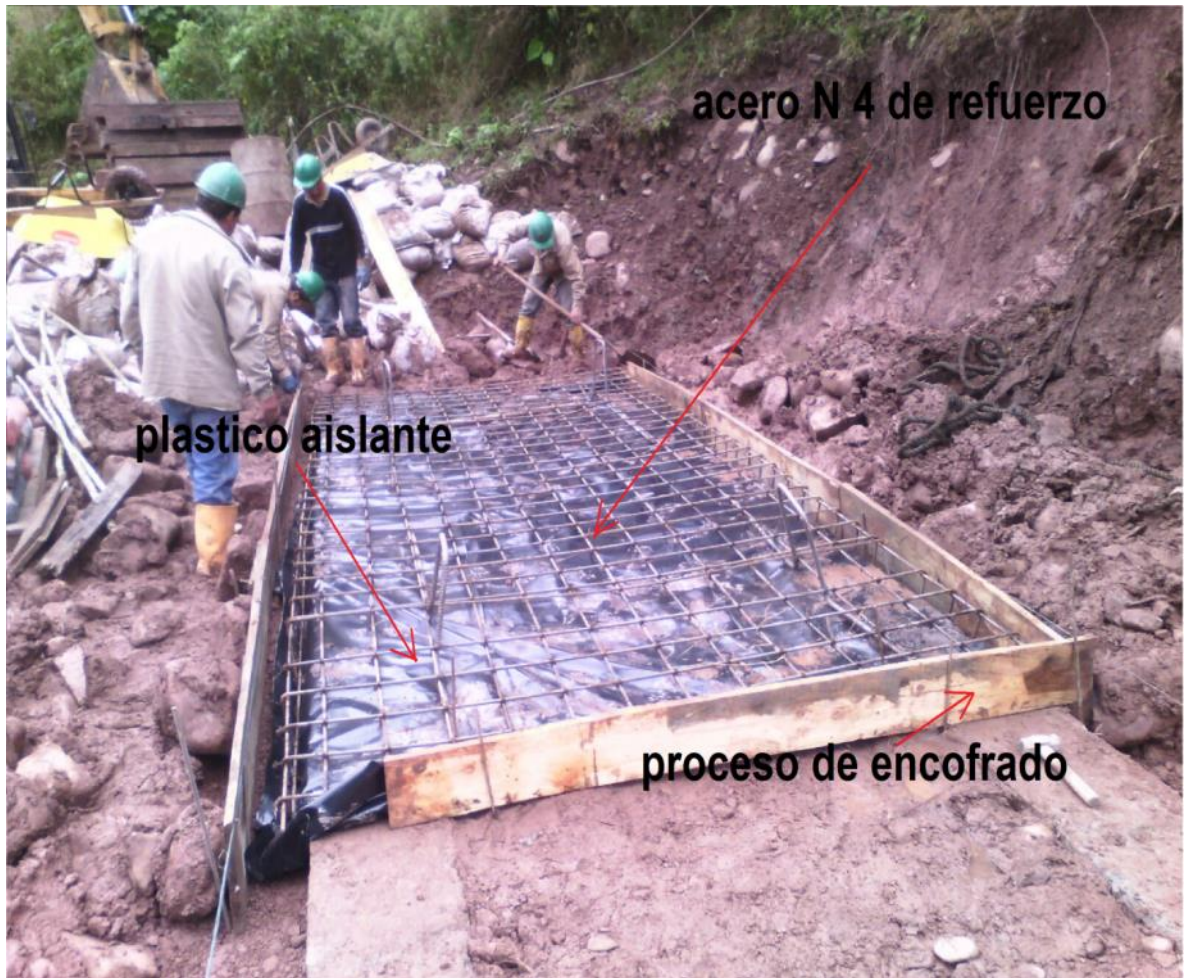
Figura 54. Encofrado de tapa de cárcamo.
