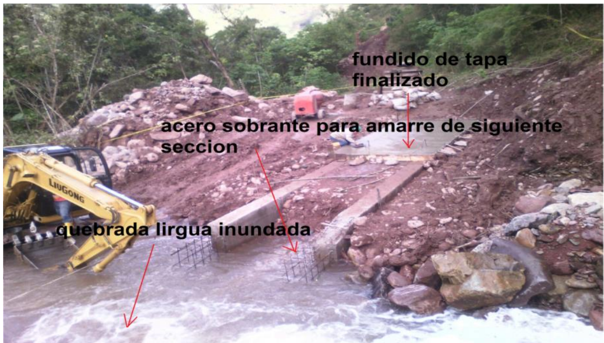
Figura 55. Finalizado de fundida de tapa.
