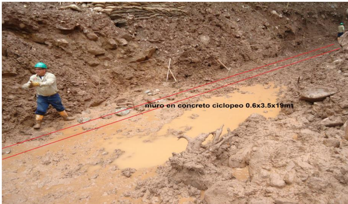
Figura 16. Localización de muro en concreto ciclópeo lado Gibraltar.
