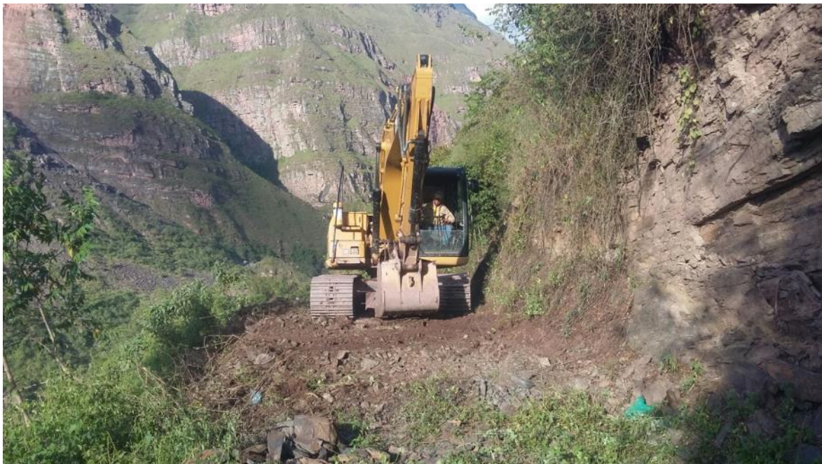
Figura 49. Apertura de vía de acceso a obra con retroexcavadora 320d.
