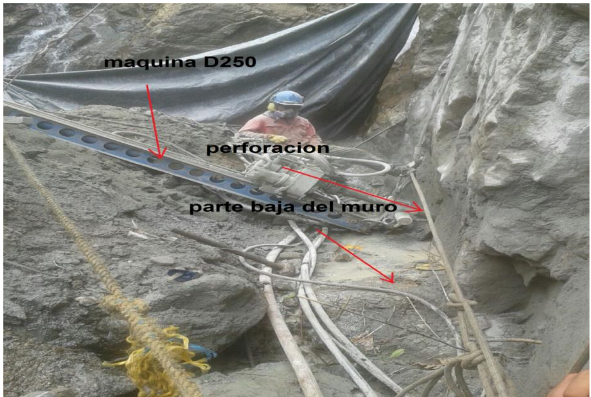
Figura 80. Inicio de perforaciones para pernos.
