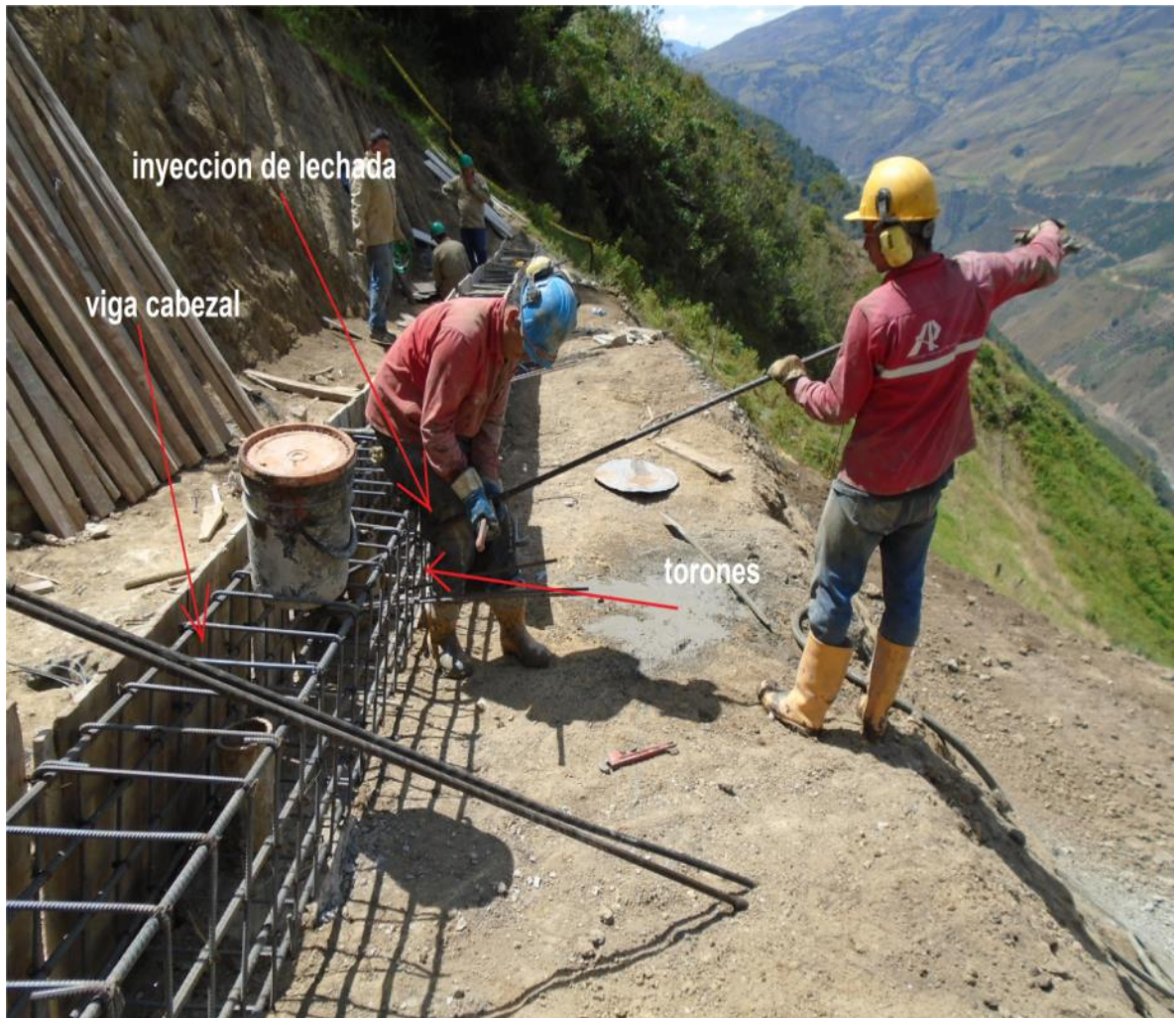
Figura 74. Instalación de torones e inyección de lechada.
