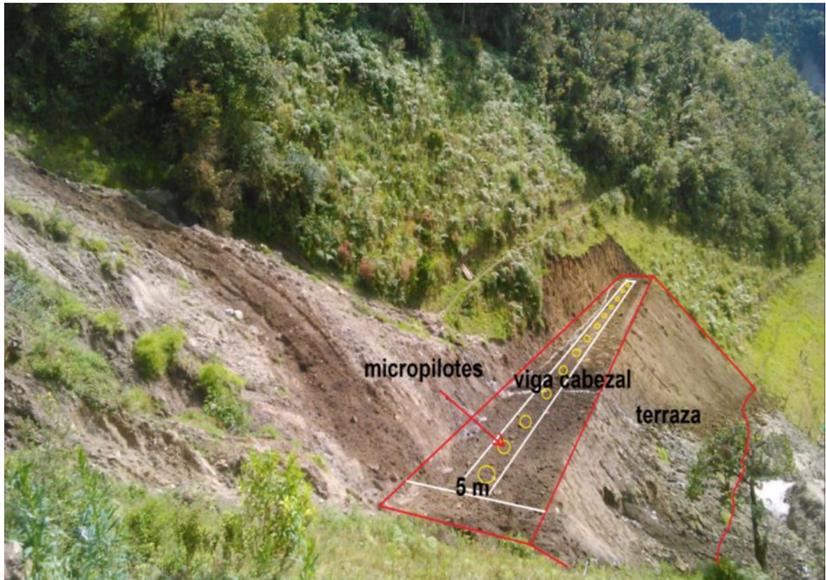
Figura 70. Ubicación de micropilotes metálicos.
