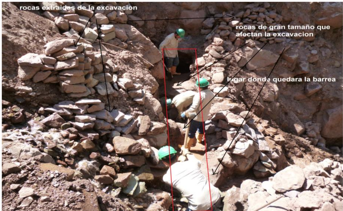
Figura 37. Excavación manual para barreras transversales al cauce.
