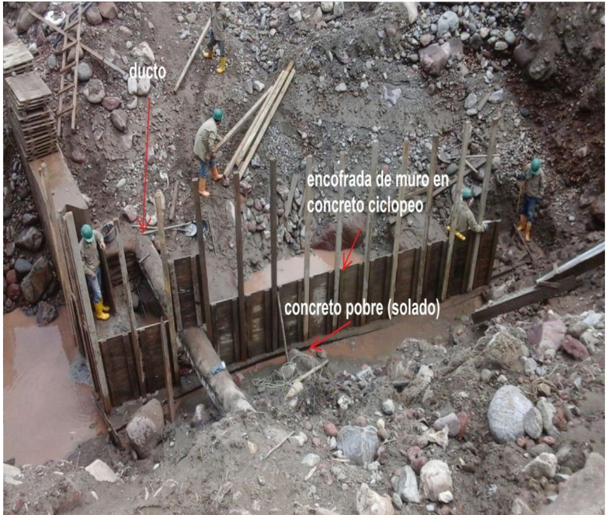
Figura 66. Encofrado de parte baja del muro en concreto ciclópeo.
