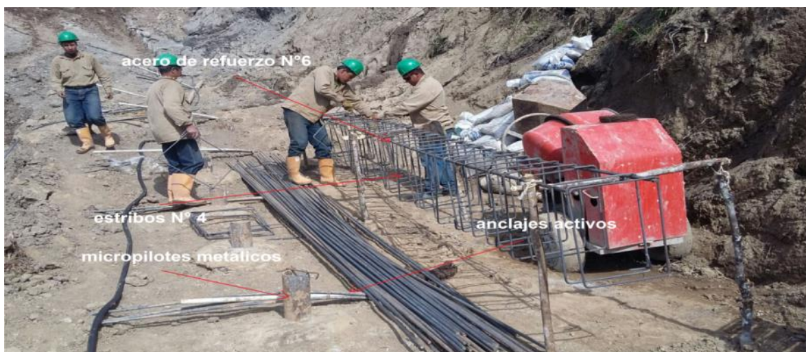
Figura 76. Armado de acero de refuerzo de viga cabezal.
