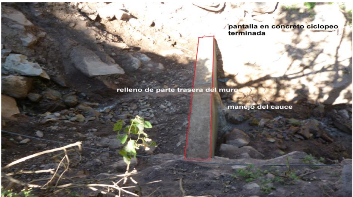
Figura 40. Pantalla finalizada y relleno de su parte trasera efectuado.
