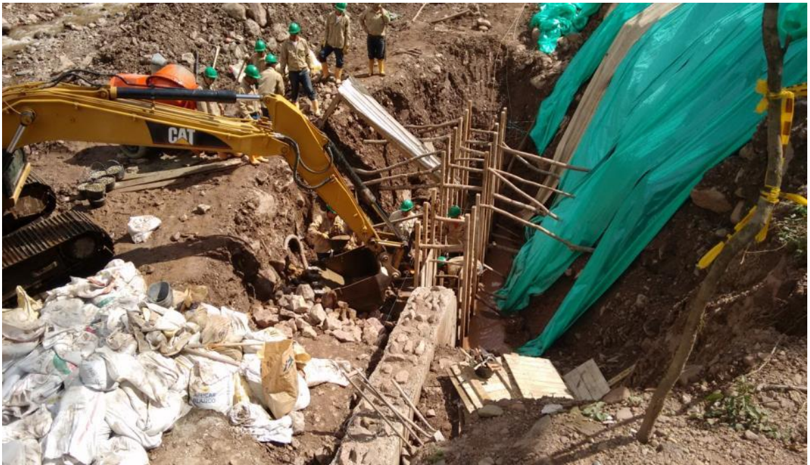
Figura 19. Encofrado y fundido de muro en concreto ciclópeo.
