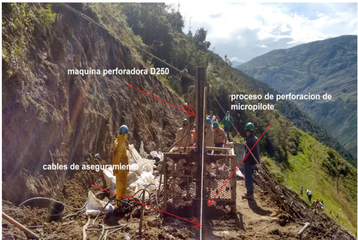
Figura 71. Perforación con maquina D250.
