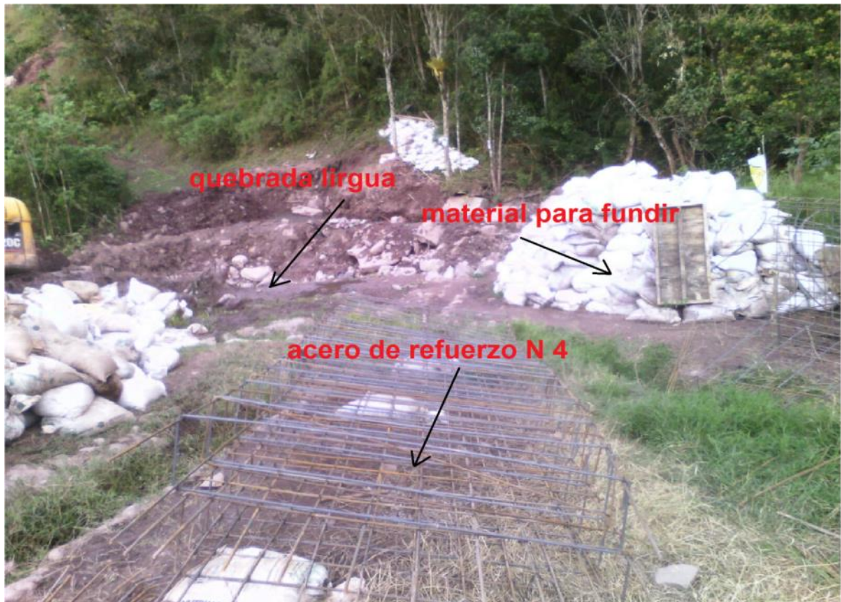
Figura 51. Armado de acero fuera del sitio de fundida.
