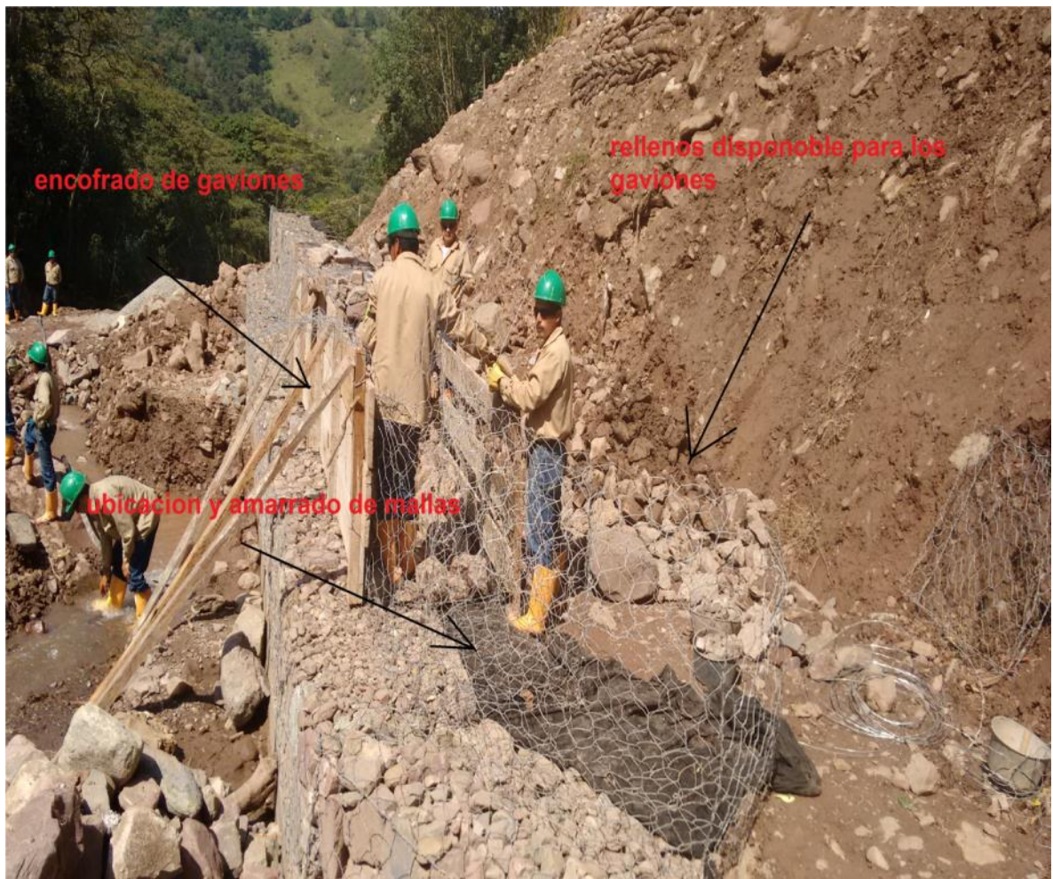
Figura 24. Encofrado y relleno manual del gavión.
