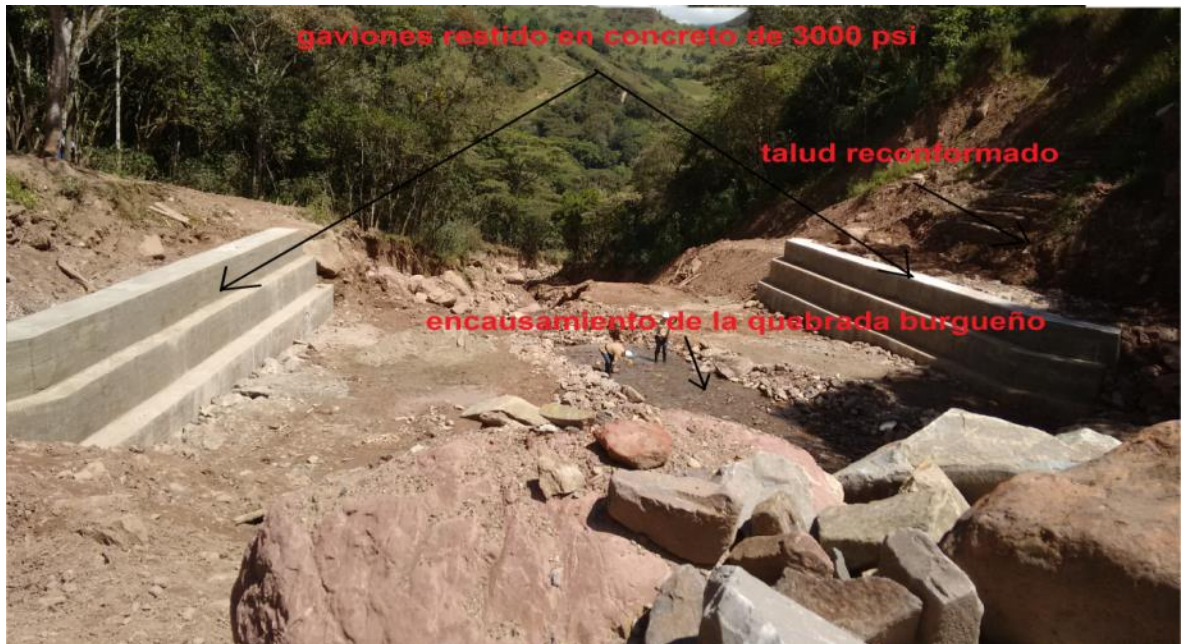
Figura 30. Obra terminada vista frontal aguas arriba.
