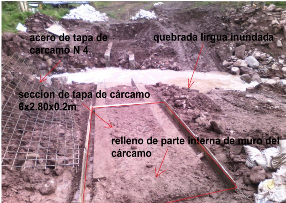
Figura 53. Relleno del interior y acero de tapa del cárcamo.
