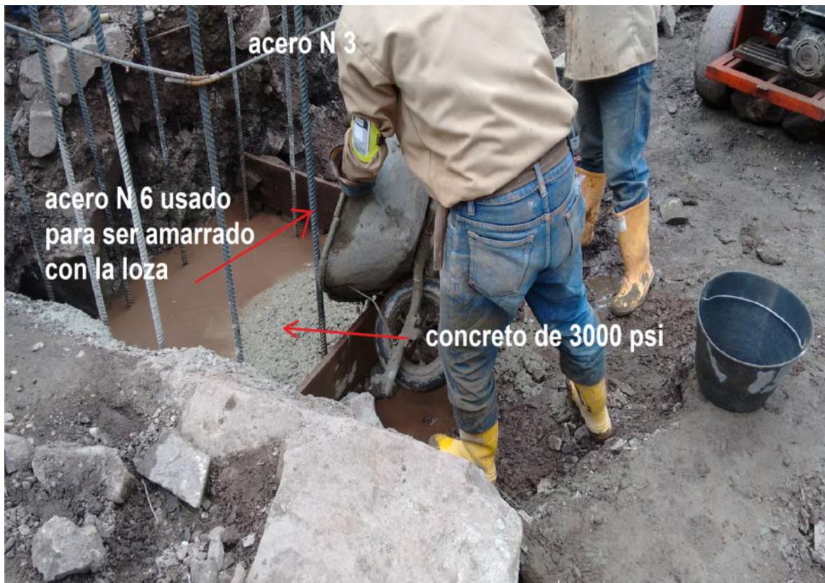
Figura 42. Fundido de pilar.
