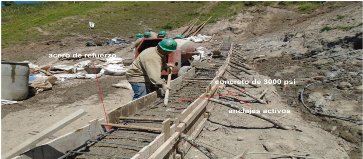
Figura 77. Fundido de viga cabezal.
