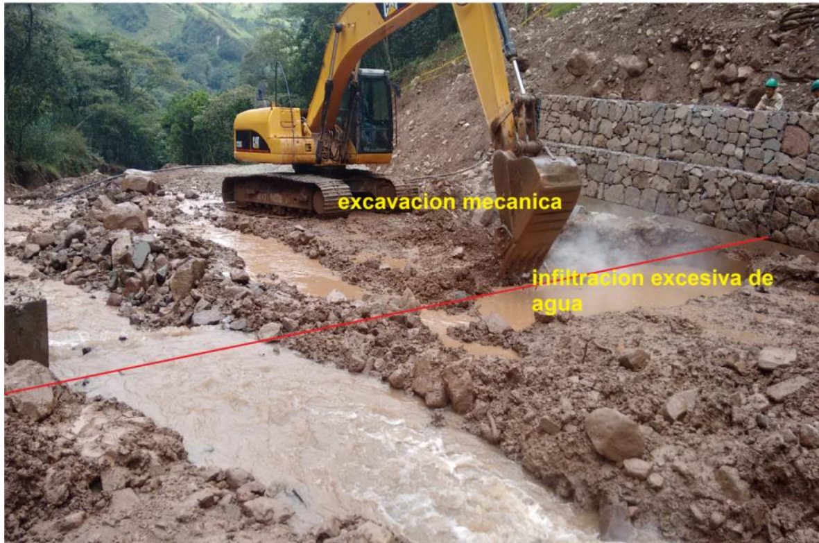
Figura 27. Excavación mecánica con presencia de agua.
