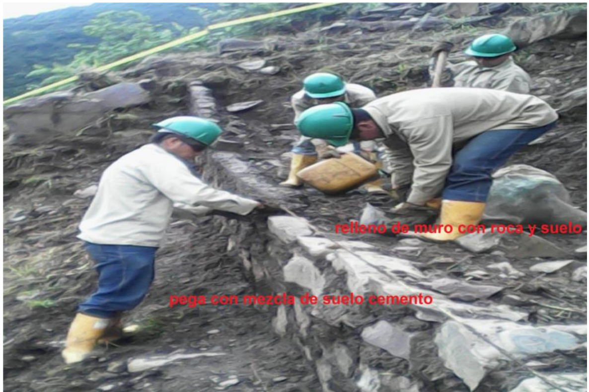
Figura 35. Pegado de roca y relleno de muro.
