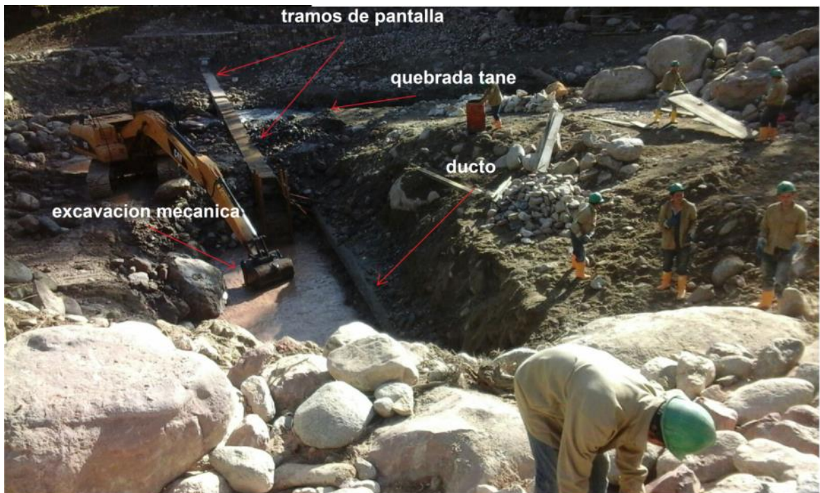
Figura 62. Excavación de tramo para pantalla de fijación.
