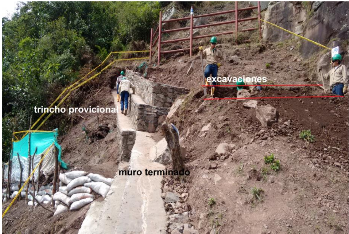
Figura 34. Excavación manual para muro.
