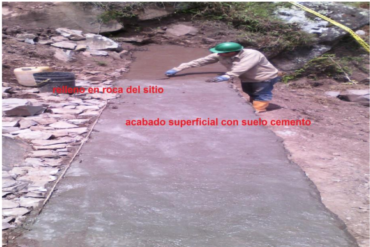
Figura 36. Acabado superficial de muro.
