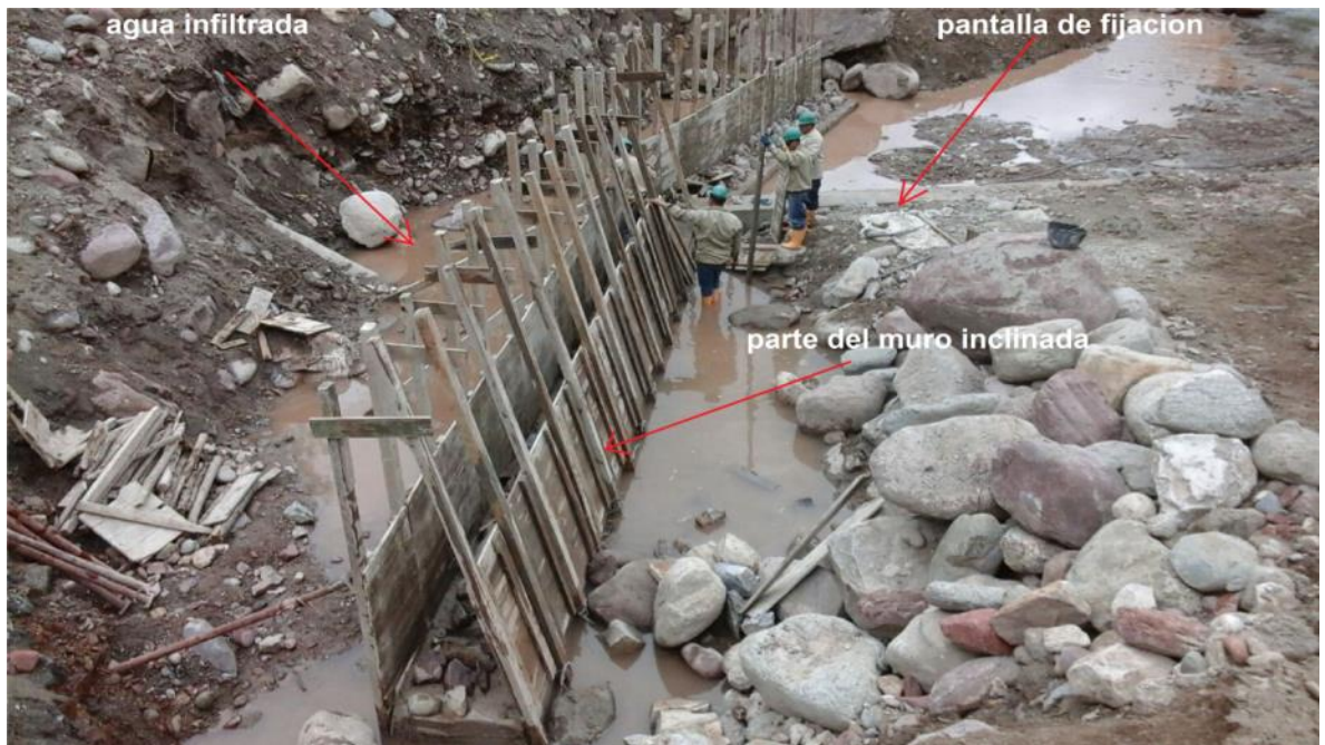
Figura 68. Encofrado de parte inclinada del muro en concreto ciclópeo.
