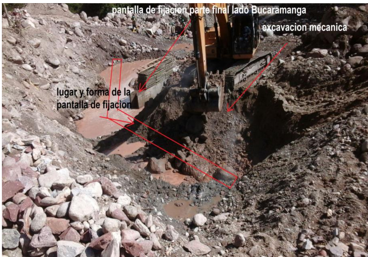
Figura 65. Excavación mecánica de muro en concreto ciclópeo.
