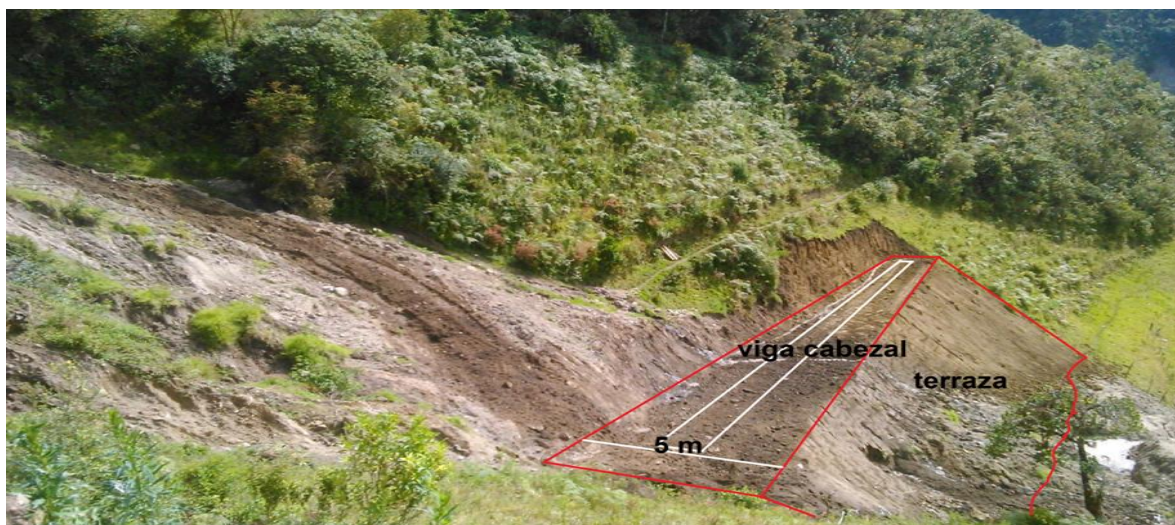
Figura 75. Construcción de terraza y ubicación de viga cabezal.
