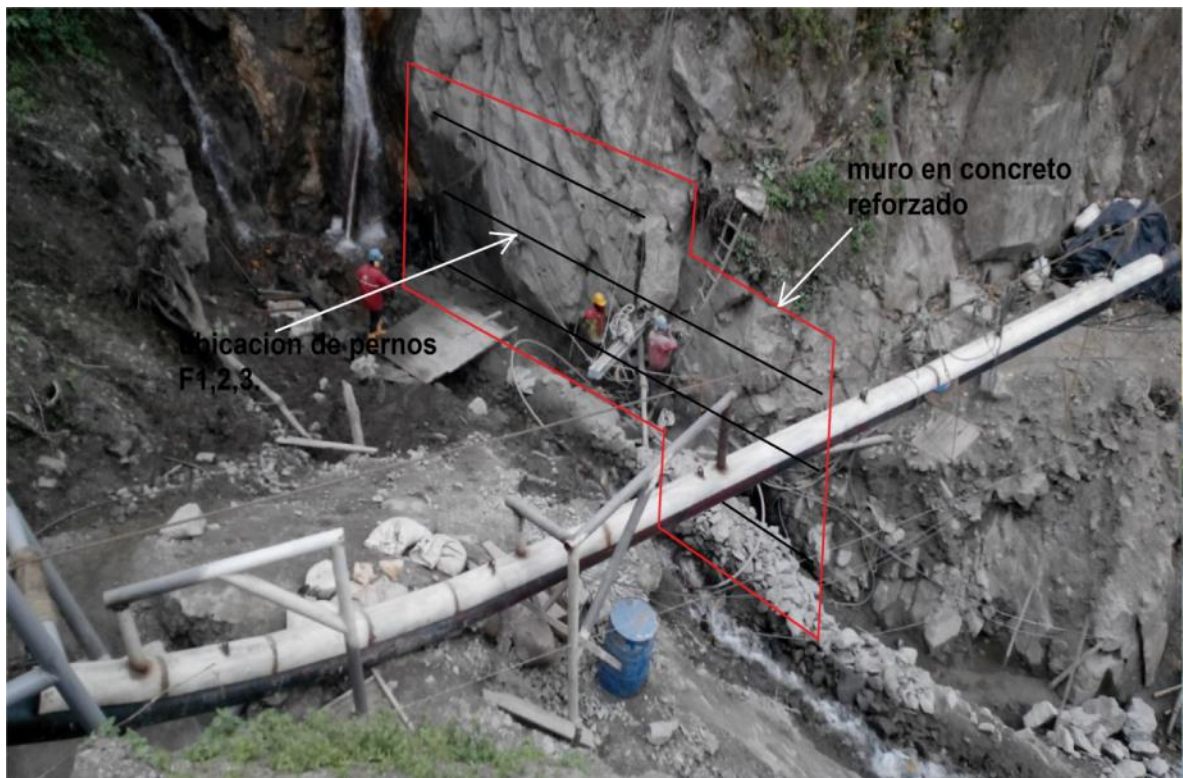
Figura 79. Ubicación de muro y pernos.
