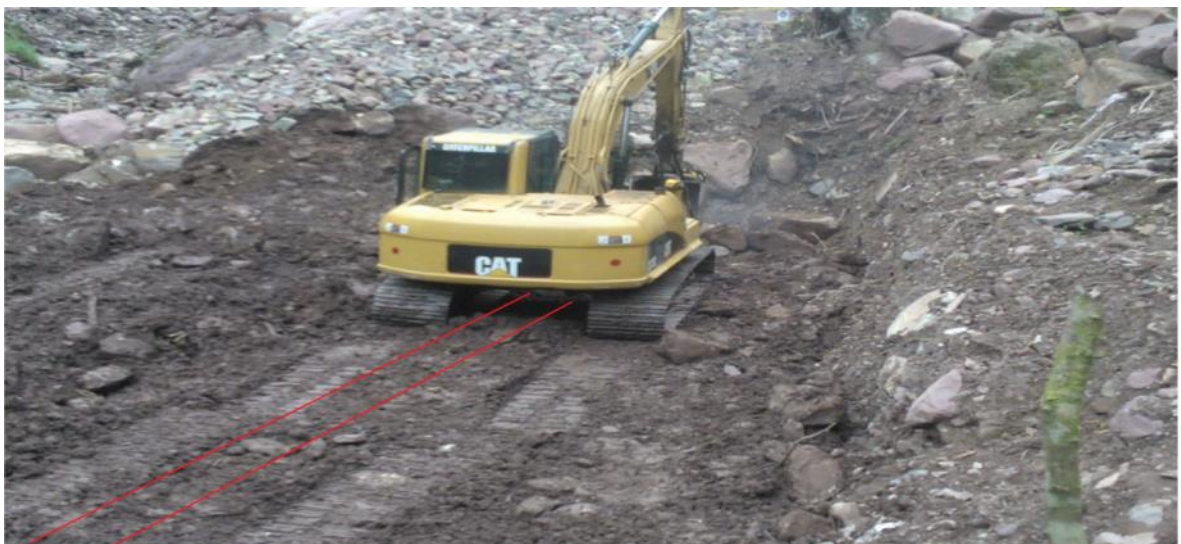
Figura 18. Excavación mecánica (retroexcavadora 320c).
