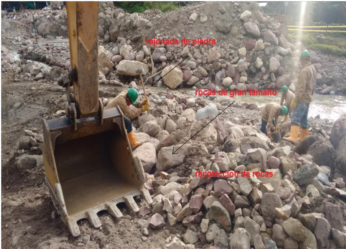
Figura 58. Acopio y rajonada de piedra.
