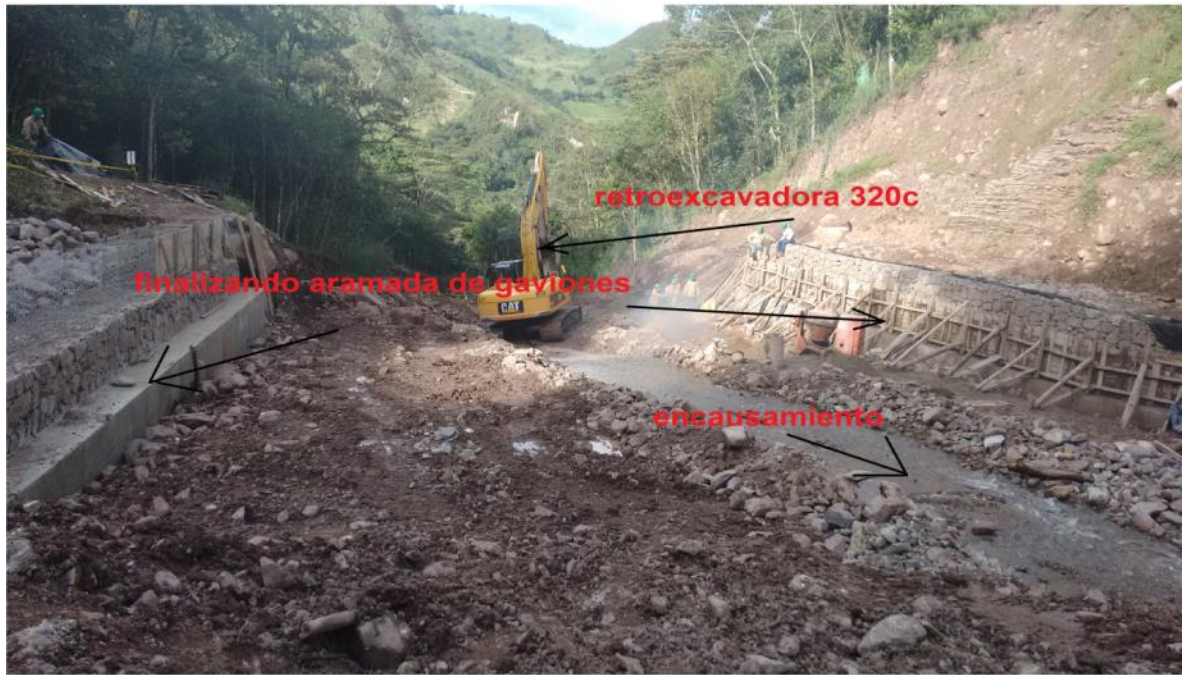
Figura 29. Mejoramiento del cauce con retroexcavadora.
