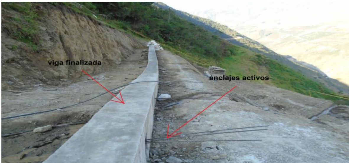
Figura 78. Viga finalizada
