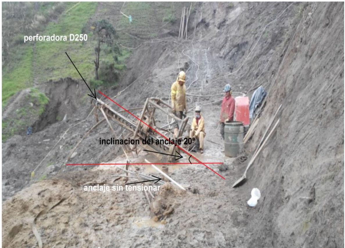
Figura 73. Perforación para anclajes activos.
