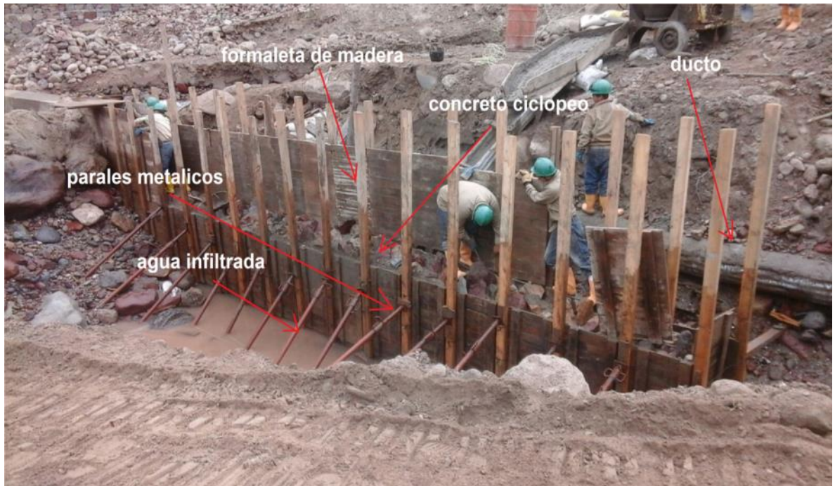
Figura 63. Proceso de encofrado de pantalla de fijación.
