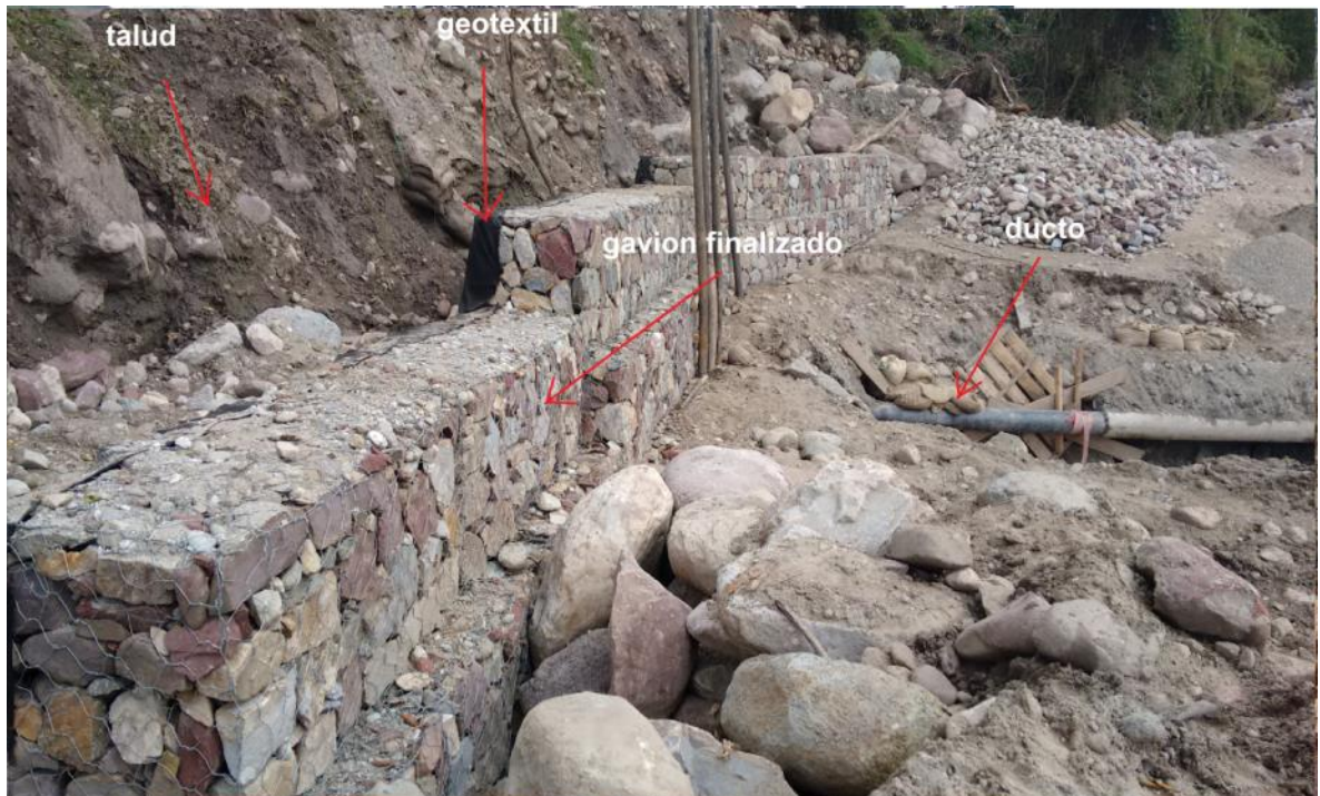
Figura 60. Muro en gavión finalizado.
