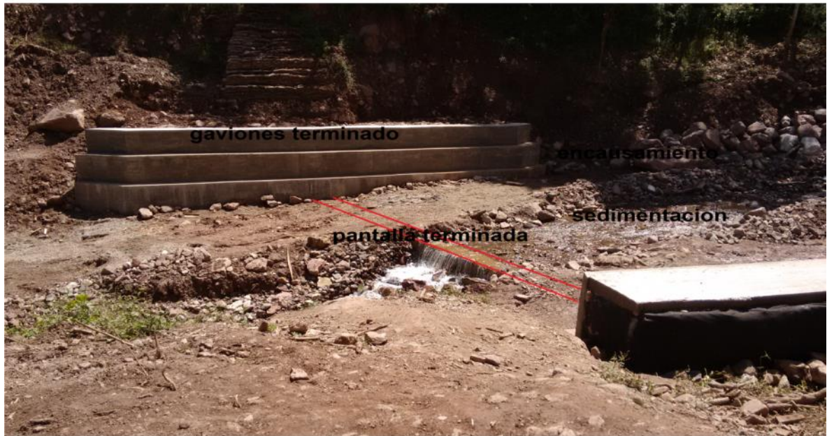
Figura 31. Vista lateral de obra terminada.
