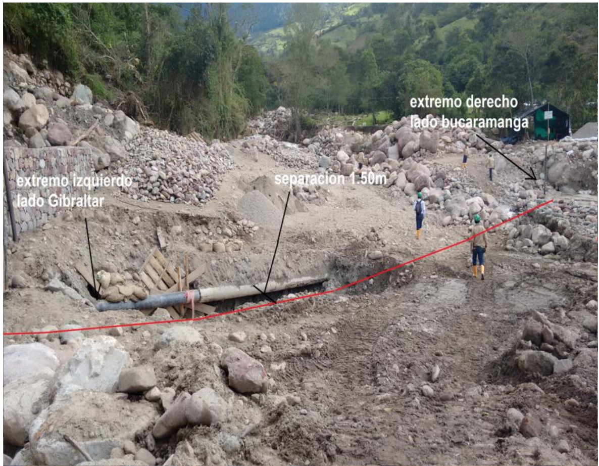
Figura 61. Liberación de ducto y ubicación de pantalla de fijación.
