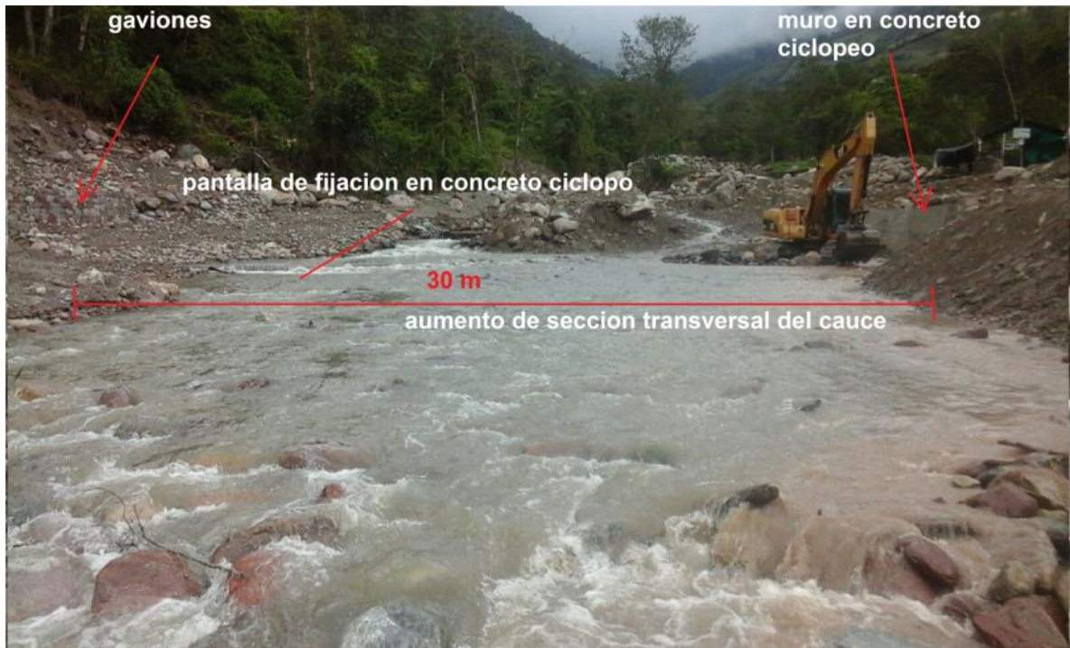
Figura 69. Manejo del cauce y finalizado de obra.
