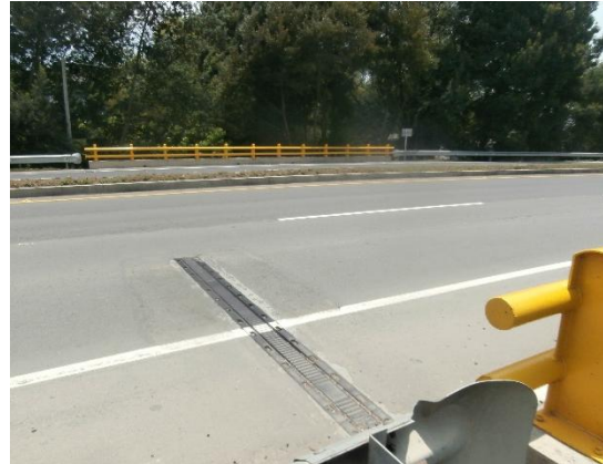
JUNTA DE DILATACIÓN
