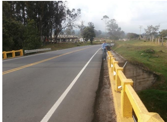
CALZADA DEL PUENTE
