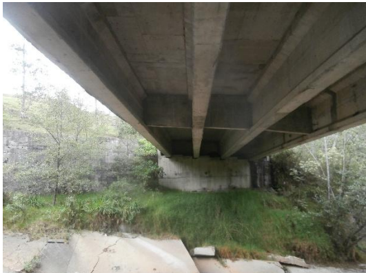
VIGAS DEL PUENTE
