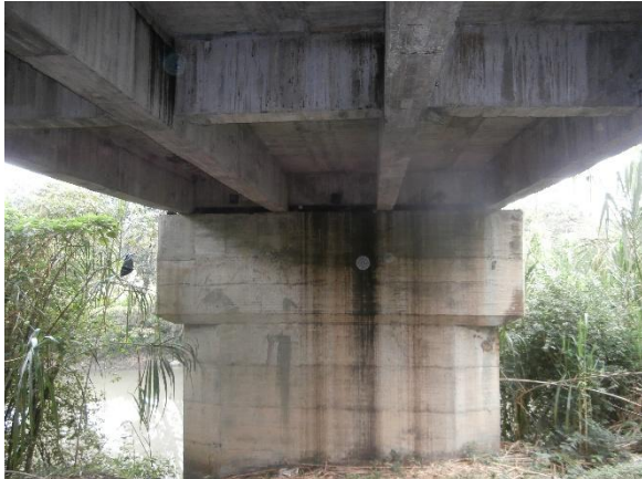
PILA Y VIGAS
