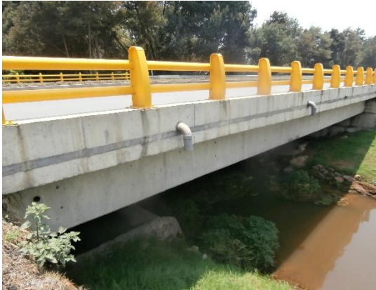
COSTADO IZQUIERDO DEL PUENTE
