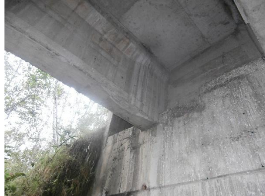
ESTRIBO DEL PUENTE
