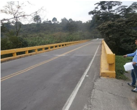
CALZADA DEL PUENTE
