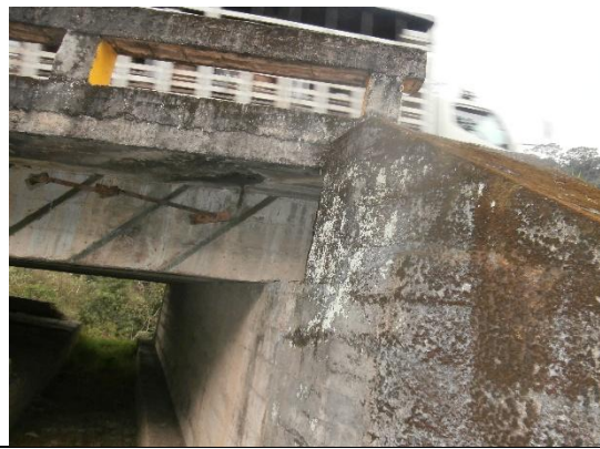
ESTRIBO Y VIGAS
