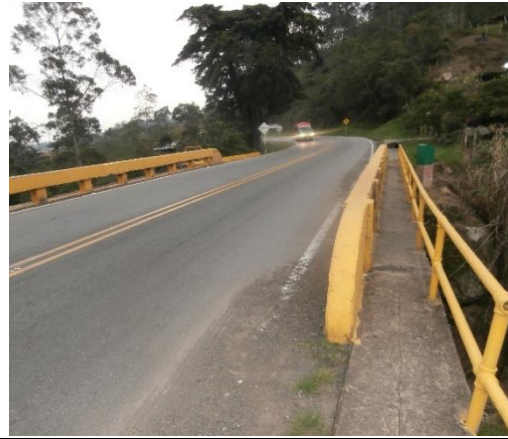
CALZADA DEL PUENTE
