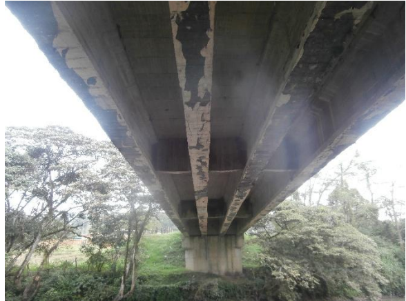
VIGAS DEL TABLERO
