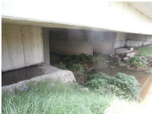
BOX COULVERT DE DEBAJO EL PUENTE
