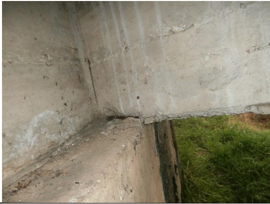
APOYO DE LA VIGA
