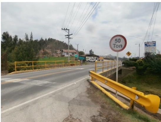
CALZADA DEL PUENTE
