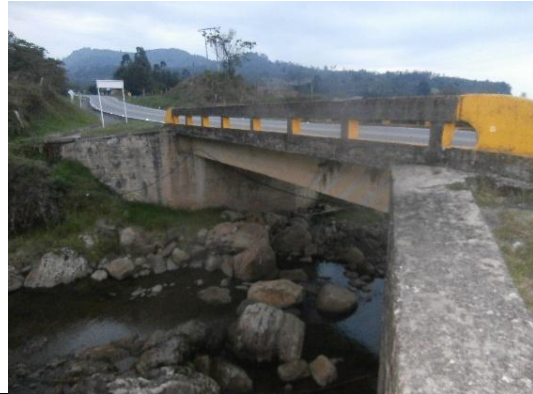
ESTRIBÓ COSTADO DERECHO
