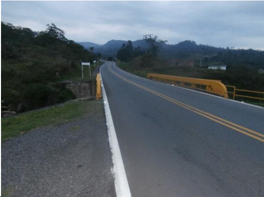
CALZADA DEL PUENTE
