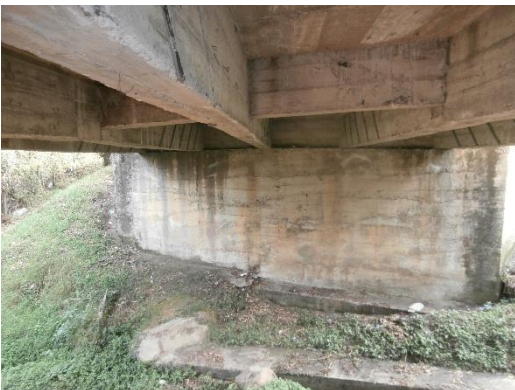
ESTRIBOS Y VIGAS
