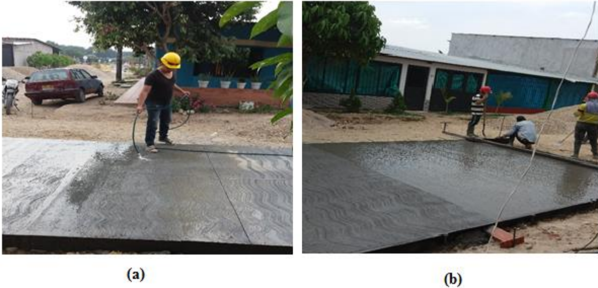
Imagen 11: Proceso Constructivo de las losas del pavimento
