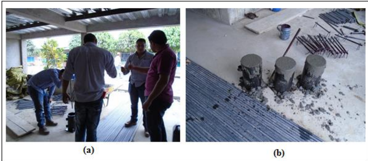
Imagen 12: Ensayos de cilindros de concreto.
