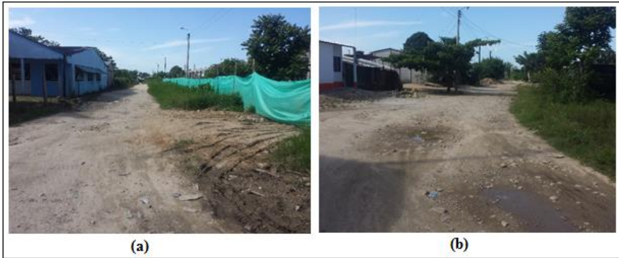
Imagen 4: Zona intervenida por el Contrato de obra 037
