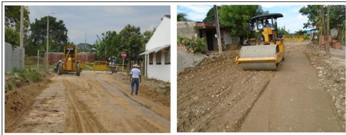
Imagen 8: Conformación y compactación de la sub – rasante.
