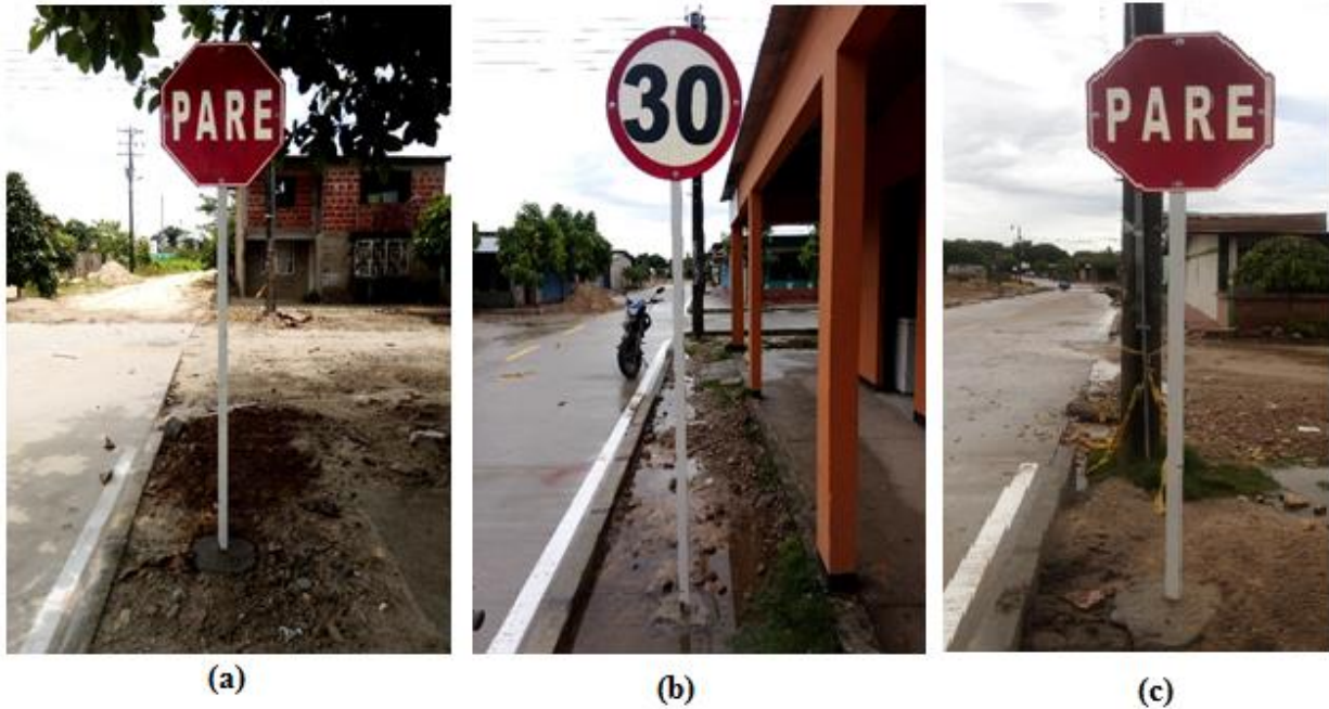
Imagen 20: Instalación de Señales de tránsito.
