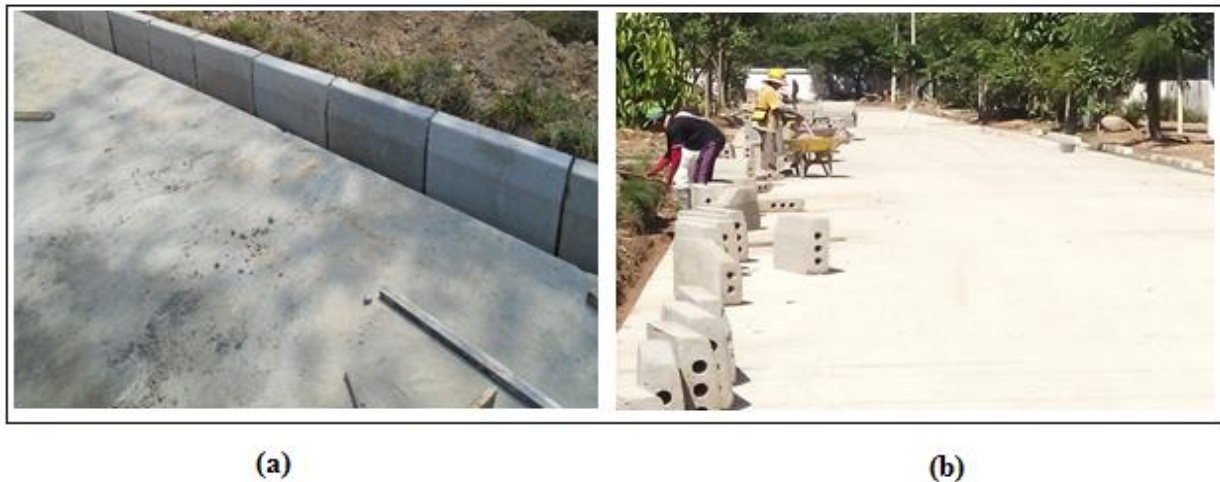
Imagen 13: Instalación de sardineles tipo idu A-10
