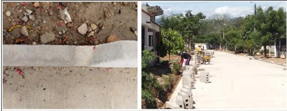
Imagen 14: Instalación de Sardinel Tipo idu A-1
