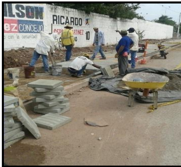
Figura 32. Colocación de losetas.
