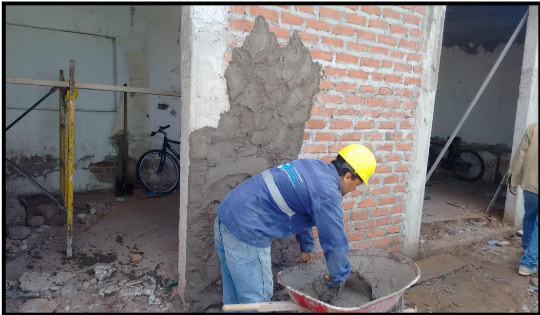
Figura 19. Pañete de muros.
