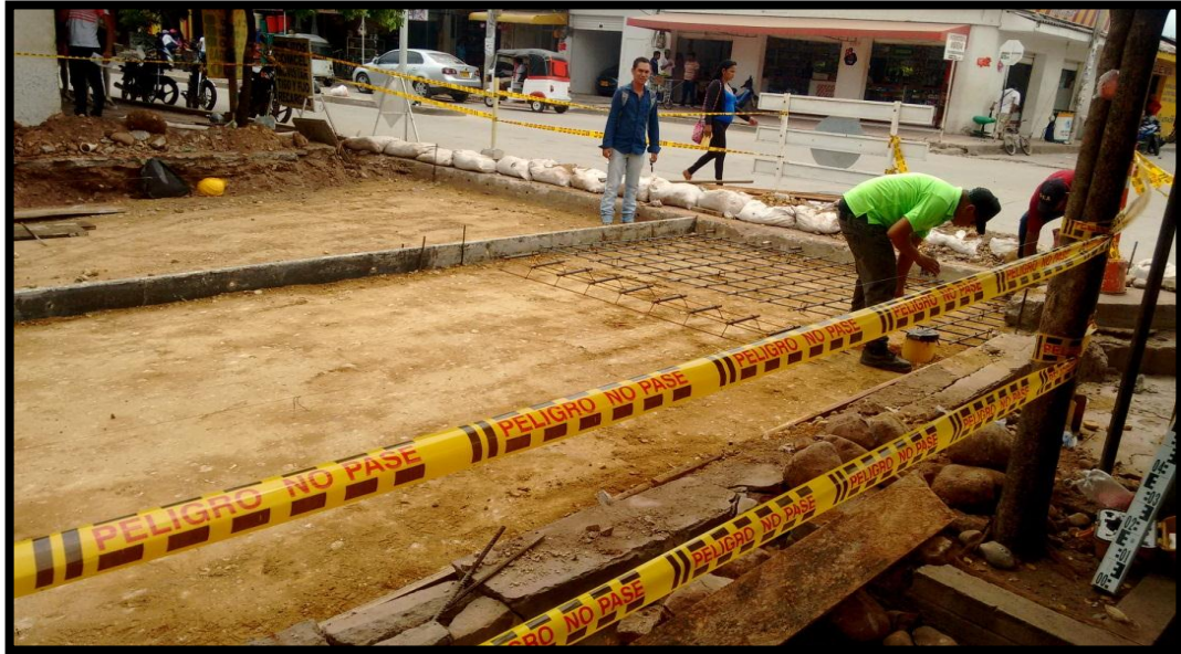
Figura 12. Acero de refuerzo.
