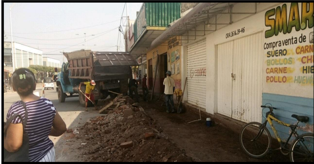
Figura 15. Retiro de sobrantes.
