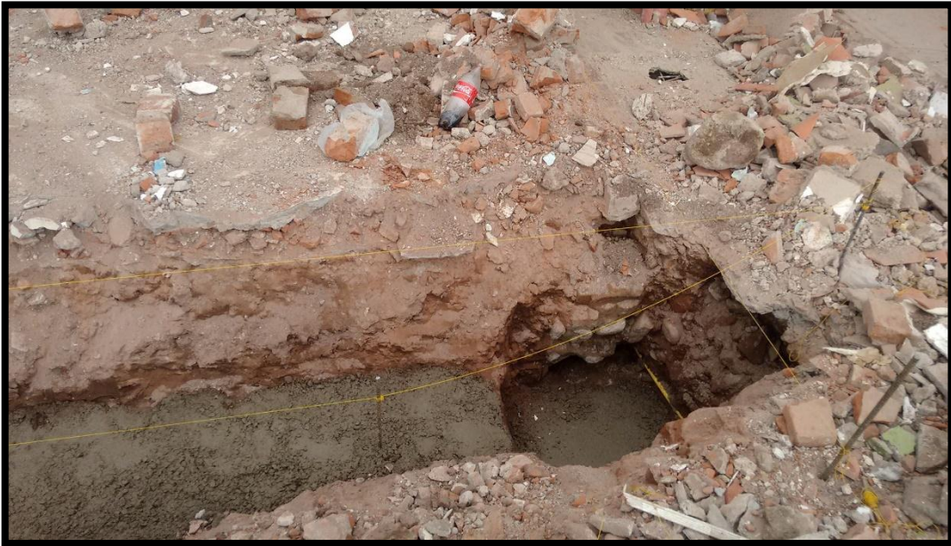
Figura 17. Excavaciones para cimientos.
