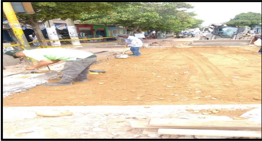
Figura 11. Colocación de sub-base.
