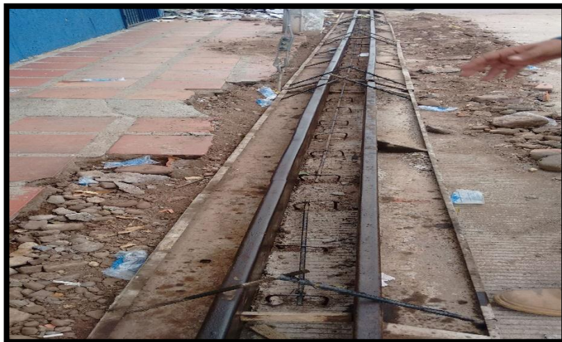
Figura 28. Formaleta para bordillos.
