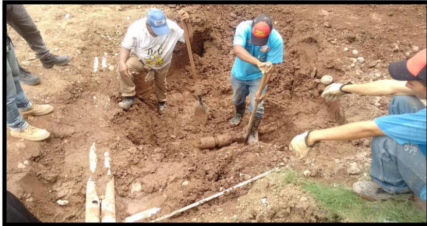
Figura 34. Excavación para redes de acueductos
