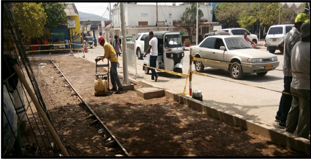
Figura 13. Compactación del terreno.
