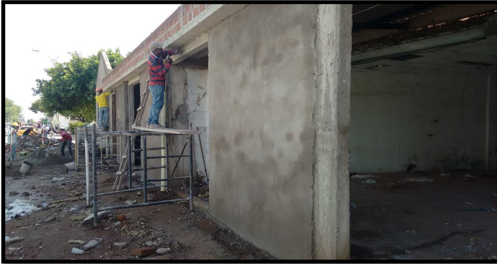
Figura 20. Pañete de muro sencillo.
