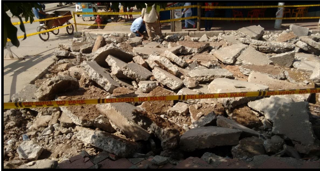
Figura 16. Demolición de pavimentos.
