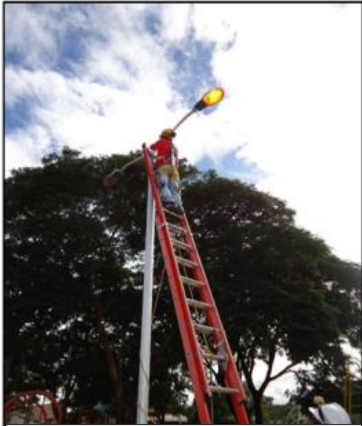
Mantenimiento de Luminarias Públicas
