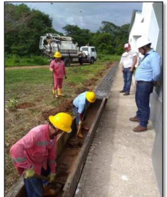
Limpieza y mantenimiento de canales pluviales
