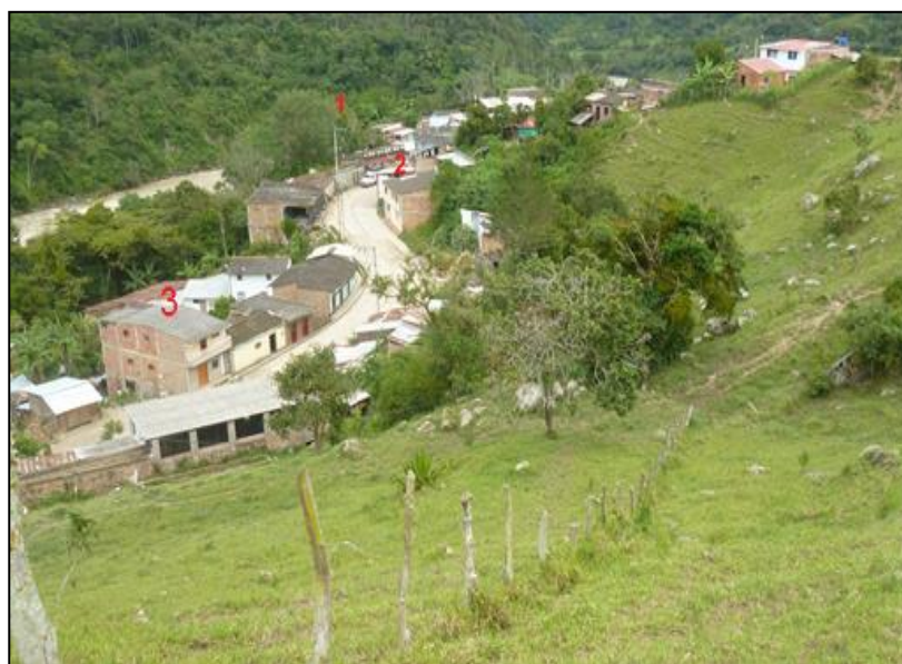
Figura 28: Estado del sector amenazado previo al fenómeno de remoción
