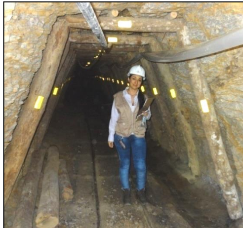
Figura 20: Bocamina municipio de Cúcuta.
