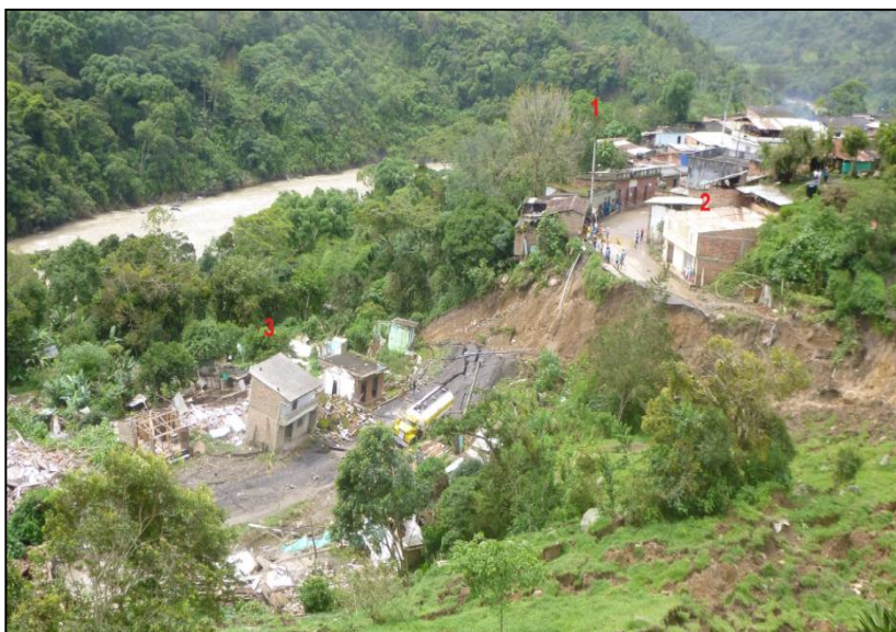
Figura 29: Estado del mismo sector, luego de fenómeno de remoción en masa Fecha: Agosto de 2015 Municipio de Toledo, Corregimiento San Bernardo de Bata Fuente: CORPONOR
