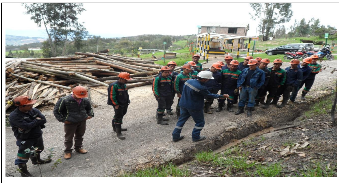
Fotografía 79. Explicación sobre la función y el manejo de las cunetas por el paso de aguas lluvias y de escorrentía
