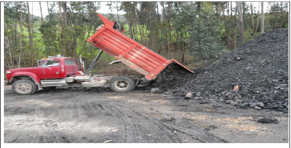
Fotografía 37. Descarga de material estéril al botadero activo
