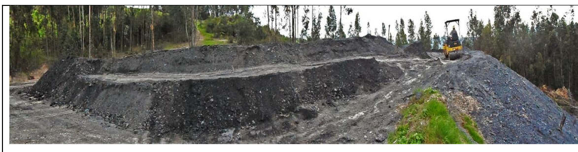
Fotografía 49. Vista panorámica después de la formación de terraza del botadero activo
