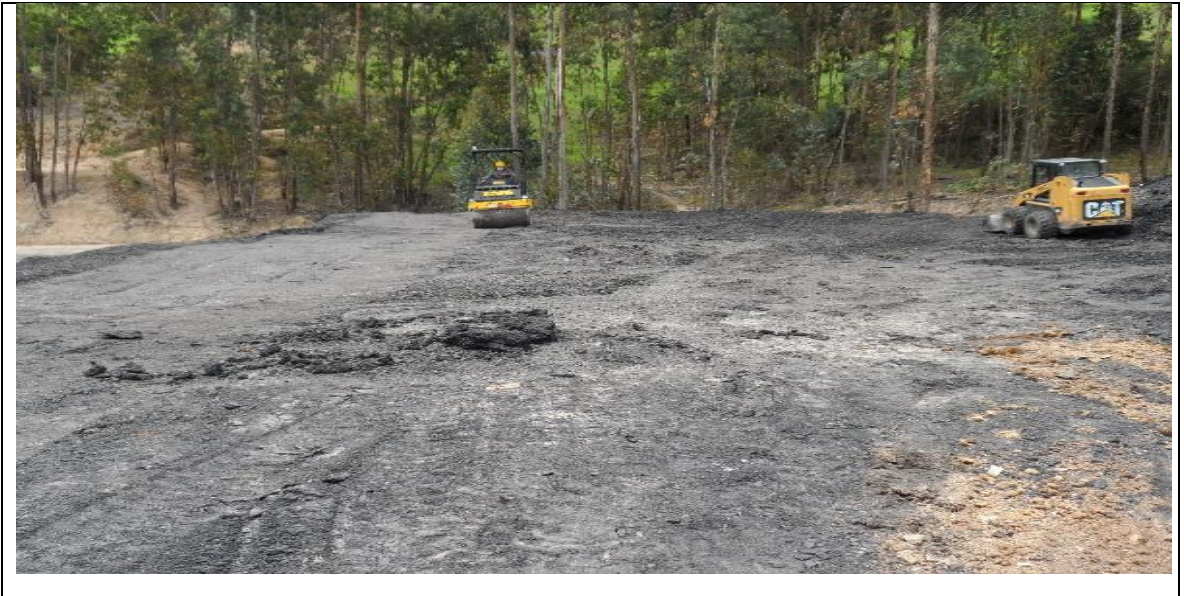
Fotografía 40. Compactación por medio del vibrocompactador en el botadero activo
