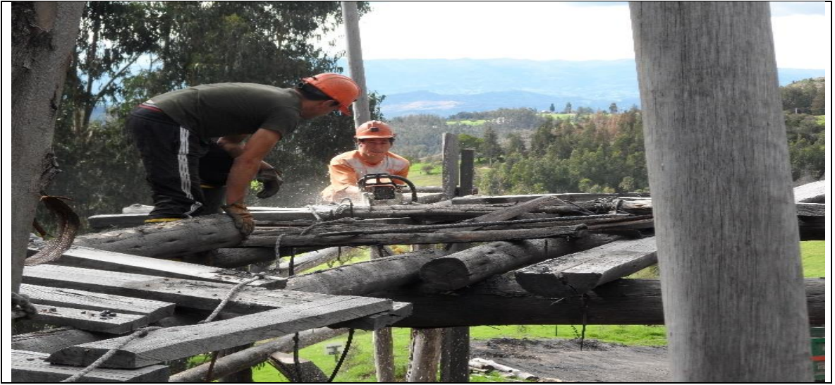
Fotografía 62. Retiro de correas
