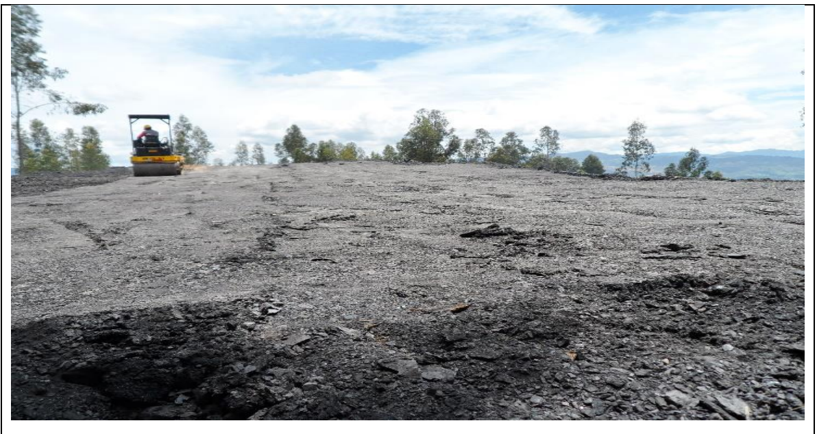
Fotografía 41. Compactación por medio del vibrocompactador en el botadero activo
