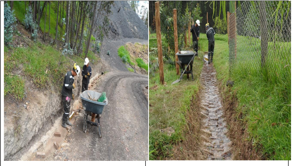
Fotografía 87. Limpieza de disipadores de energía
