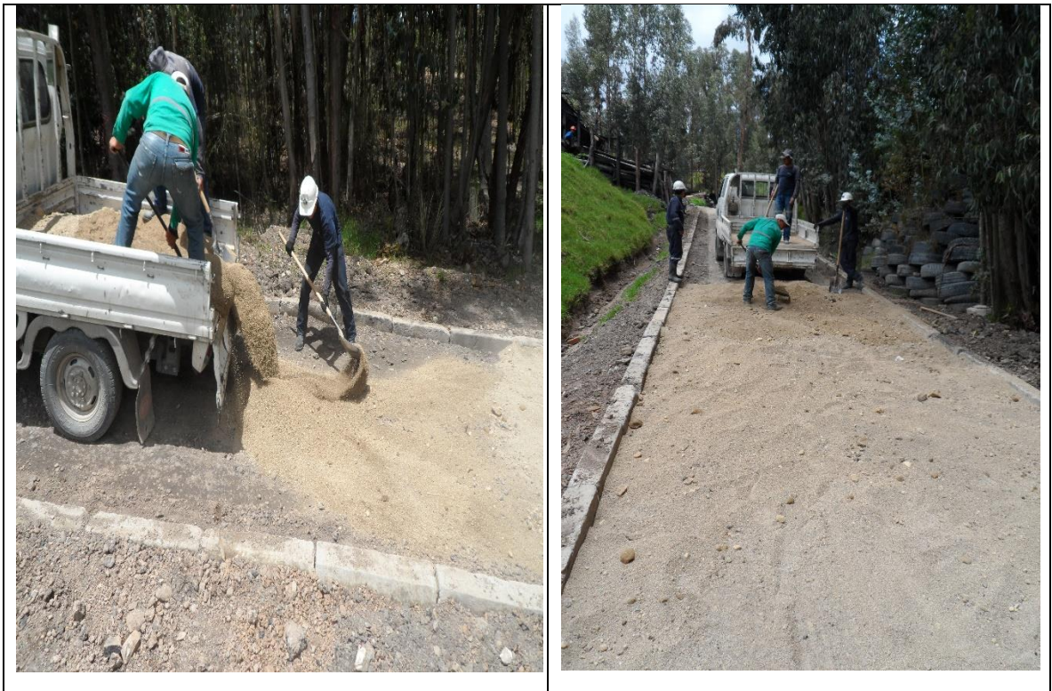
Fotografía 52. Extensión y compactación de la base
