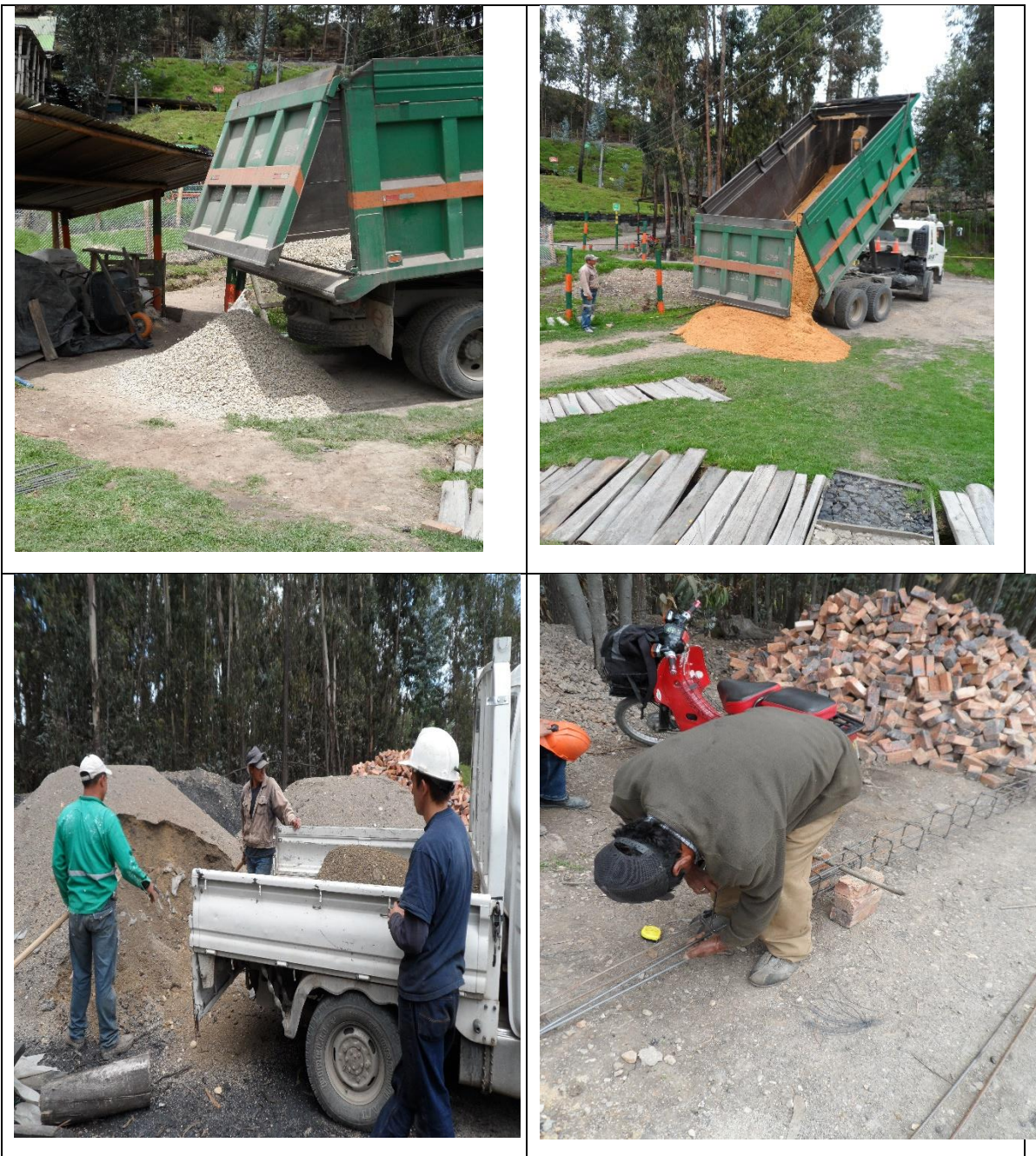
Fotografía 50. Equipos, materiales y herramientas a utilizar
