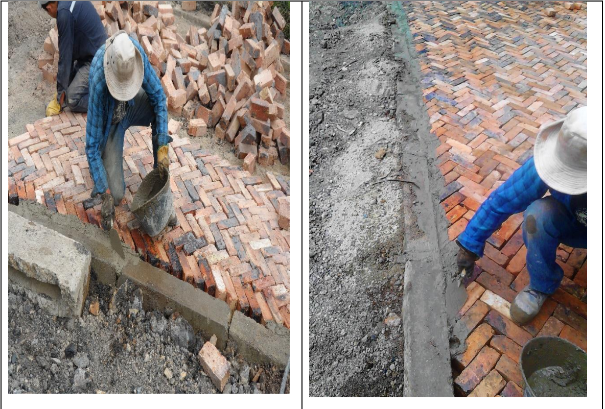
Fotografía 56. Relleno en concreto de espacios sobrantes
