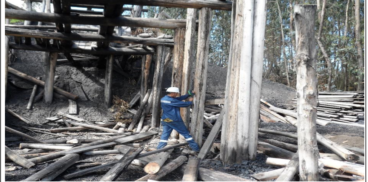
Fotografía 67. Medición de las columnas a 1.40 metros
