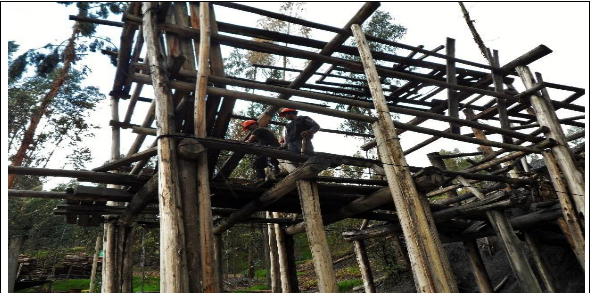
Fotografía 61. Retiro de tablas laterales de la tolva
