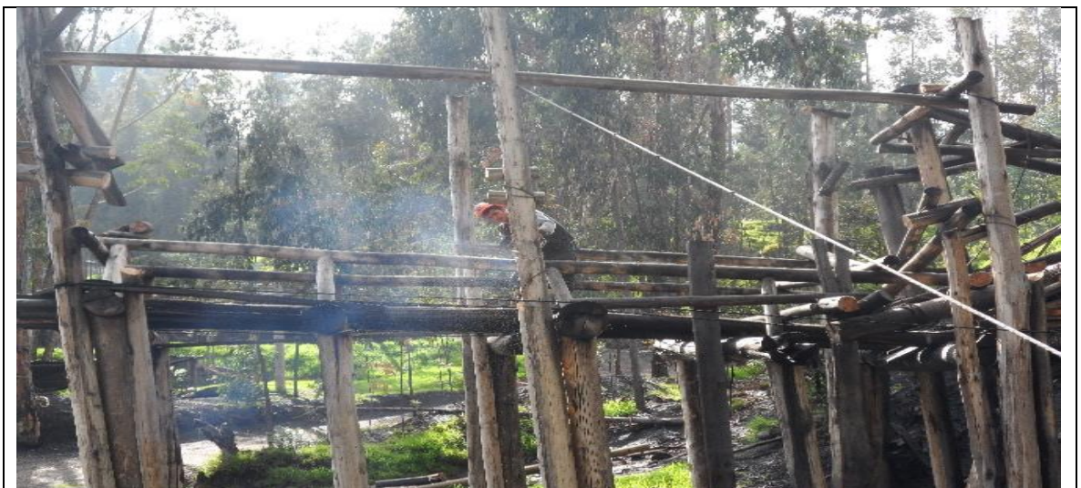
Fotografía 65. Retiro de columnas parte superior de la tolva
