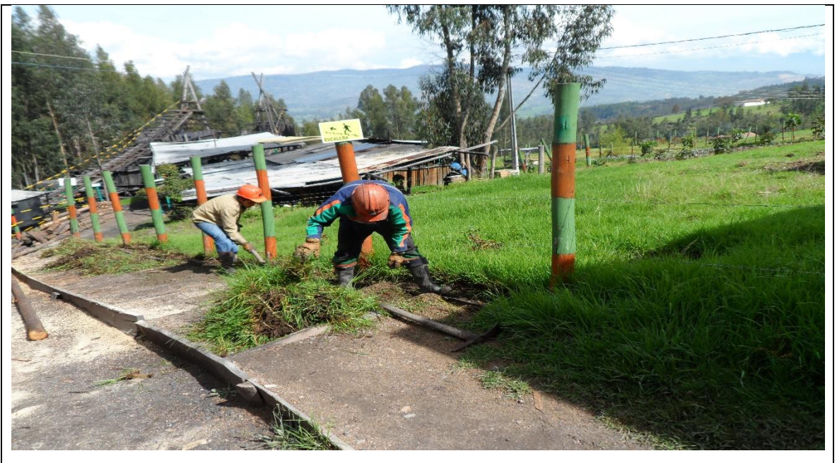
Fotografía 84. Recorte de pastos en los peldaños de la escalera
