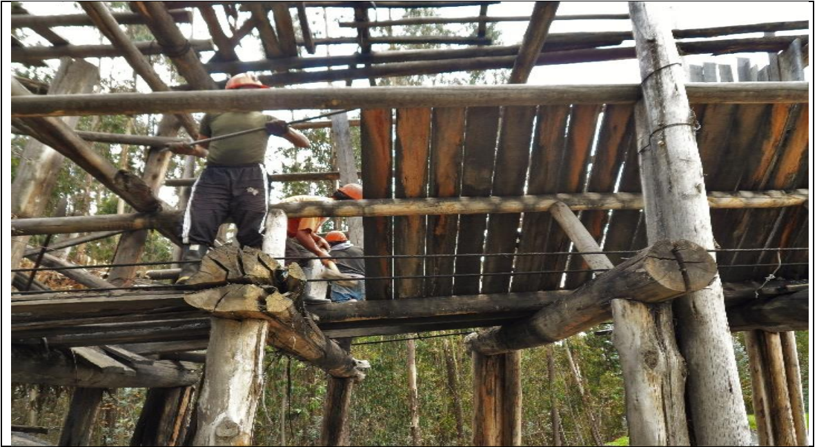
Fotografía 60. Retiro de tablas laterales de la tolva
