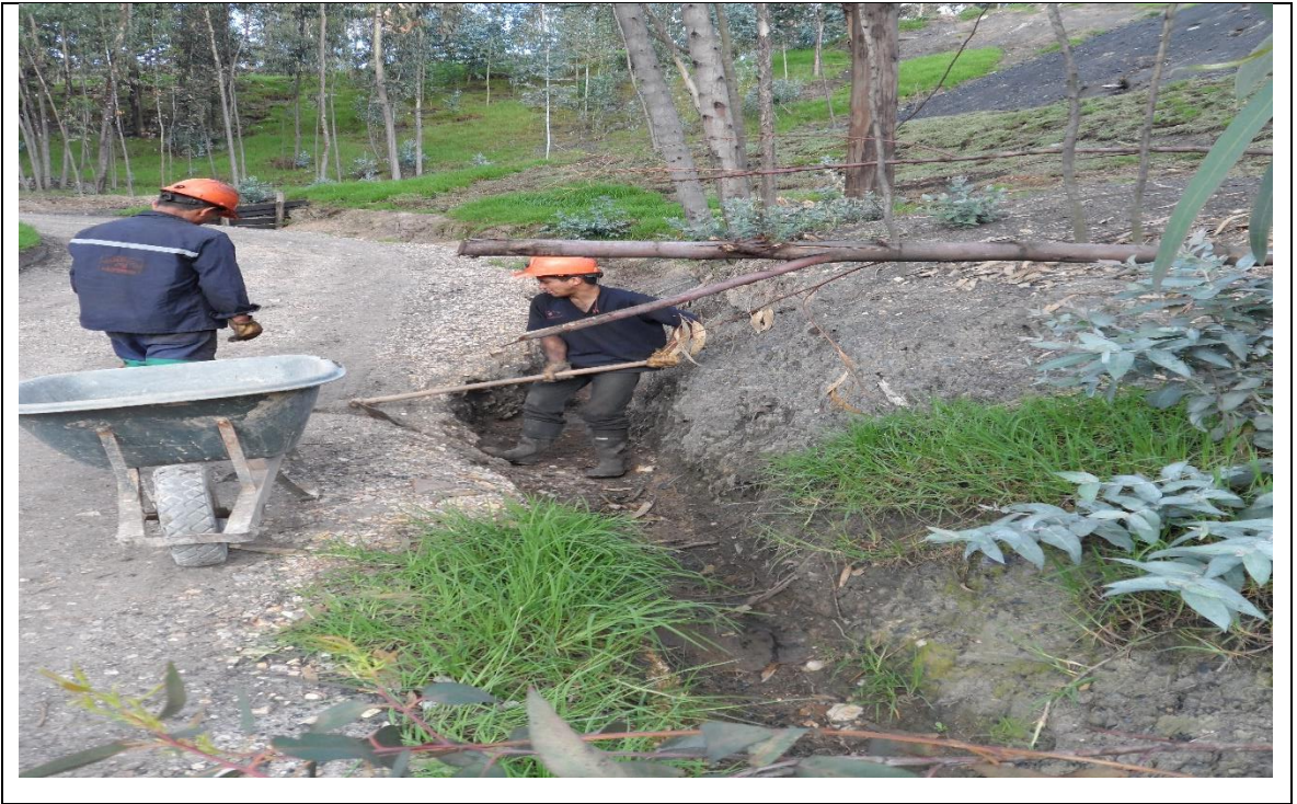
Fotografía 85. Limpieza de cunetas del sistema de aguas lluvias y de escorrentía
