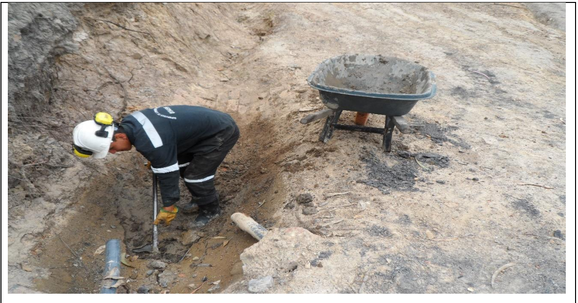
Fotografía 86. Limpieza de lodos en pozos sedimentadores
