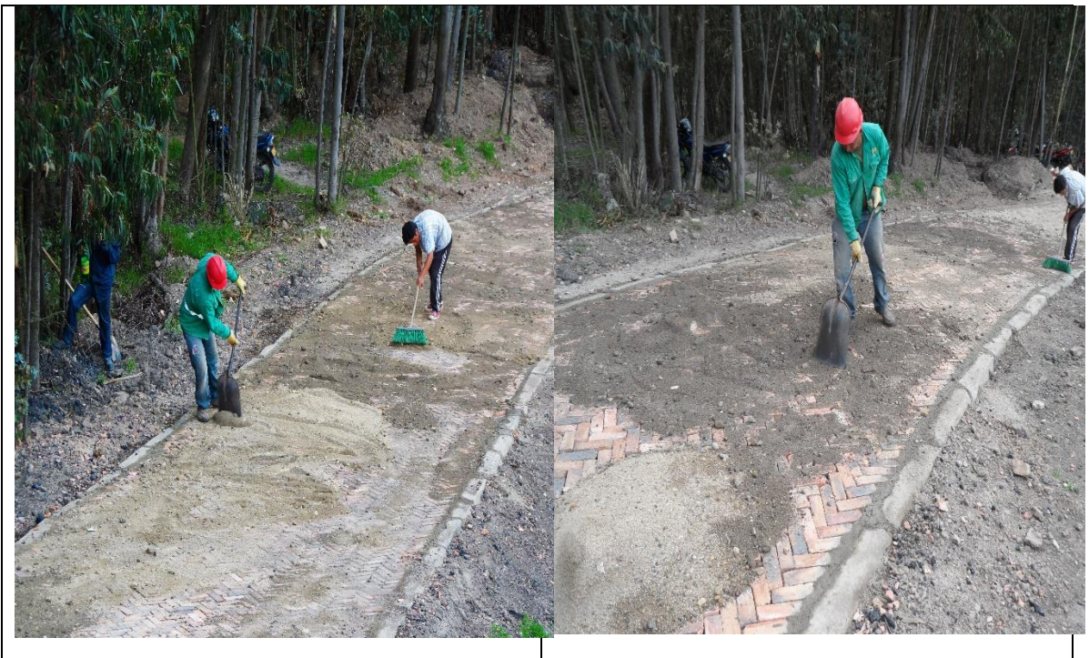
Fotografía 57. Sellado con material granular
