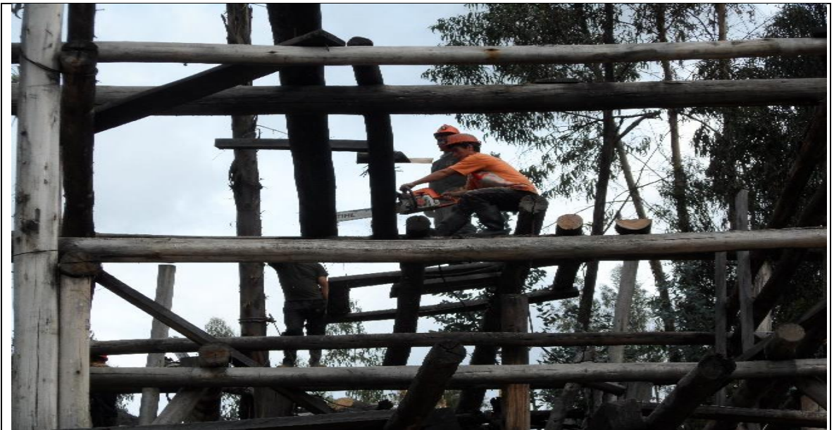
Fotografía 63. Retiro de correas
