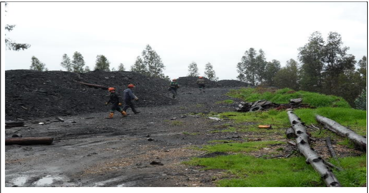
Fotografía 39. Retiro de madera, plástico y otros componentes presentes en el material estéril
