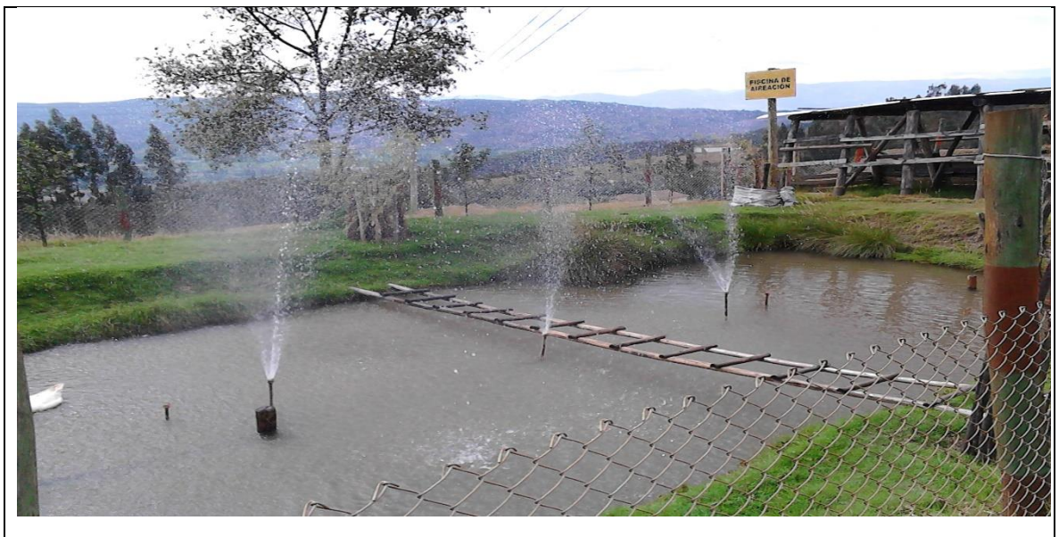
Fotografía 11. Piscina de aireación por fuente o surtidores
