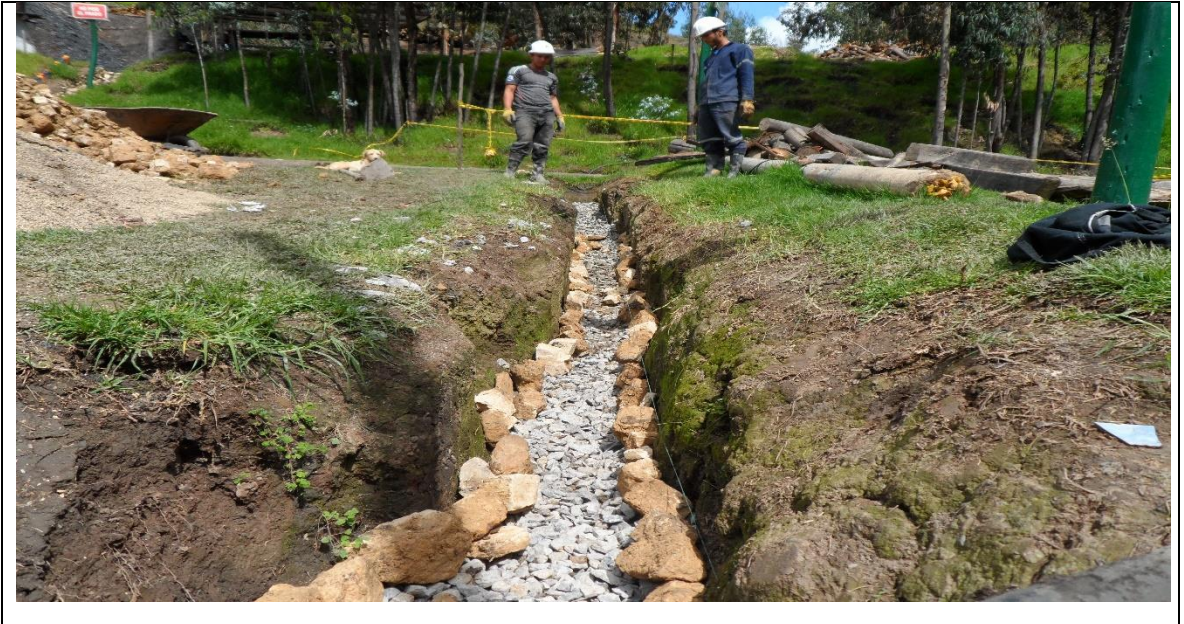
Fotografía 26. Adición de capa de grava
