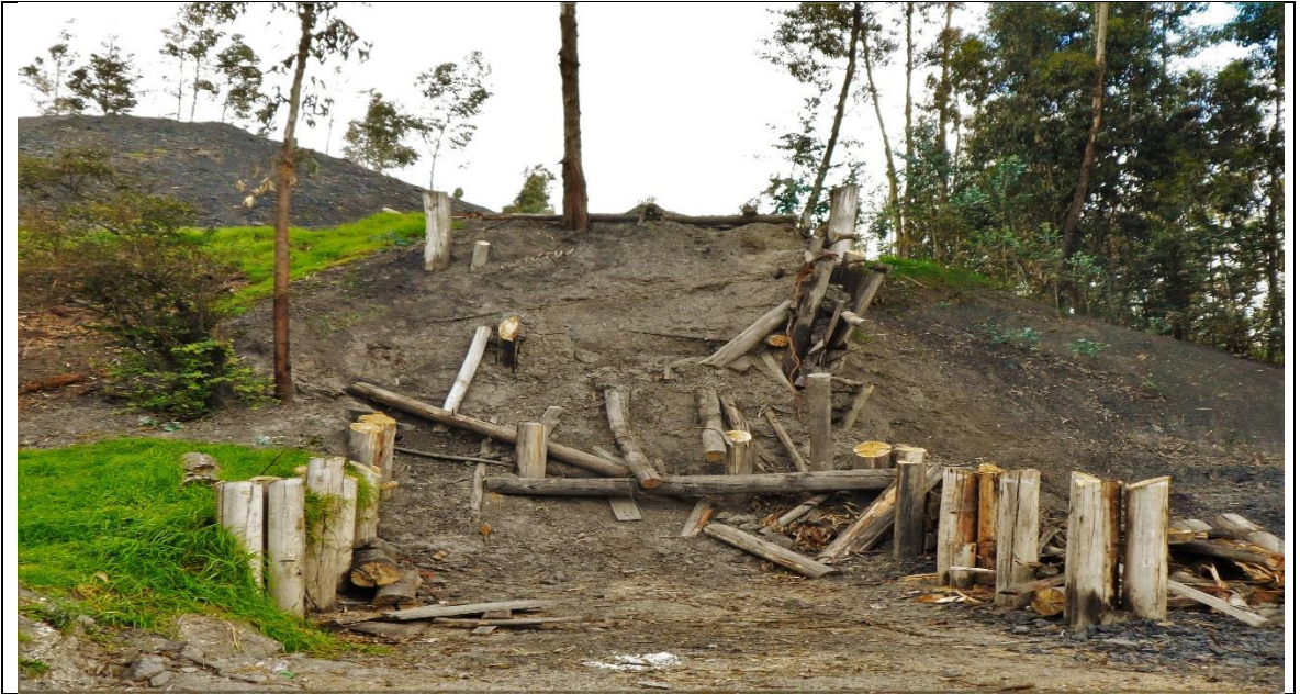
Fotografía 77. Vista frontal tolva después de ser desmantelada
