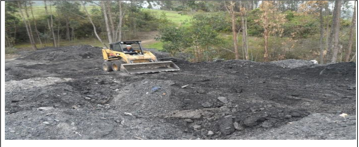
Fotografía 38. Remoción de material estéril
