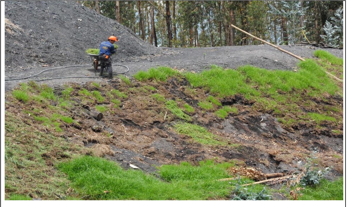
Fotografía 33. Instalación de cespedones sobre material estéril
