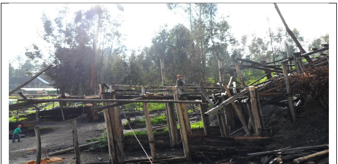
Fotografía 66. Retiro de columnas parte superior de la tolva
