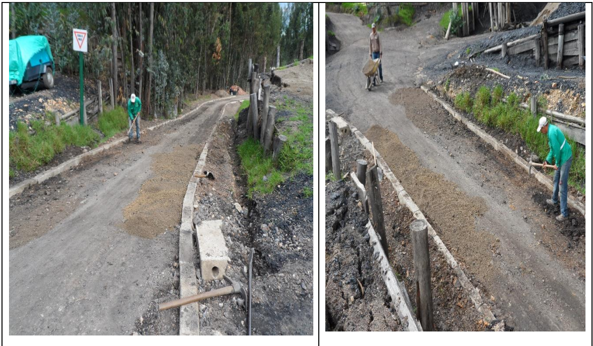
Fotografía 51. Instalación de bordillos
