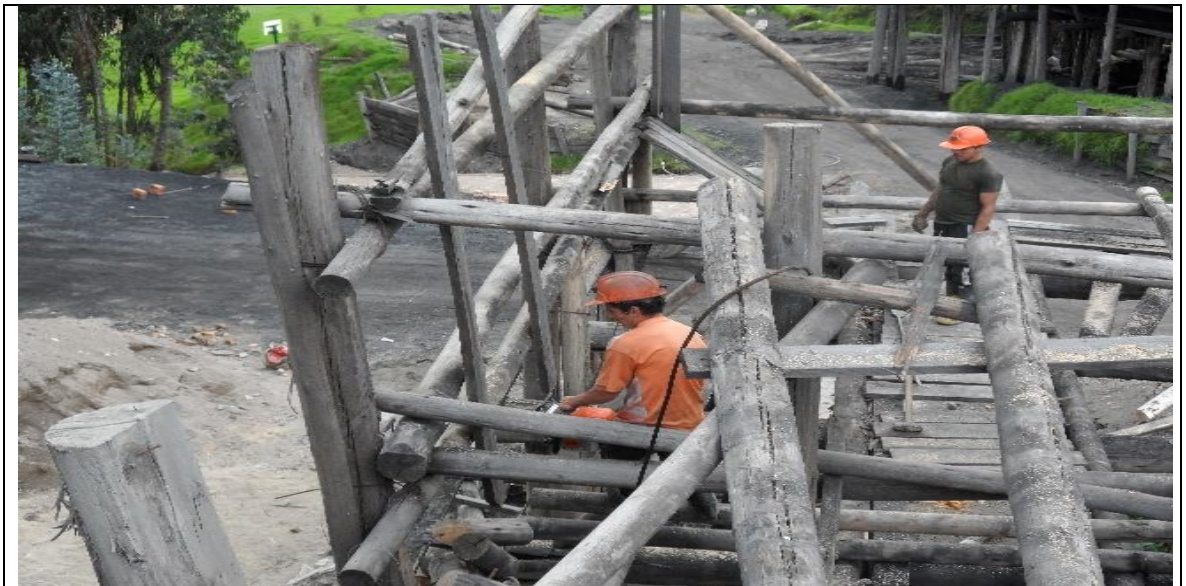
Fotografía 64. Retiro de vigas largas y vigas cortas
