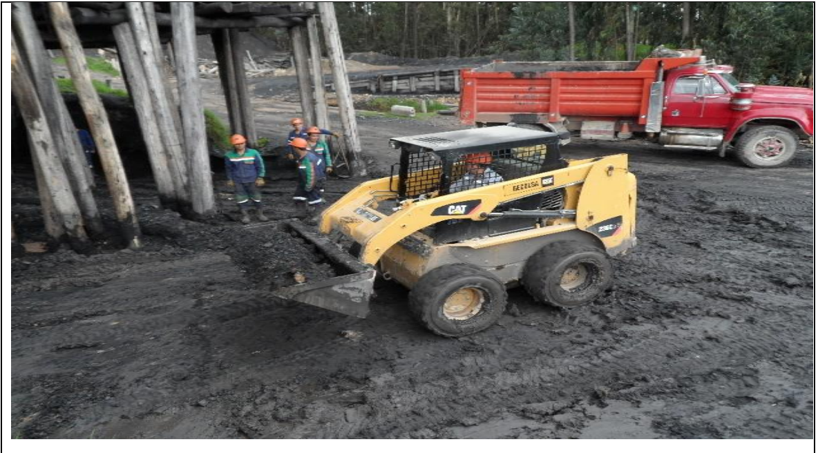
Fotografía 36. Carga de material estéril a la volqueta
