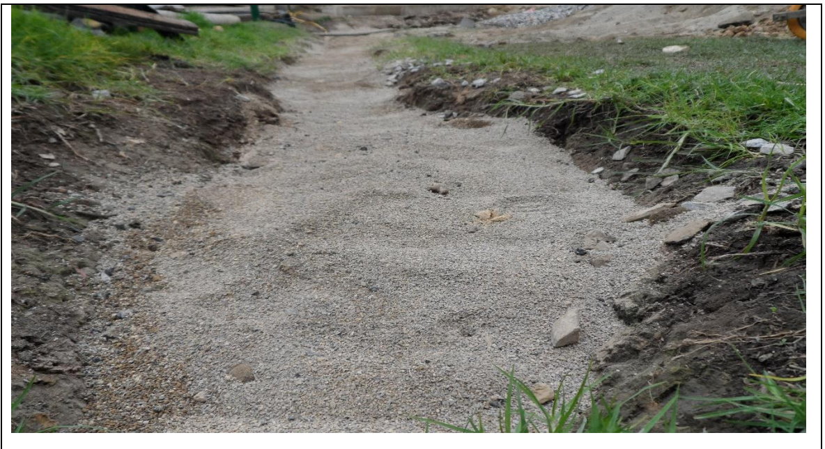
Fotografía 27. Adición de capa de granito
