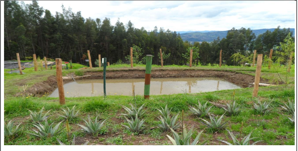
Fotografía 12. Piscina de sedimentación
