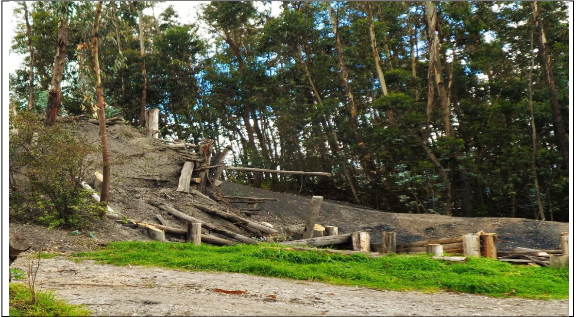
Fotografía 75. Vista lateral tolva después de ser desmantelada
