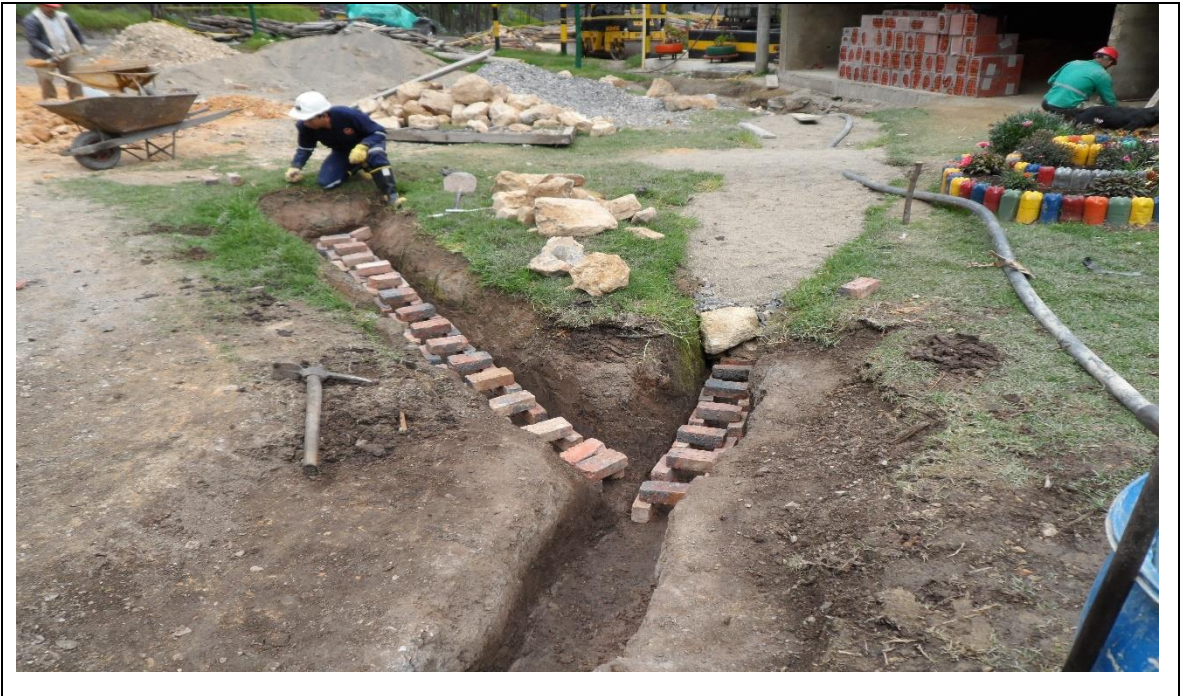
Fotografía 24. Canalización a través de ladrillos
