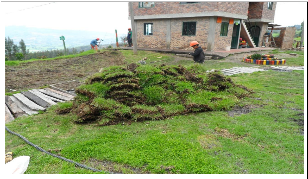
Fotografía 32. Disposición de cespedones en pilas
