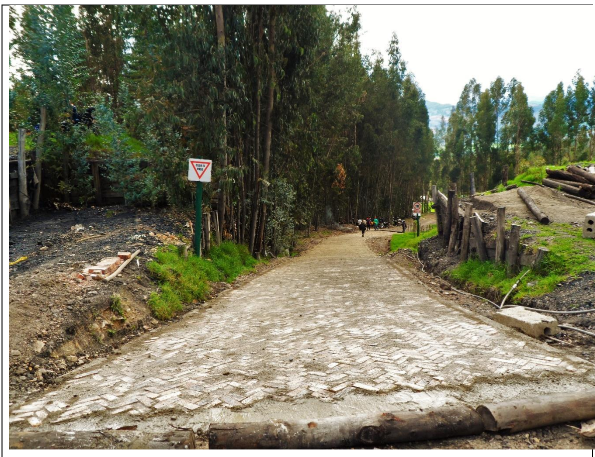
Fotografía 59. Vista superior vía adoquinada
