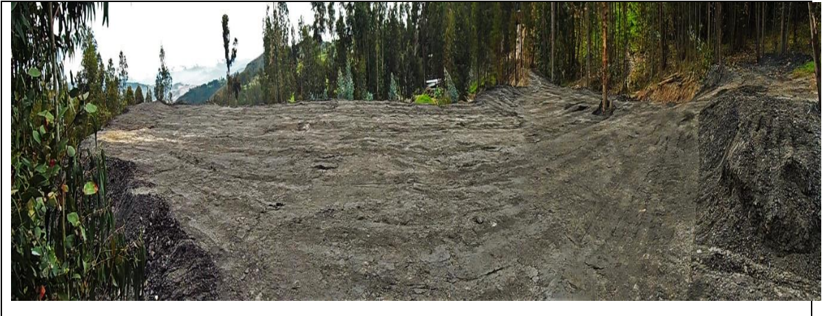
Fotografía 47. Vista panorámica botadero activo después de la remoción y compactación de material estéril
