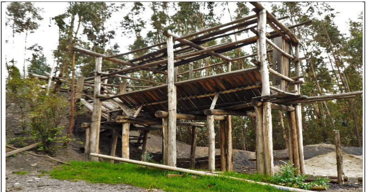
Fotografía 74. Vista lateral tolva antes de ser desmantelada
