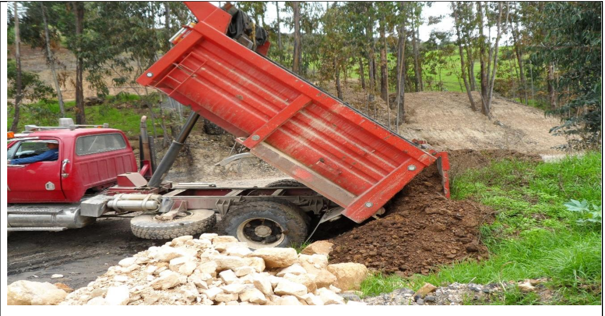
Fotografía 14. Descarga de tierra fértil
