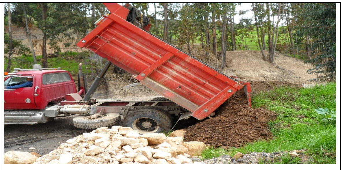
Fotografía 30. Descarga de suelo orgánico
