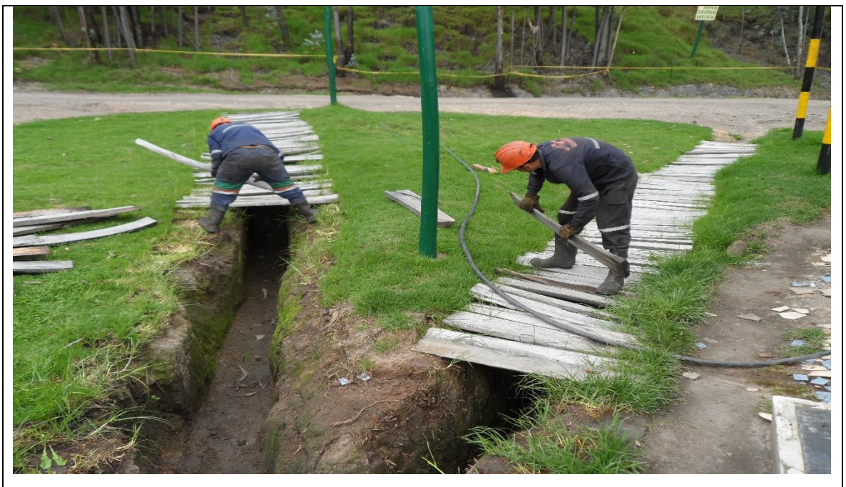
Fotografía 21. Retiro de tablas de madera
