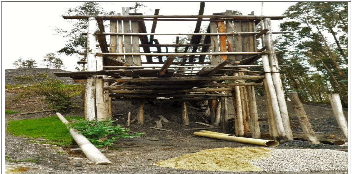
Fotografía 76. Vista frontal tolva antes de ser desmantelada
