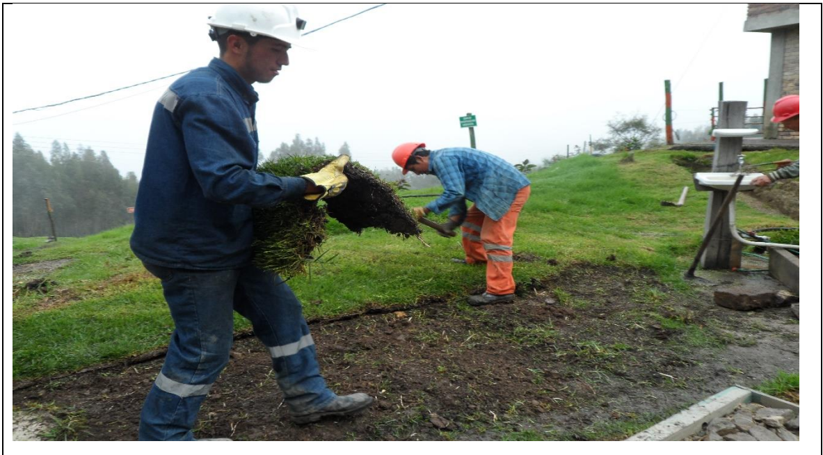
Fotografía 31. Retiro de cespedones por descapote
