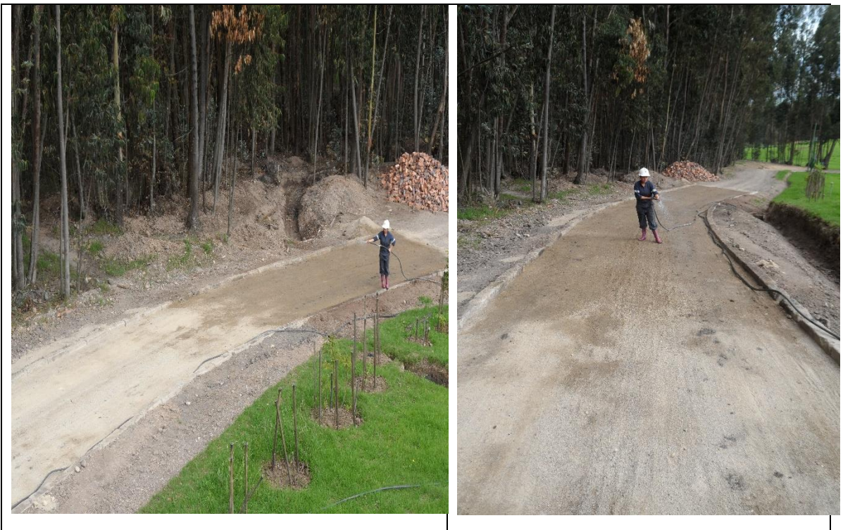
Fotografía 53. Riego y compactación de la base de fino
