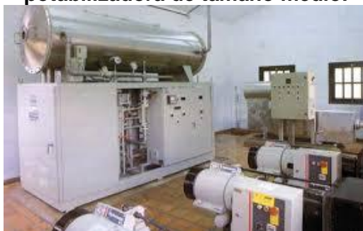
Imagen 11. Equipo Productor de ozono de última generación de una estación potabilizadora de tamaño medio.
