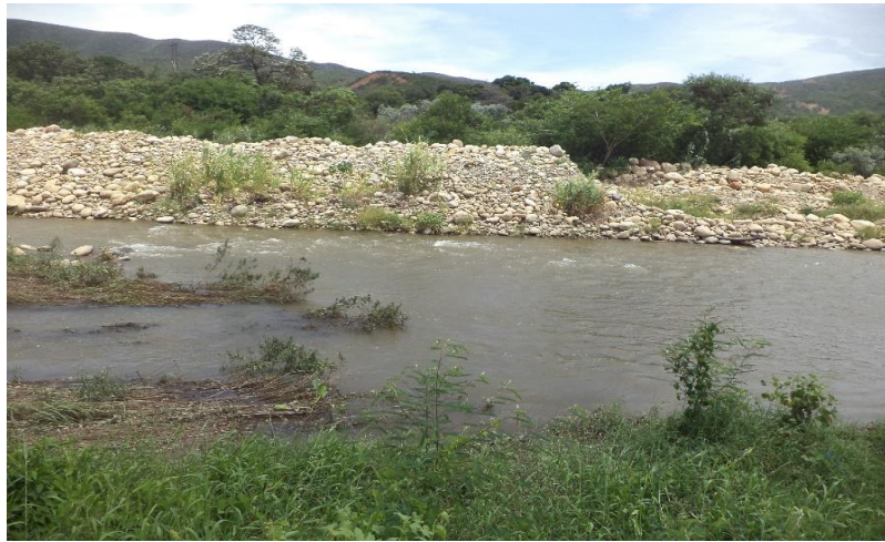
Imagen 10. Caudal aguas abajo de la Bocatoma.
