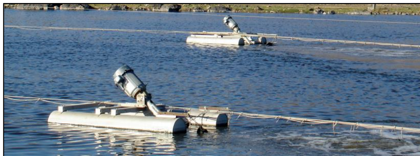
Figura 17. aireador aspirador superficial tornado Fuente: (RWL WATER, 2016)
