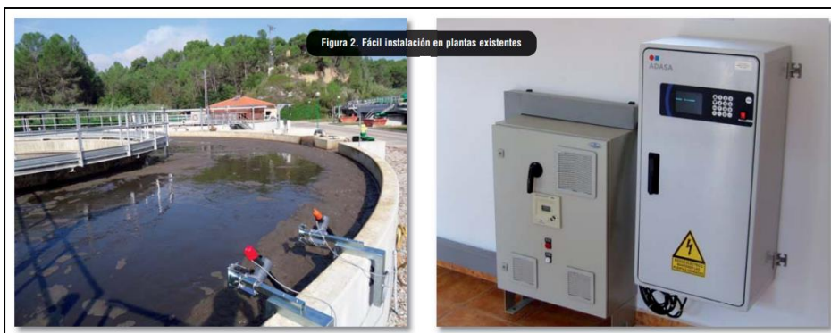
Figura 42. Instalación en plantas existente Fuente: (CROS, 2014)
