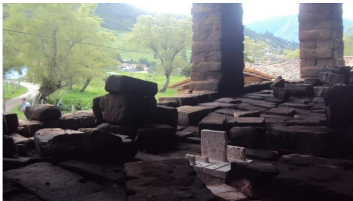
Ilustración 53. Difusor ubicado en el horno artesanal de ladrillo. Fuente propia
