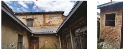
Muros compuestos de ladrillo cosido sobre tapia o rellenando vanos
