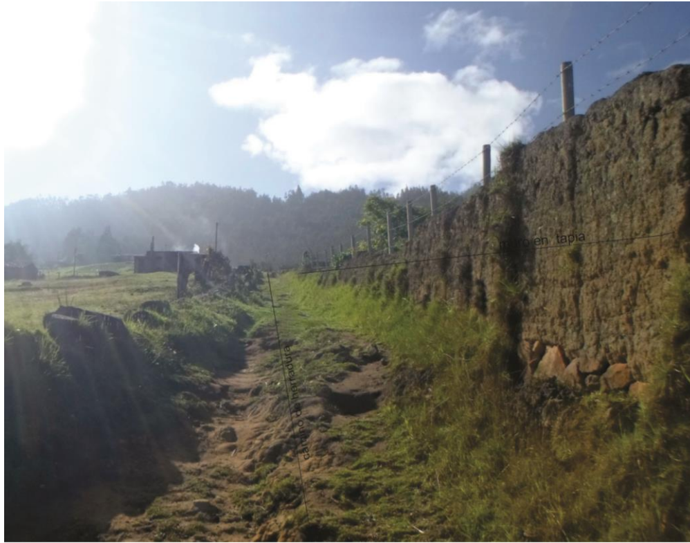
Imagen 21. Camino a Guata, estado actual, donde se puede observar vestigios de muros divisorios en tapia pisada.
