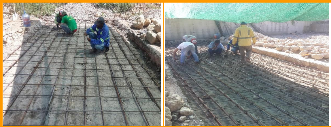
Figura 3 Instalación de Acero de refuerzo para placa inferior del puente que comunica construcción del puente que comunica Casco Urbano Con Centro Zoonosis
