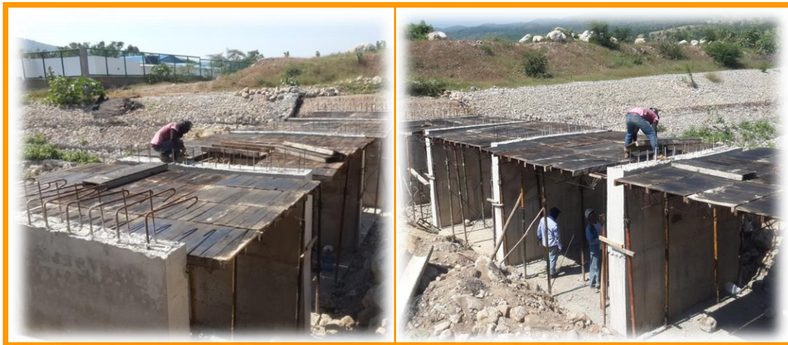
Figura 14 encofrado de placa superior de puente.
