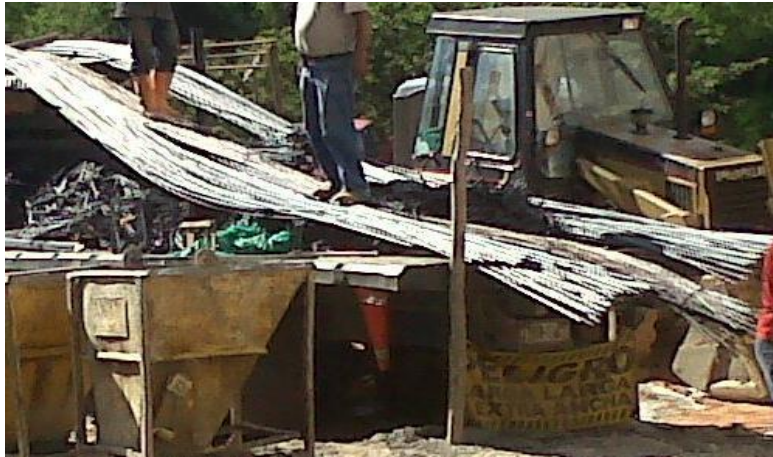
Figura 10, Aceros en obra, Fuente: El autor
