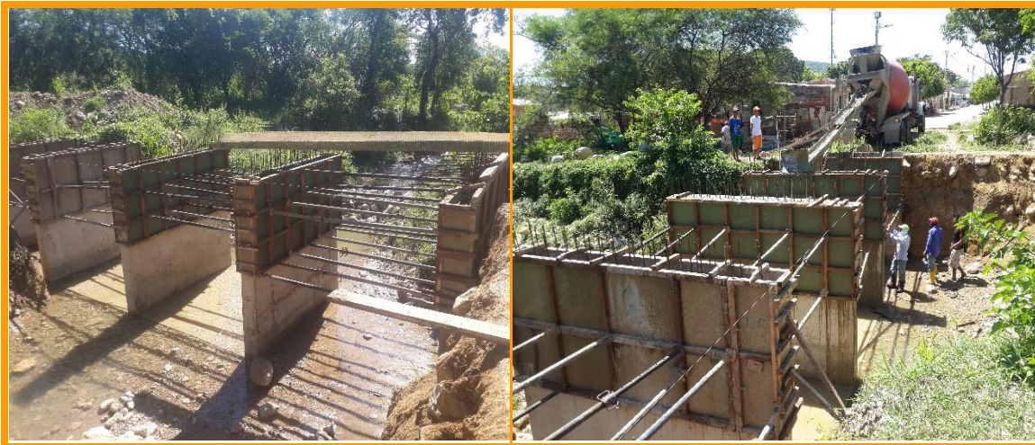
Figura 12 fundida de muros de soporte de puentes peatonales
