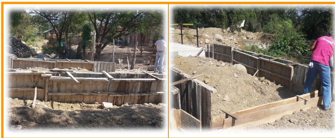
Figura 13. Fundición de muros de soporte de rampas.
