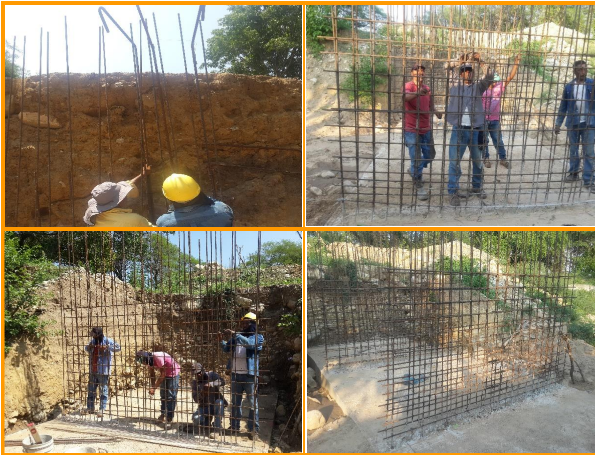
Figura 7 figurado y armado del hierro para muros de soporte del puente
