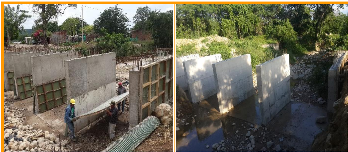
Figura 13 desencofrado de muros de soporte.
