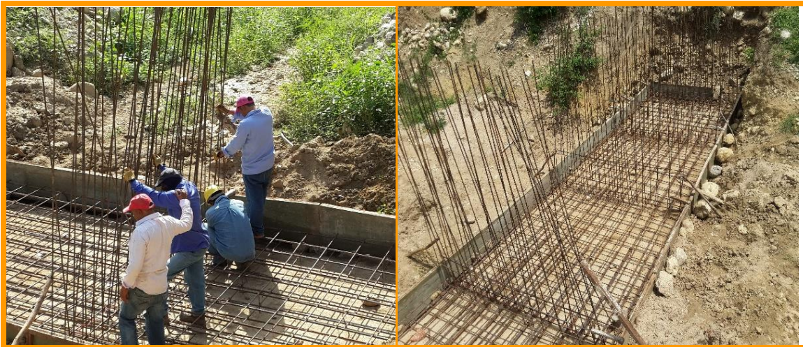
Figura 4 Armado y figurado del hierro para la base de puentes peatonales
