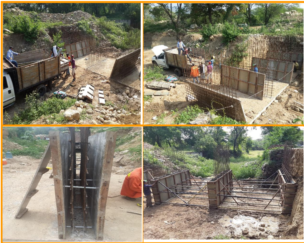
Figura 10 encofrado de muros primera sección.
