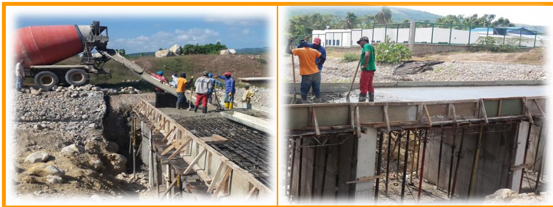
Figura 13. Fundición de placa superior.
