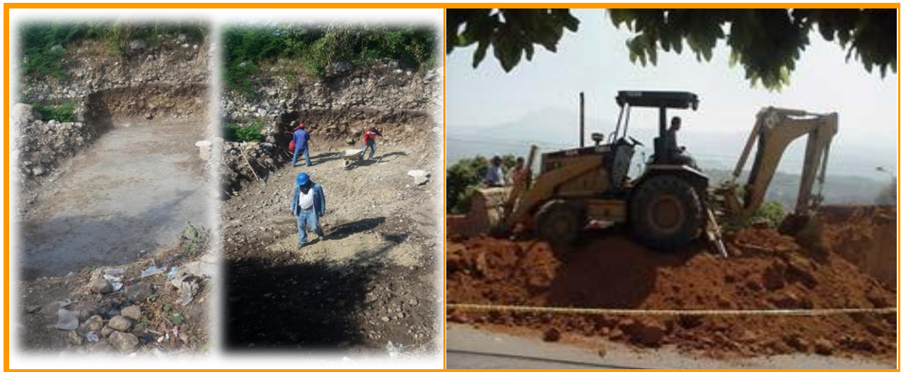
Figura 1 Trazado Nivelación, Replanteo Excavación para sondeos e instalación de tubería; Incluye: herramientas menores, equipos, maquinarias, derrumbe y mano de obra. Del puente que comunica Centro Zoonosis Con Casco Urbano
