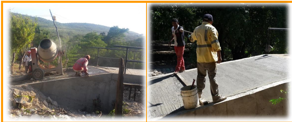
Figura 13. Fundición de plantilla de rampas.
