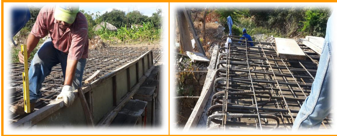
Figura 13 encofrado de placa de placa superior.
