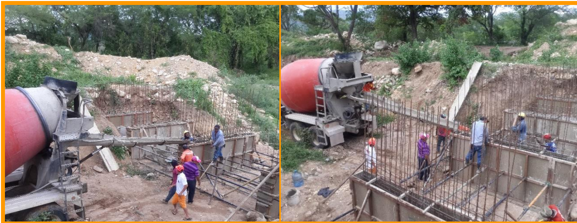
Figura 11 Fundición de columnas de la primera sección en concreto 3000psi del puente que comunica Casco Urbano Con Centro Zoonosis.
