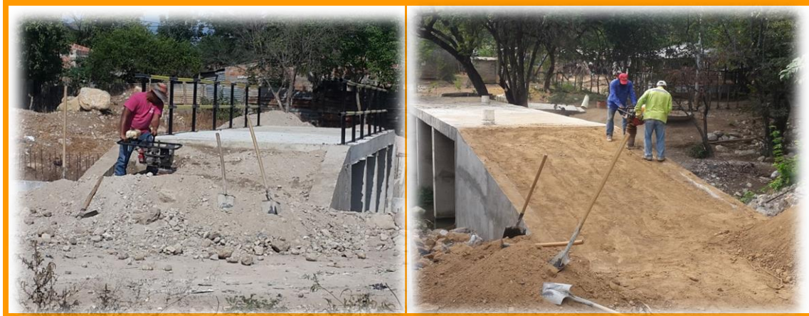
Figura 13. Relleno y compactación de material de relleno en rampas.
