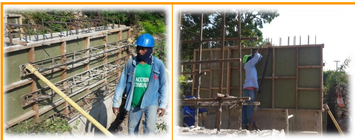
Figura 12 encofrado de muros segunda sección.
