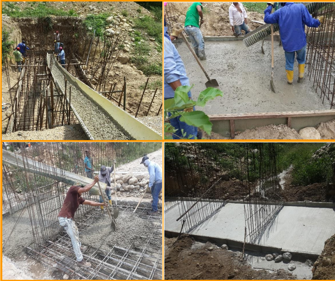
Figura 4. Fundida de placa inferior en concreto de 3000 psi
