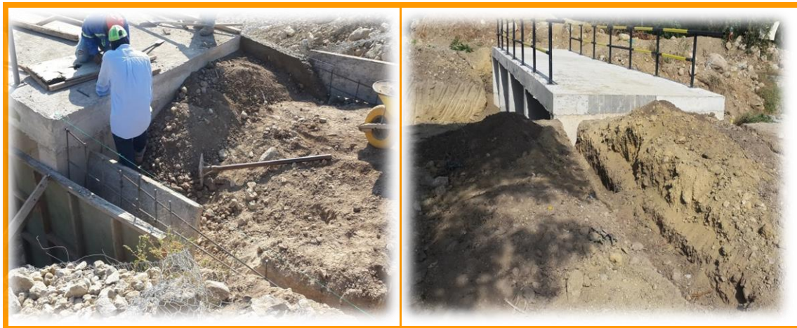
Figura 13. Excavación manual para fundición de cemento de soporte de rampas.
