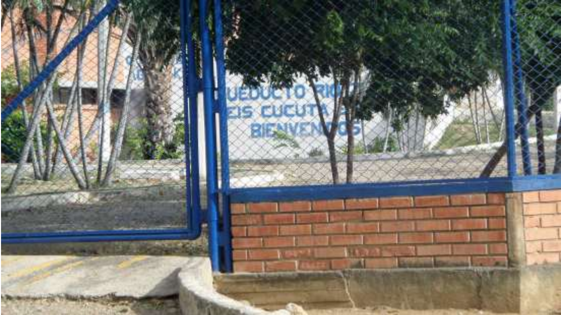
Anexo H. Fotos Planta aguas kapital ubicación Carmen de Tonchala
