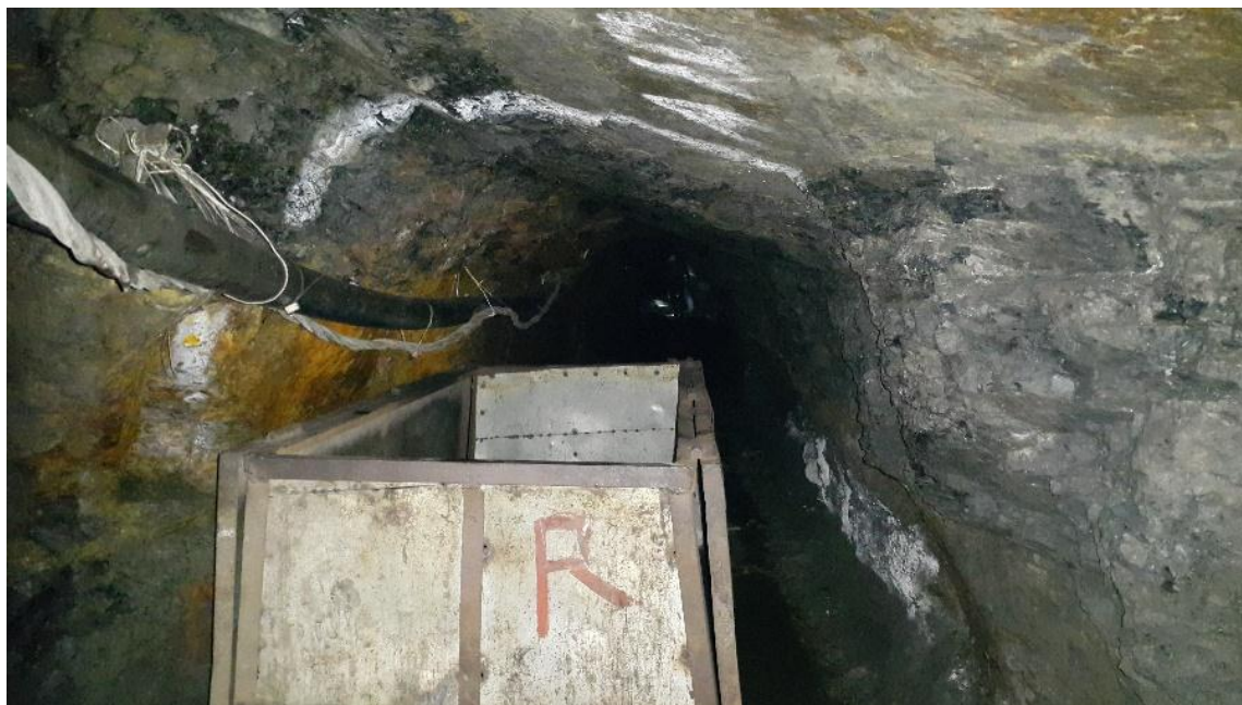
Figura 9-51 Vagón en el segundo tramo
