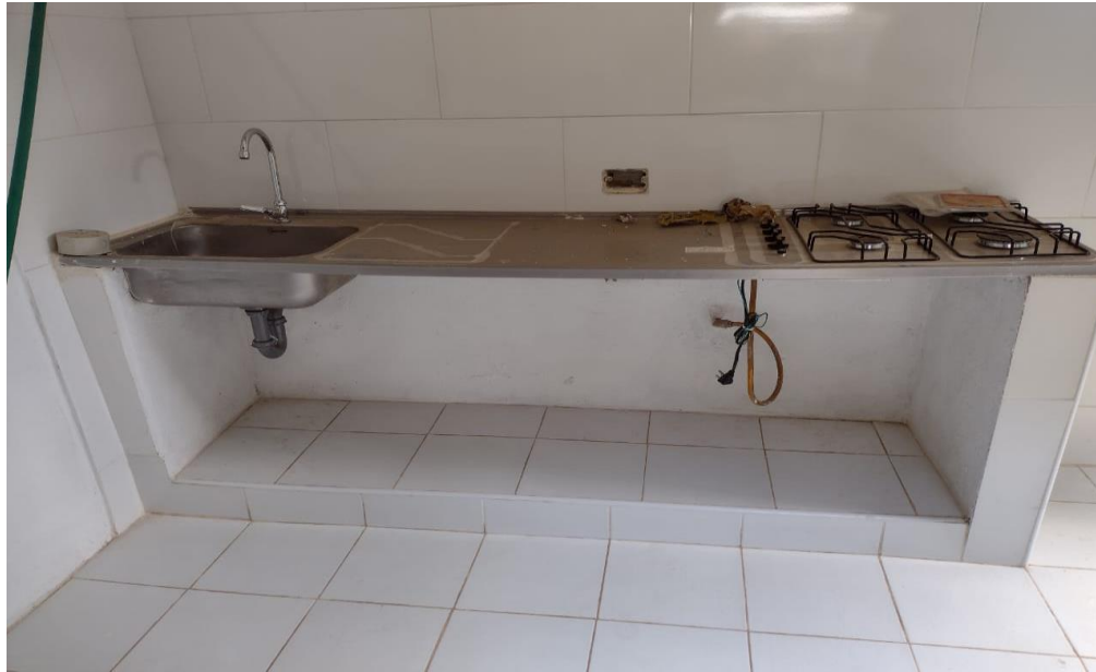
figura 15. Instalación de mesón con dimensiones 0.50 x 2.12 metros fuente: elaboración propia
