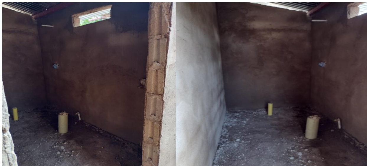
figura 16. Instalación de tubería sanitaria e hidráulicas fuente: elaboración propia
