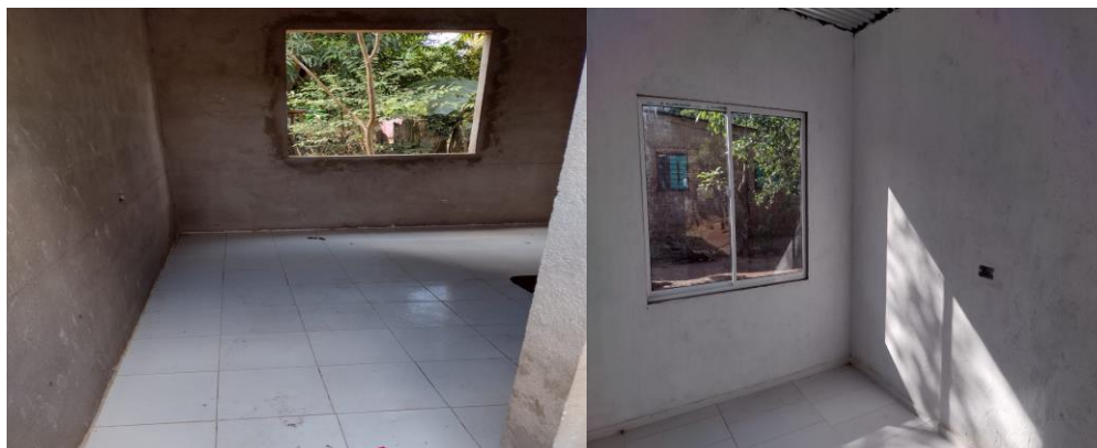
figura 12. Ventana 1.20 x1.20 he instalación fuente: elaboración propia
