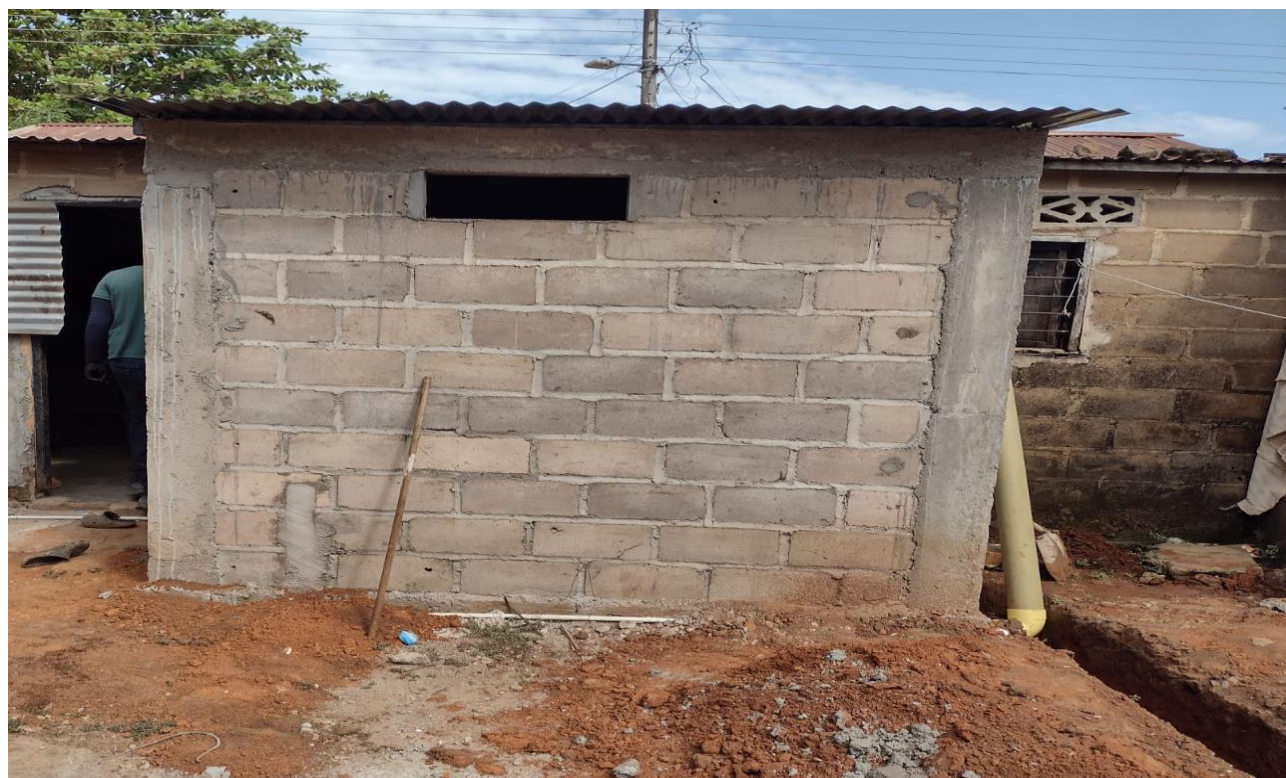
figura 9. Columneta a la vista concreto 3000psi fuente: elaboración propia
