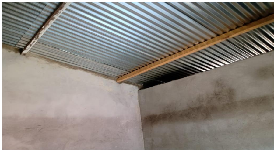
figura 20. Cambio de cubiertas fuente: elaboración propia
