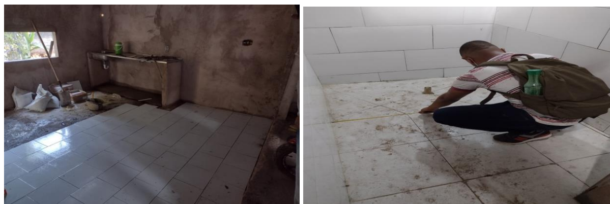
figura 18. Enchape de pisos 0.20x0.20 fuente: elaboración propia
