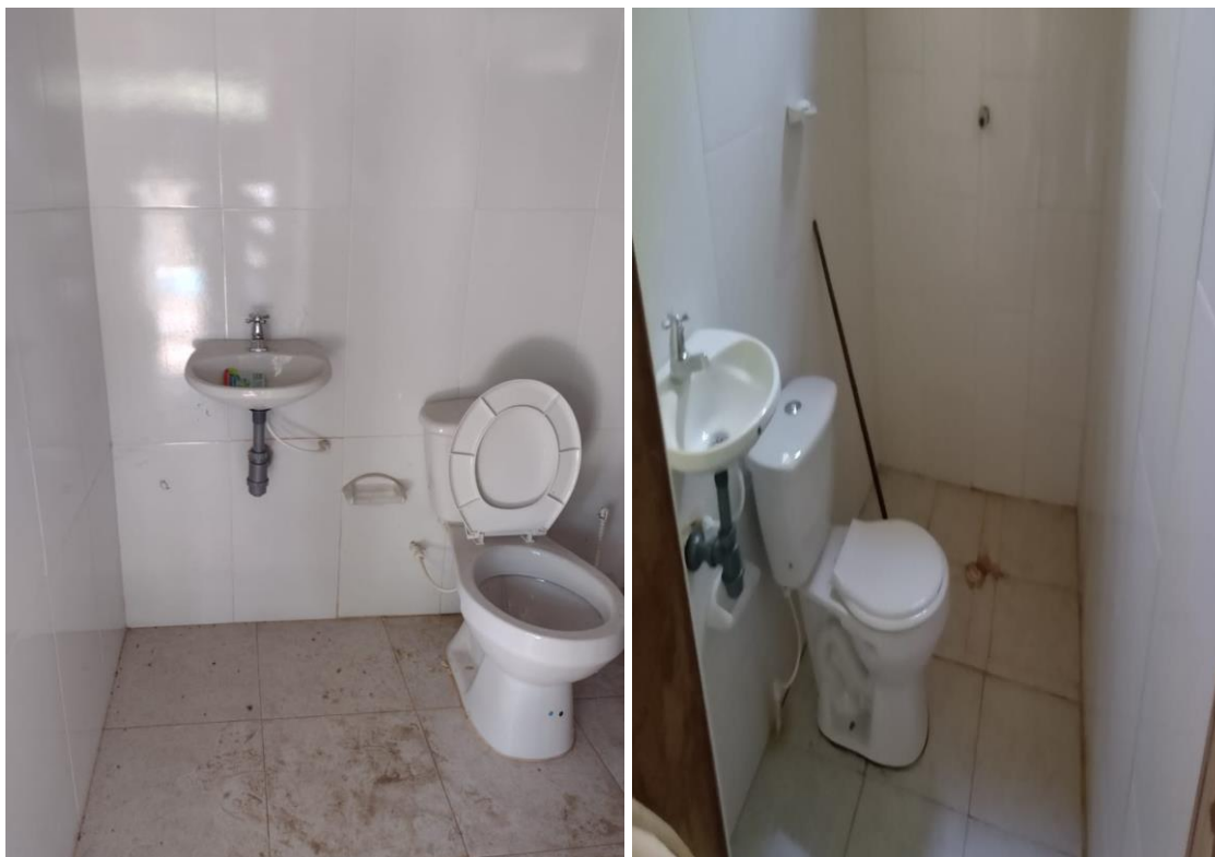
figura 14. Instalación de aparatos sanitario duchas y lavamanos fuente: elaboración propia
