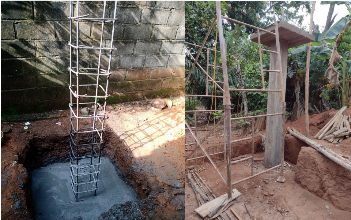
figura 8. Estructura y concreto de tanque elevado fuente: elaboración propia
