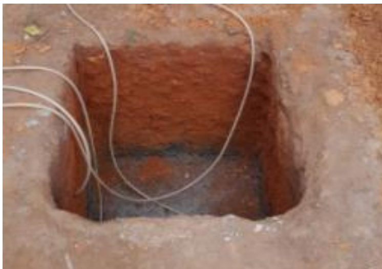
figura 6. Excavación manual fuente: elaboración propia
