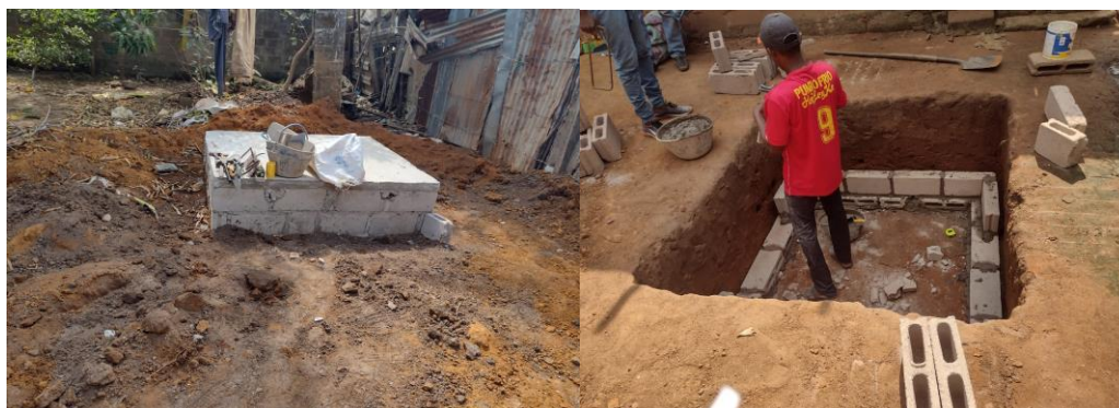
figura 21. Sistema séptico siendo anillado fuente: elaboración propia
