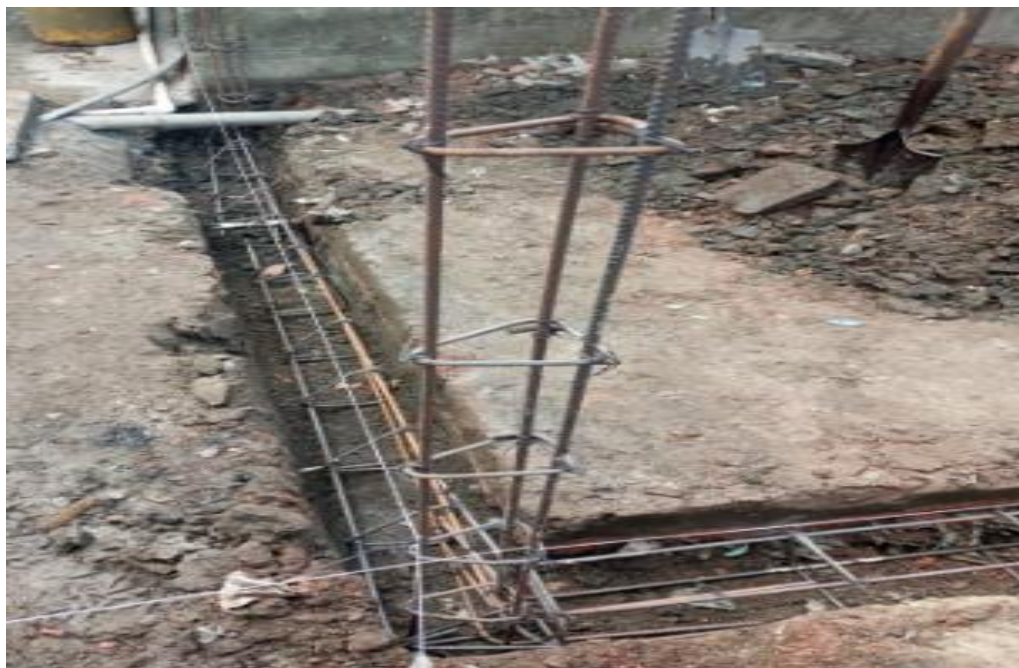
figura 7. Viga de cimentación fuente: elaboración propia
