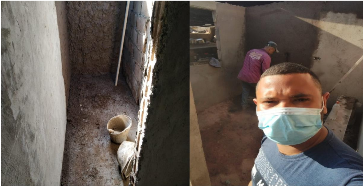
figura 11. Elaboración de pañete con motero 1:4 fuente: elaboración propia
