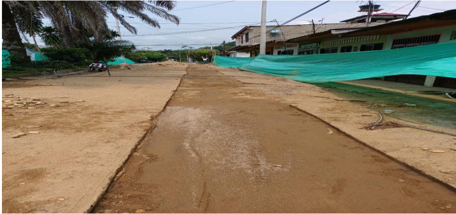
Ilustración 28. Limpieza y retiro de material sobrante en zona de trabajo Fuente: Propia
