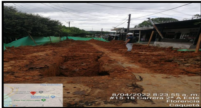
Ilustración 55. Suministro e instalación de tuberías de alcantarillado en PVC contrato 092 Fuente: Propia
