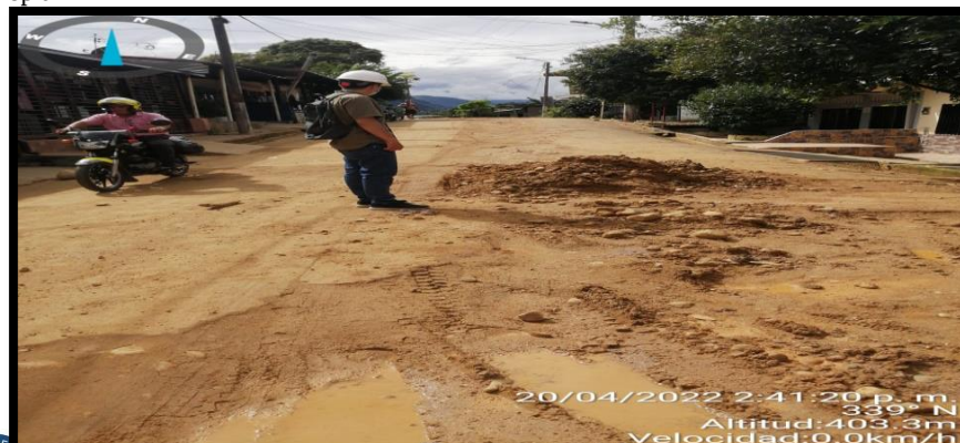
Ilustración 56. La terminación de las domiciliarias y red principal con retiro de escombros contrato 092 Fuente: Propia
