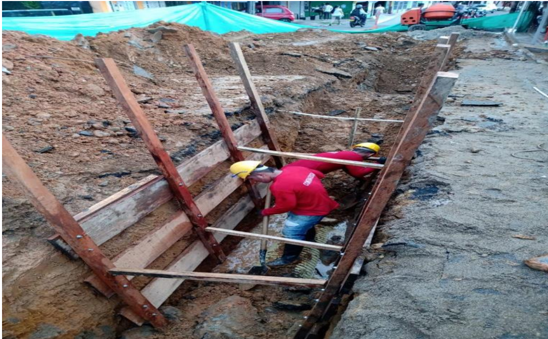
Ilustración 12. Entibado continuo en madera Fuente: Propia
