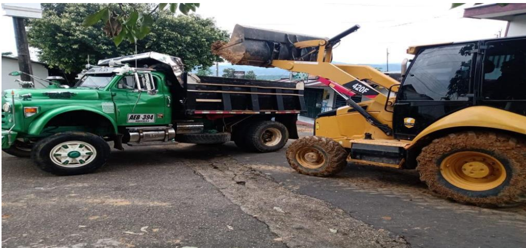
Ilustración 10. Cargue y retiro de material sobrante por excavación mecánica Fuente: Propia
