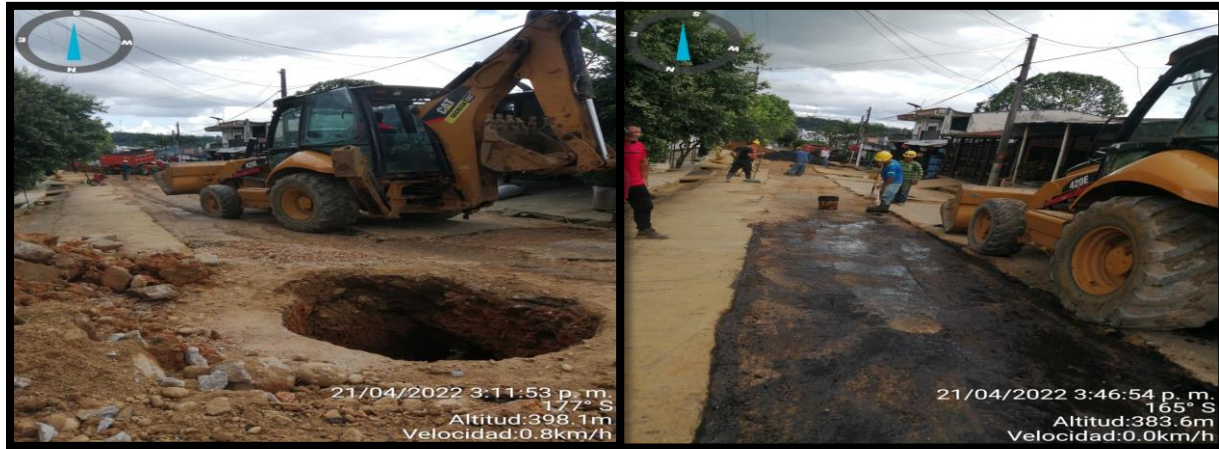
Ilustración 57. Suministro e instalación de emulsión asfáltica contrato 092
