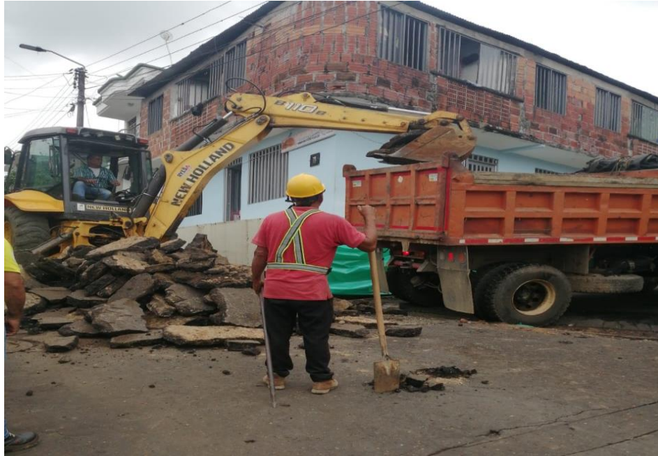
Ilustración 8. Cargue de material sobrante de la demolición de pavimento Fuente: Propia
