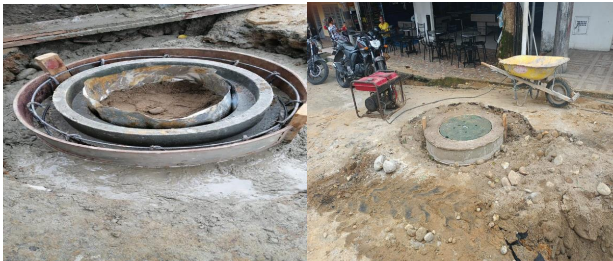
Ilustración 16. Construcción de sección superior de pozo
