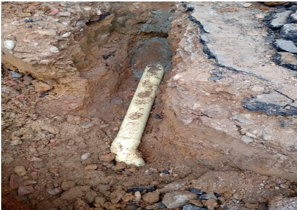
Ilustración 18. Instalación acometida domiciliaria
