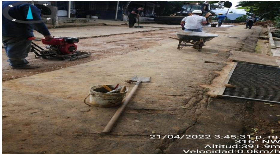
Ilustración 22. Relleno con material granular y compactación Fuente: Propia
