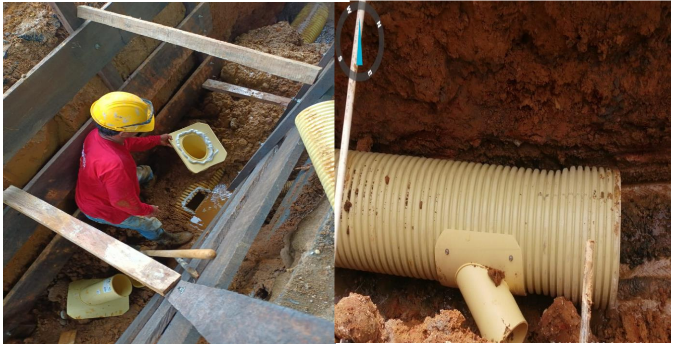
Ilustración 19. Suministro e instalación de Silla Yee para tubería de 6"
