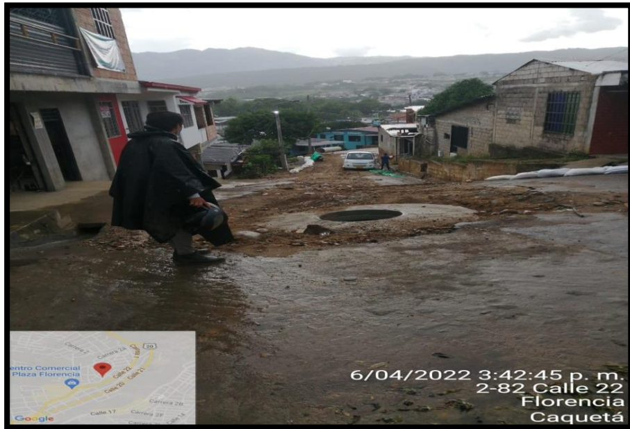
Ilustración 44. Pozo de inspección sin tapa ni señalización contrato 072
