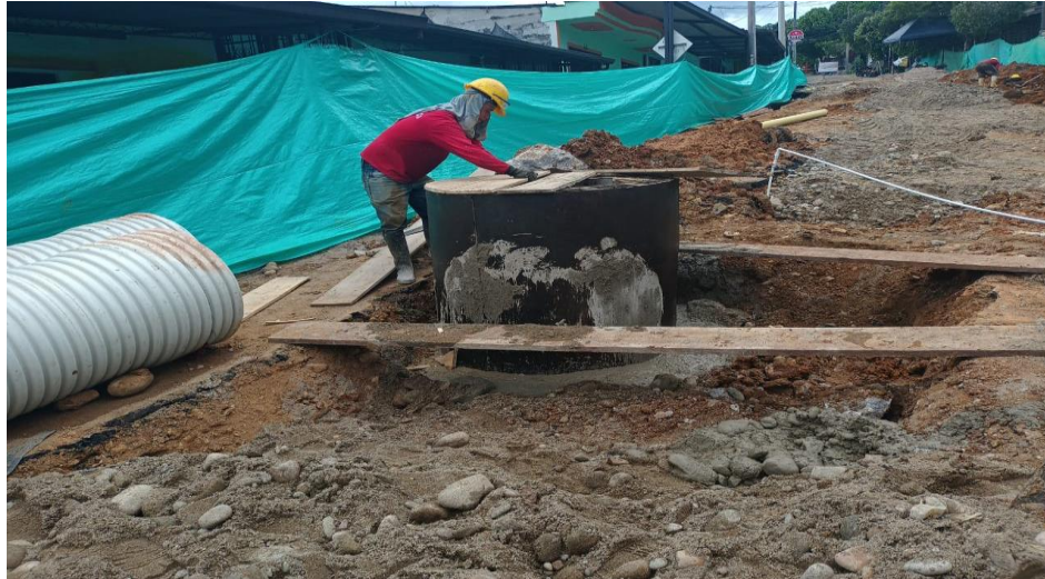
Ilustración 15. Fundación de cilindro de pozo con formaleta metálica
