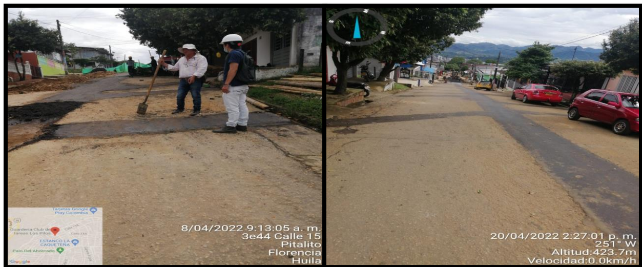
Ilustración 40. Suministro de emulsión asfáltica y de pavimento tipo 2 en el contrato 071
