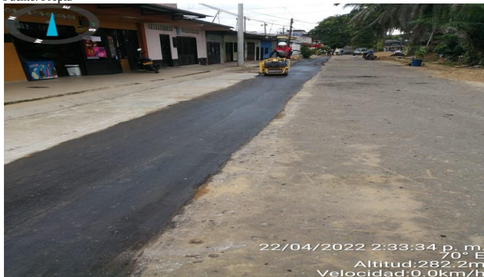
Ilustración 24. Instalación de pavimento flexible tipo 2. e = 0.1m
