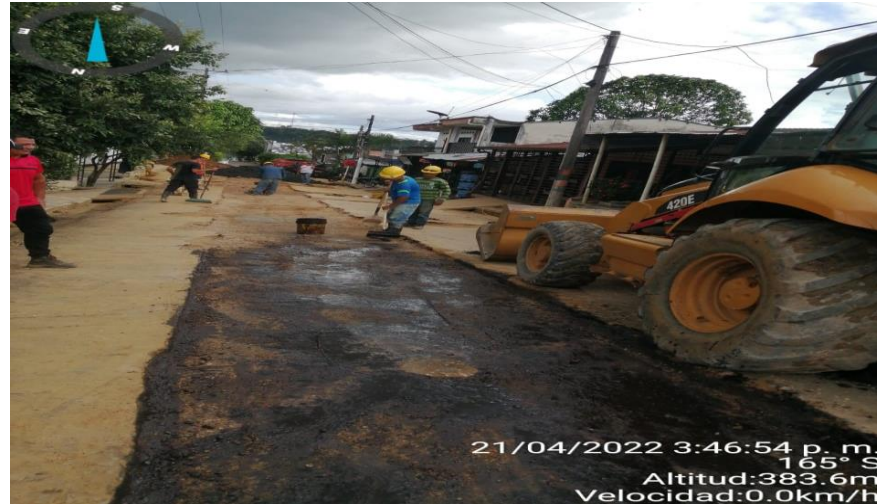
Ilustración 23. Instalación de emulsión asfáltica
