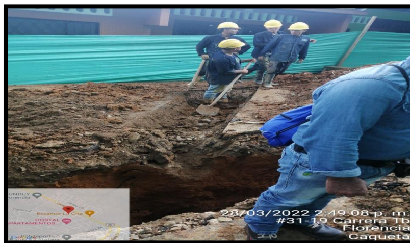
Ilustración 50. Excavación manual para domiciliarias contrato 091
