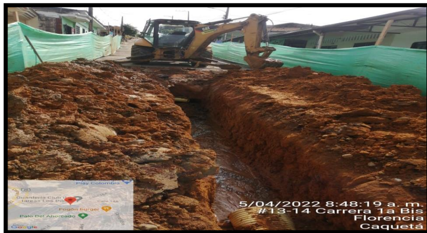
Ilustración 59. Suministro e instalación de tuberías de alcantarillado en PVC contrato 093 Fuente: Propia
