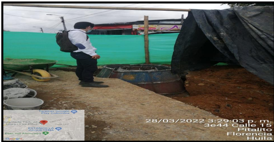
Ilustración 38. Fundición de cilindro de pozo contrato 071 Fuente: Propia
