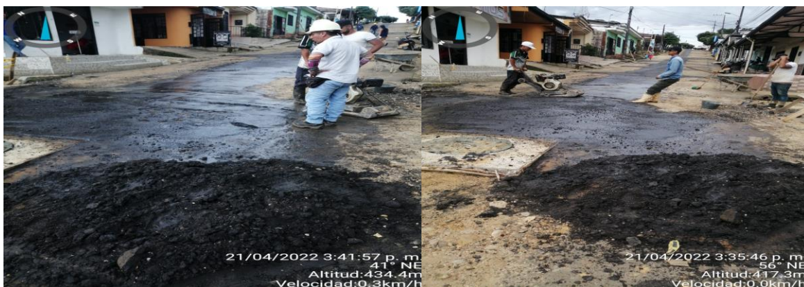
Ilustración 60. Suministro e instalación de emulsión asfáltica con pavimento tipo dos contrato 093 Fuente: Propia
