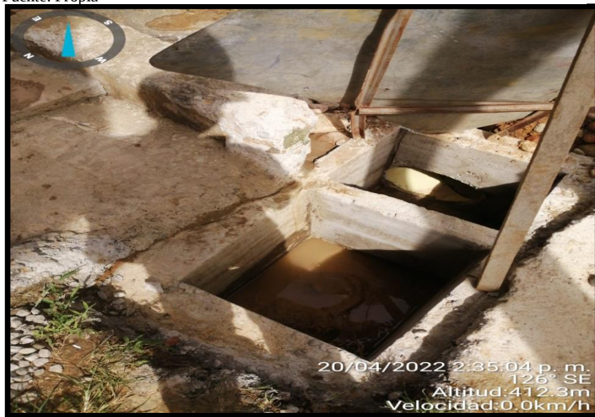
Ilustración 61. Realización de la instalación de tubería de 6" a sumidero contrato 093 Fuente: Propia
