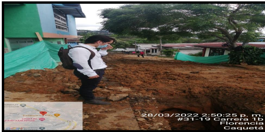
Ilustración 47. Suministro e instalación de tuberías de alcantarillado en PVC contrato 091 Fuente: Propia
