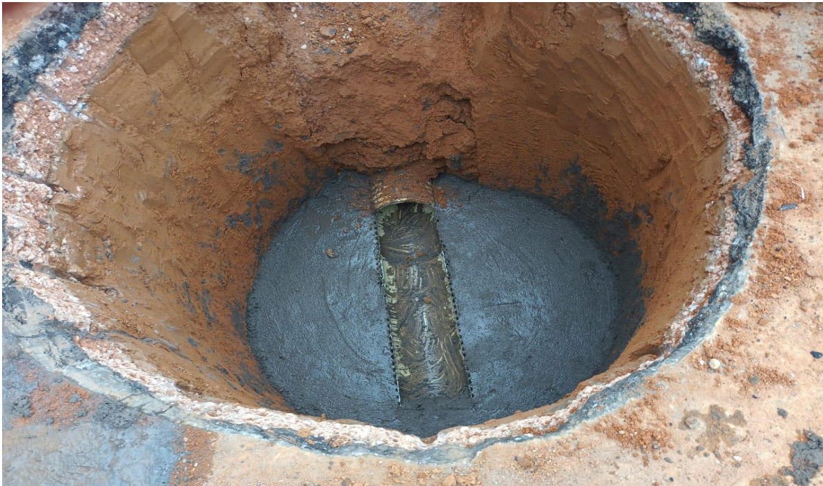
Ilustración 14. Placa de pozo y cañuela
