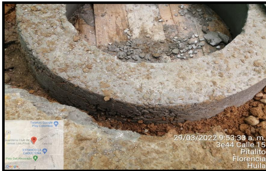
Ilustración 39. Porosidad en pozo por falta de vibrado contrato 071
