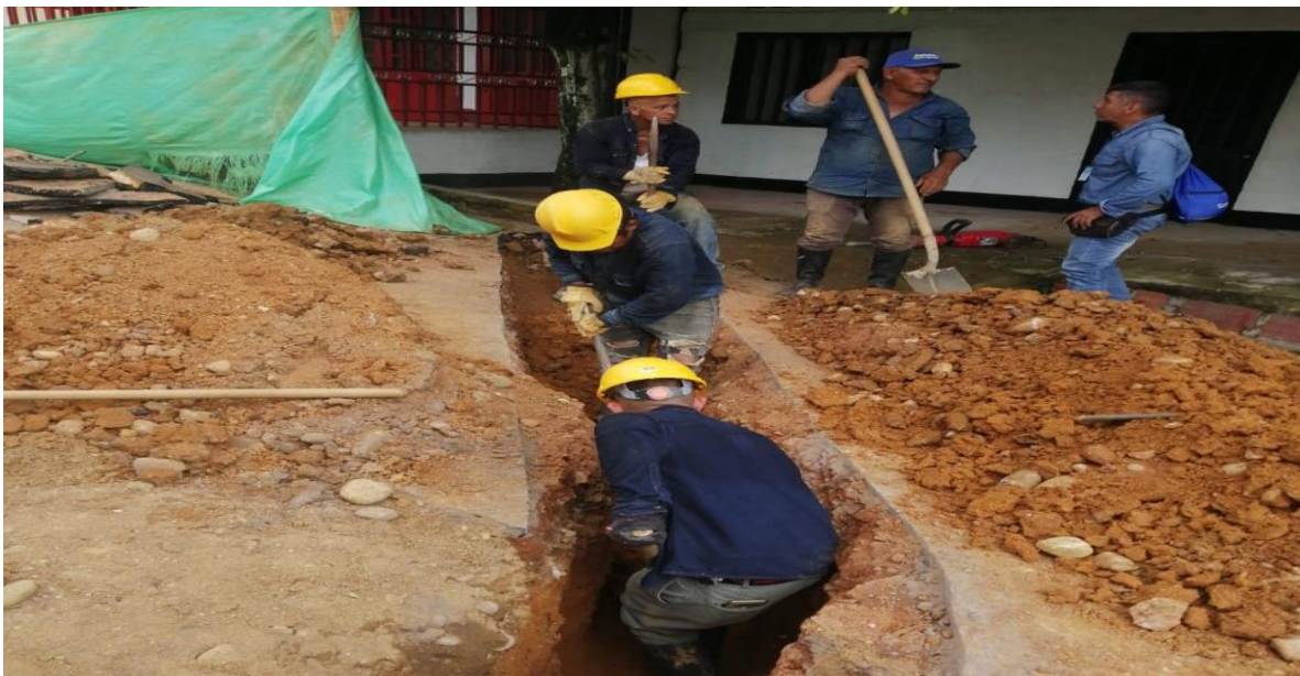
Ilustración 11. Excavación manual para domiciliarias
