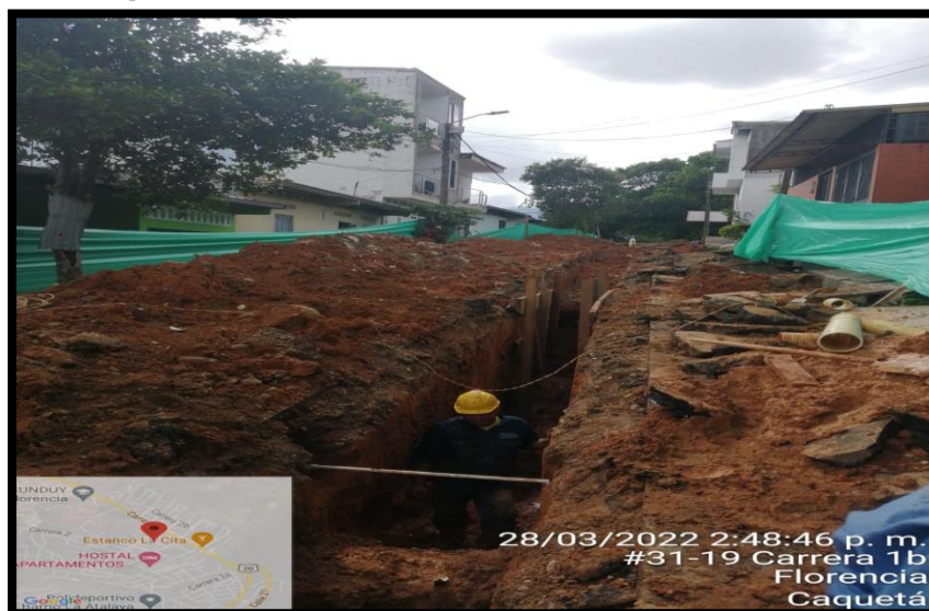
Ilustración 49. Mal uso de entibado contrato 091
