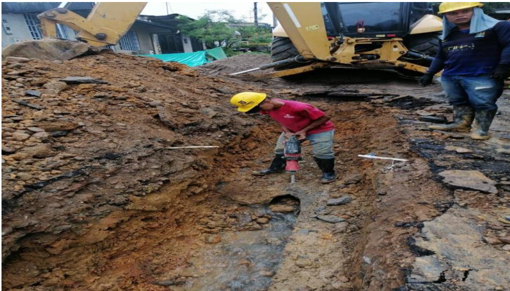
Ilustración 9. Excavación mecánica de la red principal de alcantarillado Fuente: Propia
