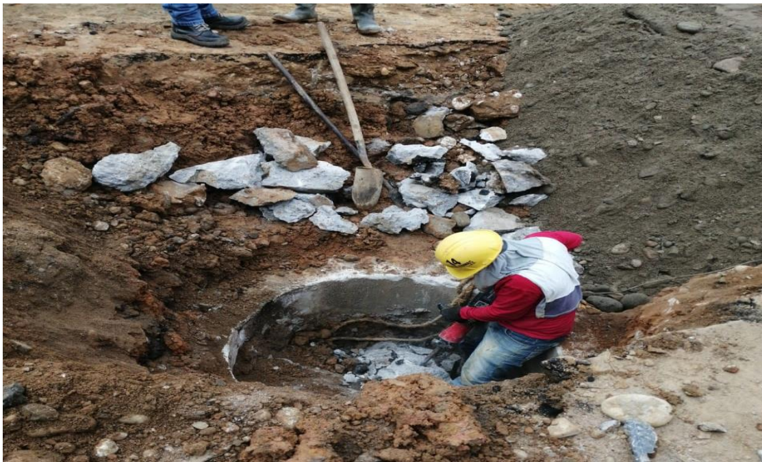
Ilustración 13. Demolición de pozo de inspección Fuente: Propia
