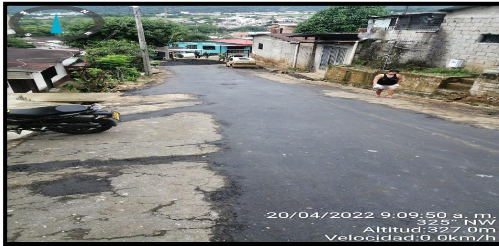
Ilustración 45. Suministro de emulsión asfáltica y de pavimento tipo 2 en el contrato 072 Fuente: Propia
