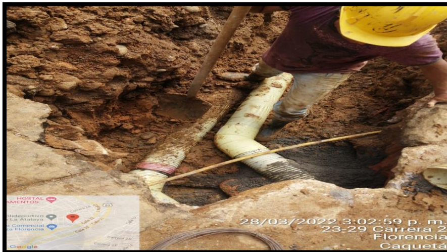
Ilustración 43. Instalación de Silla Y para tubería de 36" e instalación de codo de 45° contrato 072
