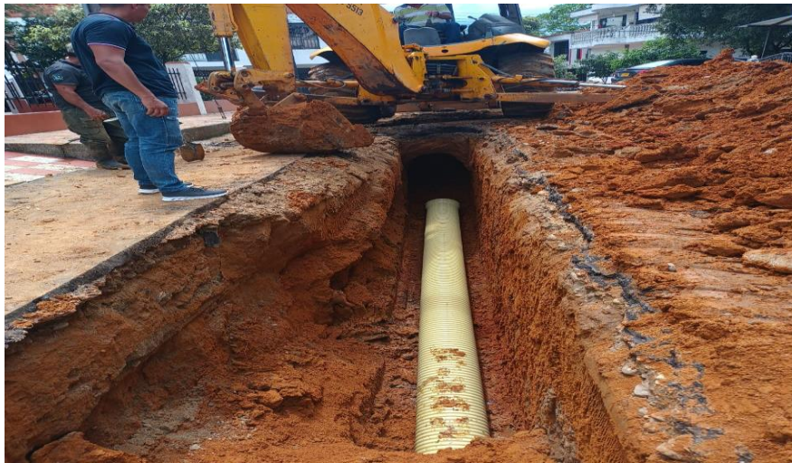
Ilustración 17. Instalación de tubería de alcantarillado en PVC
