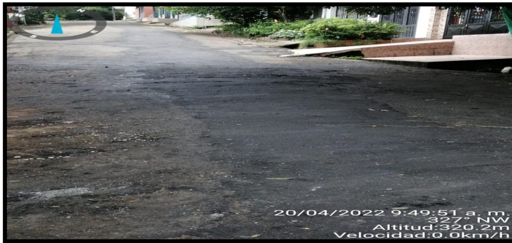
Ilustración 53. Finalización de suministro e instalación de emulsión asfáltica con pavimento tipo dos contrato 091 Fuente: Propia
