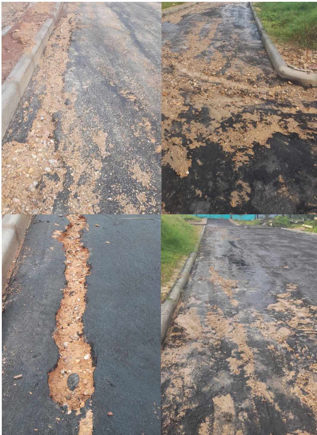
Figura 27. Daños en el proceso de imprimación provocados por lluvias.
