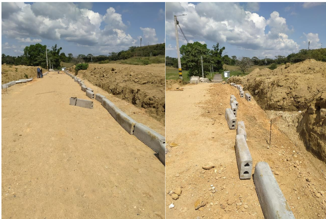
Figura 17. Ubicación de sardinel y adecuación de terreno.
