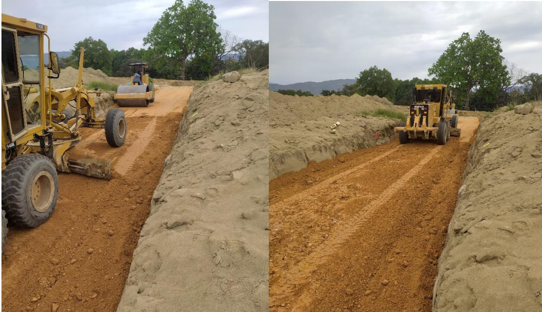
Figura 12. Extendido de material con motoniveladora.
