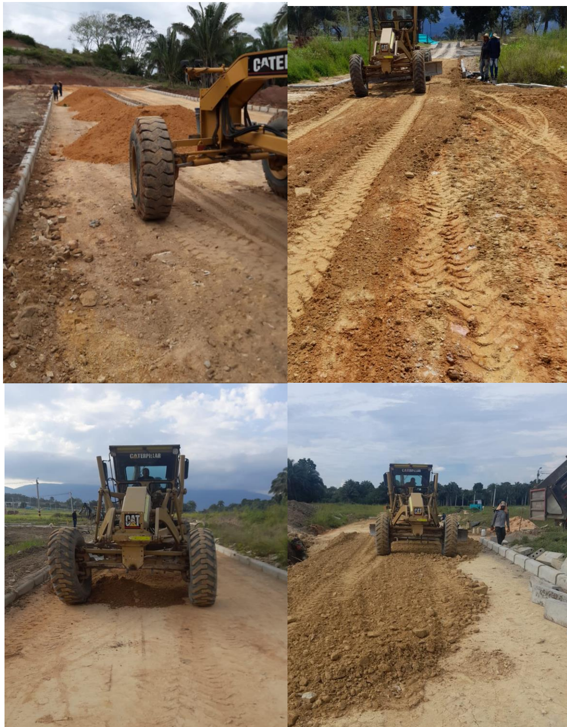
Figura 22 .Extendido de material base por motoniveladora.
