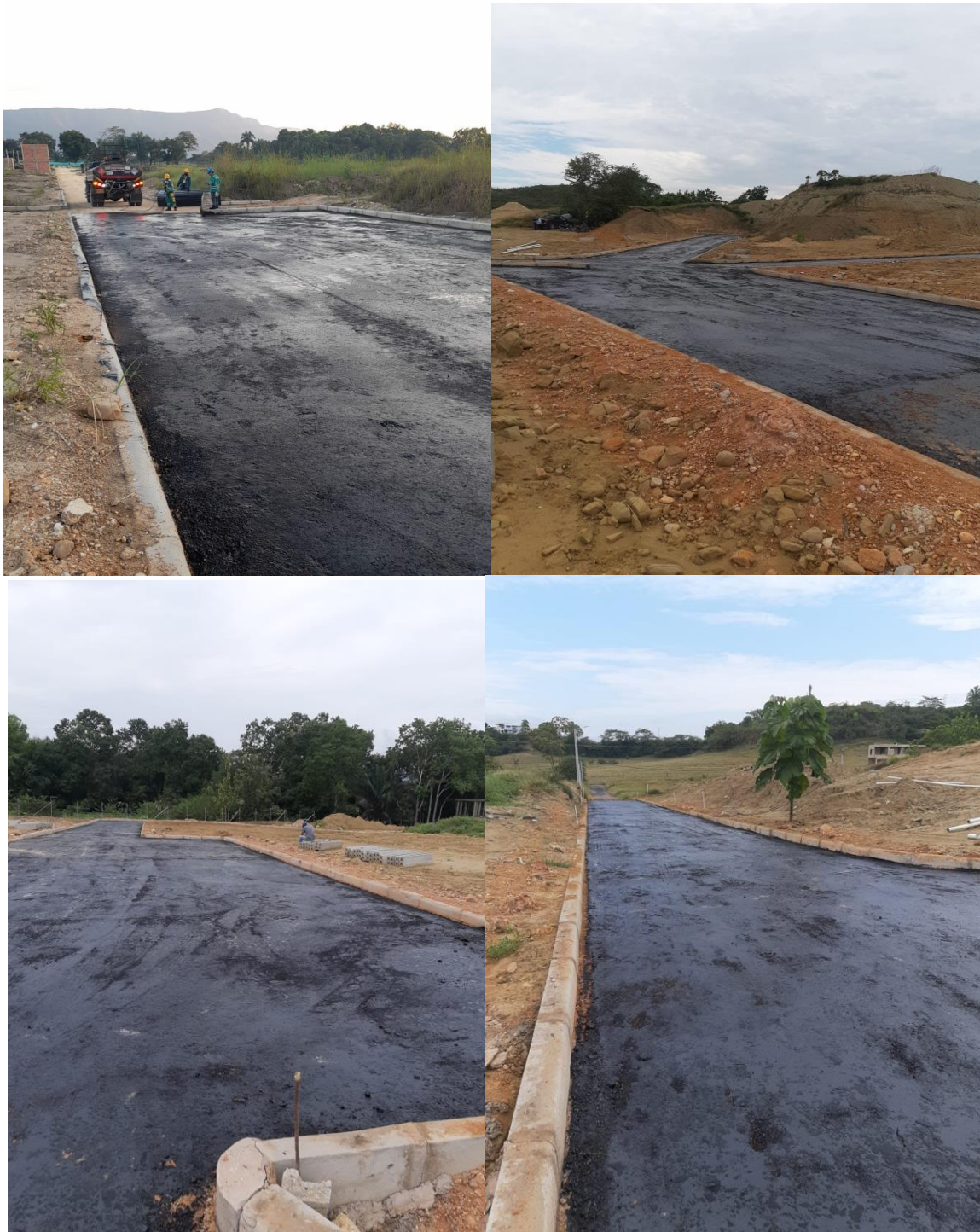
Figura 26. Proceso de riego de imprimación.
