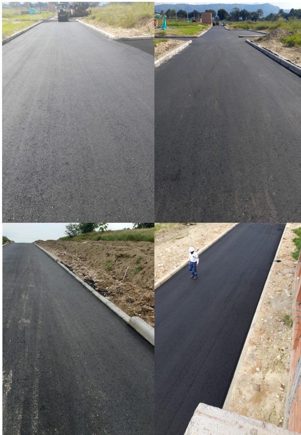
Figura 31. Estado final de carpeta asfáltica.
