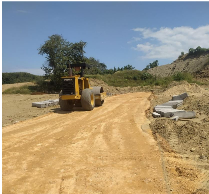
Figura 13. Vibrado y sellado de material correspondiente a capa base.
