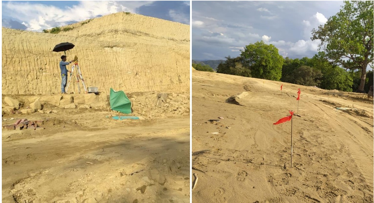
Figura 7. Localización y replanteo de vías con topografía.
