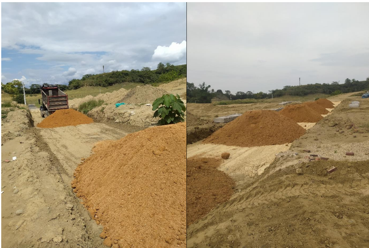
Figura 11. Disposición de material para capa sub-base en campo.
