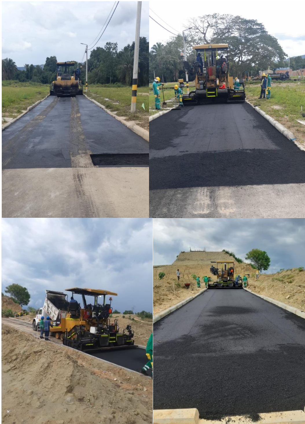
Figura 29. Inicio de instalación de carpeta asfáltica con finisher.
