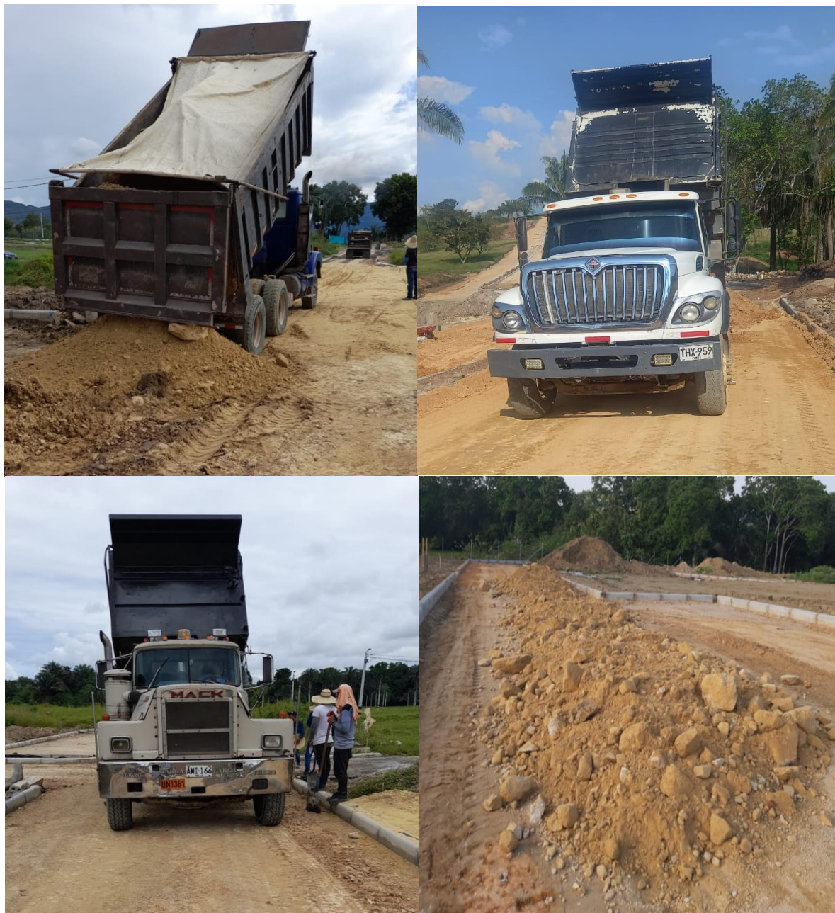
Figura 21. Disposición de material de capa base en obra.
