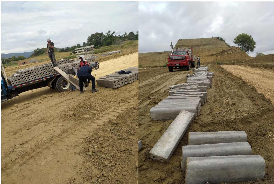
Figura 16. Traslado de bordillo a obra.
