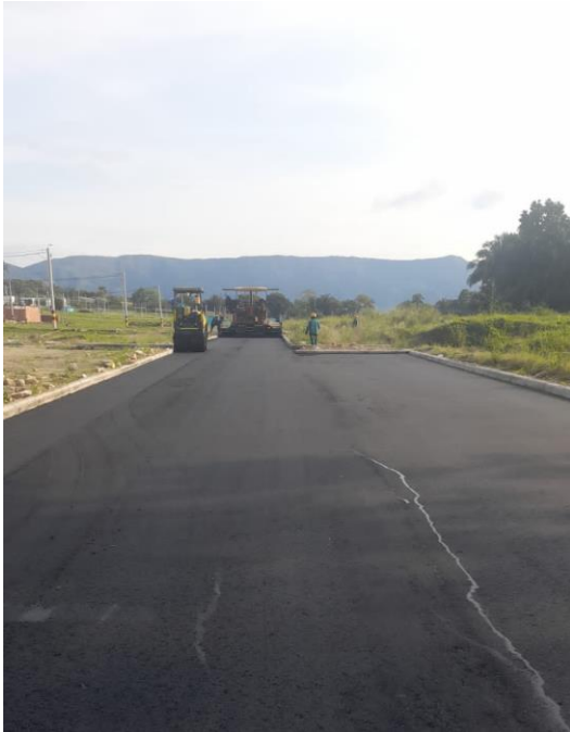
Figura 30. Sellado de carpeta asfáltica con vibro compactador doble.
