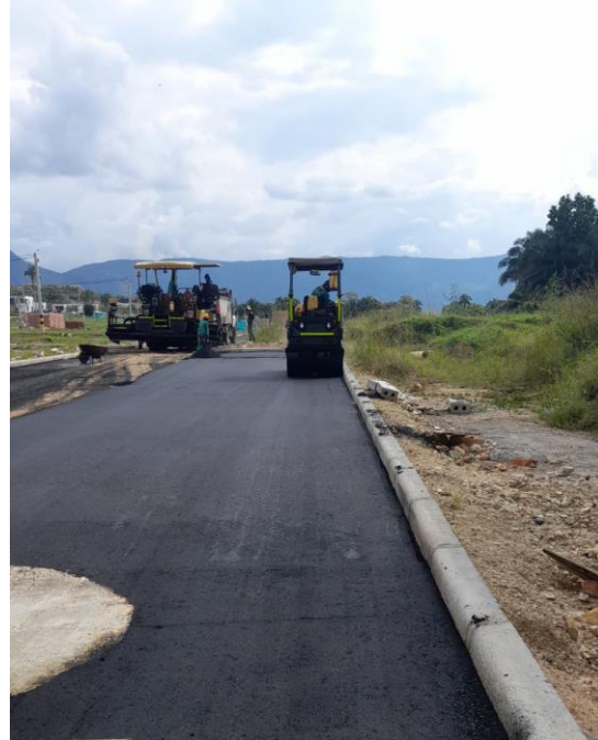
Figura 30. Sellado de carpeta asfáltica con vibro compactador doble.
