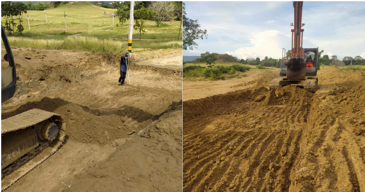
Figura 9. Excavación o cajeo de vías.
