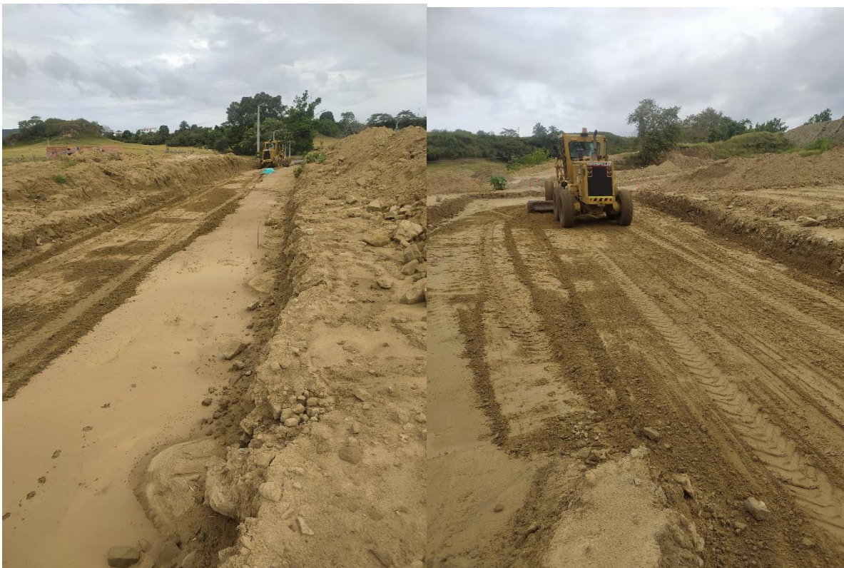
Figura 15. Restauración de capas afectadas por lluvias.
