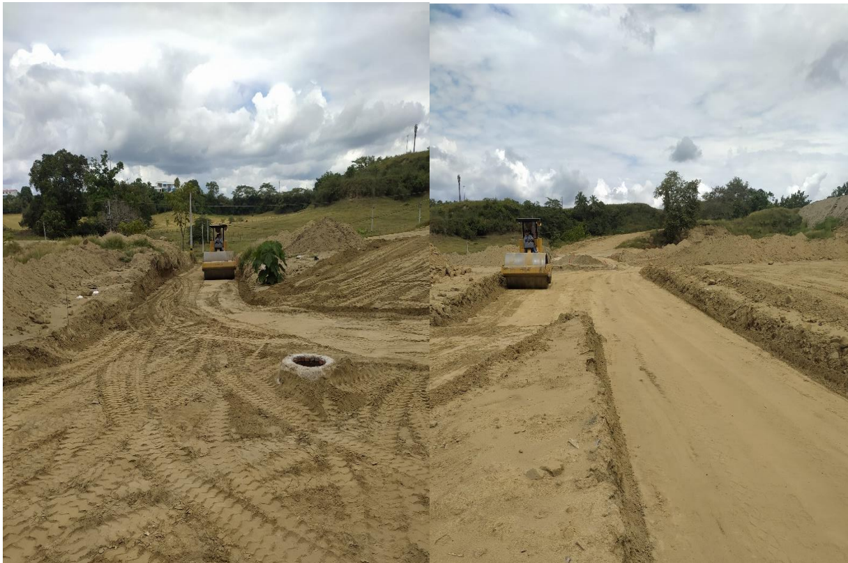
Figura 10. Vibrado y sellado de capa inicial.
