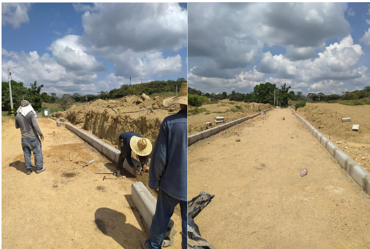
Figura 18. Instalación de sardinel.
