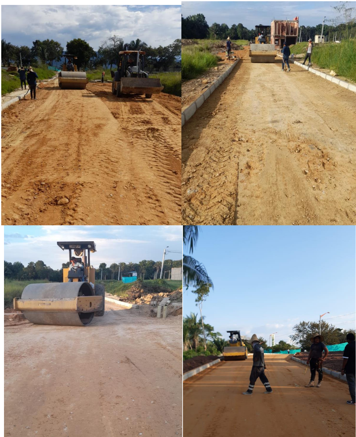
Figura 23. Compactado y sellado de material base por vibro compactador.
