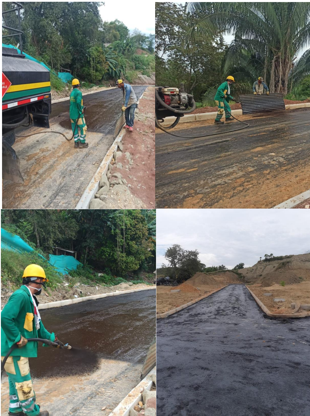
Figura 28. Restauración y recuperación de riego de imprimación.
