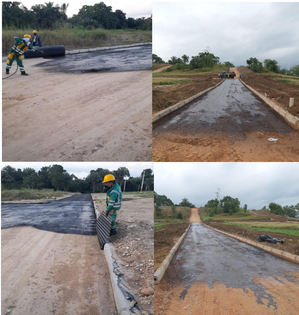
Figura 25. Inicio aplicación riego de imprimación.
