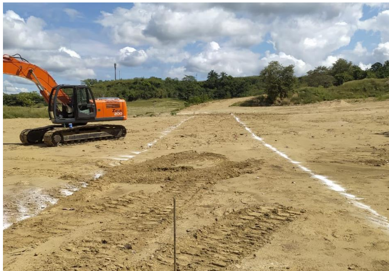
Figura 8. Demarcación de vías con cal.
