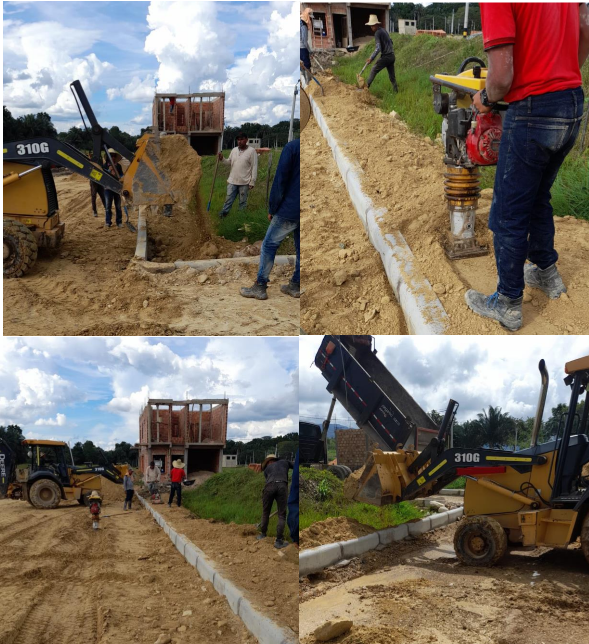
Figura 20. Atracado y compactado para sardinel.
