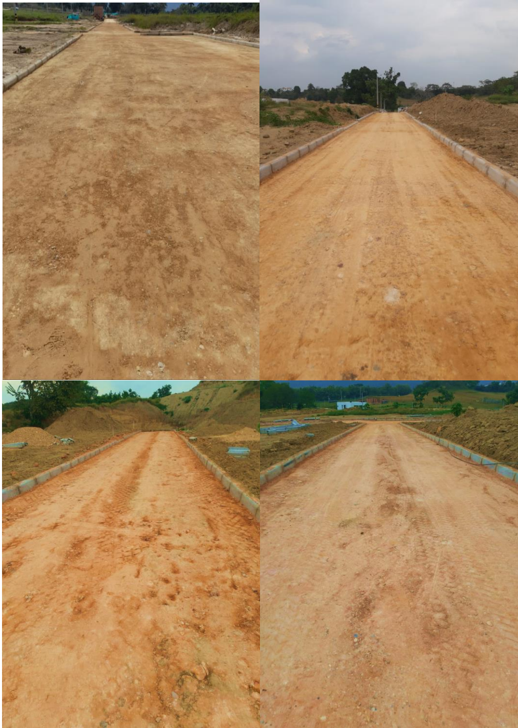
Figura 24. Capa de material base óptima.
