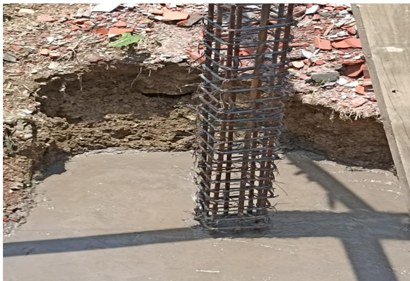
Ilustración 59 Avance 10 al 16-abril Informe semanal VALDIVIA
