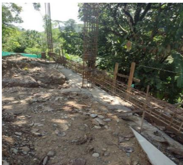
Ilustración 69 Avance 22 al 29-abril Villa Marina Vigas de amarre
