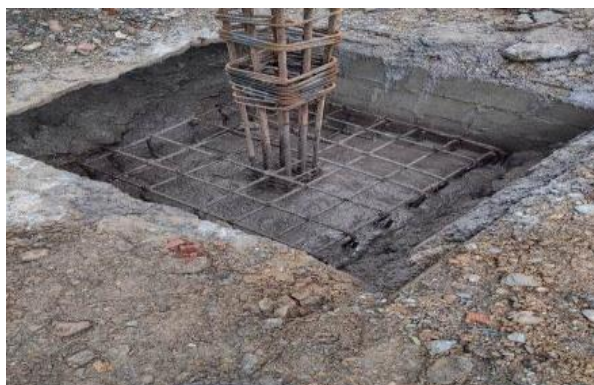
Ilustración 64 Estado 17 al 22-abril – Armado de la zapata
