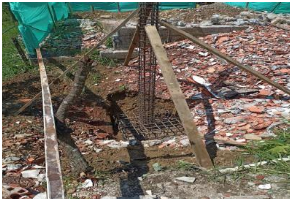
Ilustración 37 Avance de obra 27 al 02 Figurado de acero
