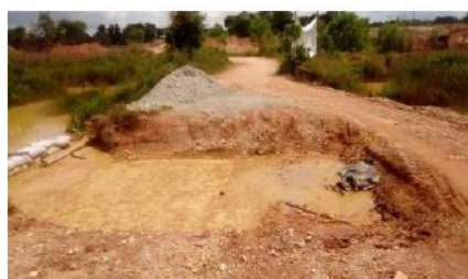
Ilustración 12 Estado de la obra el día 8 de marzo, obra sin cerramiento provisional.
