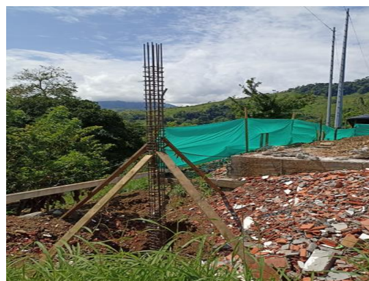
Ilustración 50 Avance de obra - preparación de columnas para formatear y fundir
