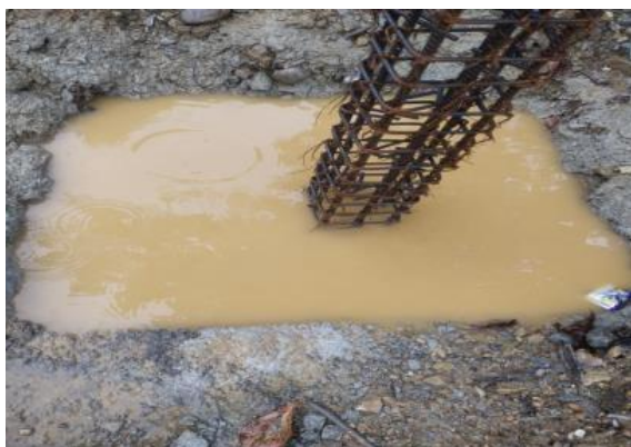
Ilustración 63 Avance 17 al 22-abril – Inconvenientes por lluvias
