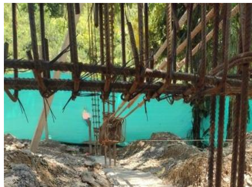
Ilustración 88 Avance de obra 21 de mayo CER Villa Marina – vigas de amarre
