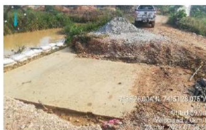
Ilustración 13 Estado de la obra el día 23 de marzo, no ha habido avance.
