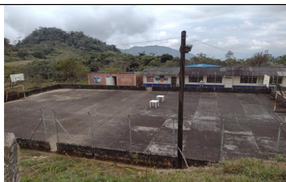
Ilustración 28 Placa deportiva estado antes de intervenir
