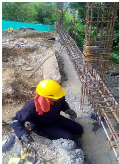
Ilustración 87 Avance de obra 21 de mayo CER Villa Marina
