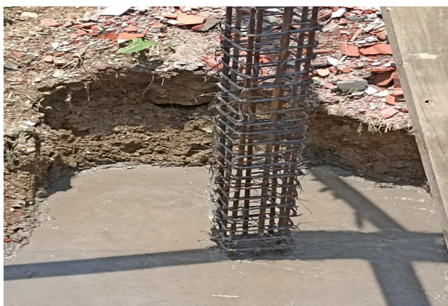
Ilustración 49 Avance de obra fundición de zapatas
