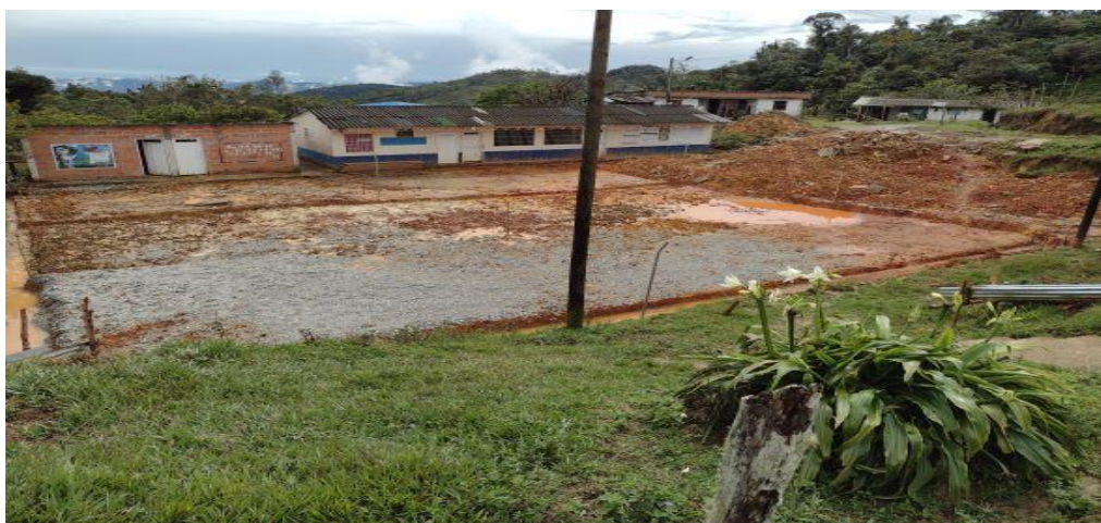
Ilustración 53 Avance 03 al 09-abril Informe semanal VALDIVIA
