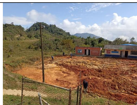
Ilustración 29 Placa deportiva estado después de intervenir
