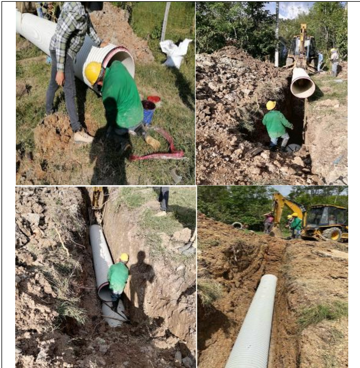
Ilustración 34, Instalación de la tubería de 24"
