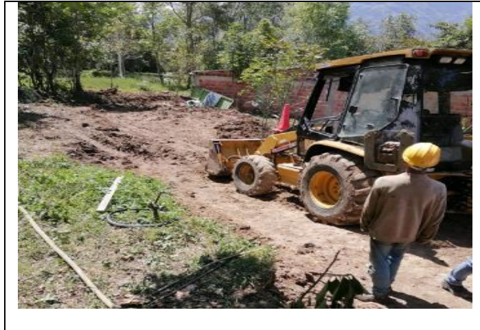
Ilustración 32, Nivelación del terreno
