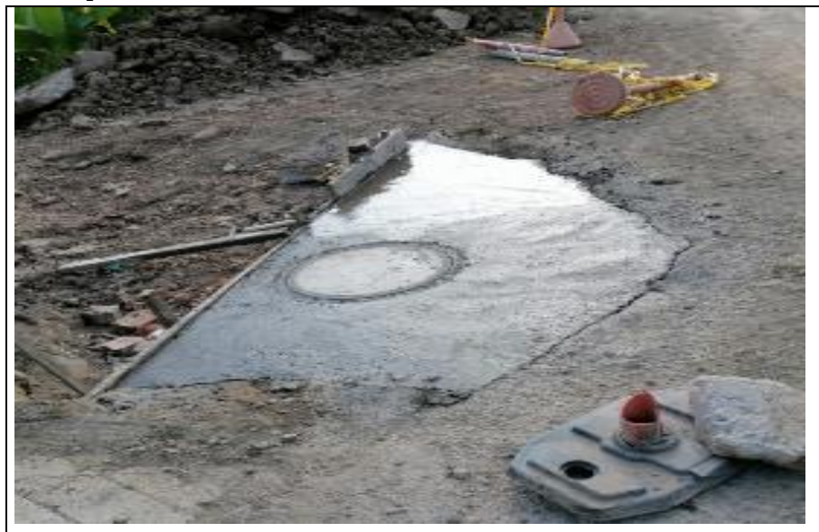
Ilustración 38, Reposición de las losas de concreto
