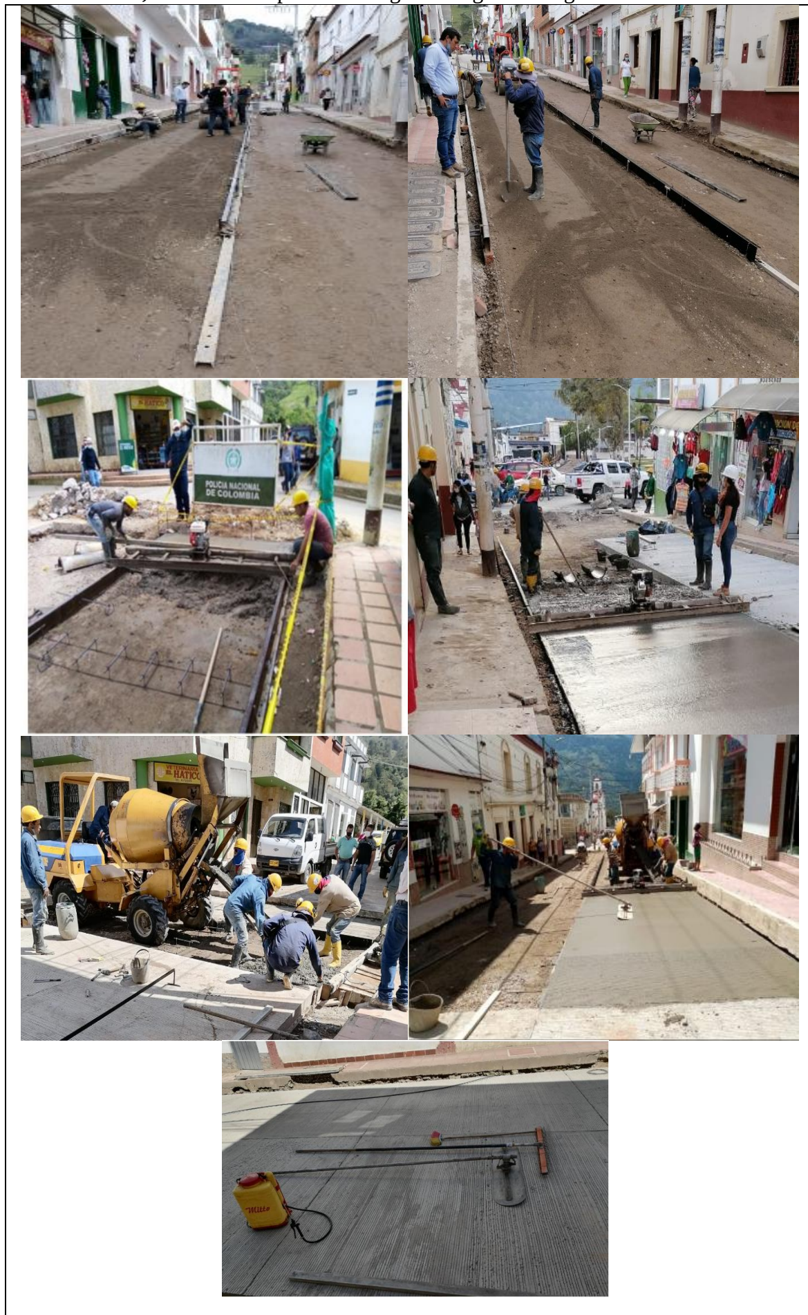
Ilustración 12, Construcción pavimento rígido - Registro fotografico
