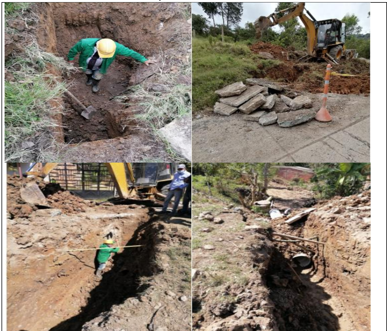
Ilustración 33, Excavacion mecánica y manual
