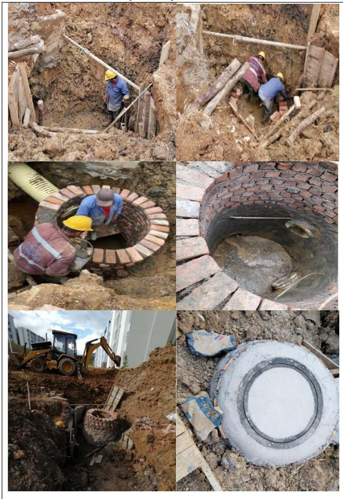
Ilustración 25, Construcción del pozo de inspección
