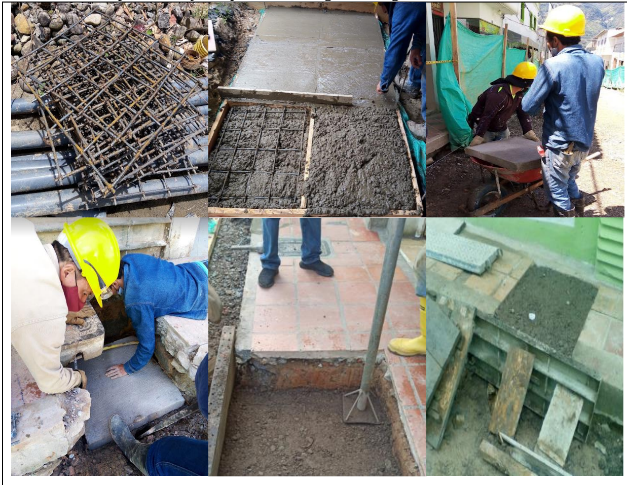
Ilustración 8, Tapa, relleno y compactación - Registro fotográfico
