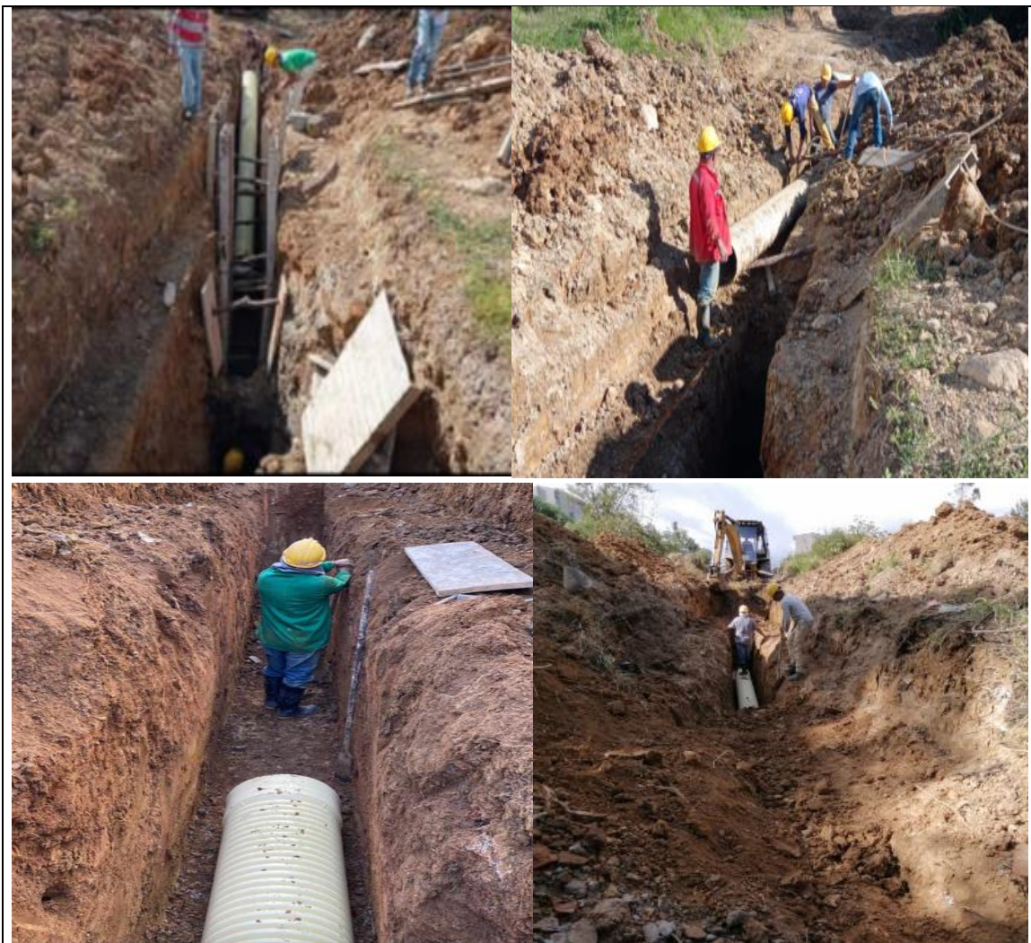
Ilustración 24, instalación de la tubería más colchón de arena
