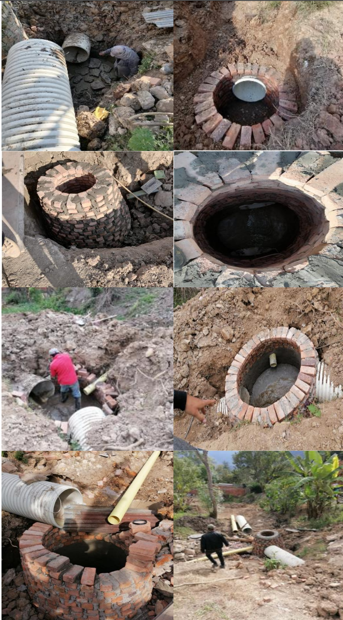
Ilustración 36, Construcción de pozos de inspeccion
