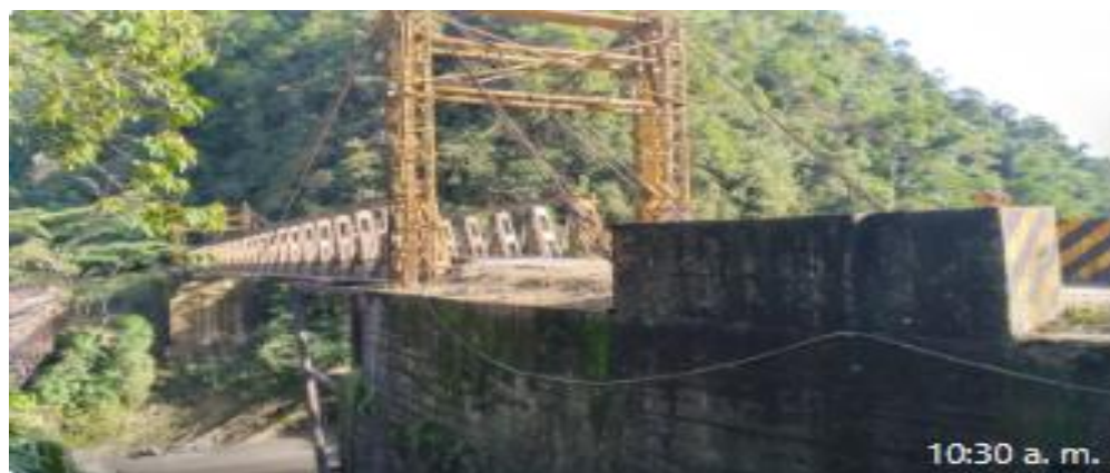
Figura 1: Fotografía de estructura existente
