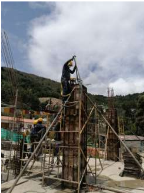
Figura 35. Colocación de la mezcla
