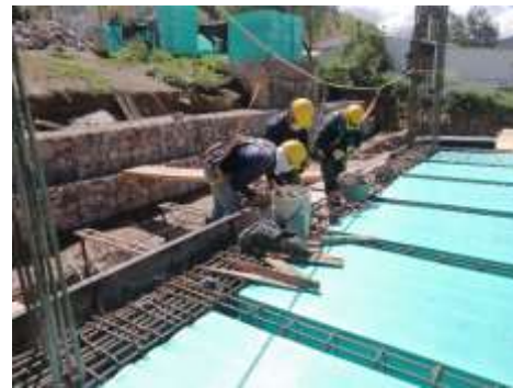
Figura 36. Preparación para colocación
