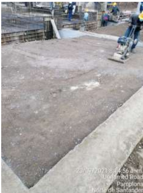
Figura 13. Visualización de compactado
