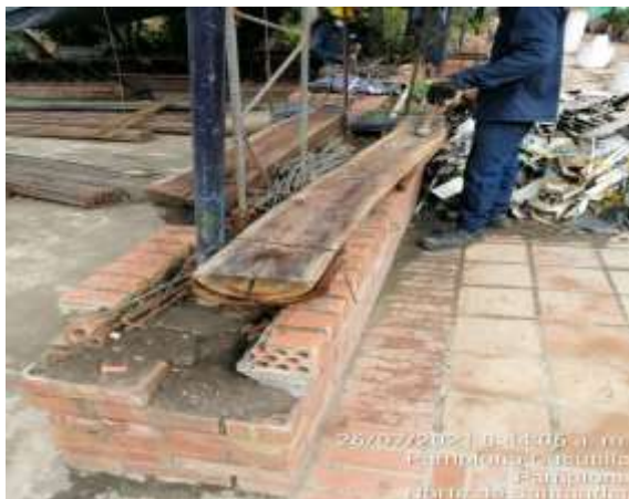
Figura 24. Figurado de acero
