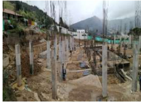
Figura 12. Visualización de columnas y mechas
