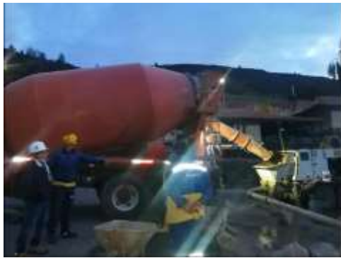
Figura 35. Colocación de la mezcla
