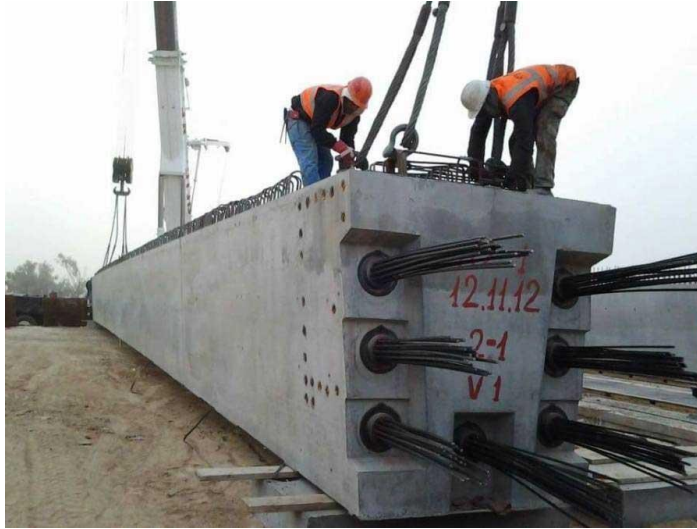
Ilustración 6 Concreto postensado (Promallas, 2020)
