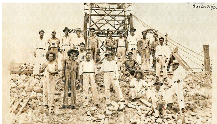
6. Trabajadores en la Construcción del puente Mariano Ospina
