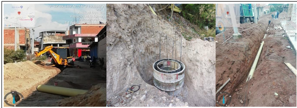
Ilustración 37:Evidencia alcantarillado urbano
