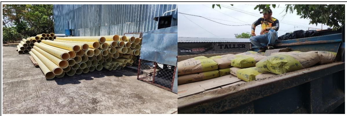
Ilustración 39: Suministro de material
