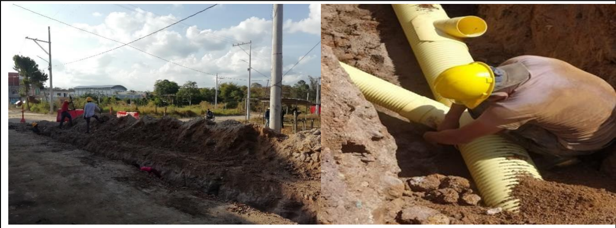
Ilustración 18: Dotación normas de seguridad
