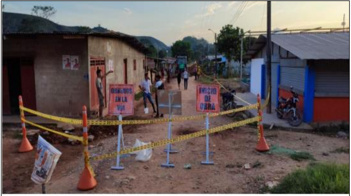
Nota: Señalización dentro de la obra. Fuente: Propia (2022)
