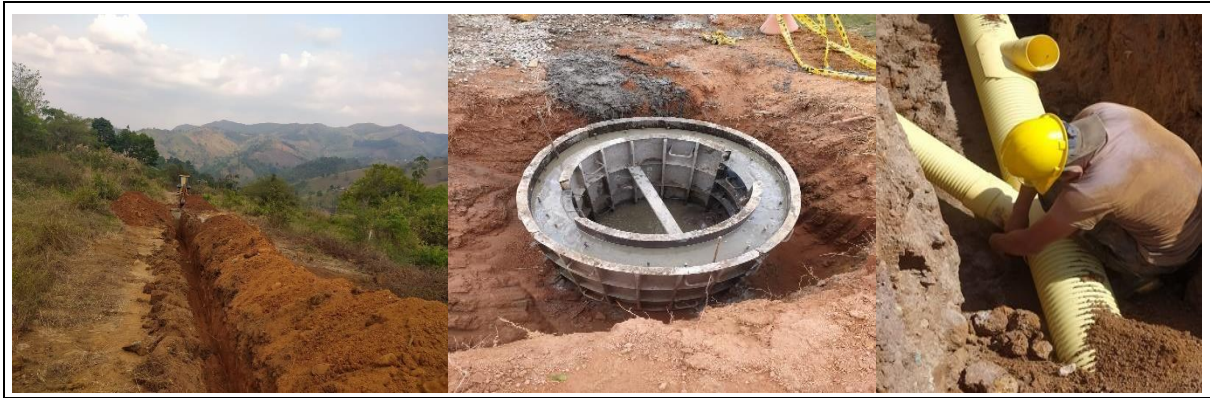
Ilustración 38: Evidencias alcantarillado rural
