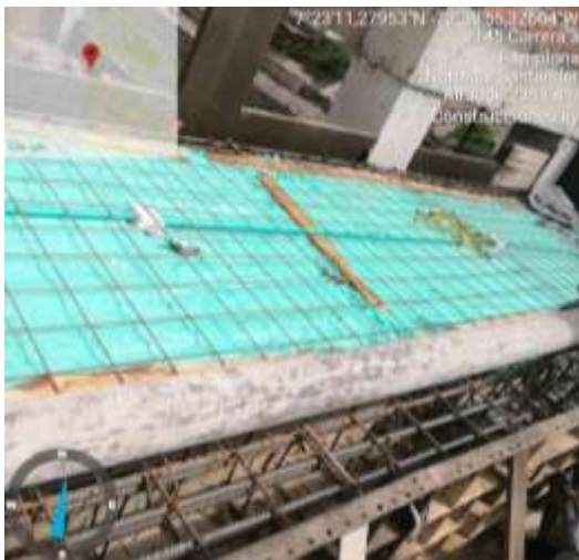
fotografía 20 Preparación para la colocación.
