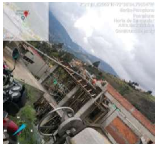
fotografía 18 Preparación para la colocación.
