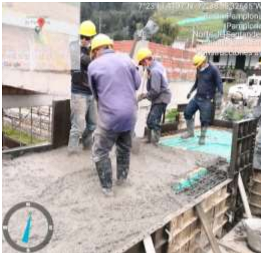
fotografía 27 Colocación de la mezcla.
