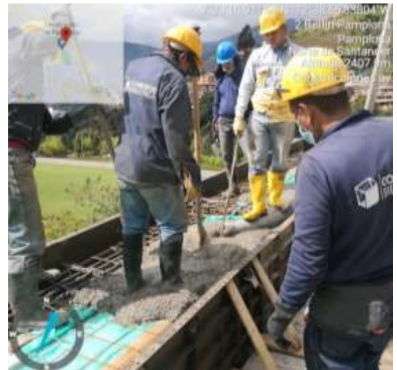
fotografía 22 Colocación de la mezcla
