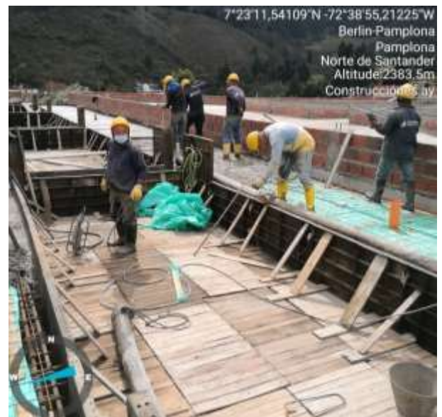
fotografía 26 Colocación de la mezcla.
