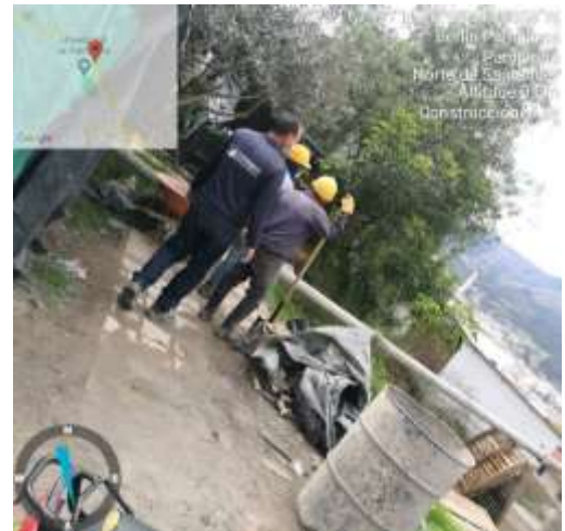
fotografía 17 Preparación para la colocación.
