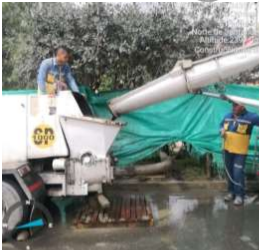
fotografía 15 recibimiento y revisión de la mezcla.
