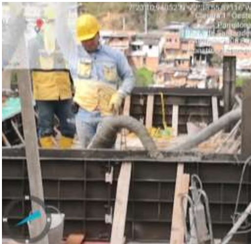
fotografía 23 Colocacion de la mezcla
