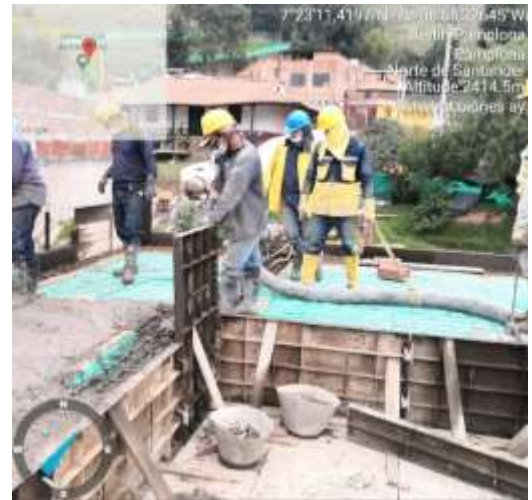
fotografía 29 Colocación de la mezcla.
