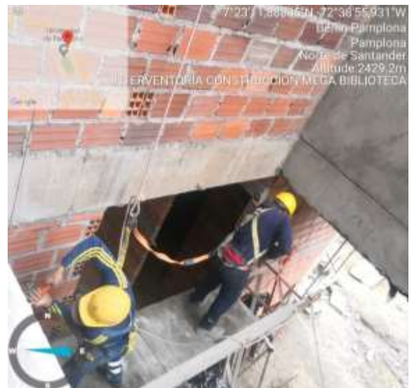
fotografía 36 correcto uso de elementos de seguridad en la obra.
