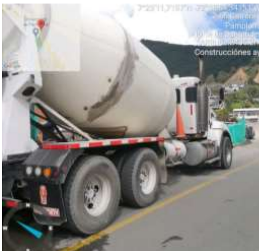
fotografía 16 recibimiento y revisión de la mezcla.
