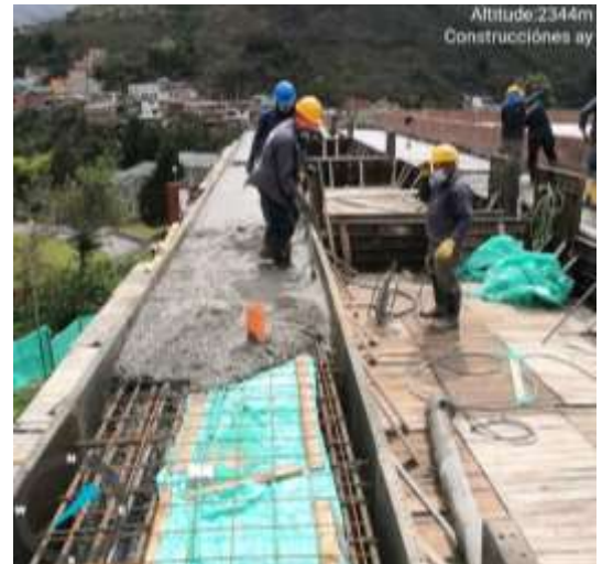
fotografía 25 Colocación de la mezcla.
