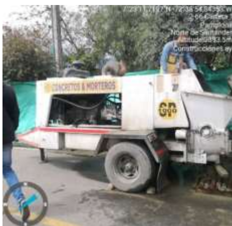
fotografía 14 Recibimiento y revisión de la mezcla.
