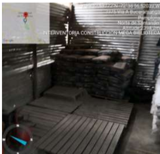
Fotografía 2 Almacenamiento de bultos de cemento.
