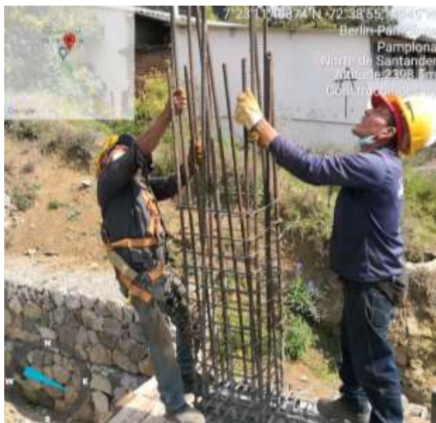
fotografía 38 Correcto uso de elementos de seguridad en obra.
