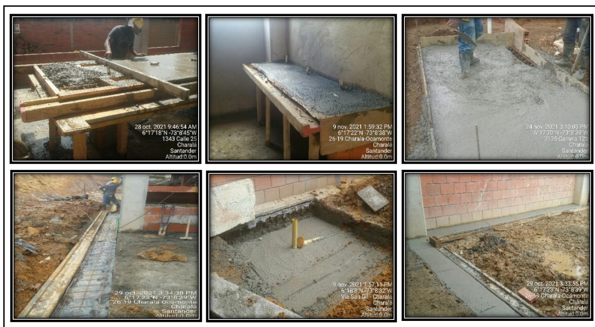
Figura 46, Elementos fundidos con concreto hecho en obra.
