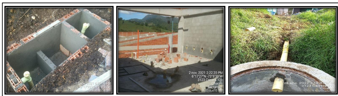
Figura 28, Construcción trampa de grasas, puntos hidráulicas e instalación tuberías sanitarias
