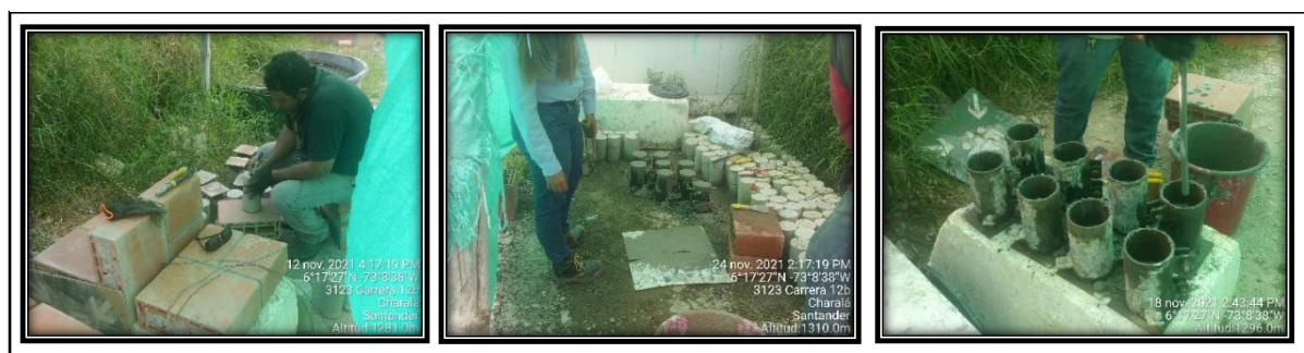
Figura 48, Toma de cilindros para ensayo a la resistencia de compresión del concreto en compañía con la inspectora de la interventoría consorcio interdesarrollo.
