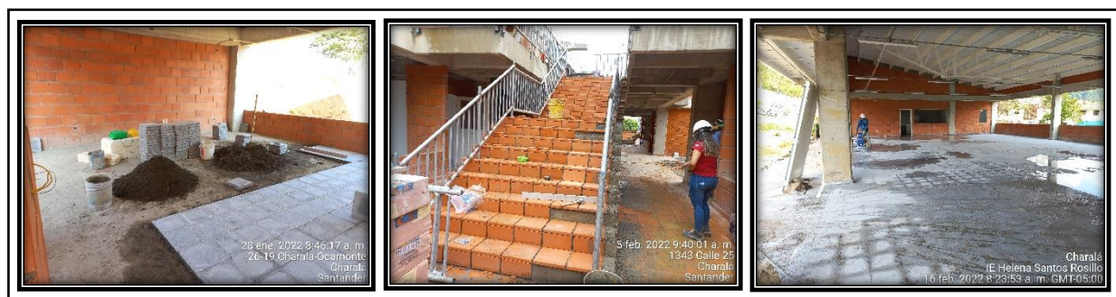
Figura 30, Instalación de pisos en general.
