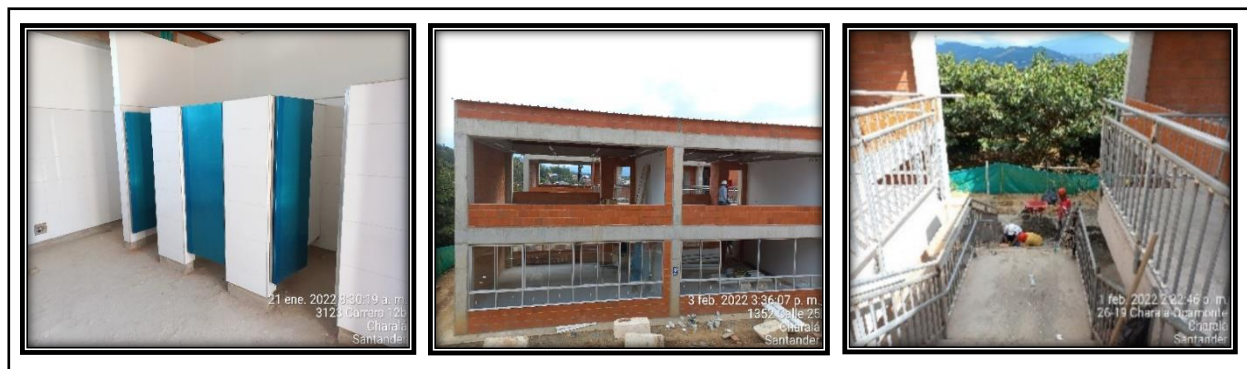
Figura 32, Instalación puertas, ventanería y barandales
