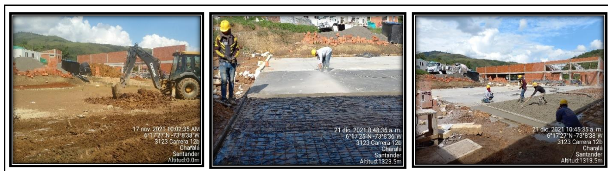
Figura 29, Construcción cancha multifuncional
