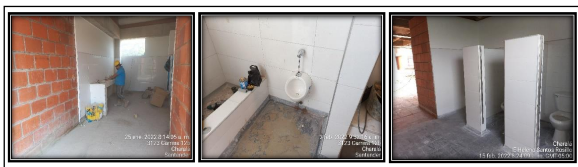
Figura 38, Instalación aparatos sanitarios y accesorios
