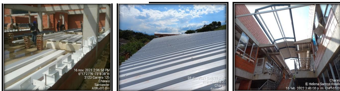
Figura 34, Instalación de cubierta
