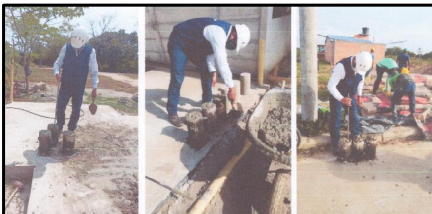
Ilustración 83. Toma de cilindros de concreto para viviendas
