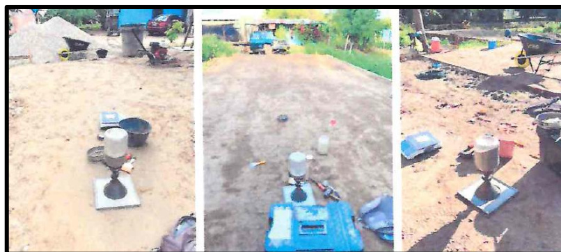
Ilustración 79. Ensayo de densidad para las viviendas
