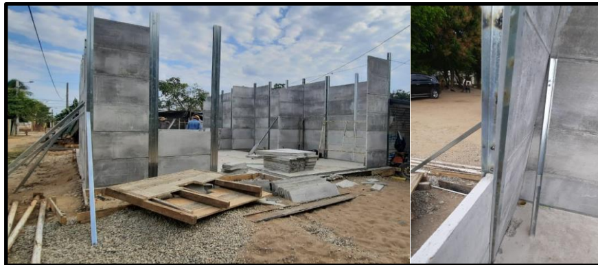
Ilustración 30. Muros para viviendas
