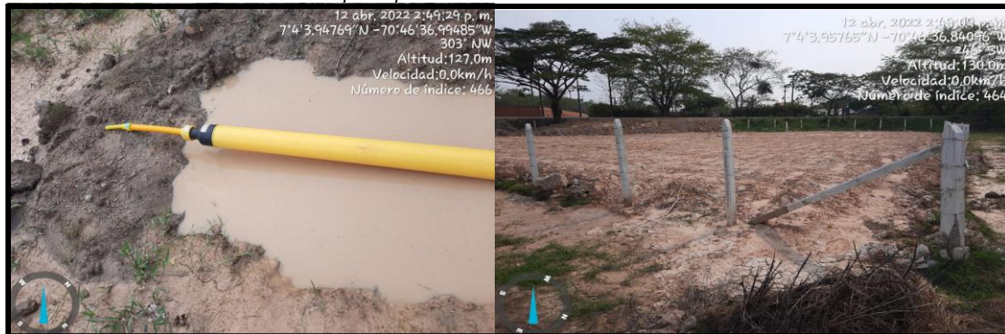
Ilustración 110. Instalación de la red principal de Gas al sector comuna 3
