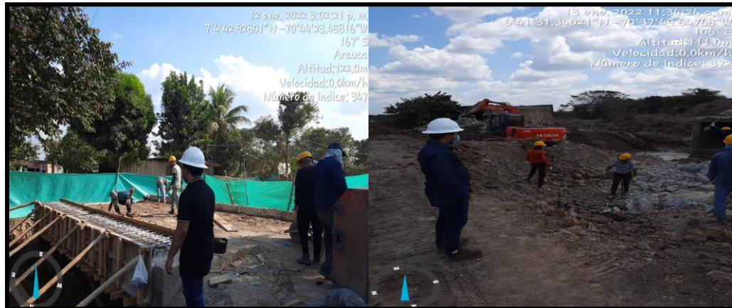
Ilustración 105. Visitas extraordinarias construcción de puentes en llano alto y corregimiento maporillal
