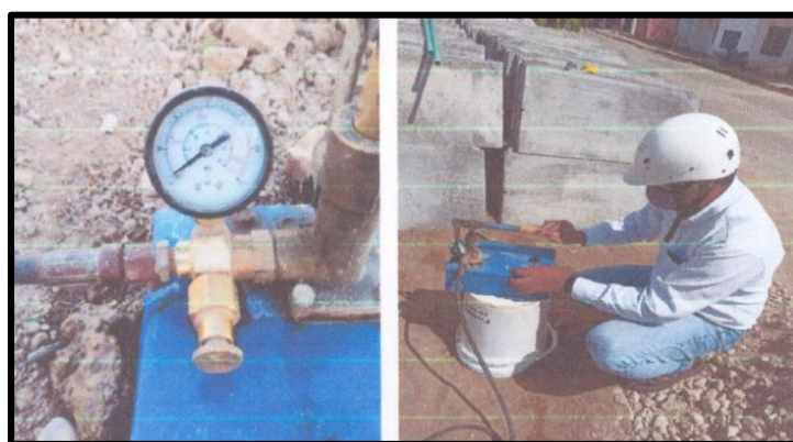
Ilustración 82. Pruebas hidrostáticas para viviendas
