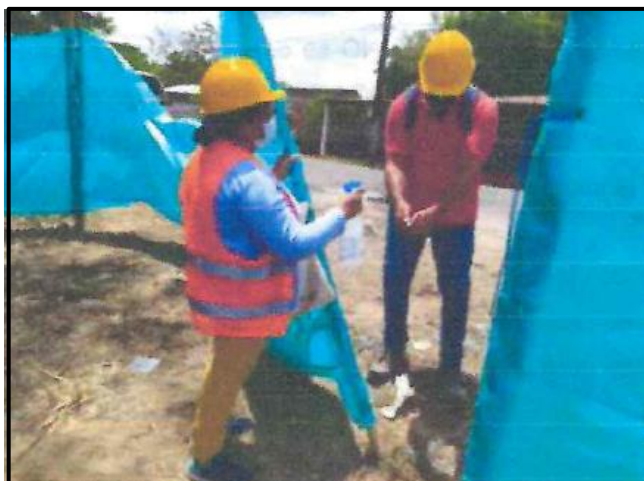
Ilustración 69. Desinfección con alcohol para la obra del cementerio
