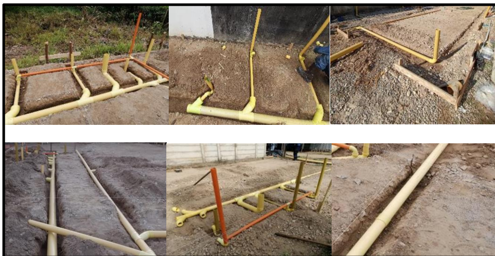
Ilustración 27. Instalaciones sanitarias vivienda
