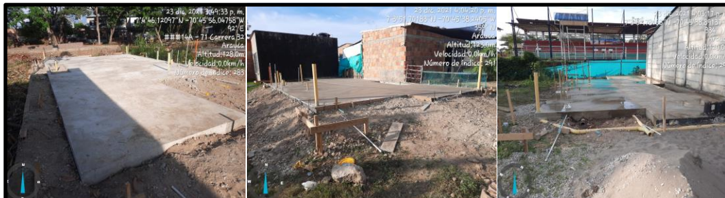
Ilustración 28. Cimentación para vivienda
