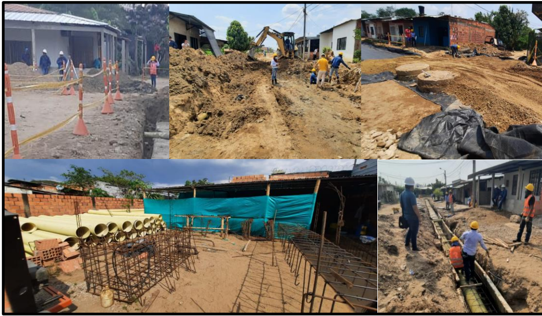
Ilustración 52. construcción de estructura de pavimento rígido
