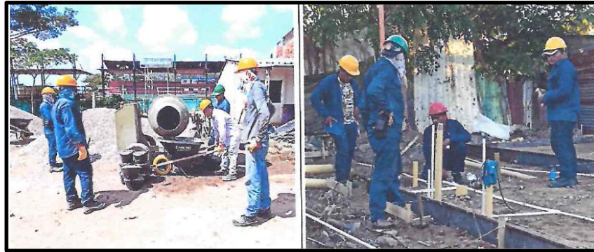
Ilustración 56. Inspección del buen uso de EPP
