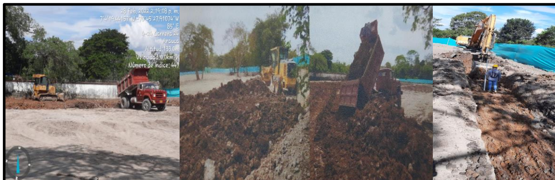
Ilustración 43. Adecuación y relleno del terreno del cementerio
