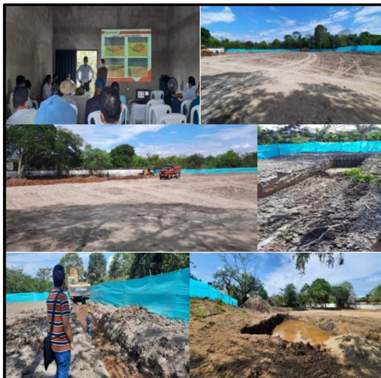
Ilustración 21. Estado inicial del proyecto del cementerio
