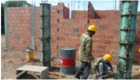
Zona acceso principal
