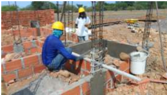
Zona acceso principal
