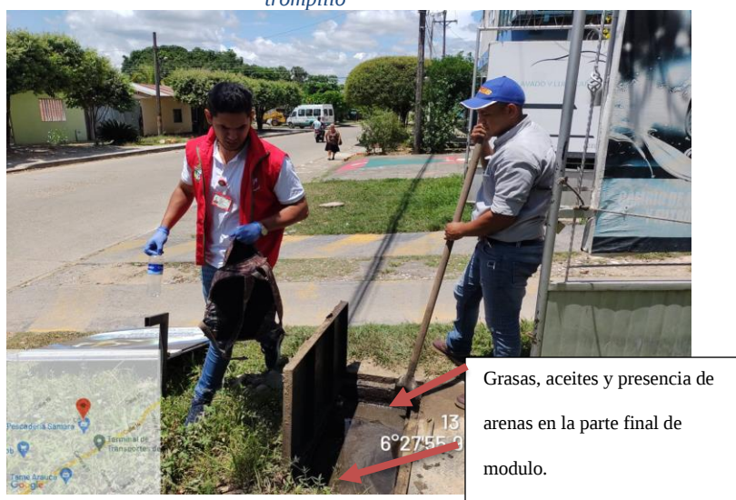
Imagen 22 , evidencias de aceites y arenas en el módulo final de la trampa de grasas Auto-Lavado el trompillo
