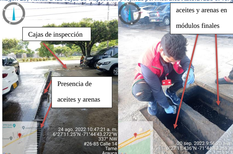
Imagen 25, visitas a las cajas de inspección y rejillas perimetrales Autolavado el vergel
