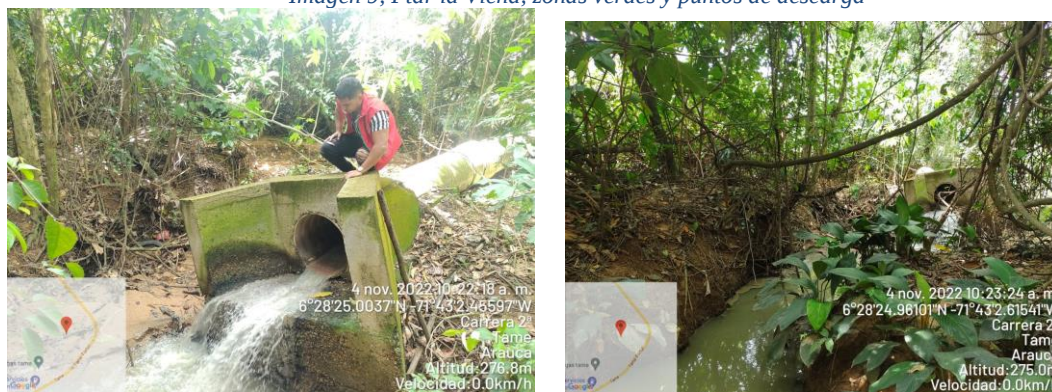
Imagen 9, Ptar la Vicha, zonas verdes y puntos de descarga
