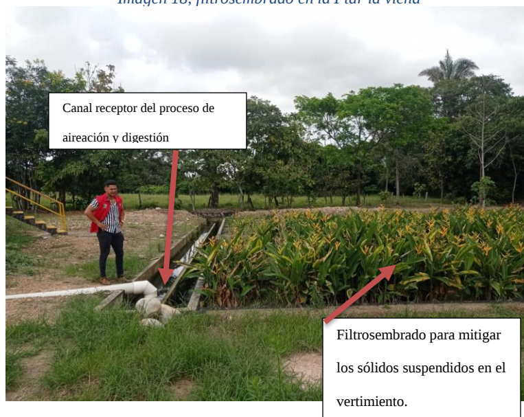
Imagen 18, filtrosebrado en la Ptar la vicha
