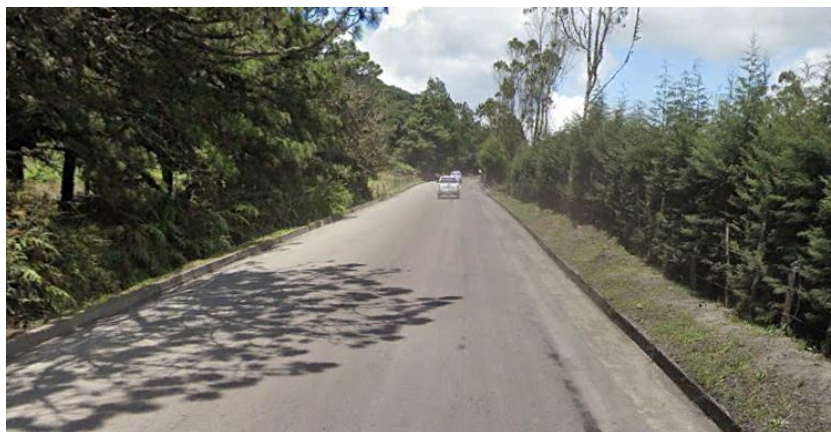
Fotografía 5. Vía de acceso
