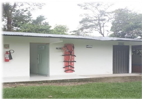
Figura 37. Área administrativa de la PTAP
