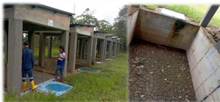
Figura 33. lechos de secado de lodo de la PTAP
