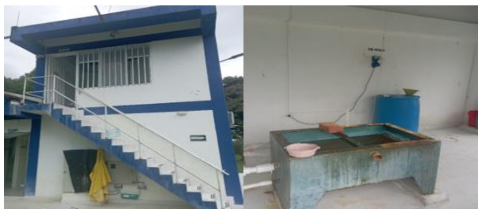
Figura 28. Zona de dosificación de la PTAP
