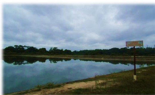
Figura 50. Laguna Facultativa PTAR
