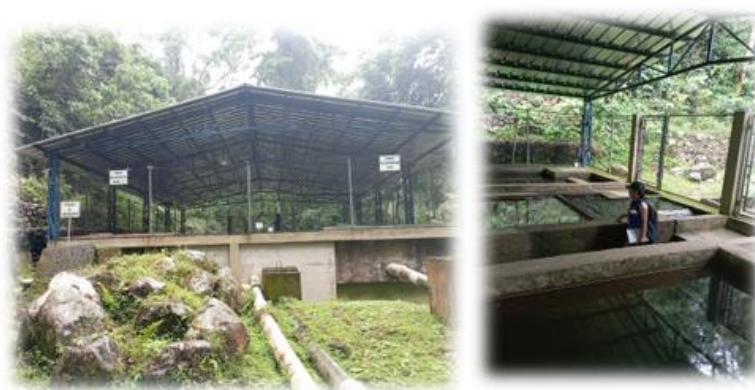
Figura 18. Desarenador claramente señalado
