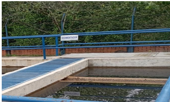
Figura 26. Sedimentador de alta tasa
