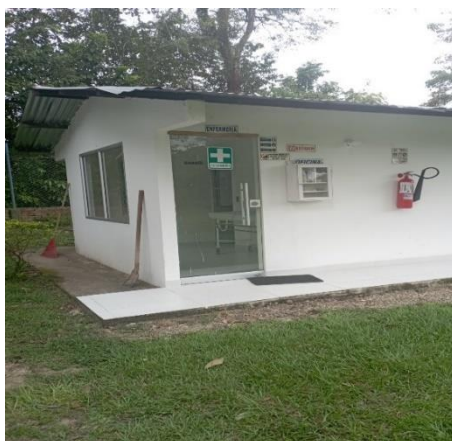
Figura 36. Área de enfermería de la PTAP
