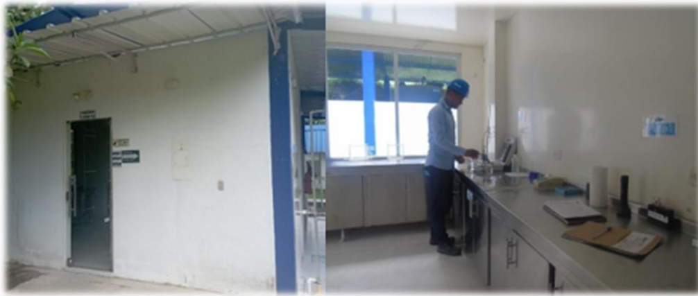
Figura 34. Laboratorio Físicoquímico de la PTAP, Fortul-Arauca
