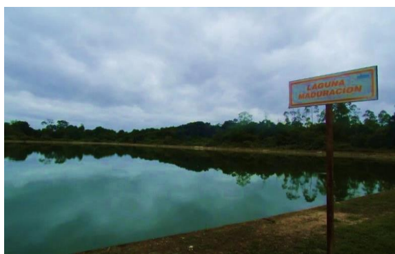
Figura 51. Laguna de Maduración- PTAR
