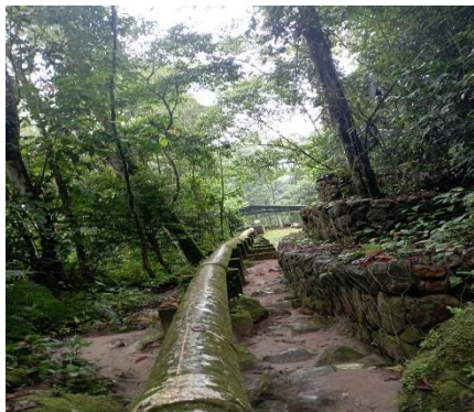
Figura 16. Línea de aducción
