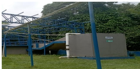
Figura 23. Cámara de aquietamiento
