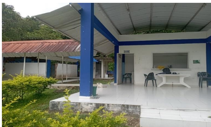
Figura 38. Cafetería de la PTAP de Fortul-Arauca
